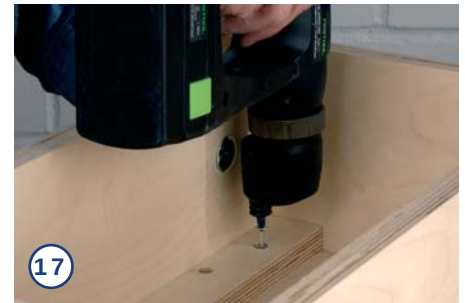
17. Danach wird die Leiste einfach mit zwei Spaxschrauben von innen unter die Deckelplatte geschraubt. Bitte keinen Leim angeben, dann können Sie später die Leiste falls nötig auch mal auswechseln.
