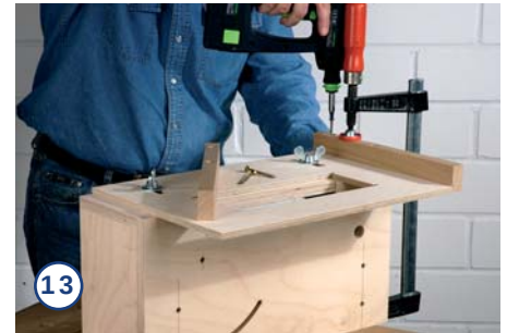
13. ... ihn an der Hinterkante der Kiste bündig und links und rechts gleichmäßig aus. Fixieren Sie dann den Träger mit den Flügelmutter und schrauben Sie die Holzleisten fest.
