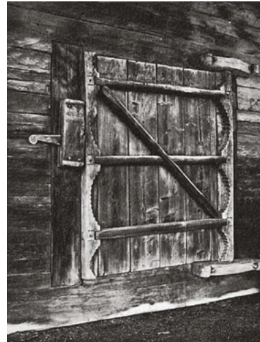
157 Door mounted on pivots with wooden latch in the Muzeul Satului in Sighetu Marmăției, Maramureș, Romania.
