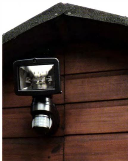
Außenbeleuchtung mit passivem Infrarotschalter
