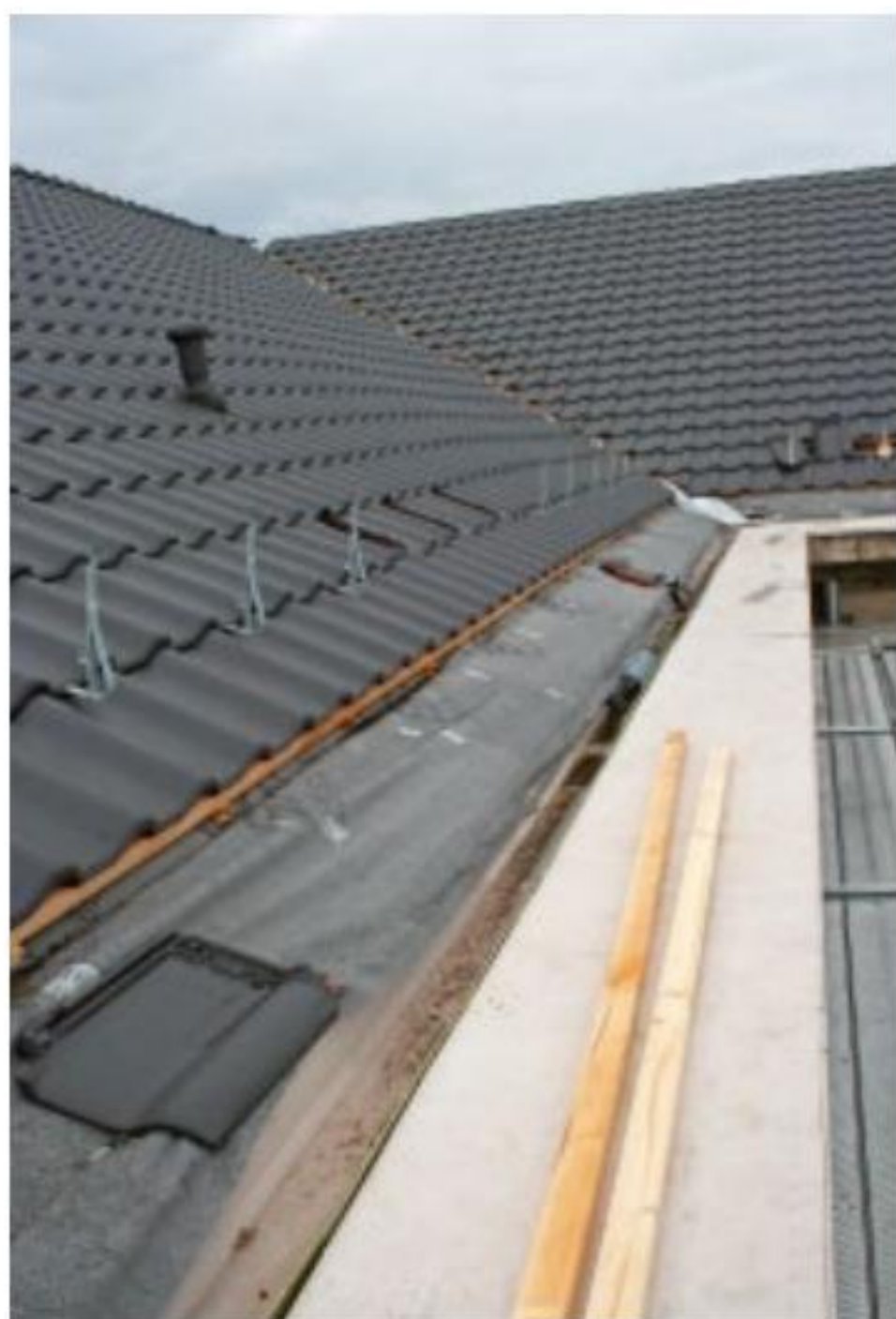
← Detail Kupferrinne, Kastenrinne Neueindeckung mit Traufanschluss
