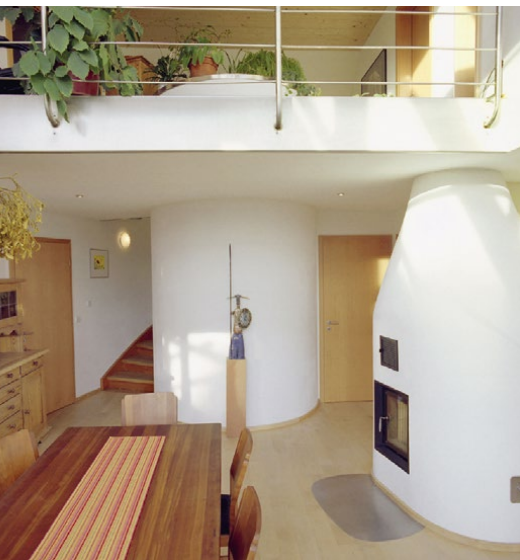
Großsolar-speicher, die oft über zwei Stockwerke reichen, können – wie hier zu sehen – geschickt in die Architektur eines Sonnenhauses integriert werden. Rechts im Bild: der Holzofen, der den Speicher im Winter nachheizt. Sonnenhaus-Institut
