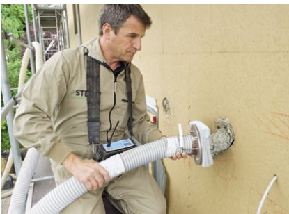
Doppelt gemoppelt: Einblasdämmung aus Zelluloseflocken wird in den Hohlraum hinter den Holzfaserdämmplatten eingebracht. Steico
