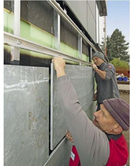
oben links: Vorgehängte Fassade aus witterungs- beständigen, zwei Zentimeter starken Schieferplatten. Rathschek
