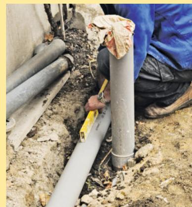
**11** Creusez des tranchées peu profondes (20 à 25 cm) au ras des façades pour y disposer les tubes de bouclage entre les descentes avec une pente de 1 cm/m.
