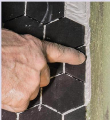
**5** Lors de la mise en place de chaque carreau retaillé, vérifiez qu'il se trouve à égale distance des trois carreaux qui l'entourent, pour obtenir des joints de largeur identique.
