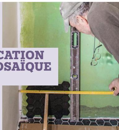
**26** Déterminez le démarrage de la pose par rapport à la mosaïque de sol. Alignez la plaque de carreaux le long d'un niveau calé à la verticale pour servir de guide latéral.
