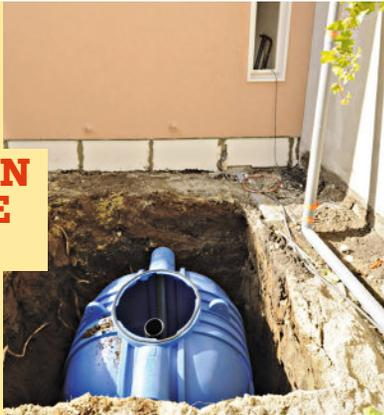
**1** Stabilisez le fond de fouille et contrôlez l'horizontalité. Déposez un lit de sable ou de gravier de 100 mm d'épaisseur. Posez la cuve à sa place.
