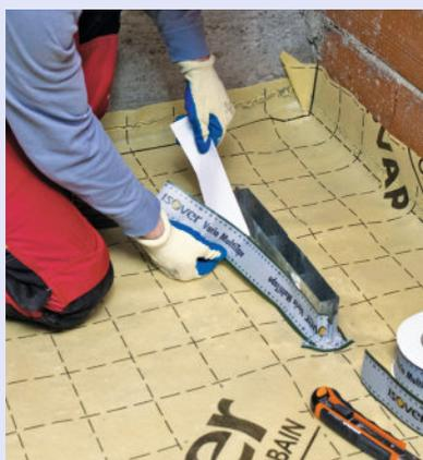
**4** Autour des points particuliers (canalisation, passage de câble...), assurez l'étanchéité à l'air du pare-vapeur en appliquant un ruban d'adhésif souple (Multitape).
