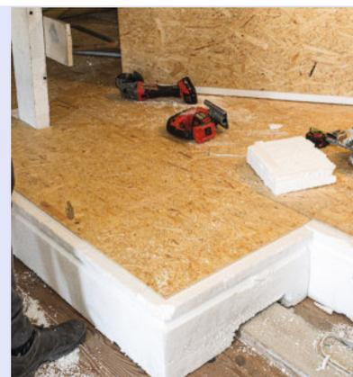
**12** Effectuez au cutter une série de coupes transversales distantes de 30 mm environ entre les coupes longitudinales. Il sera ainsi plus facile de découper ces chutes en attaquant à la scie sabre dans le sens de la longueur.
