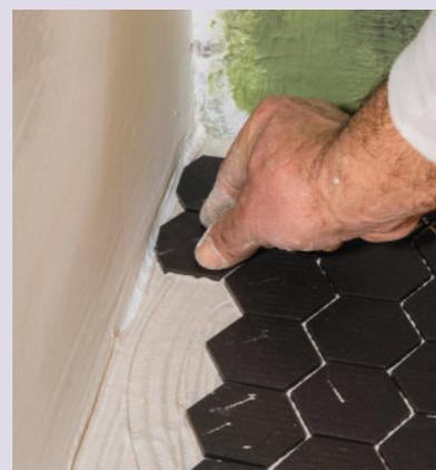
**8** L'ajustement face à des murs non perpendiculaires et/ou non rectilignes s'effectue après avoir rectifié les carreaux à la tenaille ou à la pince à bec-de-perroquet.
