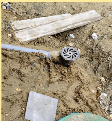
**16** Sur une surface décaissée par rapport à la rue et peu perméable (car pavée par la suite), prévoyez un siphon de sol. Relié au réseau de collecte, il évitera à l'eau de s'accumuler.
