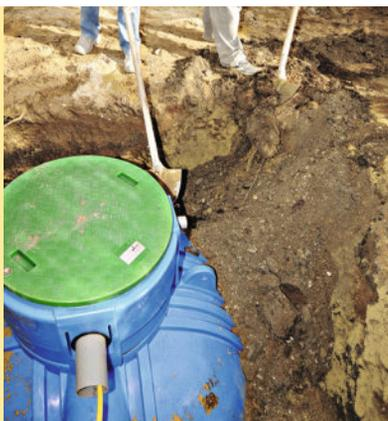
**8** À la moitié de la hauteur de la cuve, finissez le remblayage avec de la terre exempte de cailloux de plus de 15 mm. Aucun compactage mécanique n'est admis.
