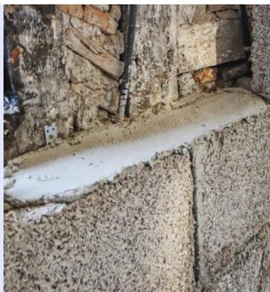
**4** Tracez préalablement un repère au sol à 10 cm du mur. Déposez un lit de mortier (ép. 1 cm) puis posez le premier rang de briques, en décalant les joints (dits à joints croisés).
