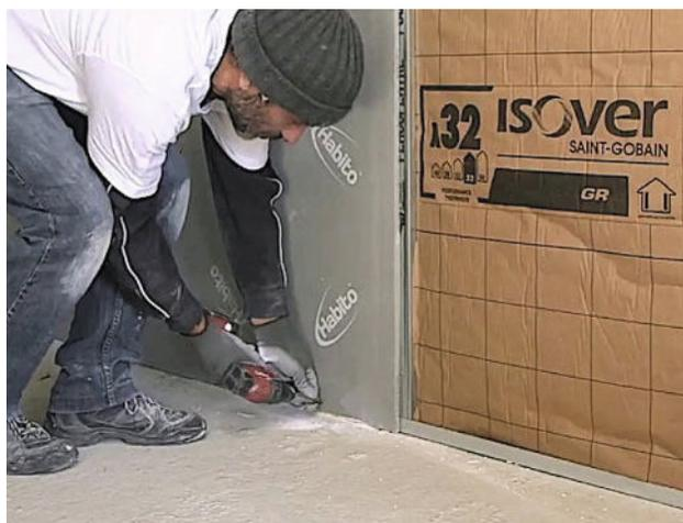
En doublage de mur, les panneaux de laine de verre s'embrochent sur des appuis en matière synthétique emboîtés dans des fourrures horizontales fixées à la paroi. Les plaques de plâtre viennent se visser sur une ossature clipsée sur les têtes des appuis.
