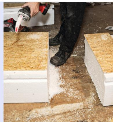
**2** Mesurez la distance entre le dernier panneau et la sous-pente. Reportez la mesure sur le parement. Découpez à la scie sabre, pratique pour ce type de matériau.
