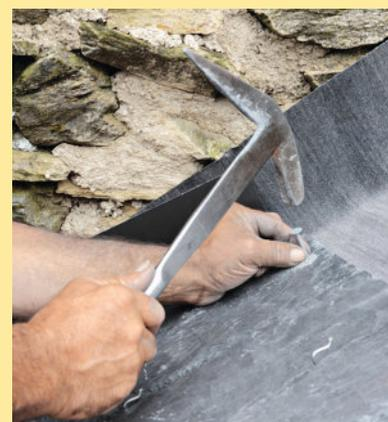
**12** Recouvrez le noquet avec l'ardoise découpée et clouez-la. Procédez de la même façon à chaque rang du dessus en intercalant un autre noquet sur l'ardoise d'en dessous.
