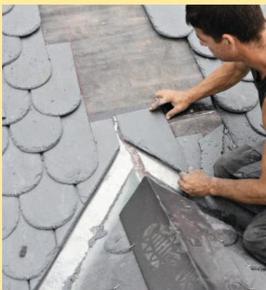
**19** Poursuivez de la même façon sur les autres pans de toiture. Pour les murs très exposés, réalisez un bardage en volige et posez les ardoises sur crochets.
