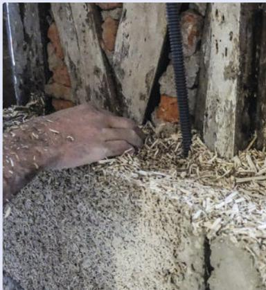
**14** Ajoutez de la chènevotte pure au fur et à mesure de l'application du mélange pour consolider l'ensemble et renforcer l'isolation.
