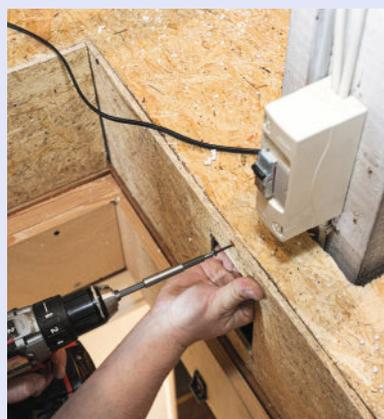
**17** Autour de la trémie, habillez l'épaisseur d'isolant avec des chutes d'OSB. Vissez-les dans les chants des lames du plancher d'origine et dans ceux des parements de l'isolant.
