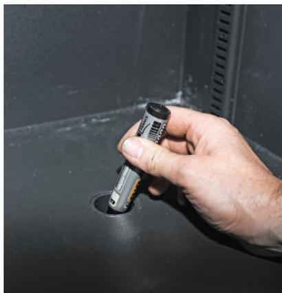
**4/** Retirez le goujon d'ancrage, reposez le coffre, puis matérialisez l'emplacement du perçage au sol à l'aide d'un marqueur suffisamment épais.
