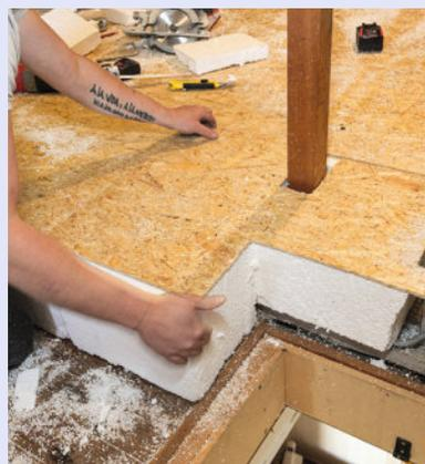
**14** Outre la trémie d'un escalier escamotable, le panneau doit contourner un poinçon de la charpente. Découpez en U son parement et retirez l'isolant à l'aplomb de la découpe.
