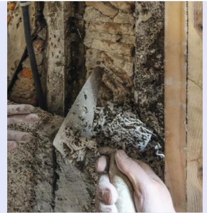
**11** Poursuivez l'assemblage des briques en veillant à contrôler leur niveau puis comblez et arrosez les joints au fil des rangées. Coupez le dernier élément comme précédemment.
