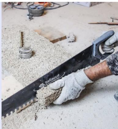
**5** En bout de rang, mesurez la distance entre le mur et la dernière brique. Reportez la mesure et découpez à la scie manuelle à grosse denture (type alligator) qui n'arrache pas les fibres.
