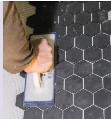
**3** Appuyez sur les carreaux avec une taloche à semelle en mousse. Parcourez toute la surface de la plaque pour niveler les carreaux dans la colle.
