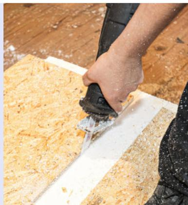
6 Découpez l'encoche correspondante dans le parement du panneau. Utilisez au départ une scie circulaire et terminez à la scie sabre.
