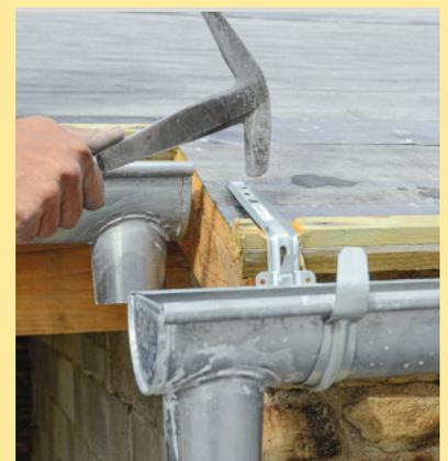
**6** Fixez un liteau au niveau de l'égout. Entaillez-le au droit de chaque support de gouttière afin que les ardoises de rive soient parfaitement alignées.
