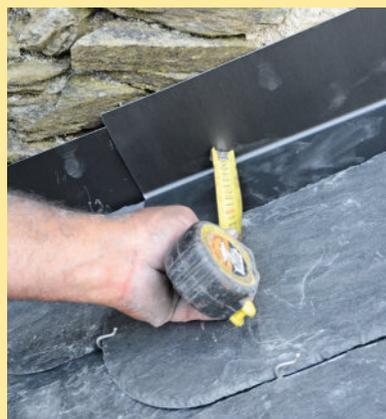
**10** Contre la maison voisine, la rive déversée est traitée avec des noquets en zinc, cloués dans la volige à travers l'écran de sous-toiture. Mesurez la dimension des ardoises à poser.
