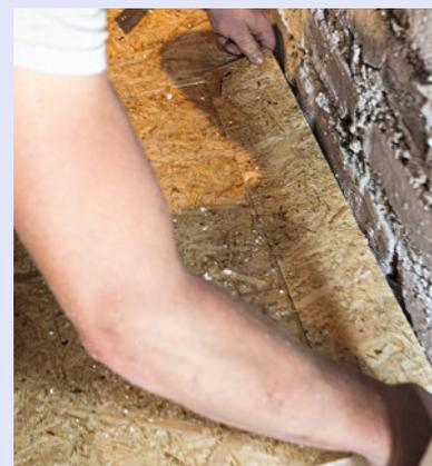
9 Recouvrez ensuite l'isolant d'une chute de parement en OSB, taillée sur mesure. Au mur, vérifiez l'absence de reliefs trop marqués. Supprimez-les au burin plat si nécessaire.
