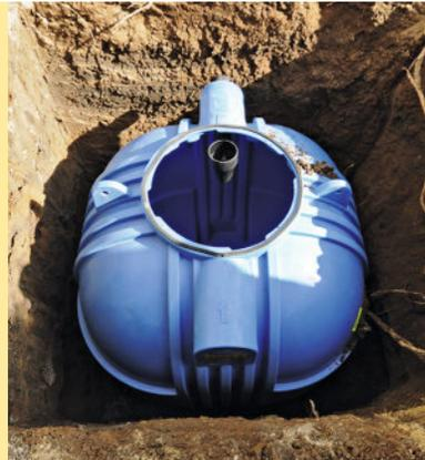
**2** Si un ancrage est nécessaire, noyez le châssis de la cuve dans du béton. Ou bien fixez la cuve sur le radier à l'aide de ses pattes d'ancrage ou de sangles.
