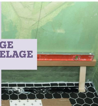
**17** Après au moins 24 h de séchage, tracez un axe vertical au centre de la paroi arrière de la douche. Calez un tasseau à l'horizontale pour soutenir la première rangée de carreaux.
