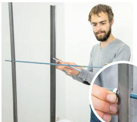
**5** Coupez les tiges filetées en deux avec une scie à métaux. Passez les 4 sections obtenues par les trous d'angle en les laissant dépasser de 1 cm. Croisez les tiges et joignez-les avec des manchons à visser afin de stabiliser le piétement. Serrez-les avec des écrous.
