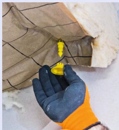
**10** Ajoutez une rondelle pour maintenir la laine de verre de façon bien tendue. Utilisez un maillet en caoutchouc pour clipser les capuchons sur les têtes des suspentes. Insérez la rondelle qui permet de maintenir la laine de verre sur la suspente puis verrouillez à l'aide du capuchon. Utilisez un maillet en caoutchouc. Répétez l'opération pour les suspentes suivantes.
