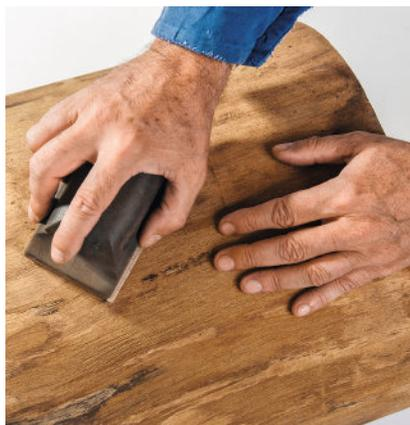
**4/** Il est préférable de poncer les surfaces non planes à la main, avec ou sans cale de ponçage. Suivez le sens des fibres du bois. Là aussi, papier abrasif n° 60 jusqu'au 100.
