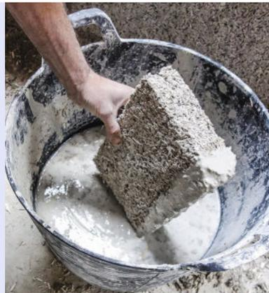
**2** Dans un autre seau, préparez un mélange de mortier plus liquide. Trempez les briques pour couvrir les chants à coller sur environ 3 cm.
