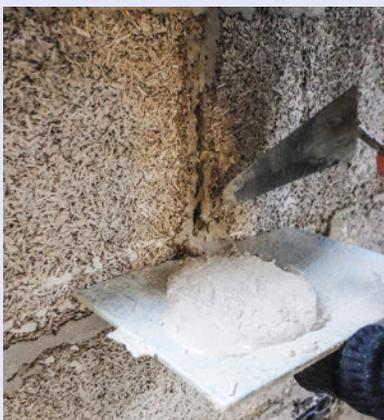
**15** Jointoyez avec un mortier de scellement épais. Projetez-le à la truelle afin qu'il pénètre au plus profond des joints. Arasez la surface.
