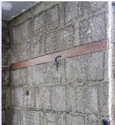
**18** Positionnez horizontalement une planche (10 cm de large x 5 mm d'épaisseur) contre les briques à 1,80 m du sol. Encastrez la planche dans l'épaisseur des briques. Vissez-la à raison de deux vis à bois tous les 20 cm. Ce renfort servira à fixer, si besoin, des meubles hauts (cependant le poids des éléments à suspendre est à vérifier).
