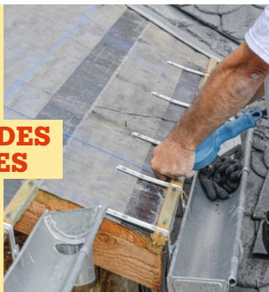
**7** À l'aide d'un cordeau à poudre, tracez tous les repères nécessaires à la pose des ardoises : axes des crochets, alignement des ardoises, pureau (ici 11 cm), etc.
