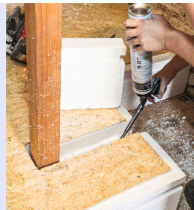
7 Remplissez l'encoche à la mousse polyuréthane expansive. Ne chargez pas trop, car celle-ci a tendance à déborder... Laissez sécher, puis recoupez le surplus au cutter.
