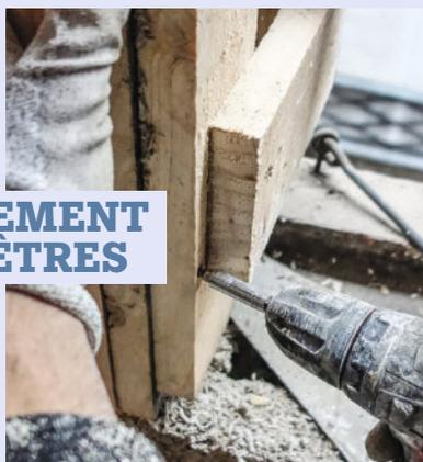
**8** L'isolation entre les briques impose de réaliser des appuis, ici avec des chutes de planches de coffrage. Positionnez-les dans chaque angle de la fenêtre. Placez des planches de 15 cm de large sur le pourtour du tableau de la menuiserie. Vérifiez que leur chant soit à fleur des briques déjà posées. Contrôlez leur aplomb. Fixez-les aux appuis avec des vis à bois.
