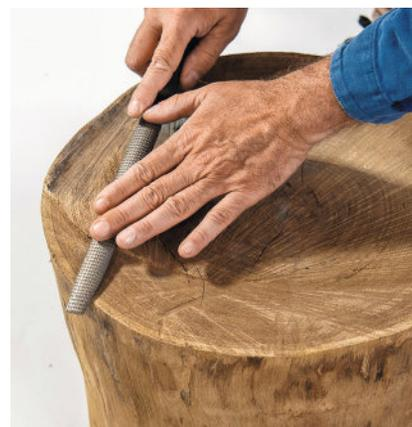
2/ Réalisez un biseau régulier afin d'adoucir les arêtes. Utilisez une râpe ou une défonceuse portative munie d'une fraise pilote à 45° pour un travail plus rapide et précis.
