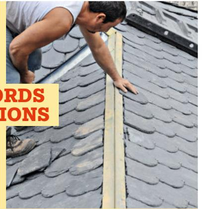
**15** Poursuivez la pose jusqu'au faîtage. Découpez les dernières ardoises et posez-les sur les crochets de façon à conserver les recouvrements (pureau, demi-pureau...).
