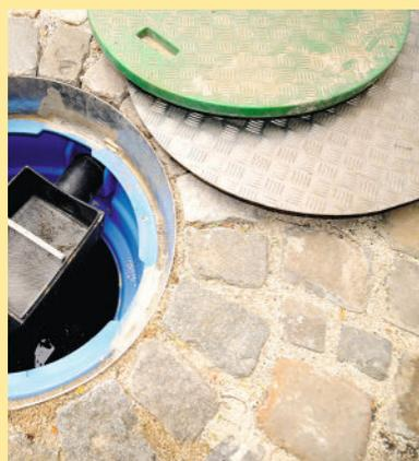
**19** La trappe de visite du filtre est masquée par un couvercle en tôle d'inox endiamantée. Il coiffe un tampon, lui aussi en inox et noyé sous les pavés.
