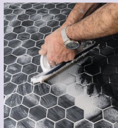
**16** Garnissez généreusement l'intégralité des joints. Essuyez le surplus avec l'éponge spéciale fournie par le fabricant du mortier.
