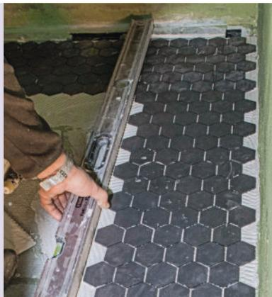
**2** Les murs n'étant pas perpendiculaires, disposez au sol une cale contre le mur latéral et alignez les carreaux le long de l'autre mur. Posez deux plaques et contrôlez l'alignement.
