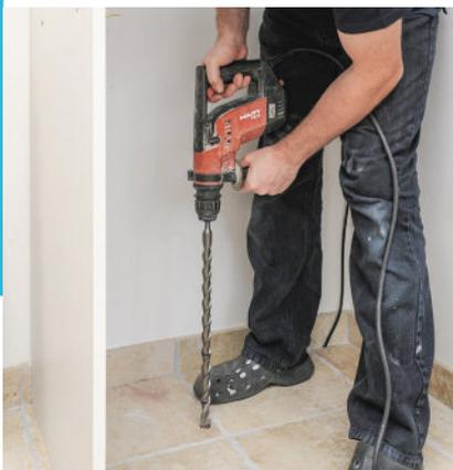
**5/** Au perforateur, réalisez le trou avec un foret spécial matériaux pleins (ici Ø 16 mm). Commencez par un trou d'un diamètre inférieur (5 mm). Ne percez que la profondeur nécessaire.
