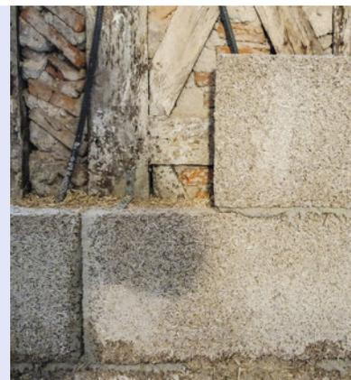
**6** Corrigez l'alignement si nécessaire (maillet). Vérifiez l'aplomb et l'horizontalité avec un fil à plomb et un niveau à bulle. Jouez sur l'épaisseur du mortier pour ajuster si besoin.
