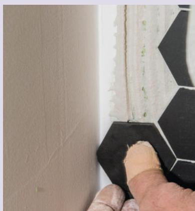
**28** L'angle des murs n'étant pas droit, la surface à carreler est irrégulière. Les carreaux sont donc à poser l'un après l'autre, après rectification de leur angle (côté gauche).
