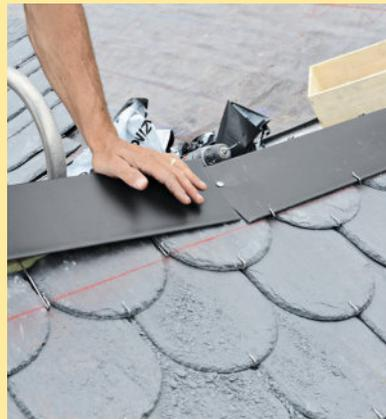
**17** Pour le faîtage, découpez une bande de 45 cm de zinc, pliée selon la pente du toit. Réalisez un ourlet intérieur, puis glissez la bande dans les crochets.
