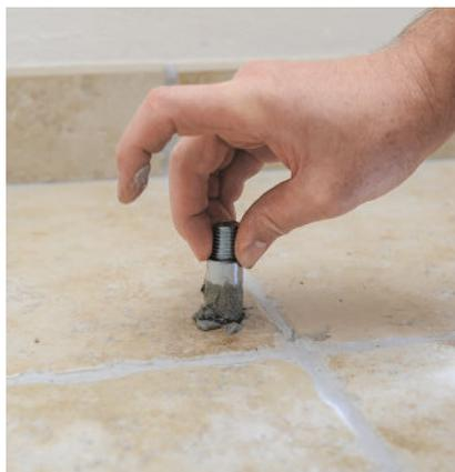
**6/** Pour plus de solidité, remplissez le trou de perçage d'une résine de scellement et placez le goujon en respectant la hauteur de tige filetée précédemment relevée.
