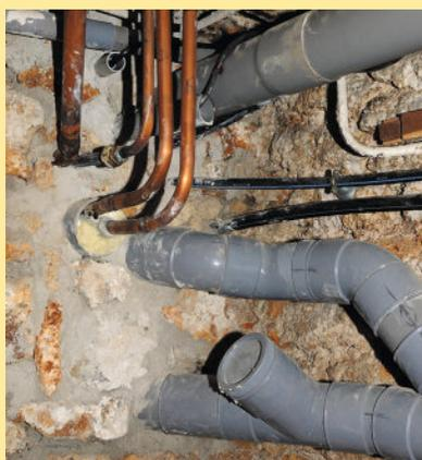
**18** Percez le mur du sous-sol pour passer les différents réseaux. Veillez à séparer les réseaux électriques et hydrauliques.
