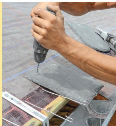
**8** Débutez la pose en bas du versant : fixez un crochet en débord de 50 mm, glissez une ardoise rectangulaire, percez-la et clouez-la avec des pointes galvanisées à tête large.
