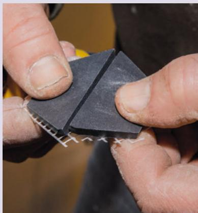
**4** Vu leur forme hexagonale, les carreaux posés devant le mur doivent être complétés de demi-carreaux. Découpez-les à la carrellette, puis coupez leur résille au cutter.
