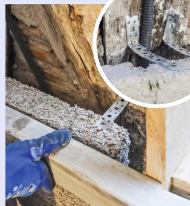
**10** Alignez la face extérieure des briques sur le chant du coffrage en vous aidant d'un tasseau. Vissez l'équerre sur le bois du colombage.
