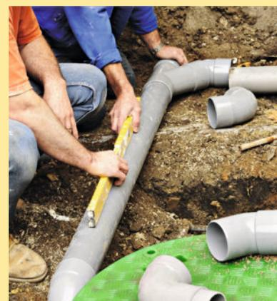
**14** Poursuivez le raccordement du réseau à l'aplomb de chaque descente : de la plus éloignée jusqu'à la plus proche de la cuve. Contrôlez la pente.
