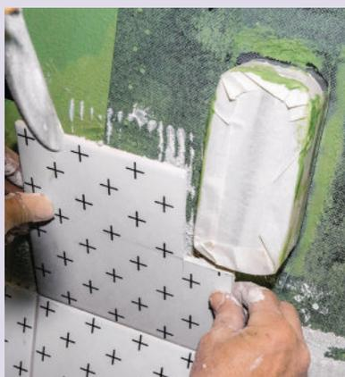
**23** Tracez à l'équerre l'encoche à réaliser pour contourner le mitigeur. Utilisez un coupe-carreau ou coupez le carreau à la meuleuse.
