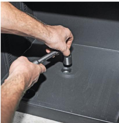
**7/** Après séchage de la résine, remplacez le caisson, vissez l'écrou manuellement, puis à l'aide d'une clé à pipe jusqu'à ce que la résistance soit optimale.
