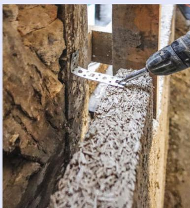
**9** Vissez à chaque extrémité des rangs une équerre métallique (voir astuce ci-contre) sur le chant supérieur de la brique.
