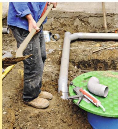
**15** Attendez que tous les assemblages soient pris (voir notice du fabricant). Finalisez le remblayage à la pelle en veillant à ne pas modifier les pentes du réseau.
