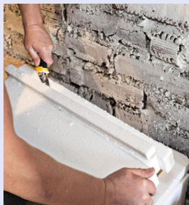
8 Il est parfois préférable de retailler une chute dans l'épaisseur pour l'intégrer en bout de rangée. Découpez sa languette au cutter et ajustez l'élément à l'intervalle disponible.
