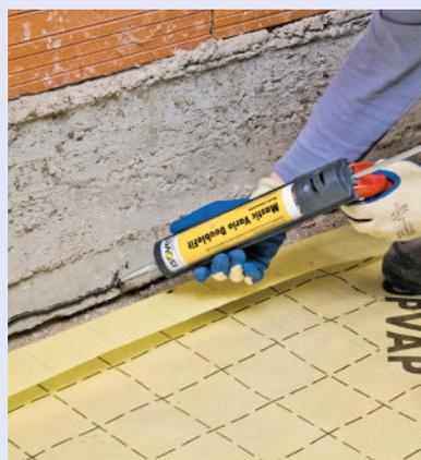
**5** Avec un pistolet extrudeur, déposez un cordon continu de mastic d'étanchéité en pied de mur. Appliquez-en également au niveau du recouvrement de deux lés.
