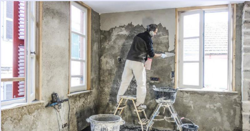
**25** Débutez par les bords du mur (plafond, menuiserie...) en appliquant l'enduit à l'aide d'une truelle. Préparez assez d'enduit pour ne pas avoir à interrompre l'opération sur un pan de mur. Veillez à ce que l'enduit de finition soit plus tendre que le corps d'enduit.
