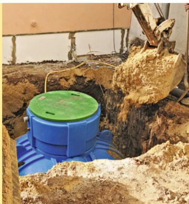
**7** N'utilisez pas la terre extraite de la fouille pour remblayer mais du gravier < 15 mm ou du sable fin à déposer en couches de 20 cm. Arrosez entre chaque couche de sable.
