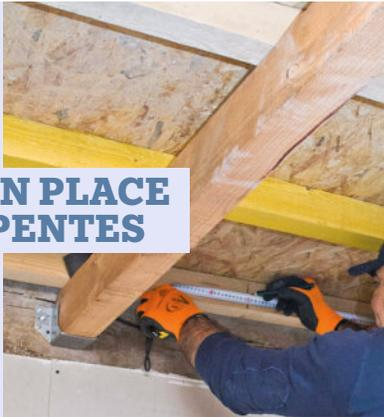
**1** Sur la lambourde, tracez un trait de repère à 60 cm de la solive positionnée côté mur. Il servira à placer la première suspente.
