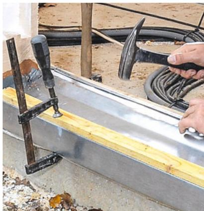
**8/** Mettez la bavette sous presse sur toute sa longueur à l'aide d'un tasseau et de plusieurs serre-joints. Vérifiez que l'ouvrage plaque parfaitement sur la lisse basse, rejigot compris.
