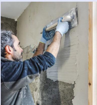
**26** Enduisez la surface restante en déposant l'enduit en large passe à la taloche ou à la règle à lisser. Travaillez la structure du rendu plus ou moins lisse.
