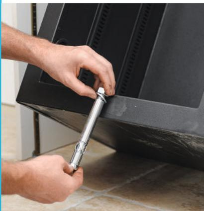
**3/** Pour définir la hauteur de tige filetée nécessaire, présentez l'écrou du goujon dans l'épaisseur de la partie basse du coffre. Repérez sa position et relevez la longueur de tige filetée.
