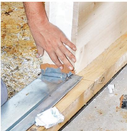
**7/** Vérifiez que les terminaisons plaquent parfaitement contre les côtés du tableau de baie. Tapotez avec un maillet ou une massette, puis lissez le mastic qui reflue.
