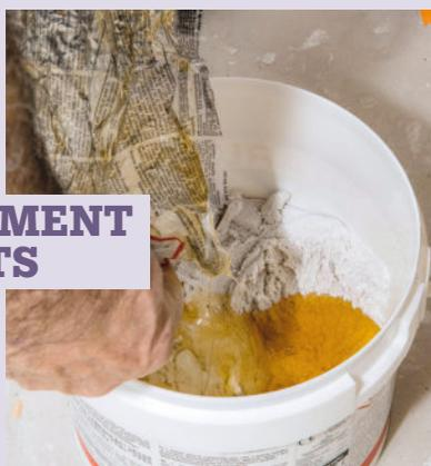
**14** De type époxy, le mortier à joint est constitué d'une pâte à additionner de résine. Versez la totalité du sachet de résine dans le pot de pâte et malaxez le tout.
