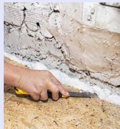
**15** Injectez de la mousse expansive dans tous les interstices restant à la périphérie du plancher. Après séchage, découpez proprement le surplus au cutter.
