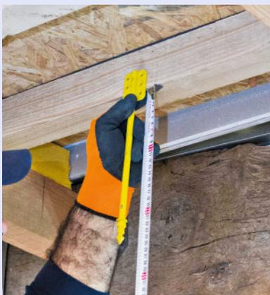
**4** À l'opposé, positionnez une seconde suspente en vis-à-vis en veillant à ce qu'elle soit exactement à la même hauteur. Aidez-vous d'un mètre ruban. Vissez la suspente.
