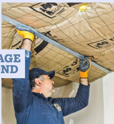
**11** Clipsez les fourrures métalliques sur les capuchons. Si nécessaire, utilisez des éclisses afin de rallonger les fourrures.
