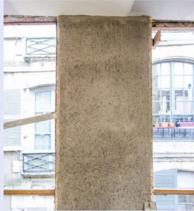
**23** La première couche (corps d'enduit) est maintenant suffisamment lisse et homogène pour recevoir l'enduit de finition.
