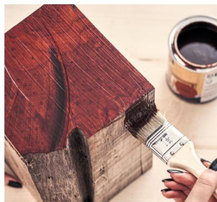
**6** Protégez le bois en appliquant une lasure avec un pinceau plat. Laissez sécher puis égrenez les surfaces avec un papier abrasif grain fin. Appliquez une seconde couche de protection.
