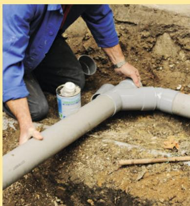
**12** Coupez les tubes et assemblez-les à blanc avec leurs coudes. Tracez des repères de part et d'autre des jonctions pour réorienter correctement les pièces lors de l'assemblage final.
