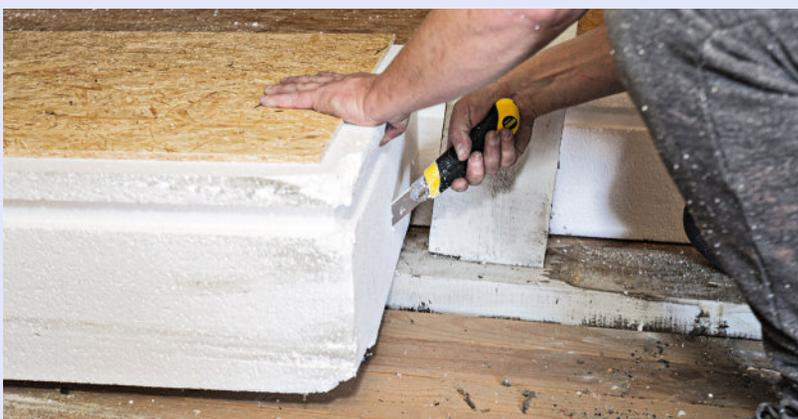
10 Pour « épouser » un obstacle au sol (ici une surépaisseur), positionnez le panneau isolant par-dessus. Tracez la coupe correspondant à la future rainure directement sur le chant concerné au cutter.
