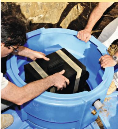
**4** Le filtre est équipé d'un couvercle qui empêche le passage des rongeurs. Le trop-plein permet d'évacuer les particules flottantes. Refermez le couvercle de la rehausse.
