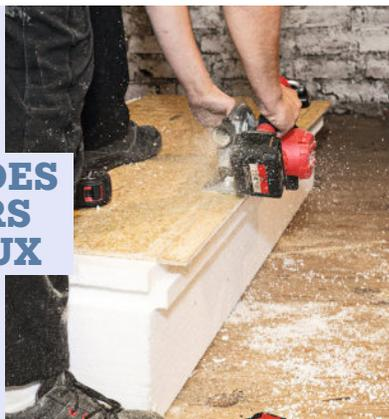
**1** Pour ne pas être gêné par le débord du parement (panneau en OSB dérivés du bois) et par la languette de l'isolant du premier panneau, découpez le premier à la scie circulaire puis le second à l'aide d'une scie sabre. Débutez la pose le long du pignon et à l'opposé de la trémie d'escalier.
