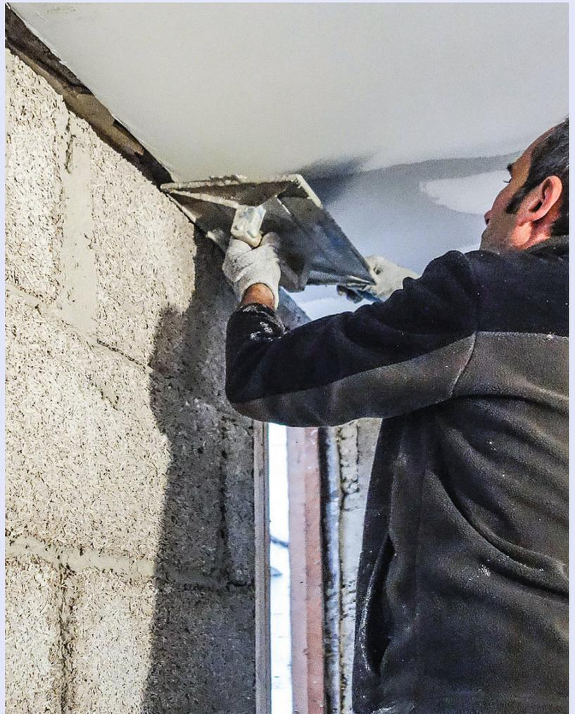
**16** Comblez l'espace restant entre le dernier rang de briques et le plafond. Déposez du mortier épais chargé de chènevotte en vrac sur une taloche rectangulaire, puis poussez-le à l'aide de la truelle.
