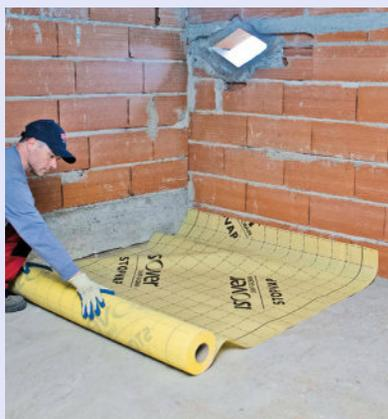
**1** Dépoussiérez la dalle en béton ou le plancher, puis déroulez un premier lé de pare-vapeur. Faites-le remonter contre les murs sur 10 cm minimum.
