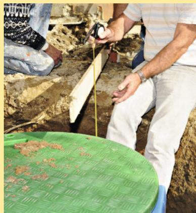
**5** Vérifiez que la cuve est à la profondeur voulue. Utilisez une règle posée au bord de la fouille. Testez l'horizontalité en posant un niveau à bulle sur le couvercle.
