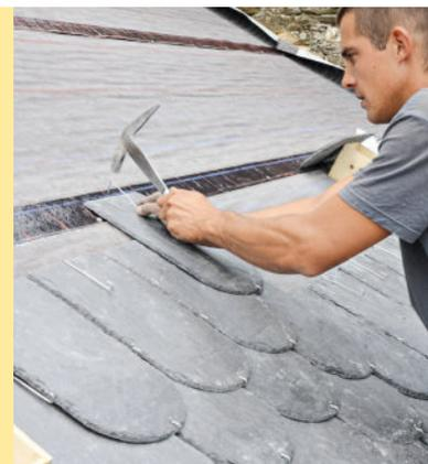
**9** Poursuivez la pose de la couverture : glissez l'ardoise dans son crochet et bloquez-la avec celui de l'ardoise supérieure. Travaillez rang par rang en veillant aux alignements.
