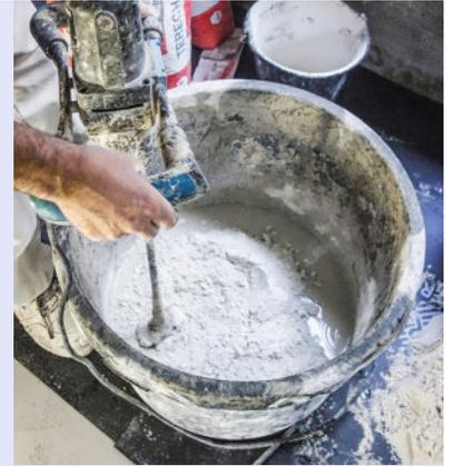
**24** Préparez l'enduit de finition : 1 volume de chaux NHL2, 3 volumes de sable et de l'eau. Travaillez au malaxeur jusqu'à obtenir un mélange fluide.
