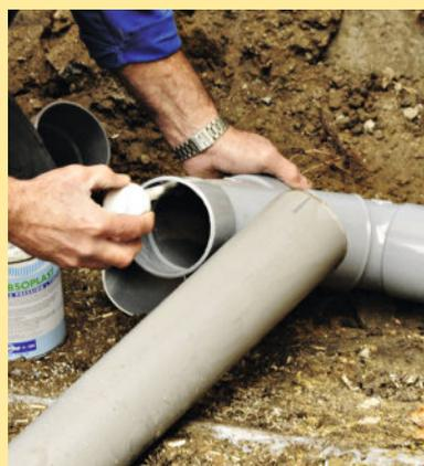
**13** Dégraissez toutes les surfaces de contact à l'alcool à brûler, puis encollez-les. Enfilez les tubes dans les coudes ou raccords en vérifiant que les repères coïncident.
