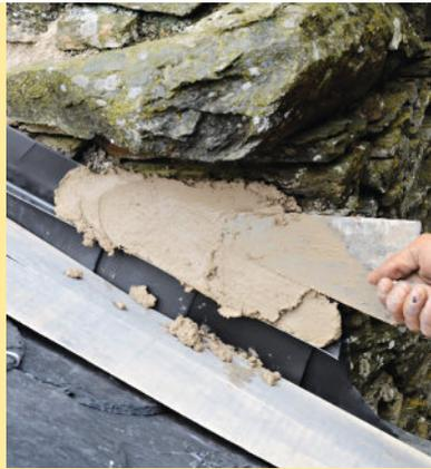
**14** Préparez du mortier à la chaux dans une auge. Garnissez ensuite soigneusement la bande à rabat avec ce mortier pour créer un solin contre la pierre existante.
