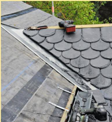
**16** Au niveau des noues, coupez les ardoises en biseau à la cisaille et vissez-les en veillant à rester bien parallèle avec le couloir de noue.
