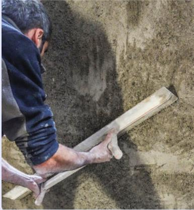
**22** Aplissez et égalisez la surface du mur avec une grande lame à lisser. Travaillez avec le bord inférieur de la lame en effectuant de larges mouvements.
