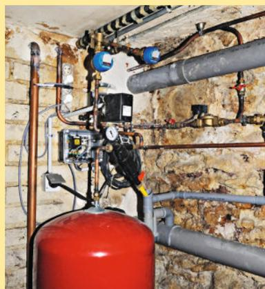
**17** Le réservoir-tampon permet d'utiliser l'eau du réseau sans risque de la mélanger à celle provenant du stockage.
