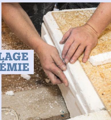
**13** Là où il est impossible d'emboîter les panneaux les uns dans les autres, découpez leurs languettes latérales. Enfilez-les dans les rainures des autres panneaux.
