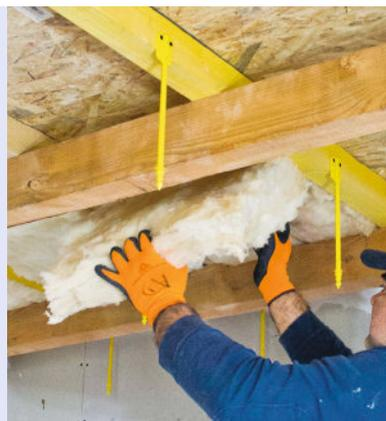
**8** Insérez les lés de laine de verre entre les lambourdes. Veillez à ce que l'isolant soit bien en contact avec le plancher d'étage.
