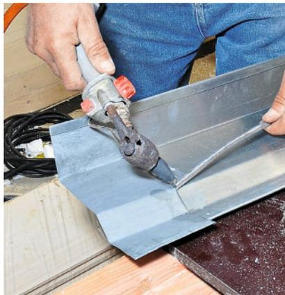
**4/** Décapez les surfaces de contact à l'acide chlorhydrique (ou chlorure de zinc en solution). Puis chauffez les pièces avec la panne du fer et faites fondre la brasure au contact de celui-ci.
