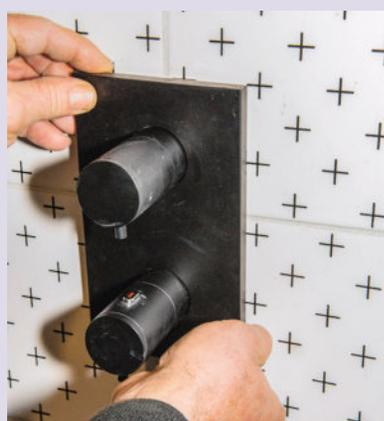
**32** Après séchage, supprimez le voile laissé par le mortier à joints à l'éponge humide. Posez la plaque du mitigeur, le coude de raccordement de la douchette et sa garniture.
