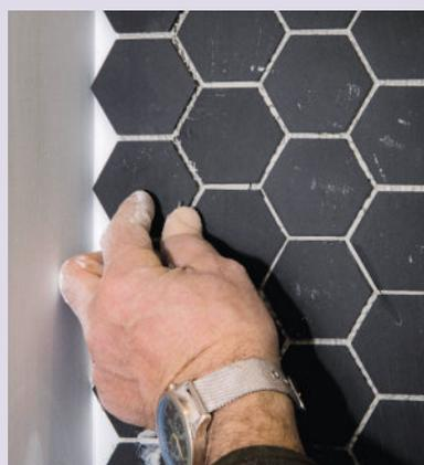
**29** Partout où c'est possible en revanche, les carreaux sont posés en bande. Il suffit pour cela de découper la trame synthétique d'une des plaques avec des ciseaux ou un cutter.
