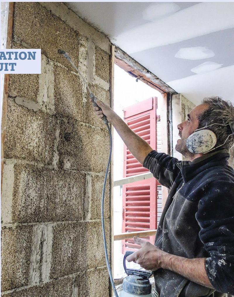
**19** Avant d'appliquer le corps d'enduit, il est nécessaire d'humidifier le chanvre à l'aide d'un pulvérisateur mais sans le saturer d'eau. Cette étape est importante, l'humification assure une meilleure accroche de la première passe d'enduit.
