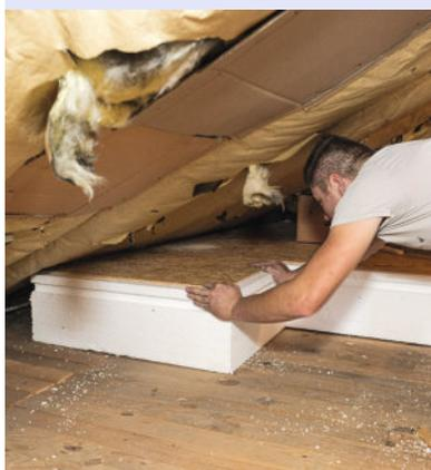
**3** Poursuivez la pose en prenant soin de décaler les joints transversaux d'une demi-longueur. Si besoin, coupez un panneau isolant en deux pour débiter un rang.
