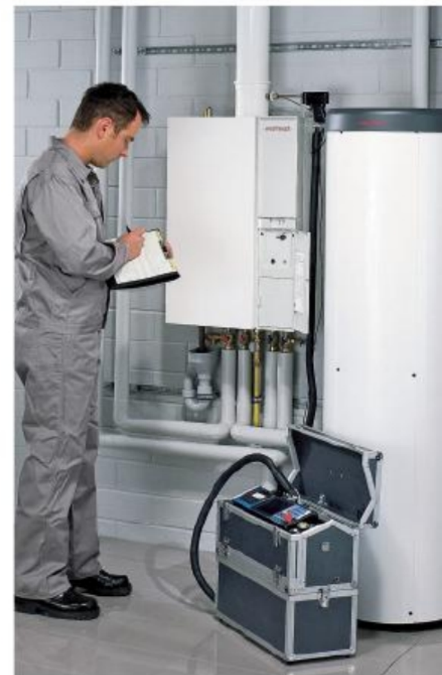
Für den Neubau geeignet sind vor allem Öl-Brennwertgeräte mit niedrigen Heizleistungen, die es auch als wandhängende Modelle gibt – hier mit Warmwasserspeicher. (Weishaupt)
