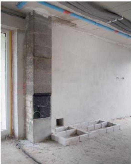
Noch in der Rohbauphase und bevor die Fußbodenheizung verlegt wird, erfolgt die Abmauerung des Sockels bis auf Höhe des späteren Estrichs.
