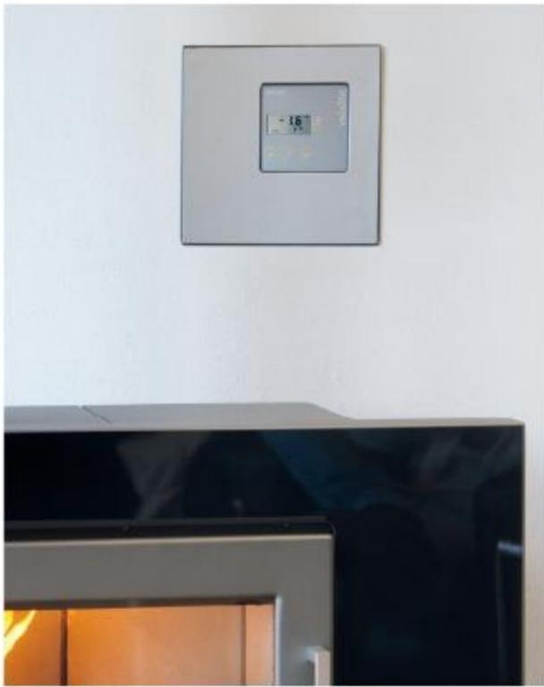
Differenzdruck-Controller „DS 01“ von Wodtke (links) sorgt bei raumluftabhängigen Öfen für die notwendige Sicherheit. Ebenso die SMS-Ofensteuerung (rechts) von Schmid und der Unterdruck-Controller „LUC“ von Leda (unten). Mit diesen Einrichtungen können auch raumluftabhängige Feuerstätten gemeinsam mit raumlufttechnischen Anlagen betrieben werden.
