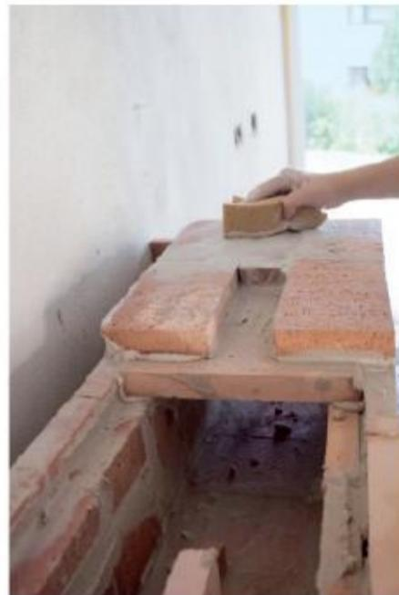
Die keramischen Züge werden individuell gebaut. Später gehen hier die heißen Heizgase durch und sorgen für die angenehme Strahlungswärme.
