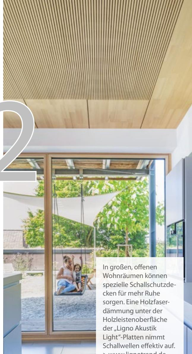
In großen, offenen Wohnräumen können spezielle Schallschutzdecken für mehr Ruhe sorgen. Eine Holzfaserdämmung unter der Holzleistenoberfläche der „Ligno Akustik Light“-Platten nimmt Schallwellen effektiv auf.
