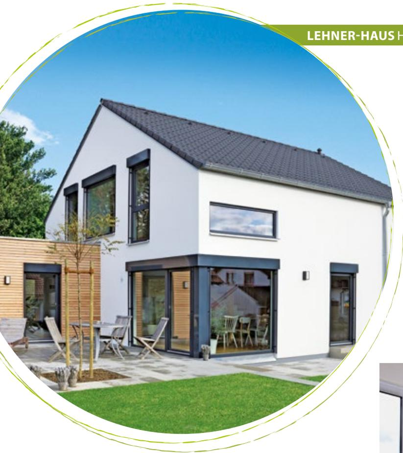
**Außenwand:** (von außen) Putz, 60 mm Holzfaserdämmplatte, 160 mm Holzrahmenkonstruktion, dazwischen 60 mm Mineralfaserdämmung, 12 mm Holzwerkstoffplatte, Dampfbremspapier, 12,5 mm Gipsbauplatte, Gesamtwandstärke circa 25 cm; mittlerer U-Wert 0,19 W/m<sup>2</sup>K
