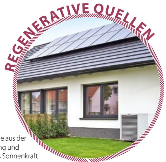
Mit Wärme aus der Umgebung und Strom aus Sonnenkraft heizt es sich besonders umweltfreundlich. Ein fein aufeinander abgestimmtes System aus Wärmepumpe „Flexocompact“, Photovoltaikanlage „Auro-power“ und Wohnraumlüftung „Recovair“ macht sich diese Energiequellen zunutze und trägt dazu bei, die Anforderungen für das KfW-Effizienzhaus 40 Plus zu erfüllen.
