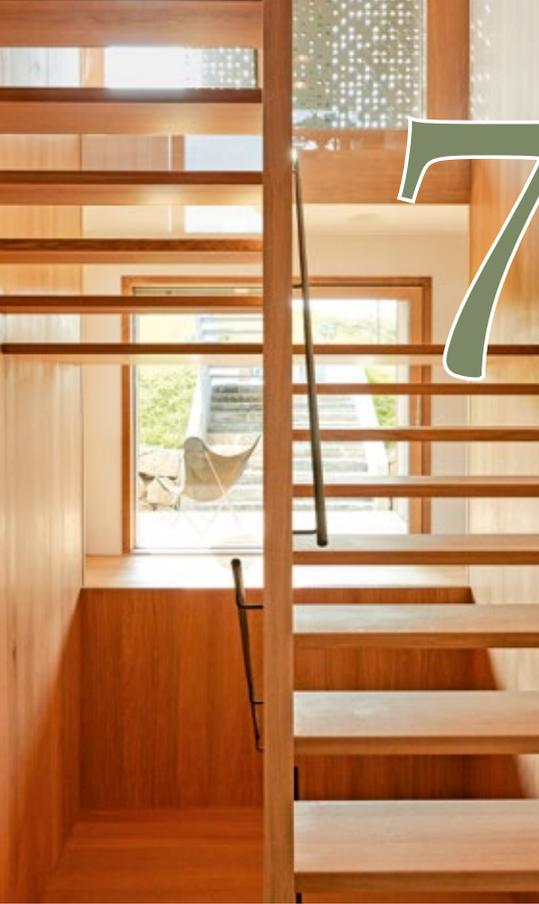
**HOLZTREPPEN** bieten dank unterschiedlicher Holzarten sowie moderner Design- und Konstruktionstechnik viele Ausführungs- und Gestaltungsmöglichkeiten: Ob vom Unterbau bis zum Geländer ganz in Holz oder kombiniert mit anderen Materialien, wie Glas oder Stahl, sind der Umsetzung als filigrane Kragstufentreppe, elegante Falwerk-konstruktion oder opulente Wendeltreppe praktisch keine Grenzen gesetzt. Außerdem sind Holztrep-pen in der Regel robust und strapazierfähig.
