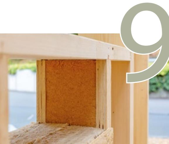
Verstärktes Ständerwerk aus Konstruktionsvollholz und gedämmten Stegträgern sorgen für um 15 Prozent verbesserte Wärmedämmung der patentierten „Atmo-tec“-Wand. > [www.buedenbender-hausbau.de](http://www.buedenbender-hausbau.de)
