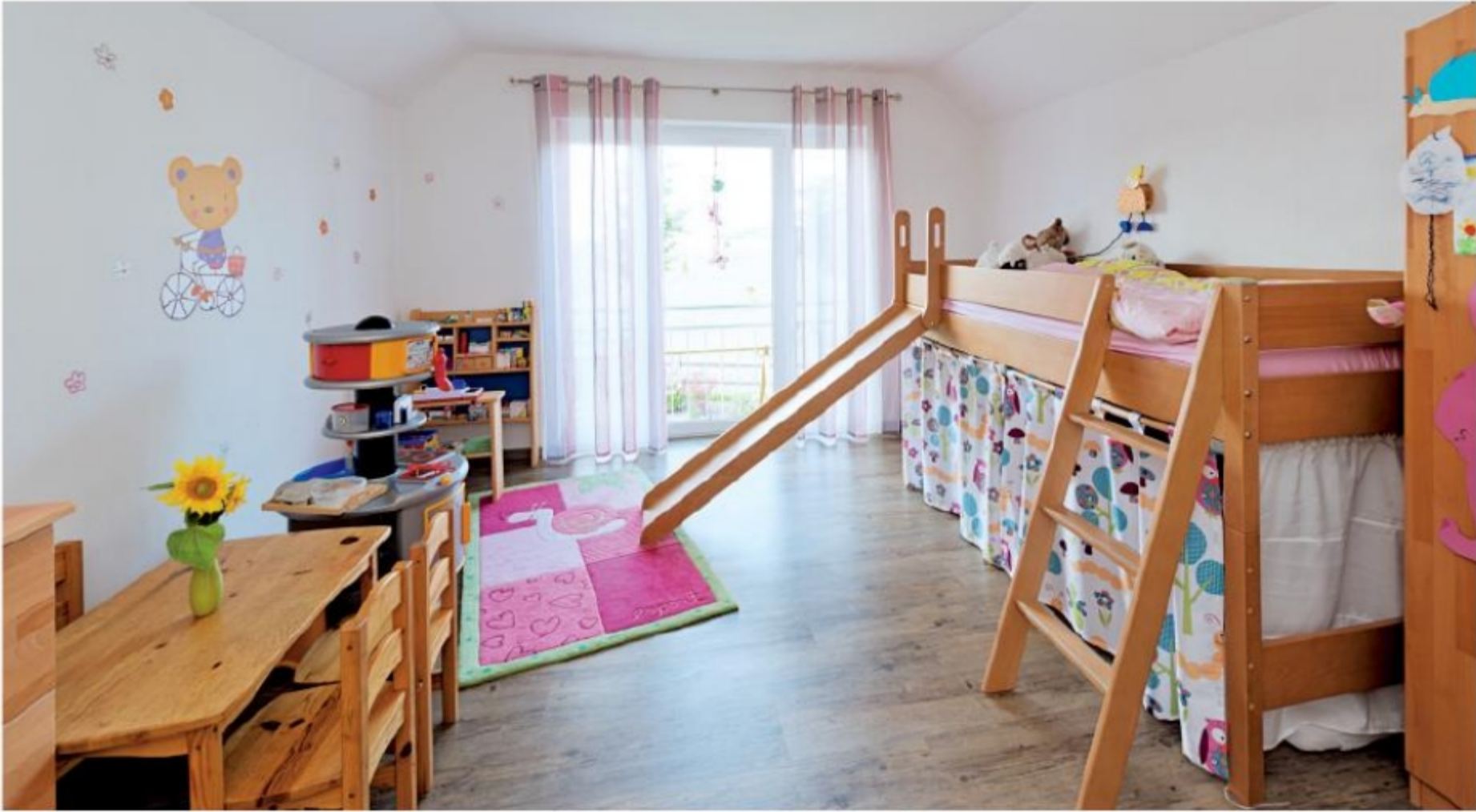
Den Fußboden im Obergeschoss haben die Bauleute in Eigenleistung übernommen: Der mit Kunststoff beschichtete Bodenbelag wird wie Parkett verlegt, ist aber unempfindlicher und biegsamer – und damit perfekt für das Kinderzimmer geeignet.
