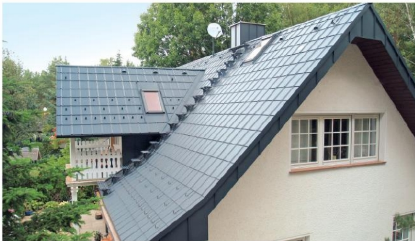
Da Aluminium sehr leicht ist, sind die Anforderungen an die Unterkonstruktion und die Gebäudestatik geringer und weniger aufwendig. Das spart Kosten. (Prefa/epr)
