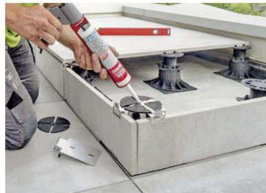
12 Sitzt die zweite Eckstellstufe mit entsprechendem Clip (auf dem anderen um 90 Grad gedreht aufgelegt), legt man das Trittschutz-Pad auf, trägt ...
