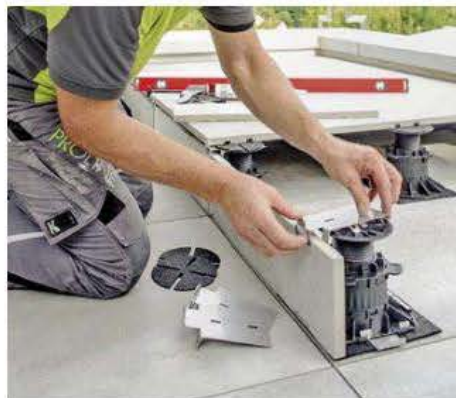
11 ... Stellstufe unten auf den Clip bis zum Außen-eck gestellt. Damit dieser auch oben gehalten werden kann, wird ein weiterer Halteclip angeklebt.
