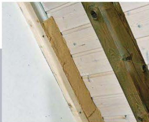
2 Mit vier Zentimeter dicken passend zugeschnittenen Holzfaser-Dämmstreifen wurde hier der Bereich bis zur Dachschalung hin schon einmal vorgedämmt.
