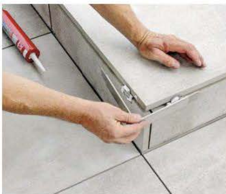
14 Dazu wird an den beiden Clipstegen Kleber aufgetragen, um so den Edelstahl-Eckwinkel anzubringen. Dieser dient zur Aufnahme der Blenden.
