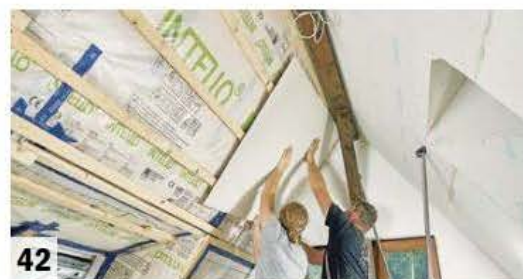
42 Die erste Platte wird ganz an die Firstpfette geschoben. Hier hat man mit der Verlegung in Querrichtung begonnen.
