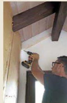
3. Für die späteren neuen Bauplatten hat man noch giebelseitig Traghölzer angeschraubt.
