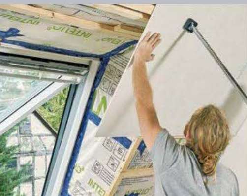
46 Diese Platte hat man bewusst erst einmal über die Fensteröffnung hinauslaufen lassen und abgestützt. Dann wurde sie wie gehabt ...
