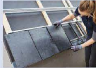
Die Schieferplatten sind dann schnell eingedeckt und bilden in einer Reihe eine eindimensionale Dachfläche mit Fugenraster.
