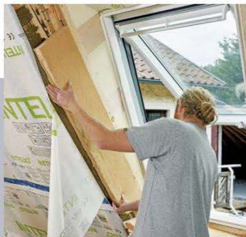
30 Die Laibungsdämmung schließt an ein 4 cm dickes Fenster-Hilfskantholz an und läuft vorne bis an die Sparrenunterseite. Oben setzt man noch ein Ergänzungsstück an.
