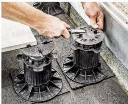
17 Unterlegt und ausgerichtet werden nur noch die Fugenstege der Längsrichtung abgetrennt, denn die Randplatten liegen hier mehr als nur am Eck auf.
