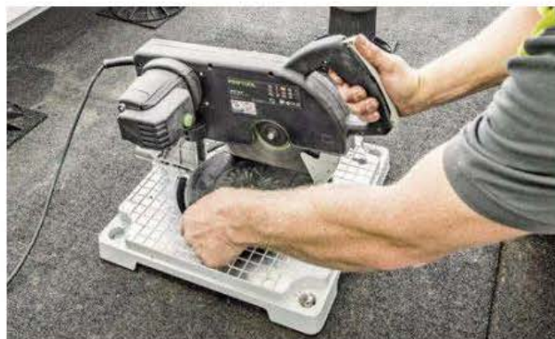
16 Nun ist nur noch die stimmige Randanbindung sicherzustellen: Für den Wandanschluss müssen die Stelzlager gemäß der markierten Linie auf der Rückseite zur Begradigung abgesägt werden.
