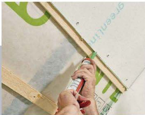
44 An der Unterkante der angeschraubten Platte trägt man in einem Zug den Verbindungskleber auf. Die Spitze hat eine Führungsnase, mit der man nur entlanggleitet.
