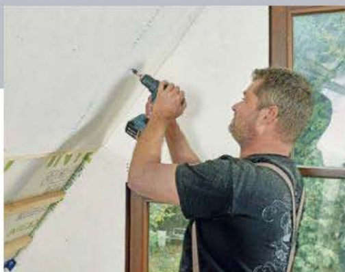
47 ... mit Schnellbauschrauben an den Traglatten verschraubt, zirka alle 20 bis 25 cm. Gut, wenn man sich zuvor an der Wand die jeweilige Lattenmitte markiert hat.
