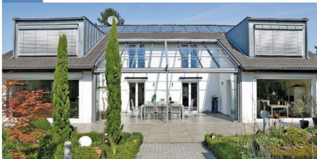
Nischenlösung: Als Einschnitt in die Gebäudekontur bietet eine solche Terrasse Wind- und Sichtschutz und mit einem Glashaus wird dem Gebäude die Außenkontur wieder zurückgegeben. Der Glasanbau füllt die Terrassenlücke vollständig aus und lässt sich auf gesamter Breite öffnen. www.solarlux.de
