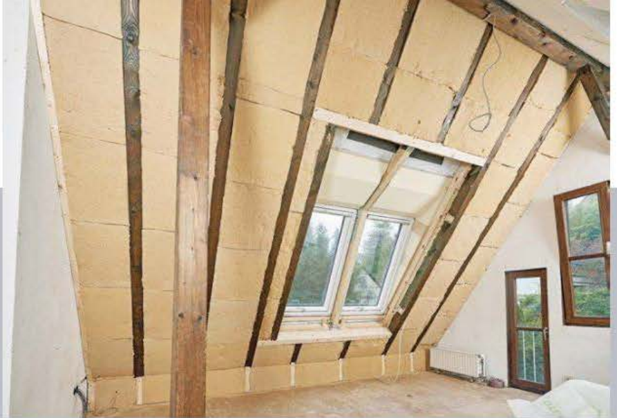
13 Mutet schon richtig wohligh warm an: Die linke Dachhälfte ist komplett von innen nachgedämmt, bis auf Höhe der Sparrenunterseite. Der Fensterausschnitt braucht aber noch ein paar ergänzende Hilfskonstruktionen, bevor auch hier Dämmung eingebracht werden kann (vgl. Abb. 22 und 26).
