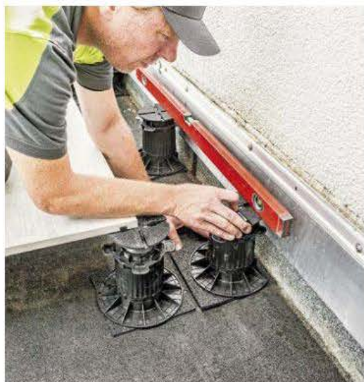
20 Mit Hilfe der Wasserwaage werden nun die Randelemente auf eine Höhe gebracht und mit der Höhe der Nachbar-Stelzlager abgeglichen.
