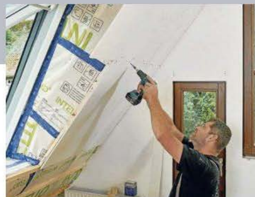
48 Die weitere Platte wurde dann jedoch schon exakt auf Endbreite (Laibung) geschnitten und in gleicher Art und Weise verklebt und verschraubt.
