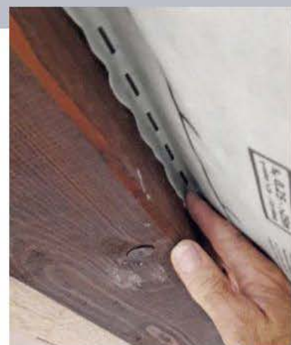
35 Nach sanftem Andrücken ist hier kein Weg mehr frei für Raumfeuchtigkeit. Die Kabel sind hinter der Ebene.
