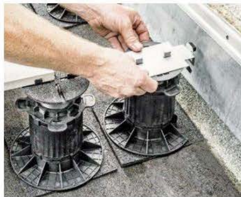
18 Es folgt das Auflegen des Abstandhalter-Clips mit Neopren-Pads. Das ist erforderlich, um später das Verwackeln der Platte zur Wand hin zu vermeiden.
