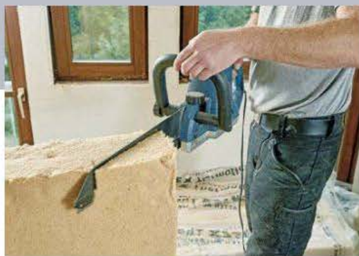
5 Die unteren Elemente wurden gemäß der Dachneigung angeschragt. Hierfür eignet sich ein Elektrofuchsschwanz, der spielend leicht durchs zähe Holzfasermaterial kommt.
