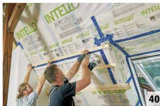
40 Wo Plattenstöße sind, verlegt man zwei Latten nebeneinander, sonst nimmt man 4 Latten pro Plattenlänge (1 m).
