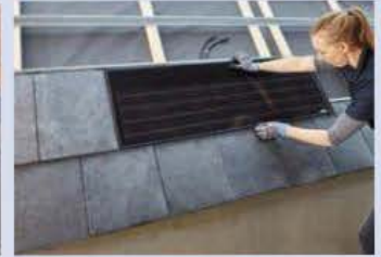
Die nächste Reihe wird halbversetzt angeordnet und überlappt die untere Reihe. Optional lassen sich PV-Module einhängen.
