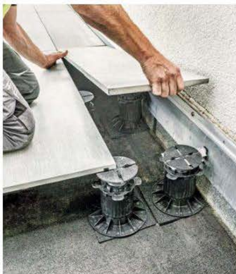
21 Das Verlegen der Terrassenplatten erfolgt sukzessive in Reihe. Der Abstand zur Wand bzw. zum Wandprofil der Abdichtungsbahn stellt sich...
