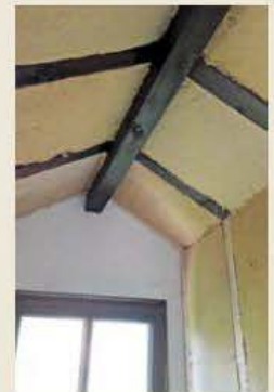
4. Die kleinen Satteldächer wurden sparrentief mit der Holzfaserdämmung verfüllt.
