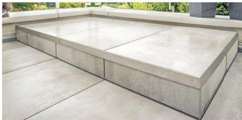
15 Und so stellt sich der Podestbereich dann dar. Die Plattenkanten verschwinden hinter Edelstahlprofilen, die an jedem Plattenstoß über die Clips gehalten werden. Die Höhe eines Podests kann übrigens mit dem entsprechenden Stelzlagermodell gewählt werden.
