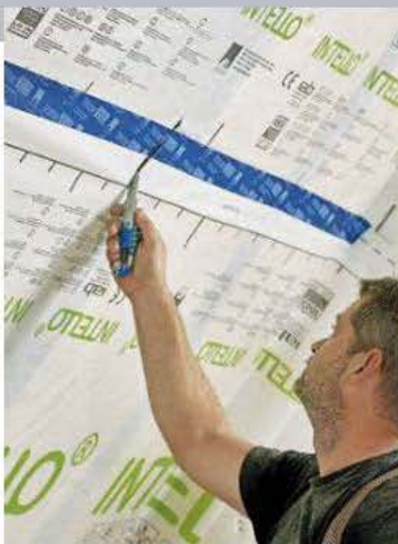
19 Das Dachfenster wird zunächst überzogen und dann so freigeschnitten, dass sich die Restlappen später nutzen lassen.
