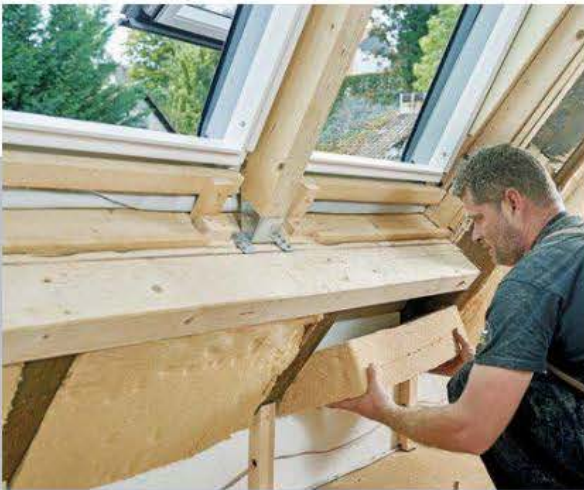
12 Auch unterhalb des Wechselbalkens für die neuen Velux-Dachfenster wurde entsprechend der Sparrentiefe Gefach für Gefach ausgedämmt.
