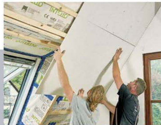
45 Die nächste Platte wird nun von unten herangeschoben etwas hin- und herbewegt, sodass sich der Kleber gut mit der neuen Kante verbindet.
