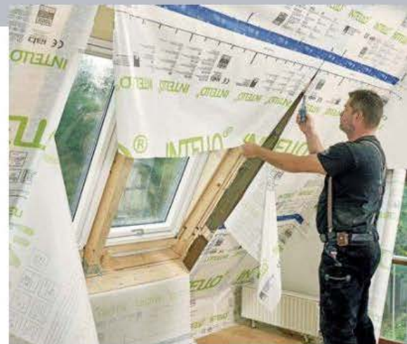
20 Denn Fensterlaibungen, Decke und Sims sollen ja jetzt auch noch gedämmt werden und anschließend ebenfalls unter die Schutzmembran gepackt werden.
