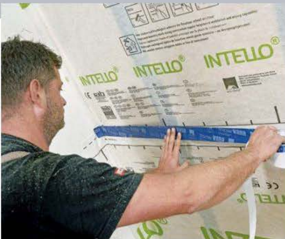
18 Mit dem breiten selbstklebenden Abklebeband werden die übereinander liegenden Dampfbrems-Bahnen dauerhaft sicher abgedichtet. Mit leichten Fingerdruck drüberstreichen.
