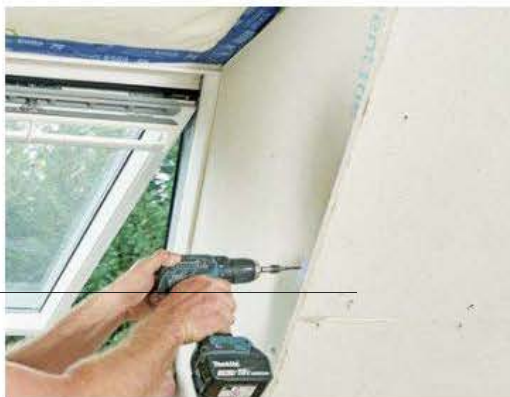
51 ... und zwar mit einem zuvor exakt zugeschnittenen Formstück. Diese Platte läuft von der Kante im rechten Winkel in die Nut des Fensterrahmens.
