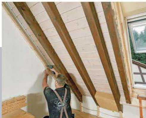
1 Das Sichtsparrendach mit außenliegender Profilschalung sollte von innen nachgedämmt werden. Das neue Kantholz dient später der Plattenauflege.
