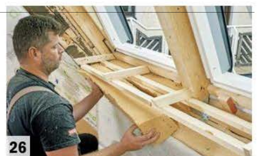
26 Am Dachfenster war ein Sims gewünscht – also hatte man aus Latten einen Unterbau gefertigt und darunter ausgedämmt.
