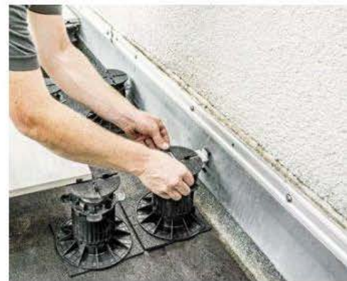
19 Das Trittschall-Pad wird wie gehabt über die Reststege gelegt, der Fuß ist bis dahin auch schon grob auf Niveau hochgedreht.
