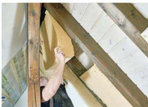
8 An der Dachspitze geht man dann folgendermaßen vor: Damit man bis hoch hinter die Firstpfette kommt, schiebt man zuerst das oberste Dämmelement bis ganz hoch.
