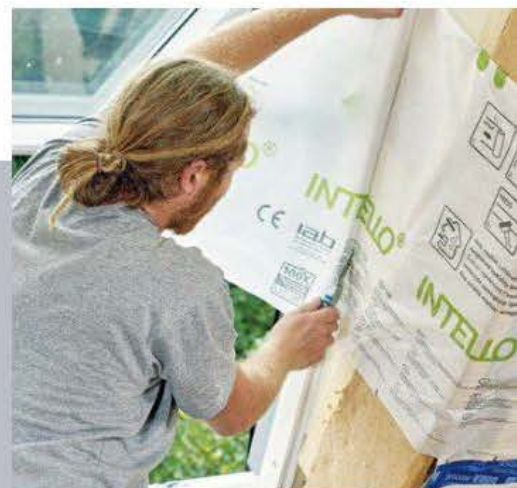
31 Gehalten wird die Seitendämmung, indem man den Folienlappen umschlägt, in der Nut des Fensterrahmens abschneidet und dort antackert.
