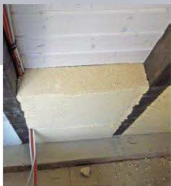
4 ... dass mit etwas Breitenzugabe das leicht stauchbare Dämmmaterial sicher einzuklemmen ist und festhält.
