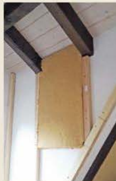
2. Die 4 cm dicken Dämmmatten wurden zwischen den Kanthölzern eingeklemmt.
