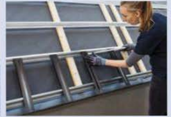
Im Weiteren geht es um das Einmessen der wasserführenden Verbindungselemente im entsprechenden Montageabstand.
