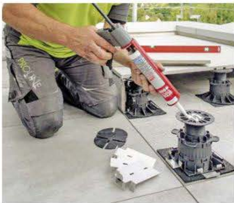
10 Alles wird mit PU-Kleber zusammengehalten, oben erfolgt auch noch ein Auftrag für die weiteren Systemteile. Doch erst wird nun die nächste ...
