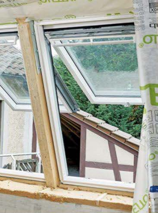
30 Die Laibungsdämmung schließt an ein 4 cm dickes Fenster-Hilfskantholz an und läuft vorne bis an die Sparrenunterseite. Oben setzt man noch ein Ergänzungsstück an.
