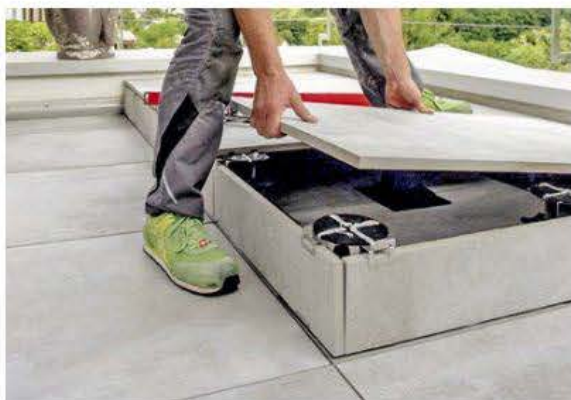
13 ... auf allen Auflager Kleber auf und legt die Eckplatte vorsichtig auf. Damit ist die Podesteck-Situation fast schon fertig. Es geht jetzt nur noch um die Verblendung.
