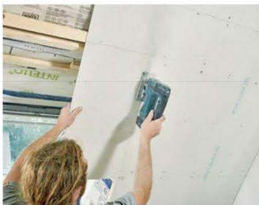
49 Nun wurde der Überstand der Platte darüber (Abb. 45) mit der Stichsäge in Verlängerung der unteren Platte abgesägt und so eine stimmige Laibungskante erstellt.
