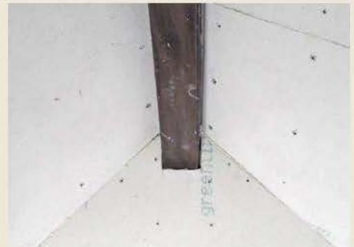
7. Mit passgenau zugeschnittenen Gipsfaserplattenstücken wurden die Gaubenschrägen bekleidet. Die Firstpfette blieb als konstruktives Element in seiner ursprünglichen Form sichtbar.
