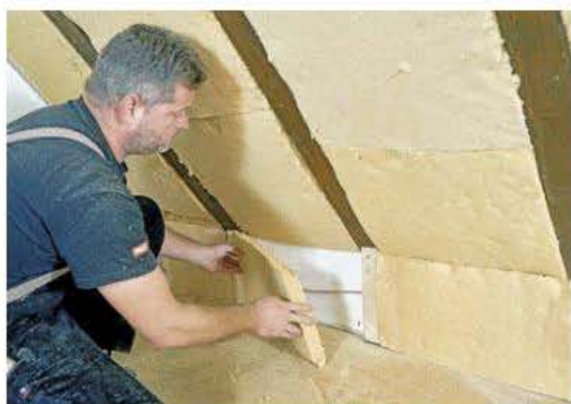
7 Für den schmalen Kniestock hatte man zuvor senkrechte Kanthölzer in Verlängerung der Sparren angeschraubt und nun mit 4 cm dicken Holzfaserstücken nachgedämmt.
