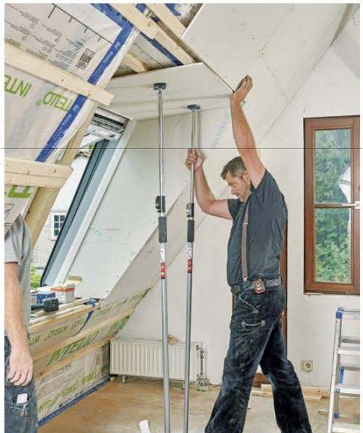
6. Eine diffizile Angelegenheit – die Tragkonstruktion für die Bauplatten hin zum Hauptdach.
