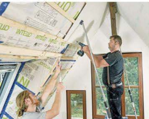
43 Mit der Montagestütze hat man beide Hände frei zum Schrauben. Hier verschraubt man an einer nicht sichtbaren zweiten Parallellatte.
