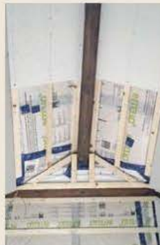
6. Eine diffizile Angelegenheit – die Tragkonstruktion für die Bauplatten hin zum Hauptdach.
