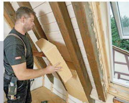
3 Die Sparrentiefe war so bemessen, dass die 14er-Dämmmatten perfekt die Tiefe ausfüllen konnten. Der Zuschnitt erfolgte so, ...
