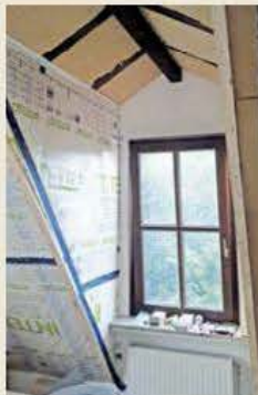
5. Vom Hauptdach aus verlegte man dann die Dampfbremse bis vor an die Fensterseite.
