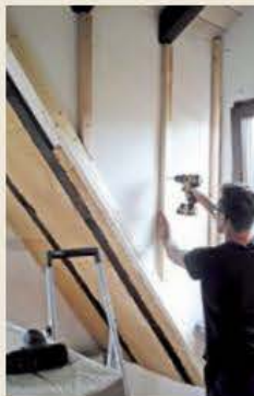
1. Zuerst doppelte man auf der alten Bauplattenlage im Bereich der Balken 4 cm auf.
