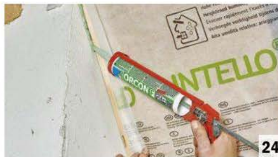
24 Anschluss der Dampfbremsmembran an die Außenwand: Der Kleber sorgt dafür, dass die Folie sicher (hier auf Putz) hält.
