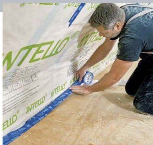
36 Die Dampfbremse muss auch am Fußboden ihren lückenlosen Abschluss finden. Dazu zieht man sie vom Kniestock über den Rohboden und klebt das Ende ab.
