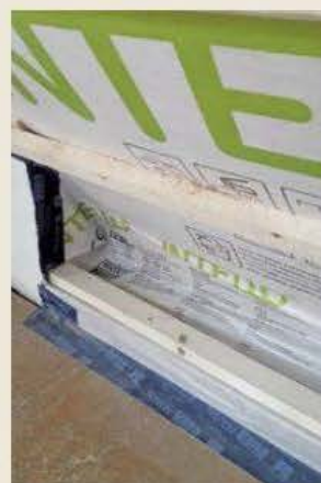
31 Gehalten wird die Seitendämmung, indem man den Folienlappen umschlägt, in der Nut des Fensterrahmens abschneidet und dort antackert.
