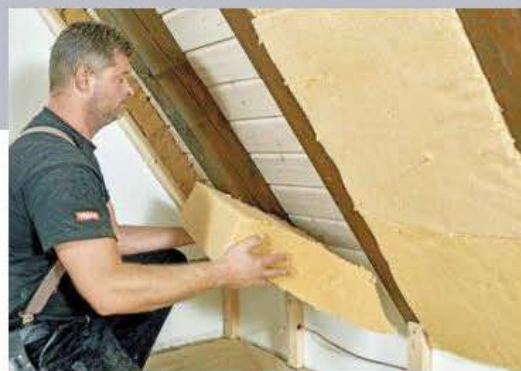
6 Und so bauten sich die einzelnen Sparrenfelder von unten nach oben auf. Element an Element dicht gestoßen und bis nach hinten an die Brettschalung herangedrückt.
