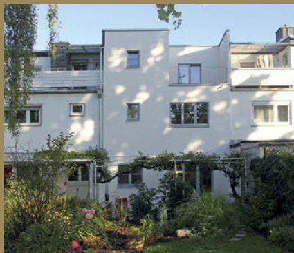
Gesamtsanierung eines Reihenmittelhauses aus den 1920er Jahren; Bauherr: Boy, Frankfurt a.M.
