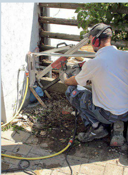
19. Den Weg frei für die Solarleitung ins Haus macht eine Kernbohrung von außen. Diese wird im 45-Grad-Winkel ausgeführt, ...
