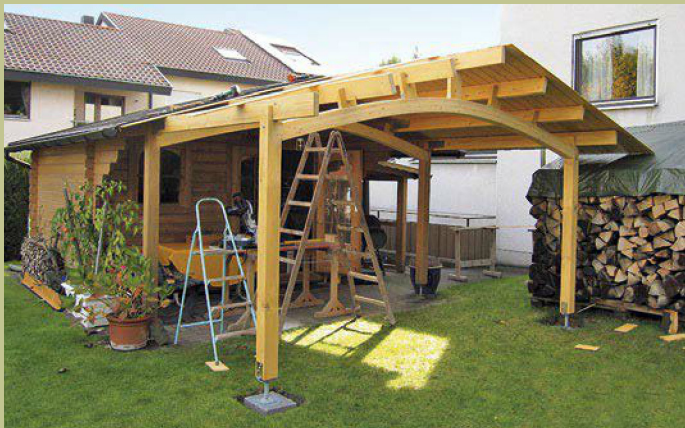
1. Vor dem Garten-Blockhaus war genügend Platz für eine Dachverlängerung. Mit 2 Bögen sowie 7 Längssparren war der Dachstuhl fertiggestellt.
