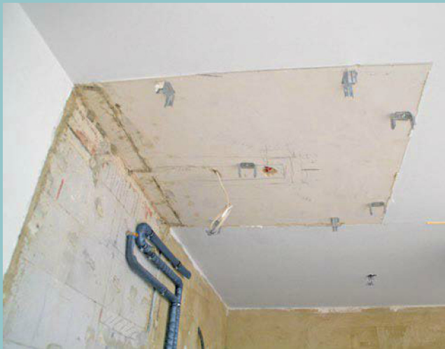
6. An der Decke bereiten die Installateure die Montage für den Duschkabinenhimmel vor. Hier wurde eine individuelle Lösung erarbeitet.
