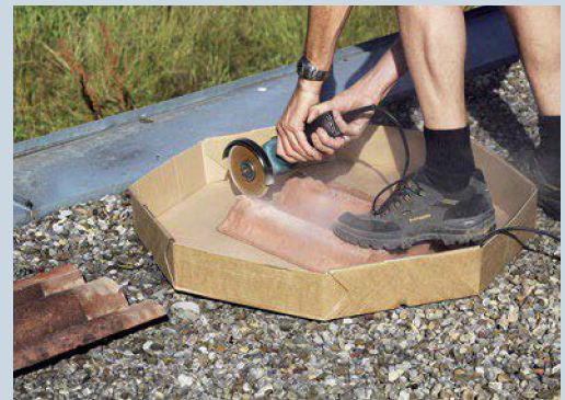
6. Damit die Dachsteine nicht absteigen, wenn sie auf den montierten Haken eingegliedert werden, schneidet sie der Monteur per Winkelschleifer zu.
