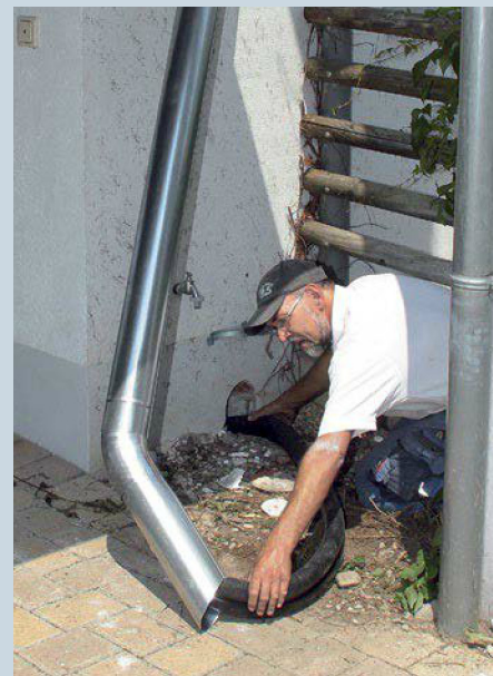
20. ... sodass die Solarleitung aus dem Fallrohr heraus direkt in Deckenhöhe im Versorgungsraum ankommt.
