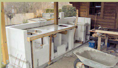
4. Abgeschalt, abgestützt und mit maßgenauen Ausschnitten für Keramikgrill, Gas-Grillstation und Kochfeld versehen wurde die Arbeitsplatte betoniert.
