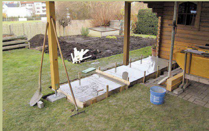
2. An der dem Garten zugewandten Längsseite wollte man die Küche platzieren. Hier entstand dann das passend abgemessene Betonfundament.
