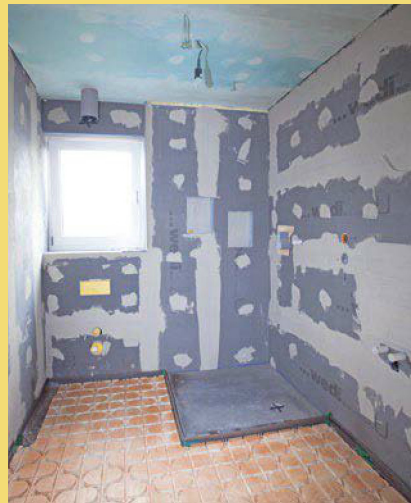
6. Um das Duschelement herum wurde eine Fußbodenheizung mit geringer Aufbauhöhe verlegt, die Trockenestrich und Rohrführungsebene zugleich ist.
