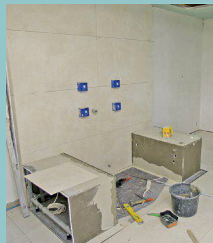
5. Rückwand sowie Sitzbänke erhielten eine Bekleidung aus modernen, großformatigen Natursteinplatten.
