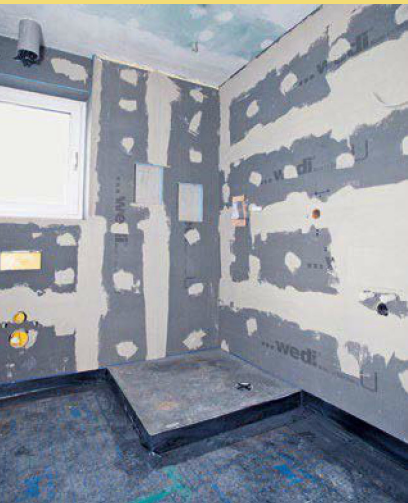
5. Die Bauplatten sind gesetzt, verklebt und armiert. Der Gefälle-Duschboden ist auf die später benötigte Endhöhe gebracht.
