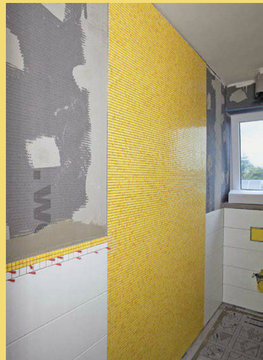
9. Soll nicht die gesamte Wand verfliesen werden, ist es auch möglich, direkt auf den Bauplatten zu verputzen.
