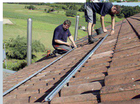
8.+9. Sind alle Dachhaken nach Plan montiert, werden die Montagelochschienen mit Edelstahlschrauben darauf befestigt und die Kollektoren kommen aufs Dach.
