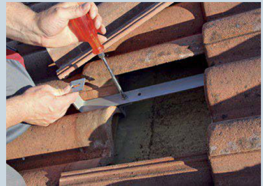
4. Mit Überlappung von einer Daumenlänge liegt der Haken satt auf dem unteren Dachstein auf. Die Klemmverschraubung wird fest angezogen, ...
