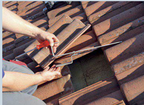
3. Der Dachhaken hat eine spezielle Klemmkonstruktion. Auf ihm wird später die Montagesciene zur Befestigung der Kollektoren verschraubt.
