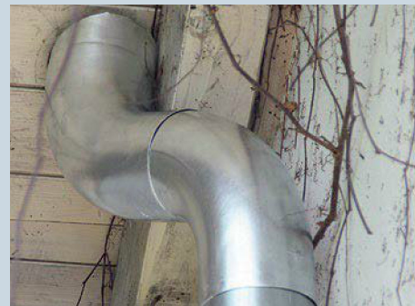
18. Vom Dachauslass bis zum Sockel des Hauses verläuft die Solarleitung gut geschützt und getarnt senkrecht nach unten.
