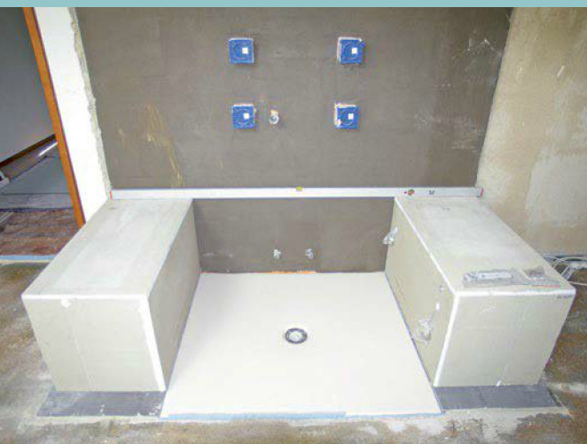
3. Die Sitzbänke wurden ebenfalls auf Wunschmaß gefertigt und mit Bauplatten befliesfähig aufgebaut. Als Duschboden fungiert eine flache Stahlemail-Duschtasse mit Mittenablauf.
