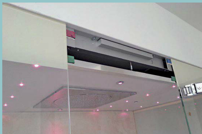
8. Zugänglichkeit zur Technik ermöglicht eine Glasblende, die harmonisch in die Gesamtansicht eingebunden ist.
