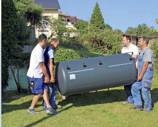
23. ... die zum Systemspeicher führen, an. Ohne Dämmung hat der Speicher einen Durchmesser von 790 mm und passt so gut durch die Türen.
