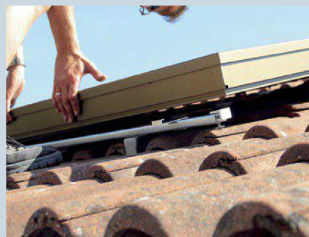
10. Das auf der Unterseite des Kollektors eingearbeitete Montageeinhängeprofil dient als Montagehilfe, damit der Kollektor gleich richtig sitzt.
