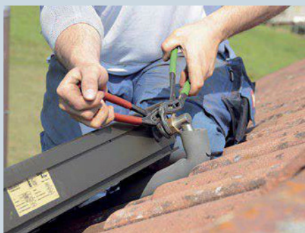
14. Auch die Solarleitung vom Kollektor in den Keller besteht aus einem Edelstahlwellrohr. Mittels Klemmringverschraubung wird der Vorlauf ...
