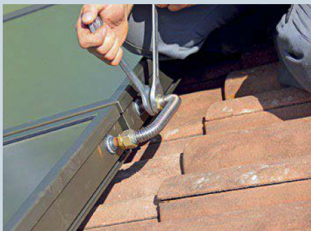
12. Detaillösung bei den Kollektorverbindern: Metallisch dichtende Verschraubungen und ein Edelstahlwellrohr trotz jeder Jahreszeit, ...
