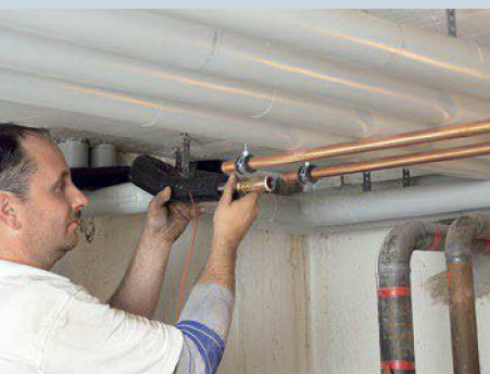
22. Der Heizungsbauer nimmt das Solarwellrohr in Empfang und schließt es an die Kupferrohre, ...
