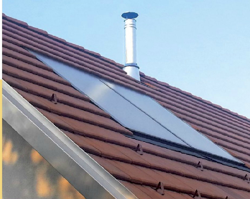
Bei einer dachintegrierten Einbausituation bleiben die Module hinter der Dachhaut zurück, sodass auch moderne flachliegende Dacheindeckungen gewählt werden können.
