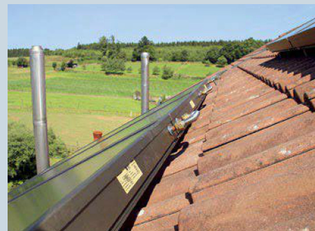
13. ... hohen Temperaturunterschieden und halten dauerhaft dicht. Die Kollektoren in Reihe und Glied sind solide miteinander verbunden.
