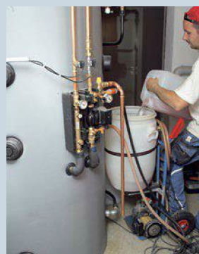
29. Der Solarkreislauf wird mit hochtemperaturbeständigem Frostschutz befüllt.
