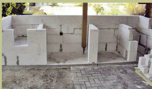
3. Entsprechend der späteren Nutzung bzw. Geräte-maße hat man eine Rückwand gemauert und dabei auch Trennwände eingebunden – alles aus Porenbeton.
