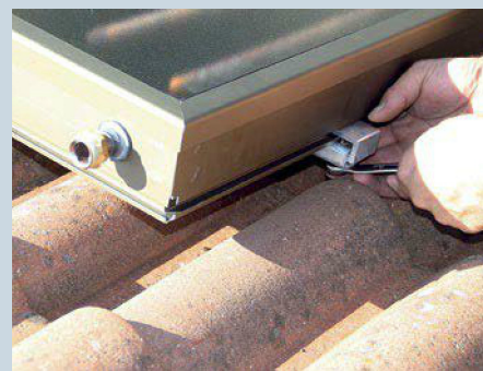
11. Mit Hilfe stabiler Endklemmen aus Aluminium werden die Kollektoren zusätzlich auf der Lochschiene gesichert.
