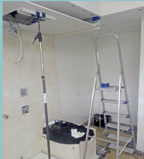
7. In einer abgehängten Platten-Konstruktion ist dann auch der Regenhimmel integriert. Hier ist dann auch schon die erste Glasscheibe seitlich montiert.
