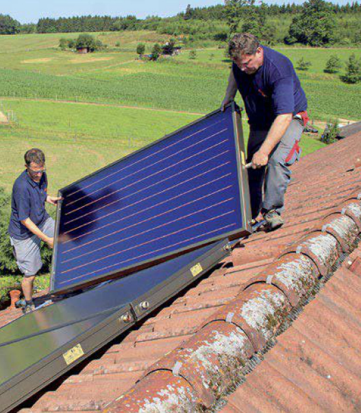
10. Das auf der Unterseite des Kollektors eingearbeitete Montageeinhängeprofil dient als Montagehilfe, damit der Kollektor gleich richtig sitzt.
