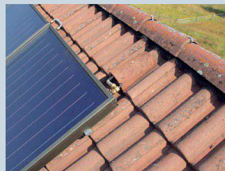
16. Das Montageteam hat die Rohrleitungen mit Hilfe von Lüfterelementen elegant unter der Dachhaut verschwinden lassen.
