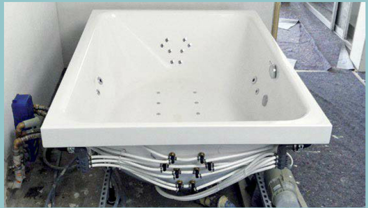
10. Die Wanne wurde werkseitig mit individuell platzierten Düsen und Licht bestückt. Vor Ort galt es dann, sie exakt auszurichten und anzuschließen sowie mit der Pumpentechnik auszustatten.
