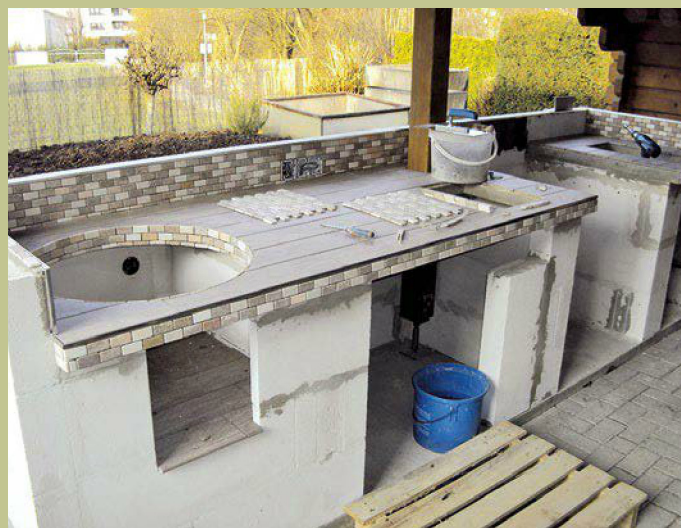
5. Feinarbeit war dann beim Verfliesen mit Mosaik angesagt. Die Rückwand, die Vorderkante, aber auch die Innenrundung sollten so verfliesen sein. Auf der Fläche hingegen kamen Fliesen in Holzoptik zum Einsatz.
