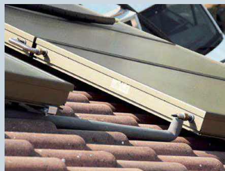
15. ... am Kollektor verschraubt. Bei Temperaturen zwischen -20^{\circ}\text{C} und +220^{\circ}\text{C} kommt es auf das richtige Verschraubungssystem an.
