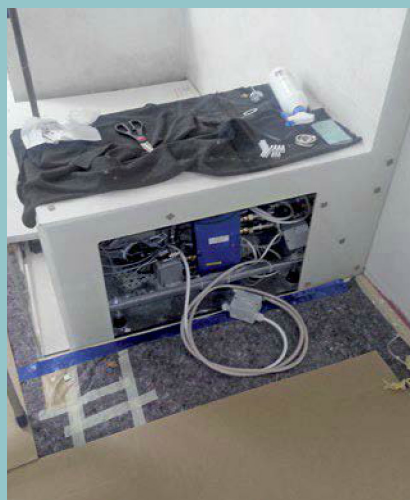
4. Im Hohlkörper der rechten Sitzbank konnte somit auch die ganze Dampftechnik platzsparend untergebracht werden.
