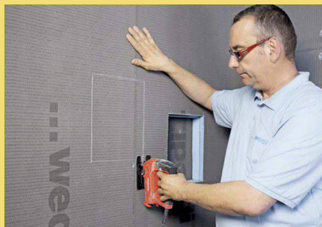
4. Aussparungen – wie hier die Nischen in der Dusche – werden einfach mit einer Stichsäge ausgeschnitten. Bauwünsche, die spontan entstanden sind, können somit – bis zum Zeitpunkt der Verfliesung – auch nachträglich umgesetzt werden.
