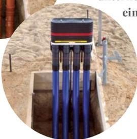
Der FHRK (Fachverband Hauseinführungen für Rohre und Kabel e.V.) rät Bauherren und Planern, sich frühzeitig mit den zuständigen Versorgungsunternehmen über Lage und Art der Leitungseinführung abzustimmen. Da Netzbetreiber das Recht haben, vorzugeben, wie sie Kabel und Rohre in das Gebäude führen, können Bauherren, die dies versäumt haben, andernfalls ein kostspieliges Problem bekommen. Ausführliche Informationen gibt es im Internet unter > [www.fhrk.de](http://www.fhrk.de)
