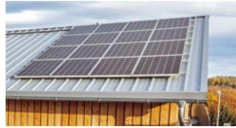
Ein integraler Baustein des Energiekonzeptes ist eine PV-Anlage mit einer Leistung von 10 kWp auf dem Dach des Gebäudes.
