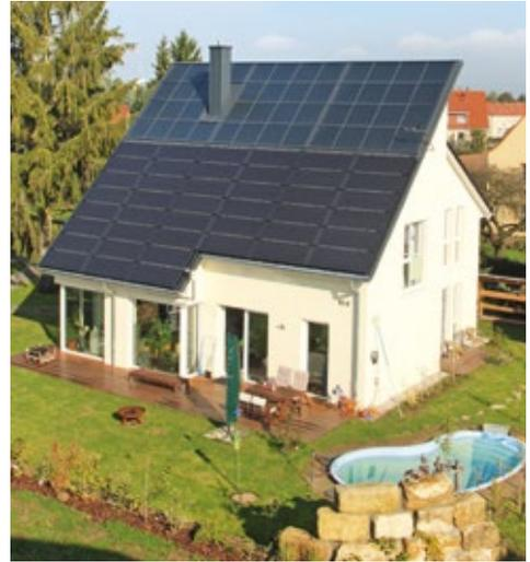
Das nach Süden ausgerichtete 45 Grad steile Dach ist komplett mit Solarelementen – sowohl für Photovoltaik als auch für Solarthermie – ausgestattet.
