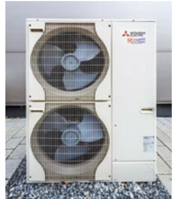
Um die Wärmeversorgung für das Gebäude und die Wärmekammer kümmert sich bei diesem Projekt eine Luft/Wasser-Wärmepumpe.
