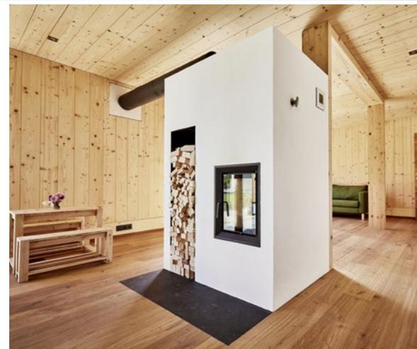
Der wassergeführte Kachelofen im Erdgeschoss kann das gesamte Haus erwärmen. Zurzeit wird noch mit Bauholz-Resten geheizt.
