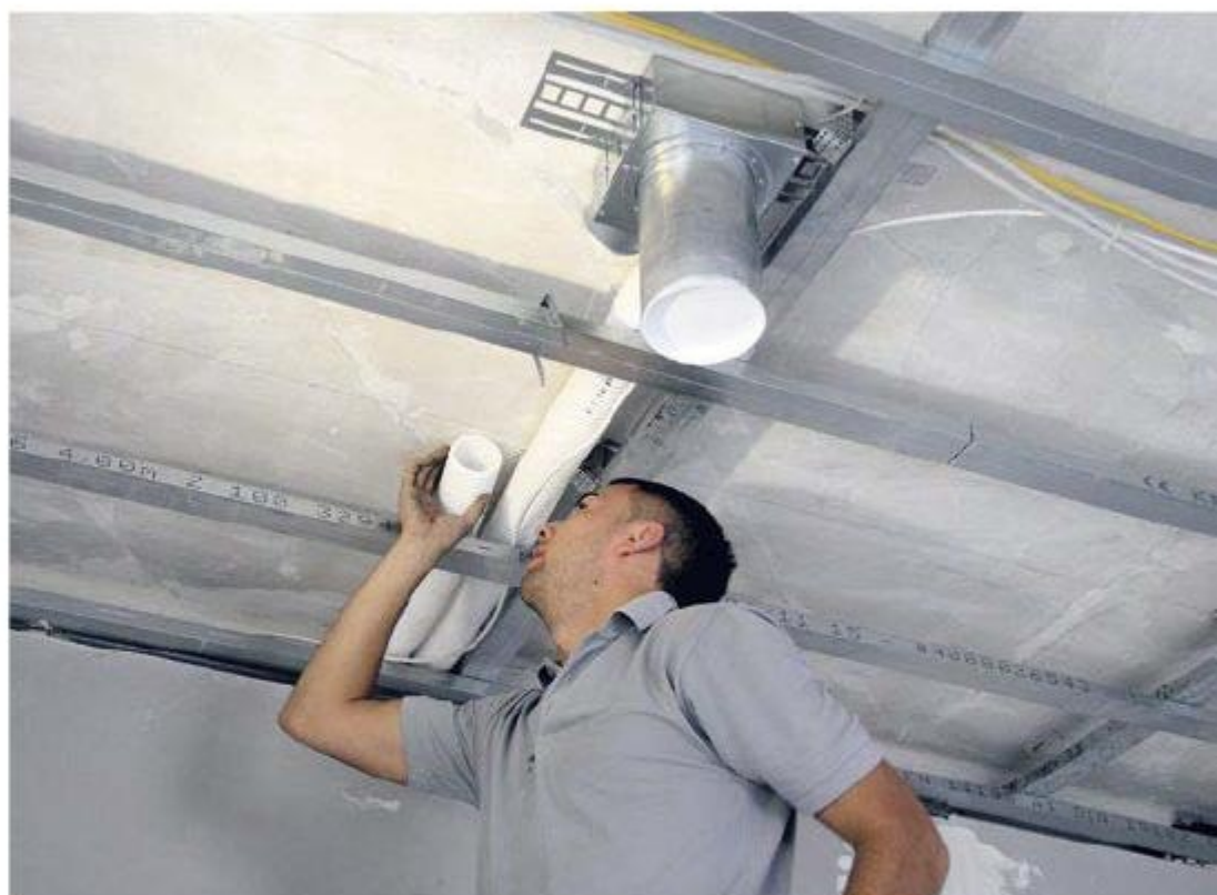
Im Renovierungsbereich werden runde, eckige oder ovale Luftleitungen oft unter einer abgehängten Decke zu den Deckenauslässen geführt. Von dort gelangt die Frischluft in die Wohnräume. www.zehnder-systems.de
