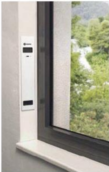
Bild oben: Lüfter für den Fenster-Laibungsbereich. Unten: Eingebauter Lüfter.
