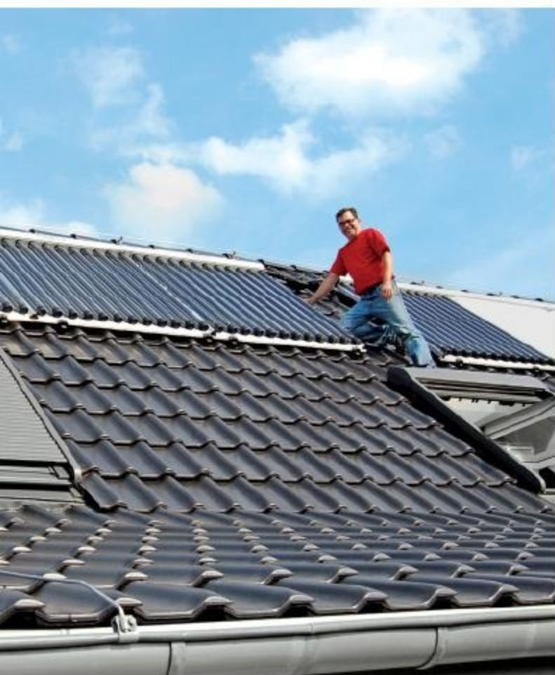
Röhrenkollektoren sind auch bei diffusem Sonnenlicht effizient und leistungsfähig.
