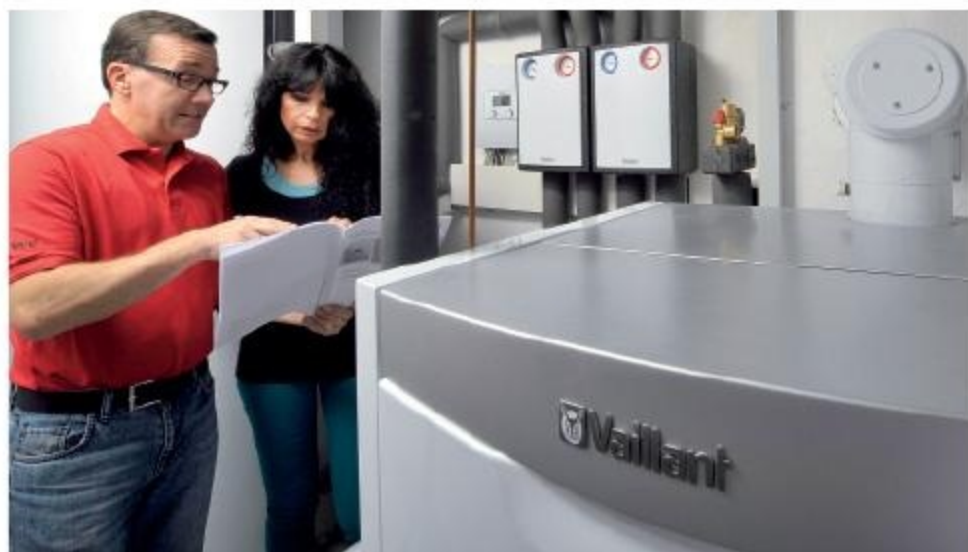
Fachhandwerker Rawe erläutert Bauherrin Christine Daiber die Funktion der neuen Heizungsanlage.
