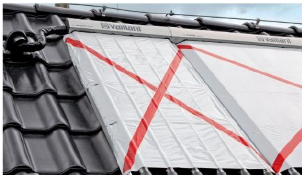
Über spezielle Solar-Durchführungspfannen werden die wärmedämmten Solarleitungen in das Dach geführt.
