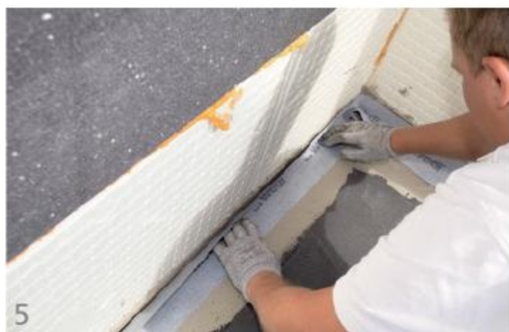
1. Die Betonplatte ist freigelegt, gesäubert und für die nachfolgenden Arbeiten vorbereitet. 2. Die Gefälleplatten sind auch zur unteren Lage stoßversetzt zu verlegen, um noch mehr Stabilität zu bewirken. 3. Das Dichtset wird zur Fugenabdichtung eingesetzt. Erst wird die 2-K-Dichtschlämme aufgetragen. 4. Anschließend werden die Dichtbänder zugeschnitten, aufgelegt, eingedrückt und zugleich glatt gestrichen. 5. An den Hauswänden wird gleichermaßen – aber mit aufgewinkelten Bändern – abgedichtet. 6. Die Fliesen verklebt man im sogenannten Buttering-Floating-Verfahren. 7. Das heißt, ein satter, vollflächiger Mörtelauftrag findet auch auf jeder Fliesenrückseite statt.
