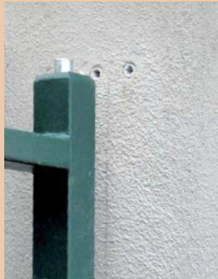
22. Und so sollte das dann aussehen. Die Dübel sitzen im richtigem Abstand und in richtiger Höhe.
