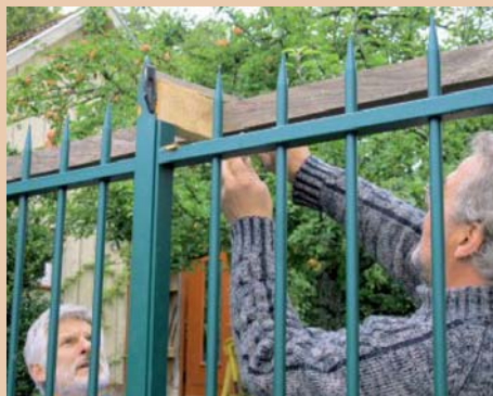
17. Nun die Flügel aus ihrer Seitenneigung in die Senkrechte bringen und per Distanzholz fixieren.
