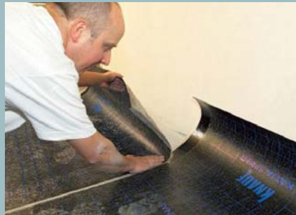
28. Die Nahtbereiche sind so ausgeführt, dass man die Überlappung einfach verkleben kann.
