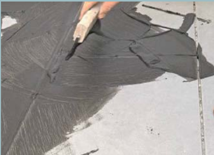
42. Das Fugenmaterial per Gummiwischer mehrfach quer und diagonal einarbeiten.
