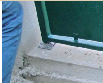
14. Jetzt geht es noch darum, den Flügel so in Position zu bringen, dass er senkrecht dasteht. Dazu ...
