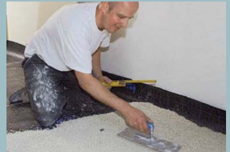
30. Mit einer Traufel kann man das Material fürs Erste grob verteilen und auf Höhe bringen.
