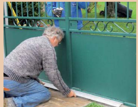
18. Wichtig jetzt auch noch einmal das exakte Fluchten der beiden geschlossenen Flügel.
