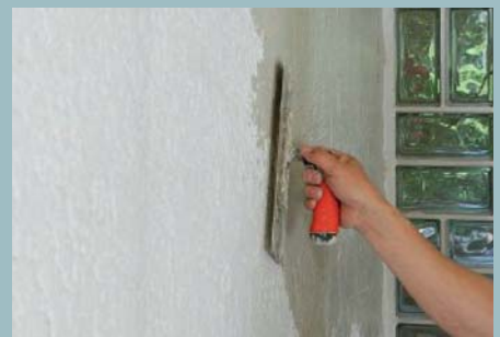
3. Gut zu sehen im Detail, wie die groben Reibespuren mit dem Gipsspachtel geglättet werden.
