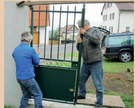
13. Dann kann schon der erste Flügel (hier der kleinere) auf den Bodendorn gesetzt werden.
