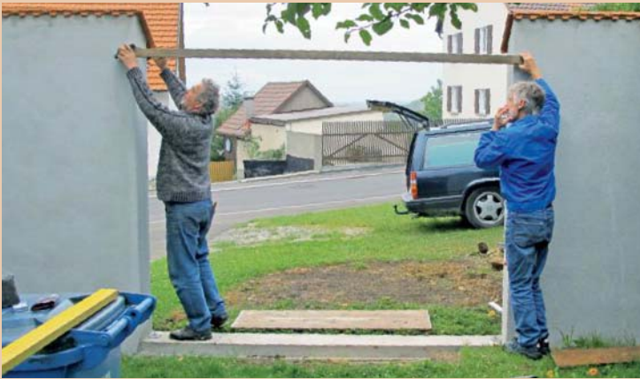
12. Erste Vorbereitung für die Flügelmontage: Zwischen den Mauerscheiben wird eine Hilfsplatte mit Schraubzwingen fixiert, sodass das Tor nicht seitlich wegkippt.
