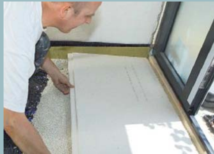
32. Die Estrichplatten sollen ja später den Trittschall nicht auf die Wände übertragen.
