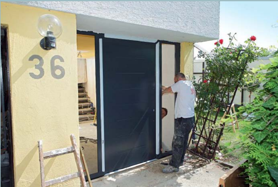
18. Die ganze Türanlage inklusive eingehängtem Türblatt muss dann noch exakt ausgerichtet werden.
