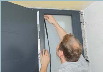
25. Das umlaufende Dichtprofil sorgt für fugenfreien und putzfreundlichen Anschluss ans Glas.
