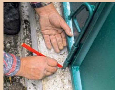
26. ... für den Bodenriegel. Er benötigt eine kleine Vertiefung in der Betonschwelle, die im geschlossenen Zustand angezeichnet wird.
