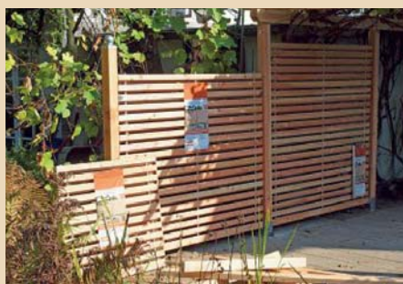
19. Dann werden die einzelnen Zaunemente ausgerichtet und angeschraubt.
