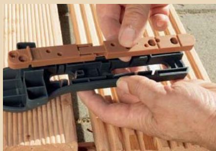
25. Verbinder in die Bohr- und Schraublehre einlegen, Diele mit der Rückseite ...
