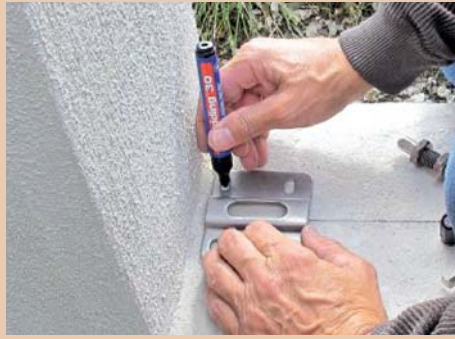
5. Für die Flügelaufnahme auf der Schwelle werden nach Vorgaben die Montageplatten platziert.
