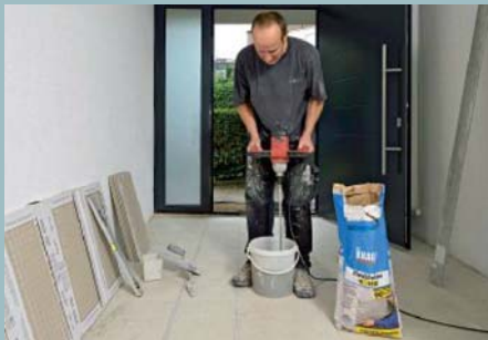
36. Der Trockenstrich wird direkt beflies. Unser Flexkleber ist besonders staubarm anzurühren.
