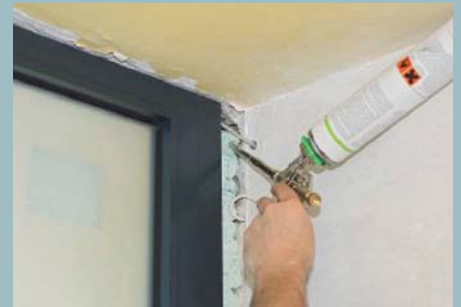
26. Zur Wand hin wird mit Bauschaum dicht angeschlossen. Der Bereich wird später angeputzt.
