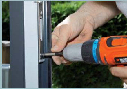
20. Weitere Arbeiten wie das Anschließen und Anschrauben des elektrischen Schlosses folgen.
