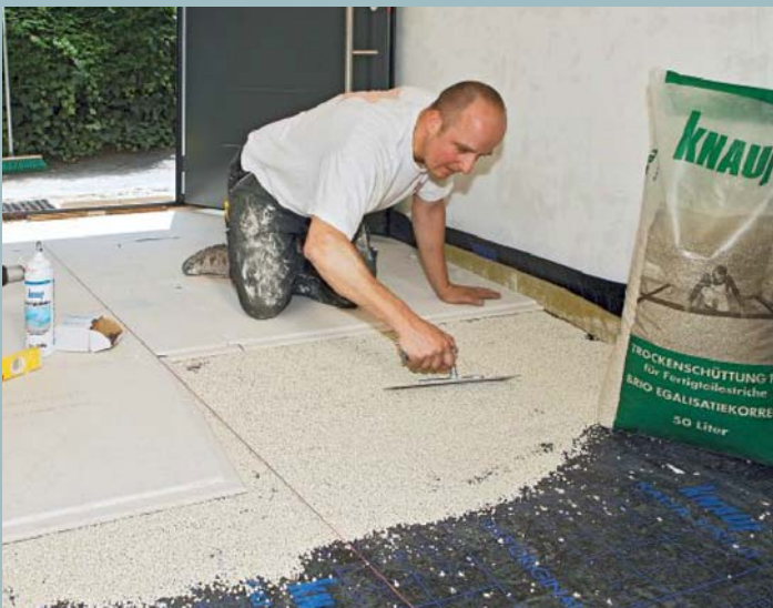
35. Mit den handlichen Platten kann man sich sukzessive voranarbeiten. Die Platten sind sofort begehbar. Die entsprechende Einbauhöhe hat man übrigens zuvor festgelegt.
