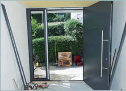
22. Und so sieht die erste Etappe dann aus. Jetzt warten noch die Festelemente auf ...
