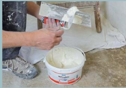
5. Mit dem fertig angemachten Gipsglätter lassen sich dann noch ganz perfekte Flächen erzielen.
