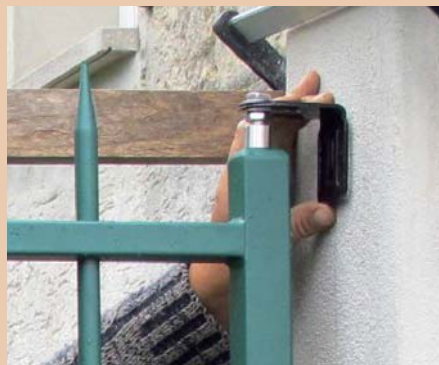
20. ... gilt es, den exakten Sitz der beiden oberen Halterungen als Drehpunkte zu ermitteln.
