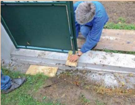
15. ... ist es am einfachsten, den freien Flügelrahmen mit Brettabschnitten zu unterlegen.
