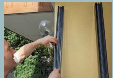
15. Für eine spätere Laibungsdämmung von außen, ergänzte man noch mit Zusatzprofilen.
