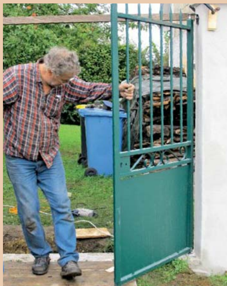
23. Erst wenn oben alles fest sitzt (siehe Infokasten), kann man zum ersten Mal das Tor frei aufschwingen.
