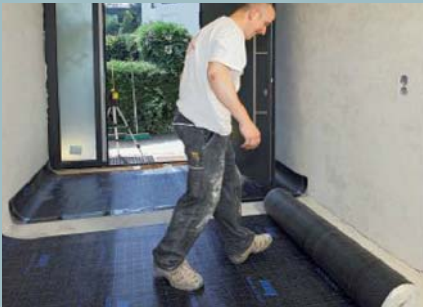
27. Weiter geht's am Boden: Die Abdichtbahn wird auf der Spachtelfläche quer ausgerollt.
