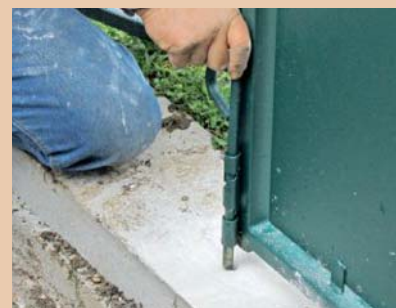
27. Der Riegel sitzt am großen Flügel und ermöglicht so das Öffnen des kleineren Gektors, ohne dass er selbst mit aufgeht.
