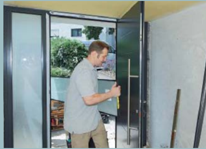
23. ... ihre Verglasung. Links ist schon verglast, das rechte Scheibe kommt gerade herein.
