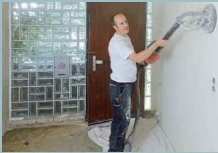
4. Eine Nachglättung erfolgt nach dem Austrocknen. Hier ist die Giraffe ein bequemer Helfer.
