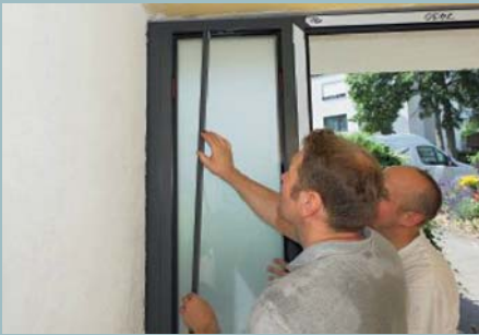
24. Damit das Glas Halt bekommt, bringt man rundum Glashalteleisten ein und drückt sie fest.
