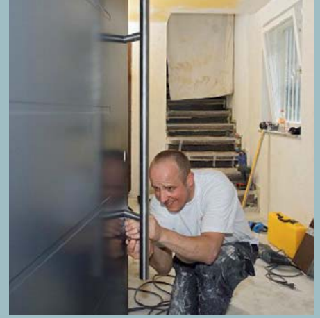
21. An der Tür kann jetzt auch schon der Stoßgriff angebracht werden. Hier Bauherrensache.
