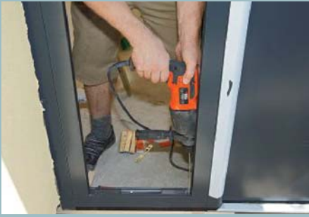
19. Zum endgültigen Fixieren des gesamten Türrahmens verschraubt man auch unten und oben.
