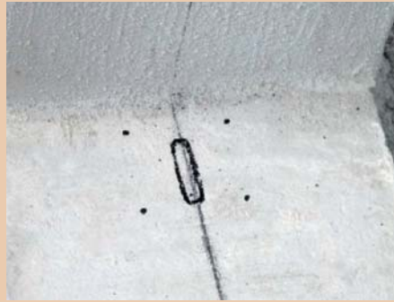
8. Nun zur anderen Seite. Auch hier die Bohrpunkte markieren. Die längliche Markierung ...
