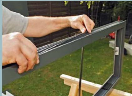
12. Die verbleibenden Rahmen erhalten Dichtprofile, damit später keine Fugen klaffen.
