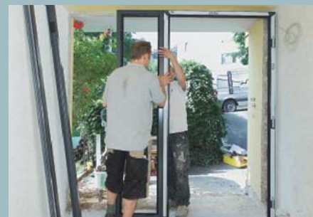
13. Das erste Seitenteil wird dann gleich an die Haustürzarge angeschlossen. Mit speziellen ...
