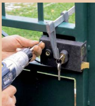
25. Nun folgen noch ergänzende Arbeiten wie das Anschrauben des Kastenschlosses oder das Bohren ...
