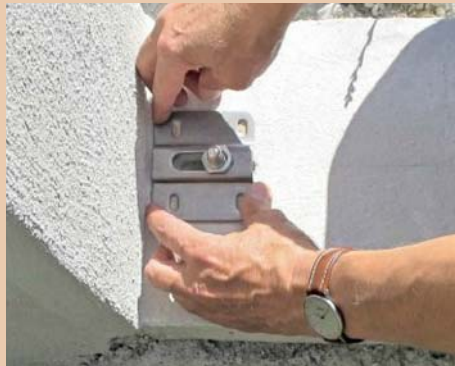
10. Probeplatzierung: Die Löcher über den Dübeln, der Aufnahmedorn im Langloch der Stahlplatte.
