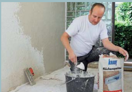
1. Zunächst wurde der grobe Wandputz mit einem Flächenspachtel überarbeitet. Dieser ...
