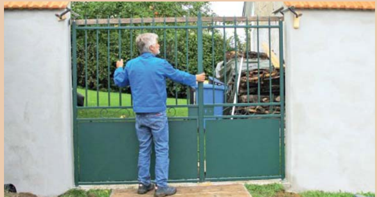
16. Mit dem zweiten Flügel verfährt man ebenso. Die Hilfsplatte tut nun ihre Dienste.
