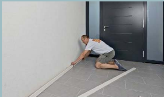
45. Den Bodenabschluss bilden weiß lackierte geradlinige Sockelprofile aus MDF, die mit Montagekleber fixiert werden.
