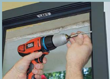
14. ... Schrauben werden so die Teile dicht zusammengezogen und zu einer stabilen Einheit.
