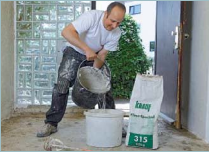
7. Solange die Wand trocknet, hat der Bauherr den abgemeißelten Boden gespachtelt. Die ...
