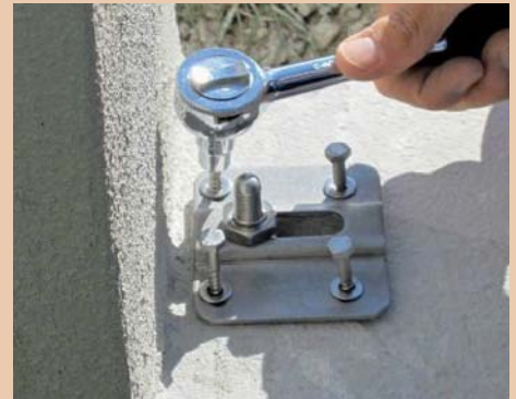
11. Mit vier Sechskantkopfschrauben und Unterlegscheiben wird die Dornplatte festgesetzt.
