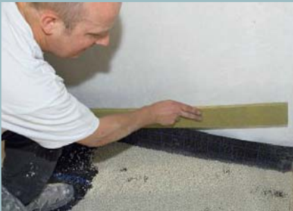
31. Außen herum verlegt man vor der Aufkantung noch einen Mineralwolle-Dämmstreifen.
