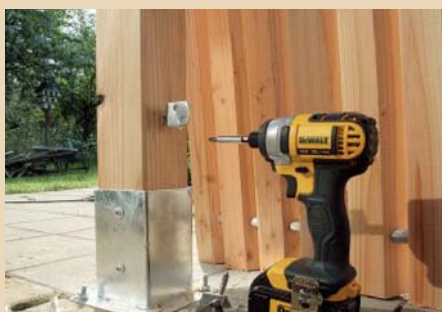
18. An die Pfosten des Sichtschutzes werden Halterungen aus Edelstahl angebracht.
