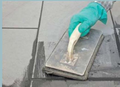
43. Überschüsse mit dem Schwammbrett ab- nehmen und die Fugen dabei leicht glätten.
