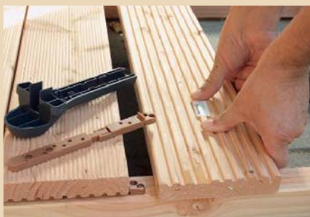
24. Die Bodendielen werden mit Hilfe eines Spezialsystems unsichtbar verschraubt:
