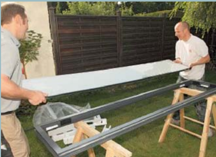
11. Draußen wurden die beiden Festelemente ausgeglast, damit beim Einbau nichts passiert.
