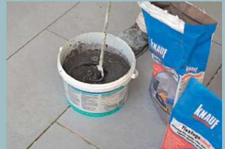
41. Nach empfohlener Trockenzeit des Klebers wird verfugt. Hier mit einem flexiblen Material.
