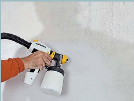
44. Letzter Arbeitsgang an der Wand: Der weiße Feinputz wird mit dem Sprühgerät aufgebracht.
