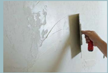
6. Er wird mit der Traufel dünn aufgezogen und unter leichtem Druck verteilt und einmassiert.
