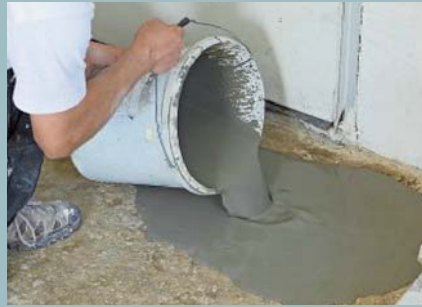
8. ... Fließspachtelmasse wird zähflüssig angemischt und eimerweise nass in nass verteilt.
