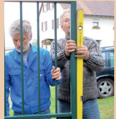
14. Jetzt geht es noch darum, den Flügel so in Position zu bringen, dass er senkrecht dasteht. Dazu ...
