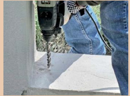
9. ... wird dann mit entsprechend großem Bohrer in voller Breite und Länge ausgehöhlt.
