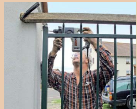
21. Wenn deren Bohrpunkte markiert worden sind, werden die Dübellöcher gebohrt.
