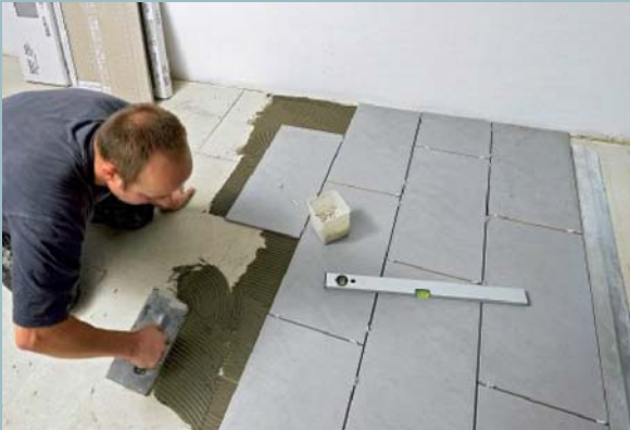
38. Der Verlegeverband ist hier mit hal- bem Fugenversatz gewählt. Die Fliesen- kreuze bestimmen die Fugenbreite.
