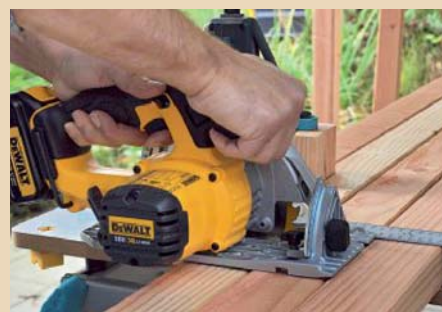
20. Zum Boden: Die Rahmenhölzer für die Unterkonstruktion des Holzdecks ...
