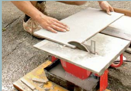
40. Geschnitten hat man die Fliesen hier mit einem Nassschneider mit Diamantscheibe.
