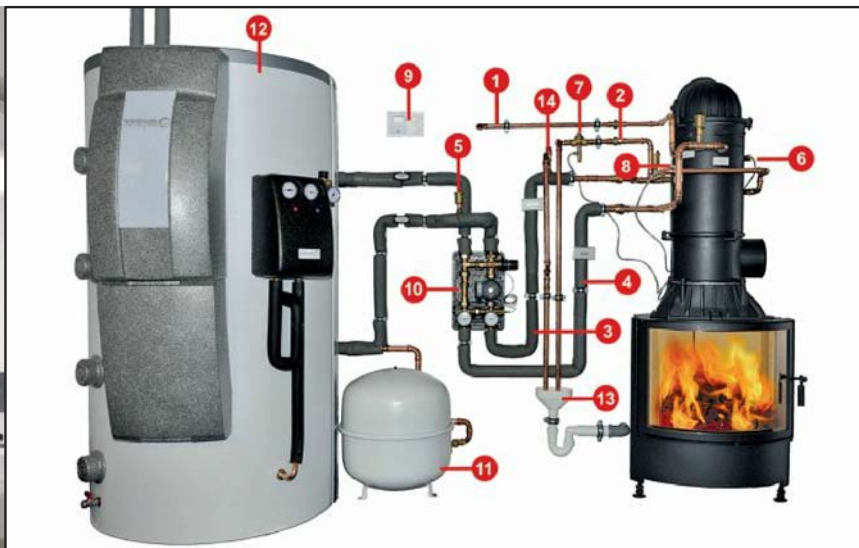
Funktionsweise eines Heizkamines mit Wasseraufsatzregister
