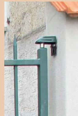
24. Später schützt eine Abdeckhaube den oberen Drehpunkt vor direktem Witterungseinfluss.
