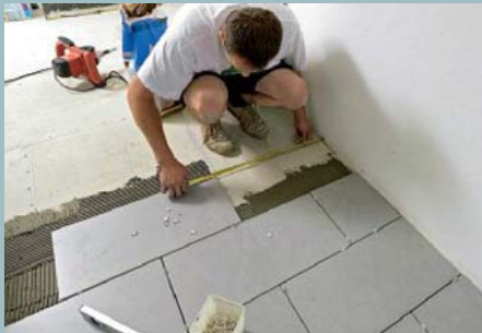
39. Die Endplatten müssen exakt ausgemessen werden und sollen nicht an der Wand anstoßen.
