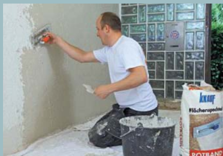
2. ... wird zu einer geschmeidigen Masse und lässt sich gut in die Vertiefungen einbringen.
