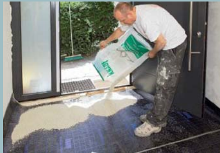
29. Mit hochgezogener Kante lässt sich dann auch gleich schon das Schüttgut aufbringen.
