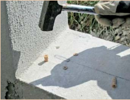
7. Die mitgelieferten Kragendübel dann bis zum Bund einschlagen. Vier Stück pro Aufnahme.
