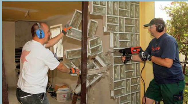
10. Dann war Abbruch angesagt. Ein bisschen laut, aber mit Hilfe eines Meißelvorsatzes am Bohrhammer ging das doch deutlich schneller als per Hand.
