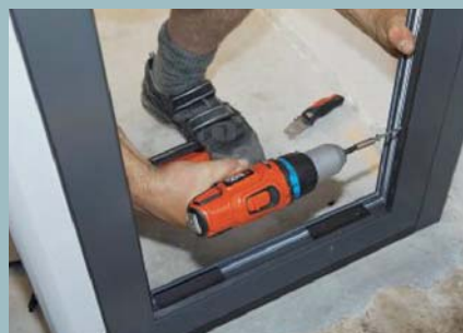
16. Diese werden von innen durch die Rahmen der Festelemente dicht angefügt verschraubt.
