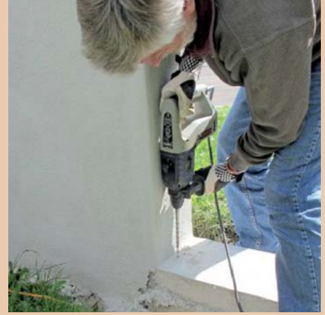
6. Mit einem Bohrhämmer kann man dann leicht die vier Montagelöcher senkrecht einbohren.
