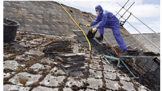
Die qualifizierten Fachhandwerker entfernen die Asbestplatten einzeln.
