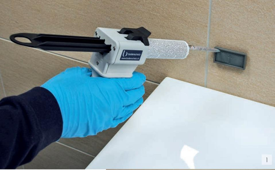
1 Statt Bohrmaschine: Der Zweikomponentenklebstoff von Sika wird mit einer Klebepistole in den Flansch gefüllt.
