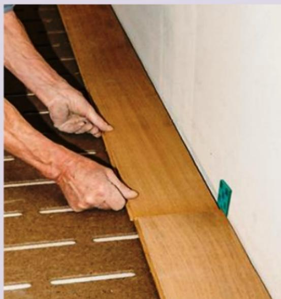
**13** Posez la première lame (rainure contre le mur) et insérez des cales d'épaisseur le long du mur et aux extrémités de chaque rangée (joint de dilatation).
