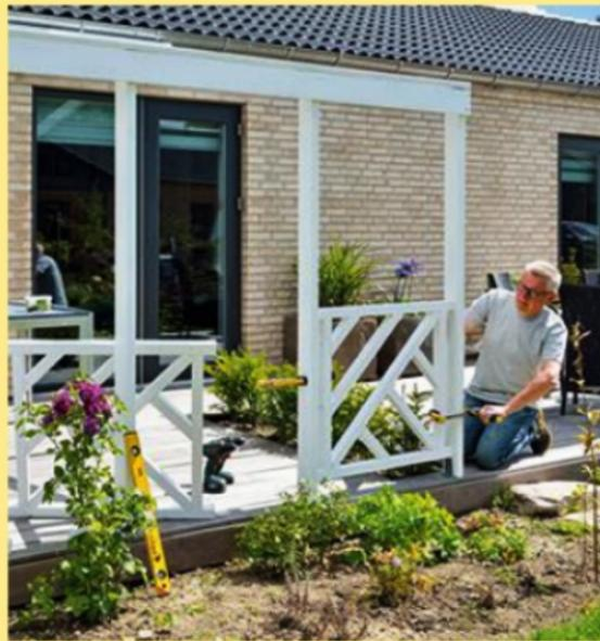
**18** Les garde-corps sont peints avant d'être insérés entre les poteaux. Posez-les de niveau et à bonne hauteur, en laissant un espace de 10 cm environ entre le sol et la traverse basse.
