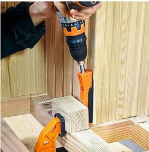
**7/** La présence de contremarches assez larges assure la stabilité et la solidité de l'ensemble. Assemblez les lames de terrasse à l'aide du gabarit de perçage oblique.
