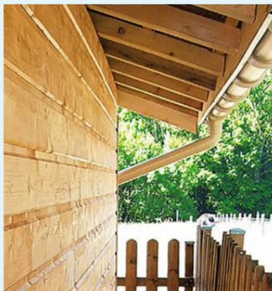
**21** Une gouttière est posée en bas du pan de toit tourné vers le terrain voisin. Les eaux s'écoulent pour l'instant librement sur le versant opposé, interne à la propriété.
