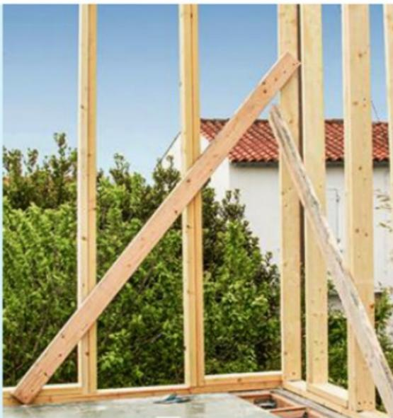
**18** Commencez les autres côtés de l'ossature par les montants d'angle. Posez deux montants supplémentaires et solidarisez provisoirement l'ensemble avec des écharpes.
