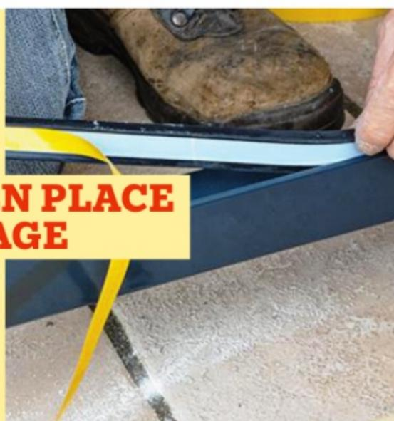
**9** À l'intérieur du cadre et des montants (cornières), appliquez un joint en caoutchouc autocollant coupé à 45° aux angles. Faites pression pour qu'il adhère bien au métal.
