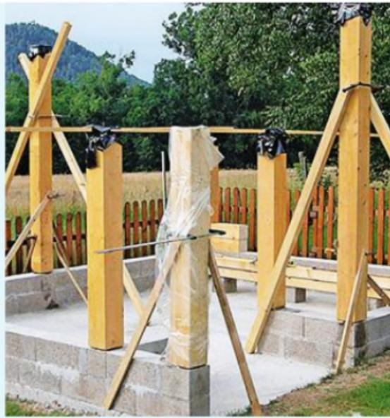
**8** Les parpaings d'angle sont remplis de mortier frais, les poteaux sont hissés un à un. Le temps de la prise, ils sont maintenus avec des étais bridés par des serre-joints.
