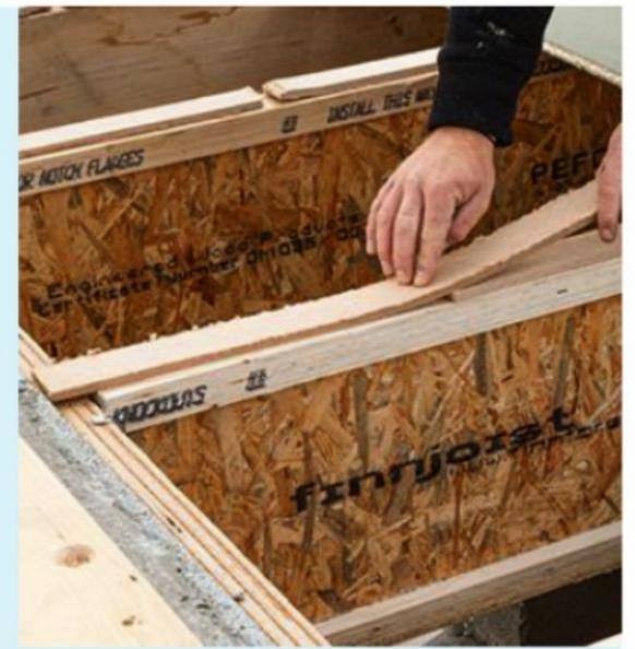
**11** Collez des bandes résilientes sur le chant supérieur des solives. Leur rôle est de désolidariser la structure du plancher et d'atténuer ainsi les bruits de choc.
