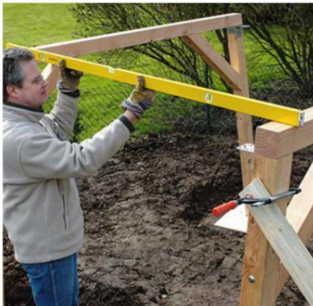
**4** L'horizontalité des traverses des fermes, leur calage à niveau et le juste espacement des deux assemblages sont contrôlés. Les traverses latérales sont vissées aux équerres.
