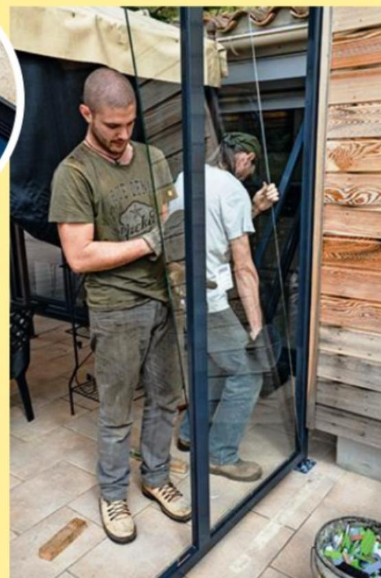
**12** À l'aide de ventouses, positionnez un à un les trois vitrages en commençant par le bas. Placez-les entre la cornière et les tétons de fixation des pare-closes.
