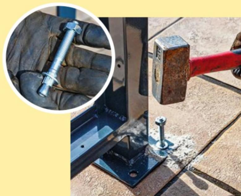
**3** Dépoussiérez les trous à l'aspirateur, puis insérez à la massette des goujons d'ancrage à expansion. Vissez fermement jusqu'à la rondelle.
