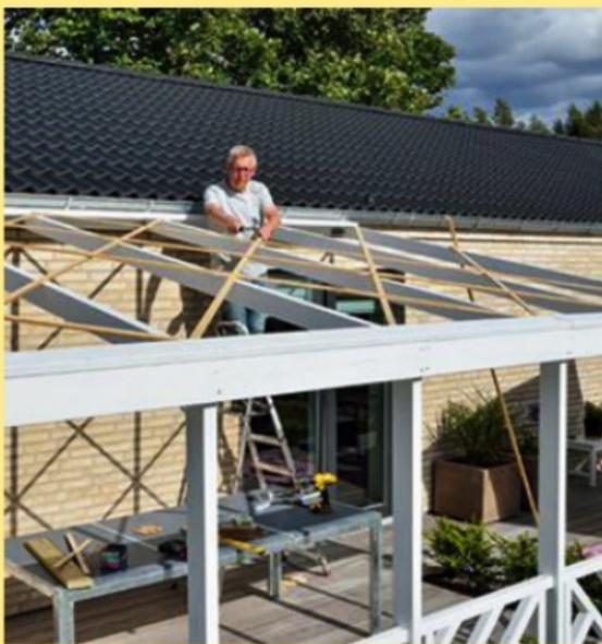
**20** Fixez des liteaux sur les chevrons à l'aide de clous galvanisés. La section et l'écart entre liteaux doivent être adaptés à la nature de la couverture.
