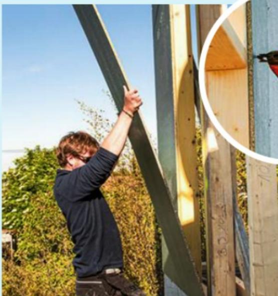
**24** Du côté extérieur, recouvrez l'ossature avec les panneaux de contreventement. L'emploi d'un cloueur, muni de pointes de Ø 2,5 x 60 mm, facilite la fixation.
