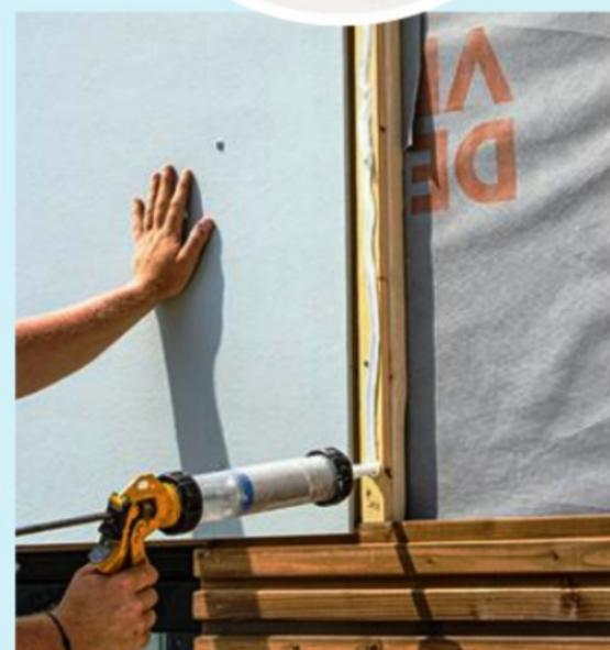
**39** Il est important aussi d'extruder un cordon de mastic sur les tasseaux d'appui, afin d'empêcher les éventuelles infiltrations d'eau pluviale.
