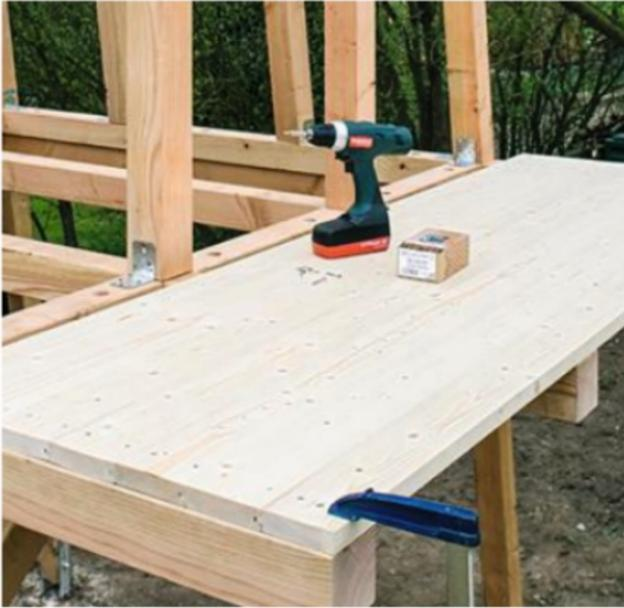
**10** L'installation du plancher commence par le balcon, plus simple à poser. Les lames bouvetées sont fixées sans avant-trou dans les solives avec deux vis (auto-foreuses) par liaison.
