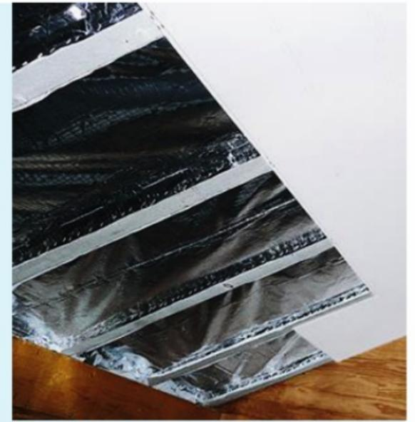
**25** Sous la toiture, notre lecteur a préféré opter pour un isolant mince. Ici, l'habillage est en lambris PVC blanc. Autre option : la pose de plaques sur ossature métallique.
