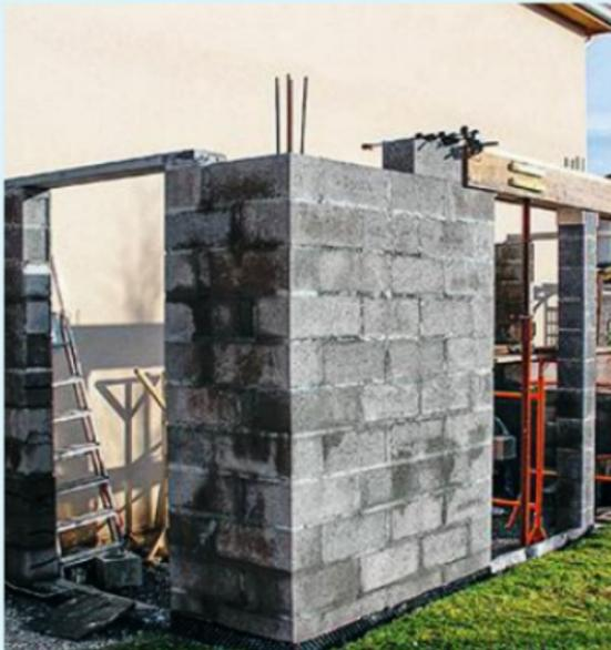
**7** De chaque côté du bâti, des linteaux préfabriqués en béton sont scellés pour fermer les ouvertures. Côté pignon, un coffrage est créé pour fabriquer un linteau sur mesure en béton.
