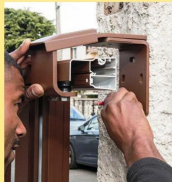
**12** Présentez l'étrier de guidage à l'extrémité du cache en insérant ses galets «olives» dans la glissière. Après réglage de l'aplomb, repérez les points de fixation sur le pilier.
