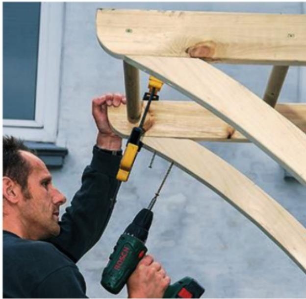
**10** Les jambes de force sont ajoutées. D'abord immobilisées avec des serre-joints, elles sont vissées à chaque extrémité avec une vis très longue de 5 x 120 et une autre plus courte de 5 x 90.
