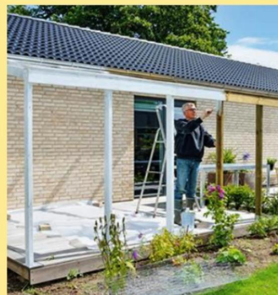
**14** Passez une première couche de peinture microporeuse avant la pose des garde-corps et des liteaux. En principe, cette opération s'effectue sur des surfaces déjà finies.
