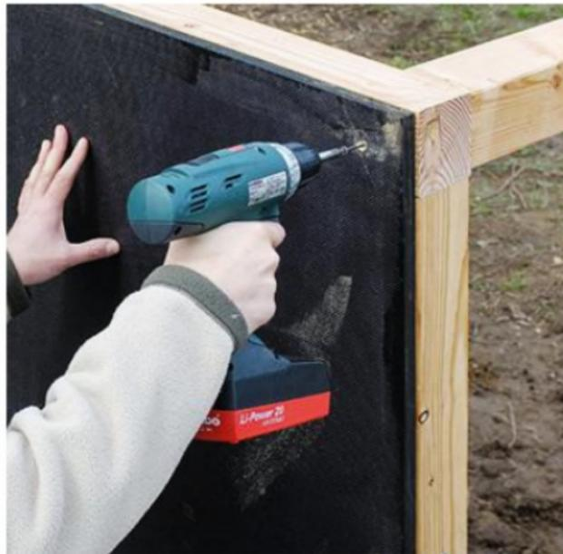
**5** Coupé aux cotes et selon les angles requis, le panneau arrière est bridé 30 cm au-dessus du sol et vissé. Le chambrage des têtes de vis est fraisé lors du perçage des avant-trous.
