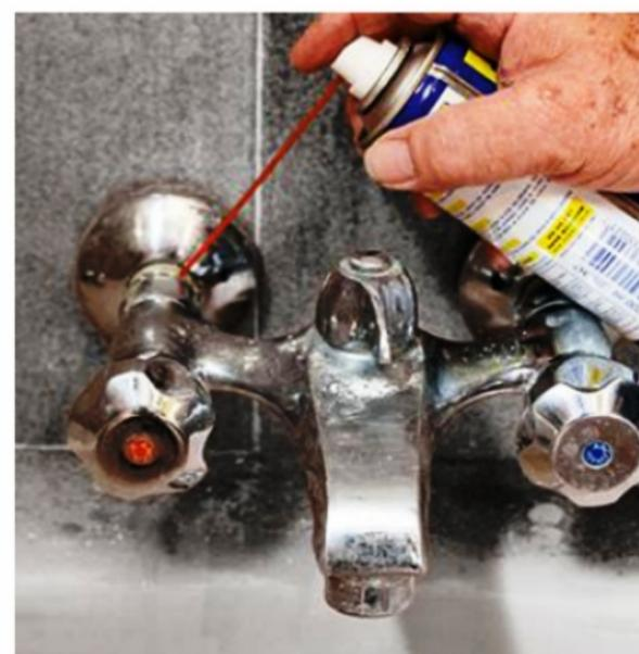
**2/** Avec un mélangeur ancien et une eau calcaire, les écrous peuvent être coincés. Appliquez du vinaigre blanc ou un dégrissant (Loctite, Transyl, WD40...). Laissez agir avant de dévisser.
