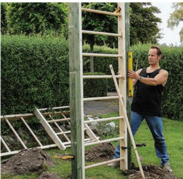
**7** Les poteaux (bois traité pour un usage extérieur) sont engagés dans les trous, puis les espaliers sont solidarisés avec des serre-joints. L'aplomb et l'horizontalité sont contrôlés au niveau, les poteaux sont calés par des pierres.
