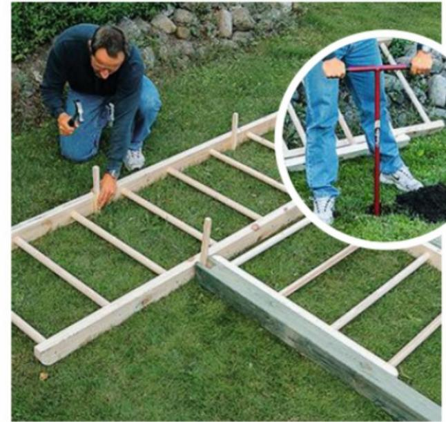
**6** L'emplacement des trous d'ancrage dans le sol est repéré en posant directement poteaux et espaliers à terre, puis matérialisé par quatre piquets. Le creusage est ensuite effectué à la tarière manuelle (un sol dur nécessiterait un modèle électrique).
