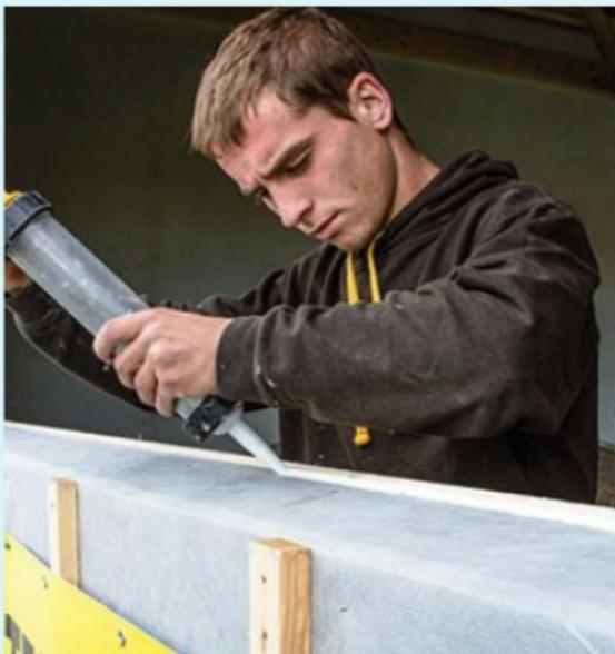
**32** La mise en place des fenêtres est simple. Elles se posent en applique et se vissent directement sur l'ossature. N'oubliez pas le joint d'étanchéité entre la menuiserie et le bois !
