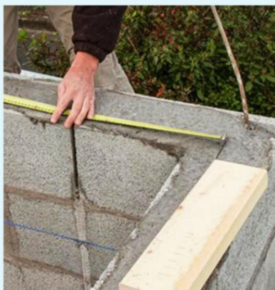
**4** Tracez la ligne de pose des lisses sur l'arase maçonnée (retrait de 12 mm de l'extérieur des murs). L'écart correspond à l'épaisseur des panneaux de contreventement.
