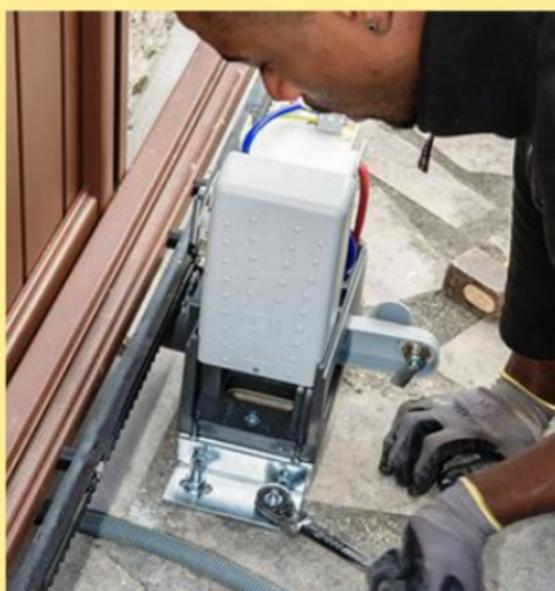
**17** Une fois l'emplacement nettoyé, procédez à la fixation du bloc-moteur. Serrez à fond les écrous des goujons en n'oubliant pas d'intercaler les rondelles plates fournies. Testez le coulissement à la main et mettez en place le cache-crémaillère.
