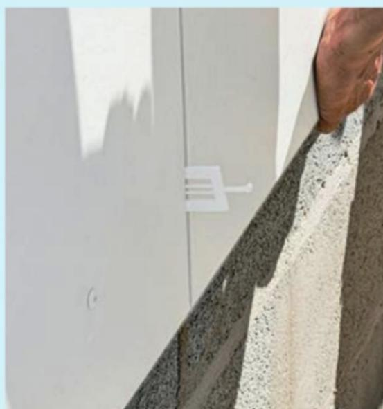
**38** Un espace de dilatation, ici 2 mm, est nécessaire entre les panneaux. Des cales (appelées « fourchettes ») permettent de régler leur épaisseur au plus juste.
