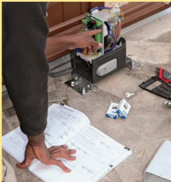
**27** Remettez le courant et, patiemment, encodez l'installation comme indiqué dans la notice. Il est important, après avoir reposé le capot, de vérifier que tous les réglages ont été exécutés correctement, que les fins de course, les dispositifs de sécurité et de déverrouillage fonctionnent bien.
