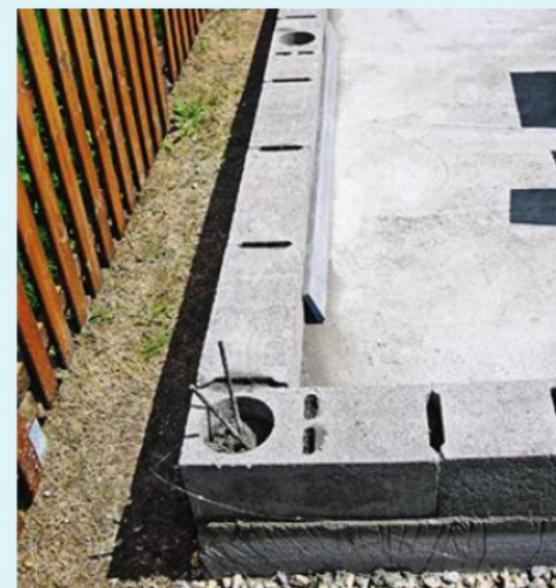
**6** Lors de la pose des parpaings, les éléments d'angle et ceux implantés au droit des poteaux à venir restent vides. Ils seront ensuite remplis de mortier pour sceller les poteaux.
