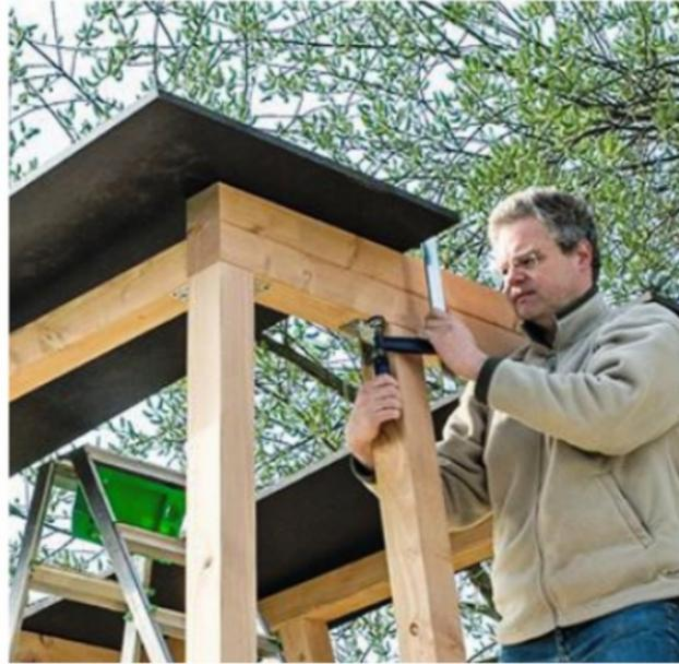
**11** La couverture est hissée sur l'ossature après tirefonnage de la traverse de rehausse. Les deux panneaux latéraux sont vissés sur les traverses avec des vis munies de rondelles d'étanchéité.
