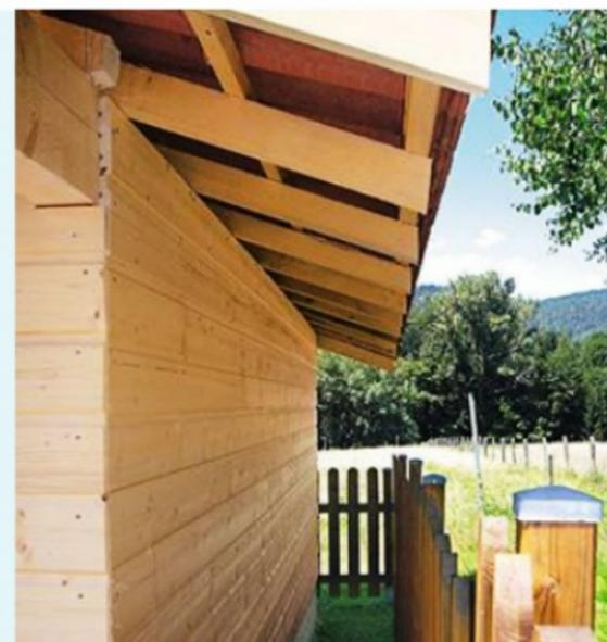
**17** La première paroi vient à fleur de la face du poteau, la seconde couvre l'extrémité des lames de la première. Un couvre-joint (baguettes d'angle) masque le raccord.
