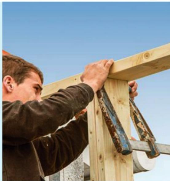
**19** Placez les longueurs de lisse haute sur les montants. Ajustez leur position et bridez-les avec des serre-joints, avant de les visser à chacun des montants.
