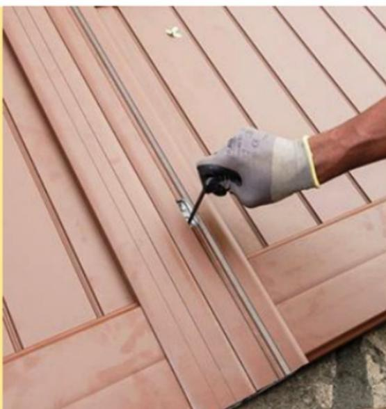
**7** Verrouillez l'assemblage à l'aide des vis à empreinte hexagonale prévues à cet effet. Serrez-les à fond avec une clé Allen, puis posez le profilé de masquage (tapée).
