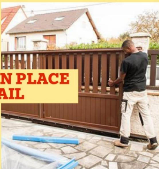
**10** À deux personnes, redressez le portail et avec précaution, mettez-le en place en faisant reposer les roulettes sur le rail de sol. Vérifiez qu'elles s'alignent bien.
