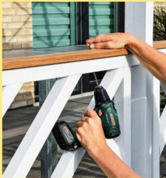
**21** Vissez les mains courantes en bois exotique sur les traverses hautes des garde-corps. La fixation s'effectue par en dessous afin de rendre l'assemblage invisible.
