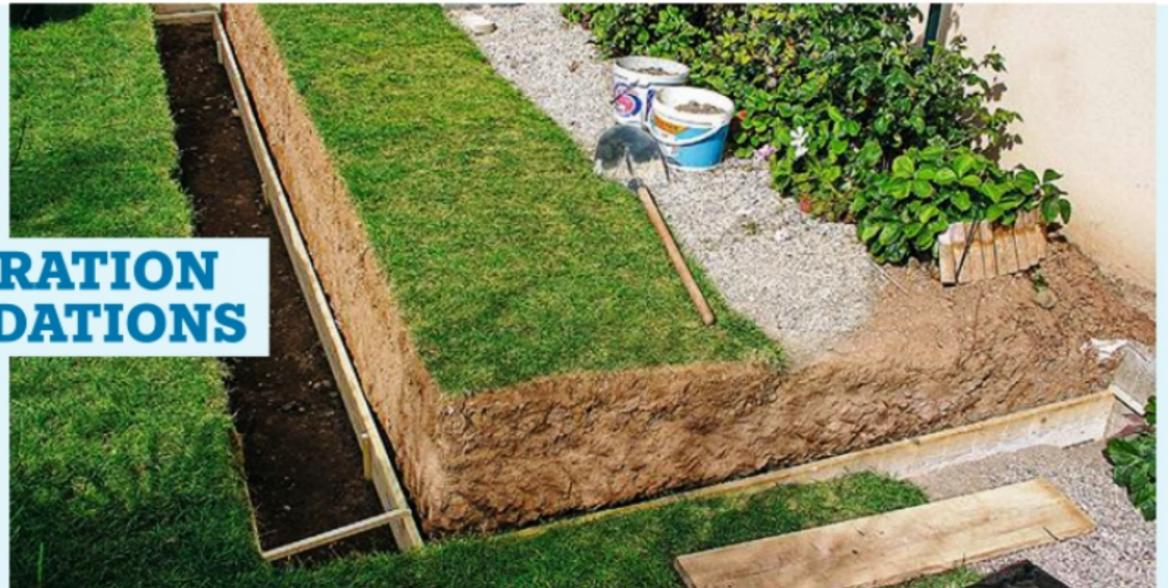
**1** Une fois le terrassement du sol effectué à la pelle et la pioche, un coffrage perdu en bois est mis en place sur le pourtour de l'excavation. Il permet de créer une semelle périphérique en béton armé pour asseoir la future maçonnerie.
