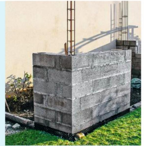
**6** Après avoir prolongé le ferrailage vertical, le montage des parpaings se poursuit jusqu'au linteau des futures menuiseries.
