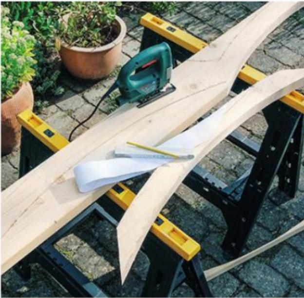
**4** La forme des jambes de force est tracée avec un gabarit (le modèle est joint dans le plan téléchargeable), utilisez une planche de section 45 x 195 mm. La découpe peut être effectuée à la scie sauteuse.
