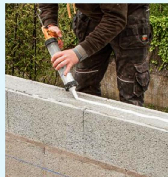
**6** Déposez un cordon de mastic-colle sur l'arase. Prépercez les lisses tous les mètres et placez-les. Forez l'arase au travers des bois et fixez-les (goujons de Ø 12 x 140 mm).
