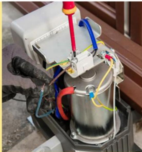
**23** Connectez le fil de phase (marron ou autre couleur conventionnelle) dans la borne L du transformateur et le neutre (bleu) dans la borne N.
