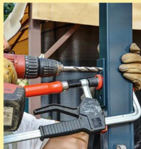
**5** Dans le montant, percez au foret métal les trous de fixation de la jambe ( $\varnothing$  10 mm). Puis retirez-la pour chanfreiner les perforations avec une fraise pour métal.
