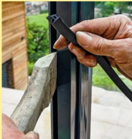
**14** À l'aide d'un écarteur en bois de fenêtrier, faites levier entre le verre et chaque pare-close, puis insérez le joint caoutchouc complémentaire de maintien et d'étanchéité.
