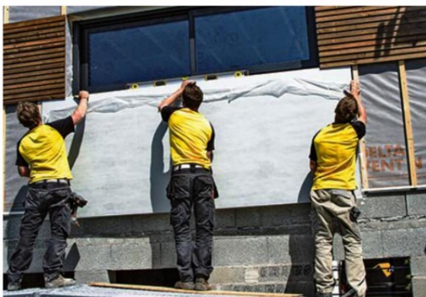
**35** Le bardage en fibres-ciment vient se glisser sous les panneaux de lattage décoratif, pour favoriser l'écoulement des eaux de pluie. L'opération requiert trois ou quatre personnes, en raison du poids et des dimensions des panneaux.
