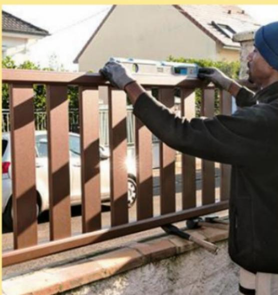
**32** Fabriquées sur mesure, les travées en aluminium s'emboîtent à chaque bout dans leurs supports. Il y en a deux identiques, de 190 cm de longueur, d'un côté du passage.
