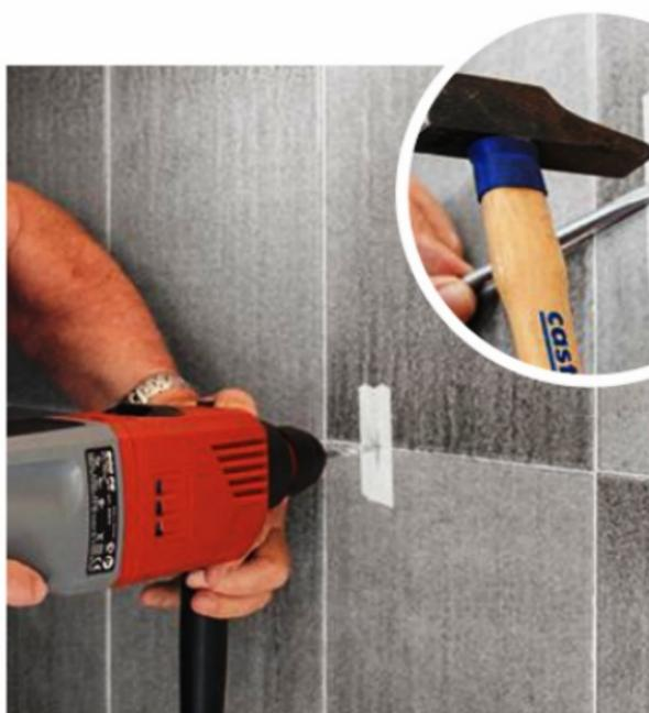
**7/** Mesurez l'axe central du mitigeur. Collez un morceau d'adhésif, puis percez à vitesse lente et sans percussion avec une mèche à béton. Insérez la cheville au ras du carrelage.
