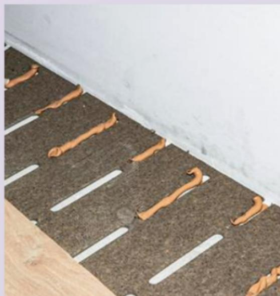
**12** Comblez les alvéoles de la sous-couche correspondant à la première rangée de lame. La colle sèche lentement, ce qui permet de corriger les erreurs de positionnement.
