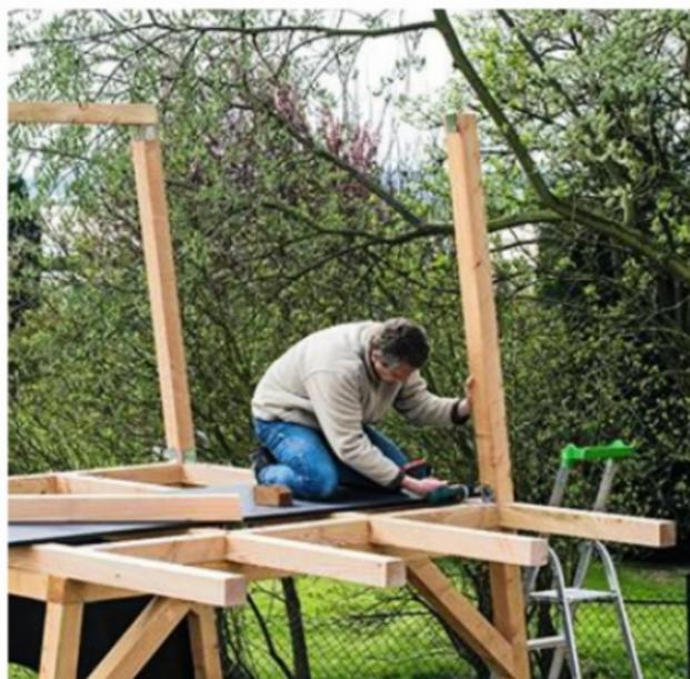
**8** Les montants de la cabane sont vissés dans les angles de la plate-forme à l'aide d'équerres. Les traverses arrière et avant sont aussitôt installées. Un panneau sert de plancher provisoire.
