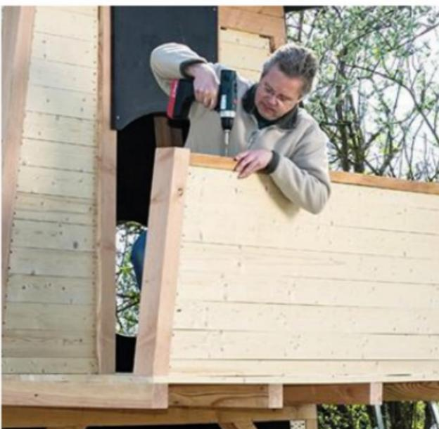
**14** Les montants du garde-corps sont boulonnés aux solives à travers le plancher. L'habillage (lames de plancher) sera surmonté d'une main courante qui se prolonge sur les côtés.
