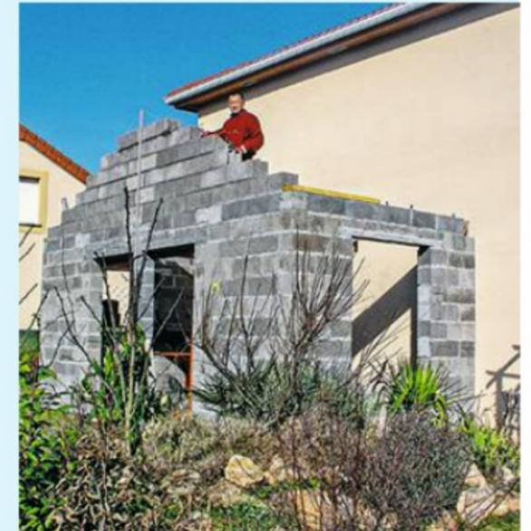
**9** Après séchage du linteau, le montage des murs se poursuit. Là encore, un mat et deux cordeaux servent à contrôler l'aplomb en cours de montage.
