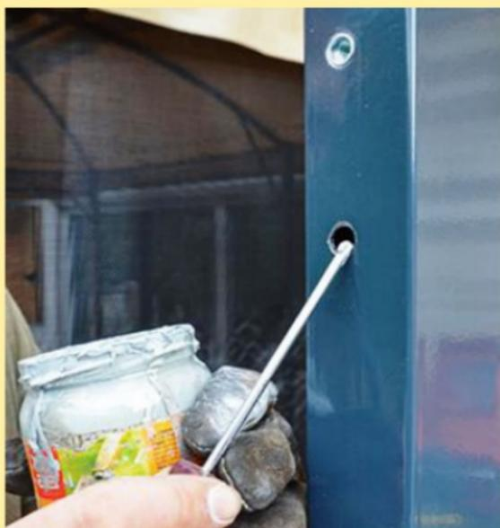
**6** Avec la pointe d'un tournevis plat, déposez de la pâte d'étanchéité en périphérie de chaque trou, puis glissez-y un écrou à sertir. Sertissez-les à la pince à main.
