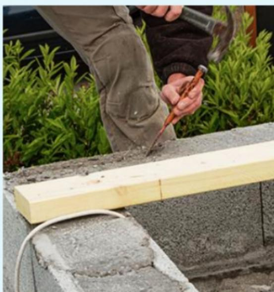
**5** Vérifiez la planéité de l'arase. Si besoin, corrigez les imperfections au burin ou à la meuleuse munie du disque diamanté. Sciez les lisses pour les mettre à longueur.
