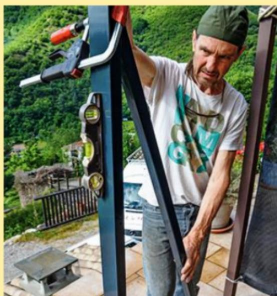
**4** Une fois les pieds fixés, positionnez les jambes de force contre les montants. Maintenez-les par des serre-joints tout en contrôlant l'aplomb au niveau à bulles.
