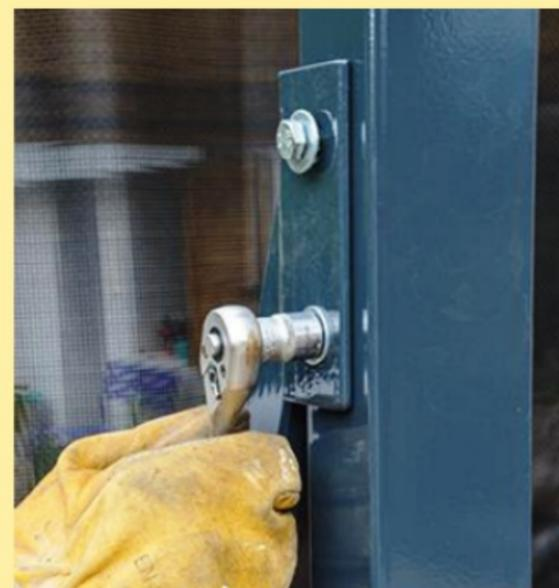
**7** Vissez dans chaque écrou, un boulon équipé d'une rondelle métallique à l'aide d'une clé à douille pour fixer la jambe de force au montant.
