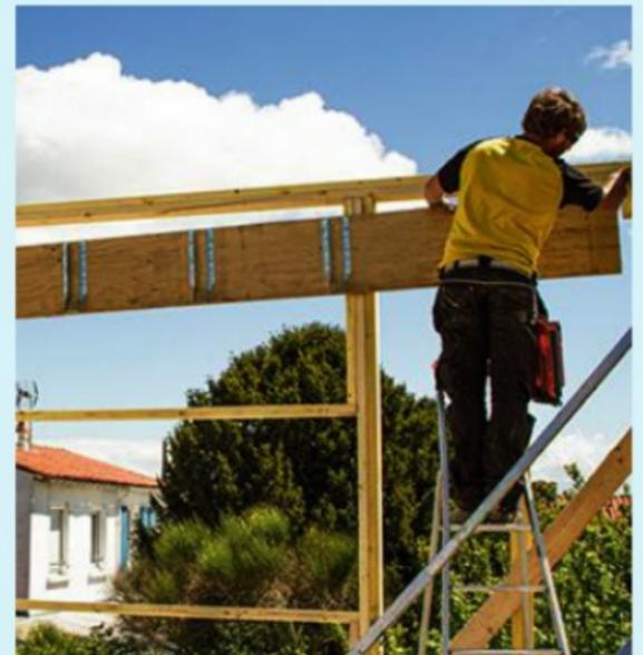
**23** La toiture doit décrire une légère pente d'écoulement, entre 2 et 5 %. Déterminez le sens de l'inclinaison et fixez la muralière sur l'ossature à l'endroit convenu.
