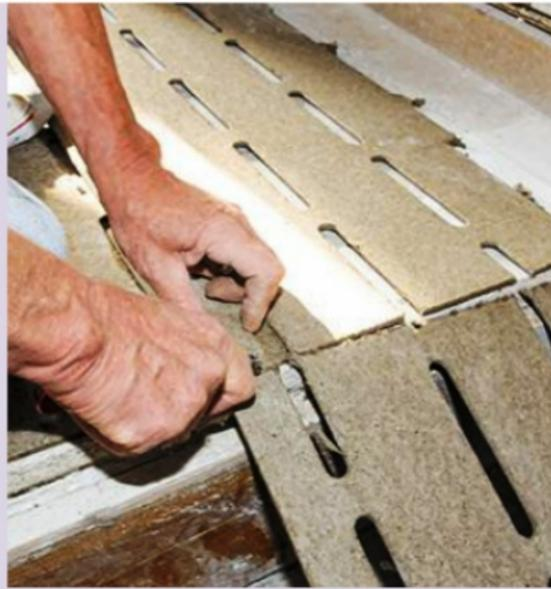
**2** Découpez la sous-couche aux dimensions souhaitées à l'aide d'un cutter à forte lame (non flexible). Prévoyez des lames de rechange car cette sous-couche est très abrasive.
