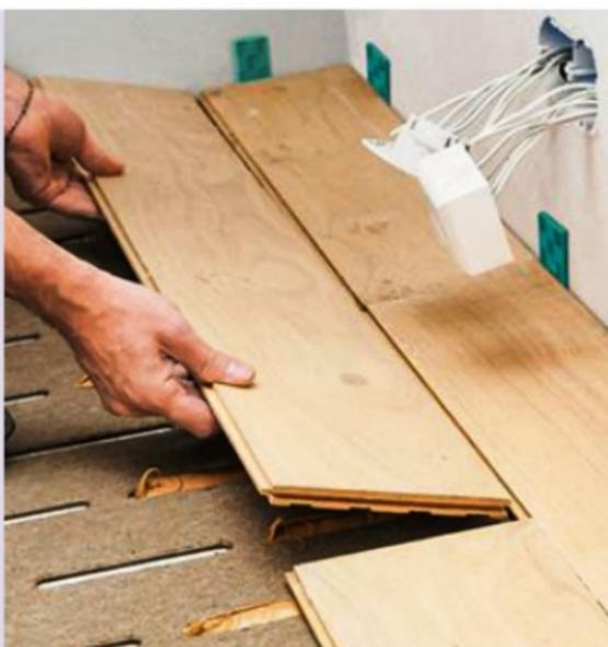
**15** Emboîtez délicatement la rainure de la lame dans la languette de celle déjà collée. Inclinez la lame pour un parfait emboîtement.
