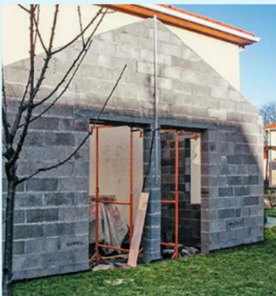
**10** Après avoir écrêté les parpaings à la meuleuse, des coffrages sont posés le long des rives du mur pignon. Du béton est ensuite coulé dans le coffrage.
