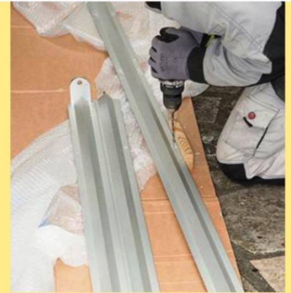
**3** Repérez les points de fixation du rail de sol, sur chaque aile, tous les 50 cm environ. Marquez-les au pointeau avant de prépercer au diamètre des chevilles à frapper.
