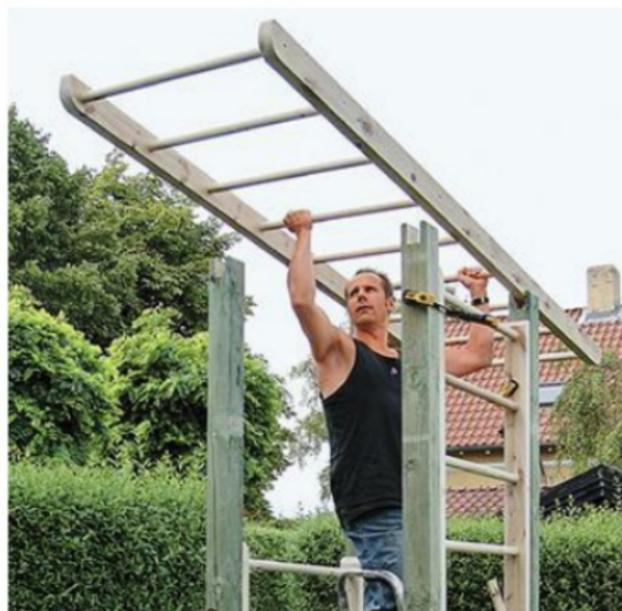
**8** Lorsque les quatre poteaux et les deux espaliers verticaux sont mis en place, l'échelle horizontale est emboîtée dans ses encoches. Elle débordé de façon équilibrée de part et d'autre du portique.
