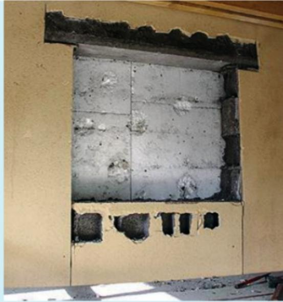
**14** Une saignée est percée en haut du mur pour sceller un linteau préfabriqué en béton (20 cm de section). Après séchage du mortier de scellement, le mur est démoli au burineur.
