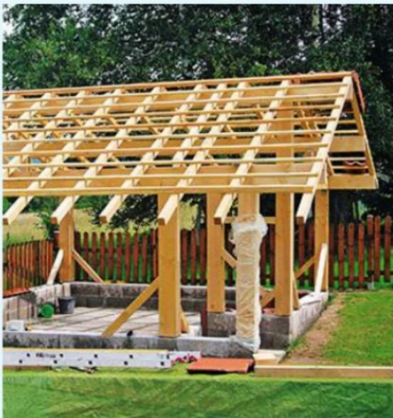
**12** Les liteaux (section 27 x 40 mm) sont à leur tour cloués perpendiculairement aux chevrons. Leur espacement dépend du pureau des tuiles utilisées.
