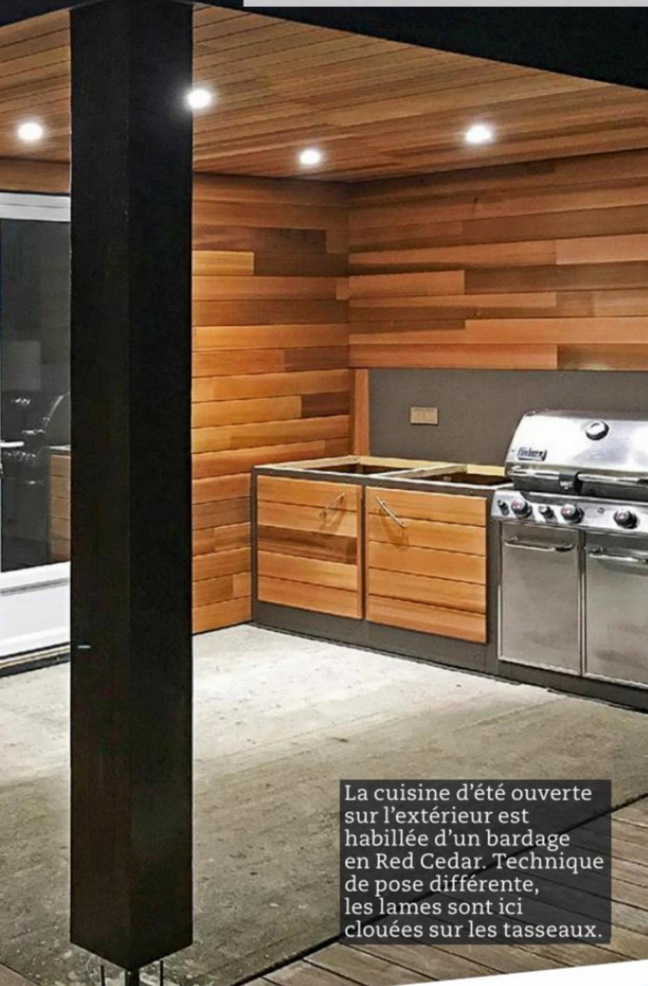
La cuisine d'été ouverte sur l'extérieur est habillée d'un bardage en Red Cedar. Technique de pose différente, les lames sont ici clouées sur les tasseaux.
