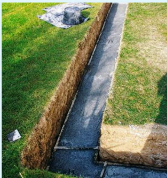
**2** Après le coulage du béton de propreté en fond de fouille, un treillis est posé pour assurer une assise solide des fondations. Du béton est ensuite ajouté.
