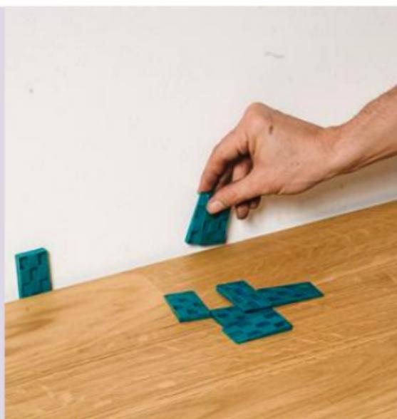
**7** Le bois étant susceptible de se dilater sous l'effet des variations de température et d'hygrométrie, des cales de 6 à 8 mm d'épaisseur sont placées entre les lames et le mur.
