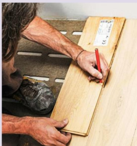
**18** En bout de rangée, procédez à un repérage par superposition des lames pour tracer la découpe et débiter le bout de lame manquant à la scie circulaire ou sauteuse.
