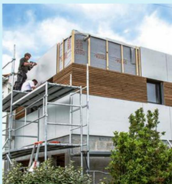
**41** Finalisez la pose du bardage comme précédemment. Pour votre sécurité, utilisez un échafaudage qui restera en place jusqu'à la mise en œuvre des couvertines.
