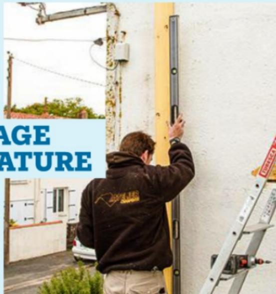
**13** Posez un premier montant d'aplomb contre la façade et tracez son emplacement. Après perçage, déposez un cordon de mastic sur le mur et fixez le montant avec des goujons.
