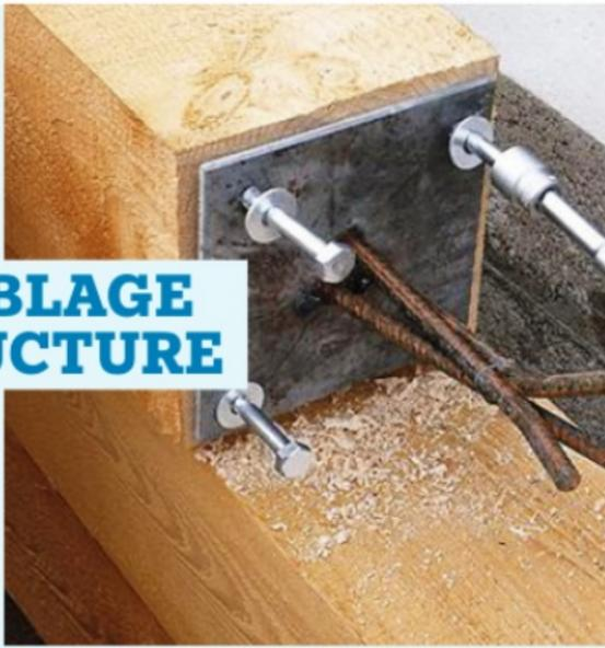
**7** Les platines supports des poteaux sont de fabrication maison : une plaque de tôle sur laquelle sont soudés trois fers à béton. Elles sont tirefonnées au pied des huit poteaux.
