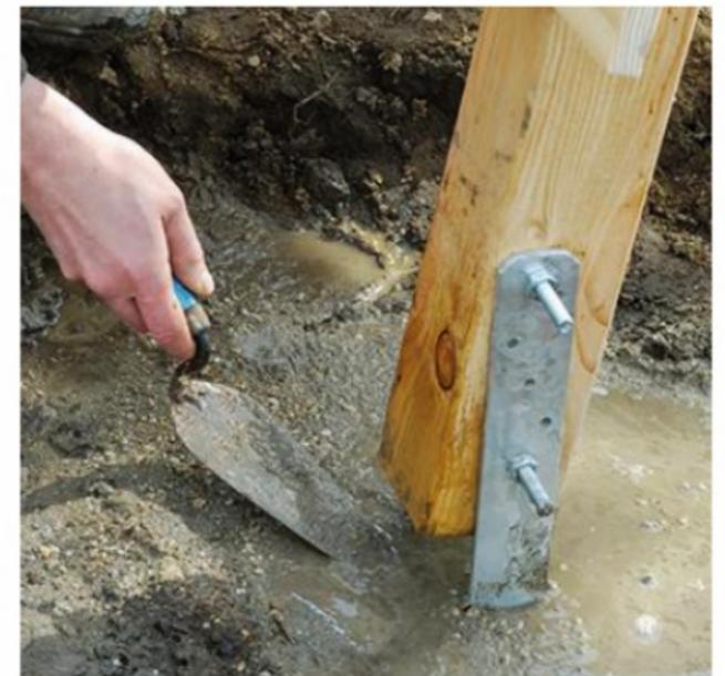
**6** Boulonnées au pied des poteaux, les pattes de scellement sont noyées dans le béton qui laisse libre l'extrémité du bois. Les surlongueurs des boulons sont recoupées à ras.
