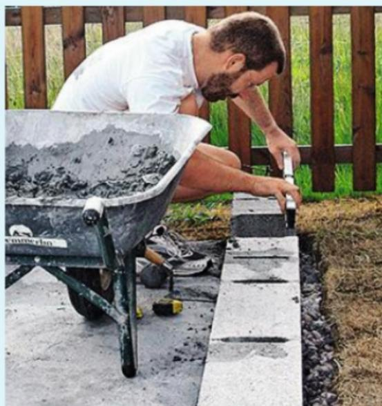
**5** Après une semaine de séchage, le muret de soubassement est établi (deux rangs de parpaings). Pour mieux le lier à la dalle, des fers à béton ont été noyés dans ses angles.
