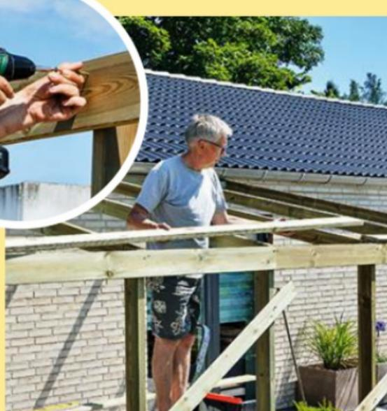
**11** Vissez une lisse contre l'extrémité haute des poteaux, puis complétez-la par une seconde vissée au-dessus des chevrons.
