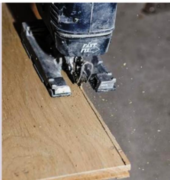
**6** À l'aide d'une scie sauteuse, coupez le chant de la première lame pour l'ajuster au mur. Travaillez avec précision, avec une lame pour le bois, de préférence à petite denture.
