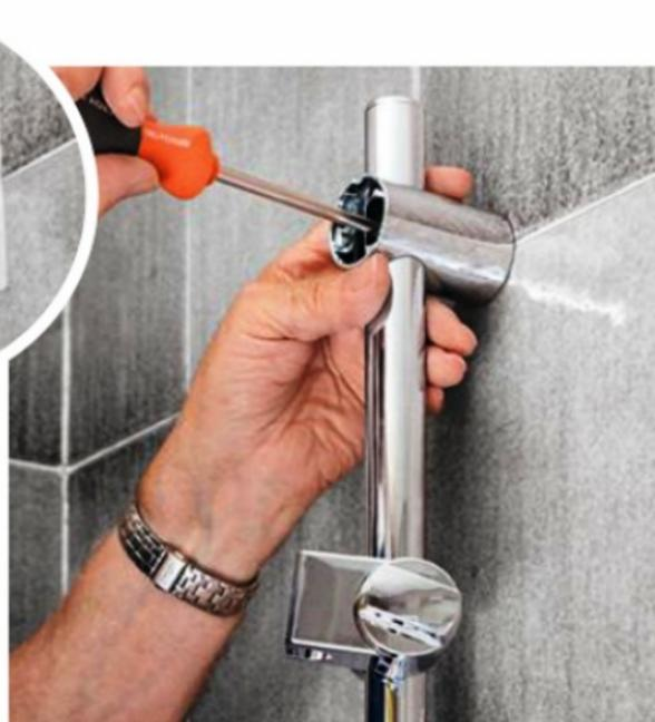
**8/** Posez la barre support de la douche contre la faïence. Vissez-la en plaçant les vis à l'intérieur des supports muraux puis clipsez les caches de finition sur les supports.
