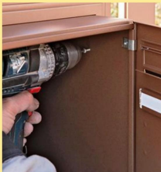
**34** La boîte aux lettres s'encastre au millimètre dans sa réservation. Elle se fixe au cadre de l'intérieur, avec des vis à métaux, dans des perçages réalisés en usine.
