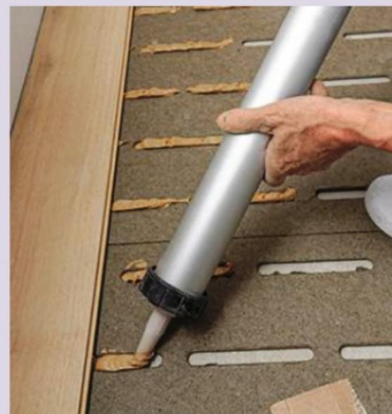
**14** La première rangée collée, poursuivez la pose sur le même principe. Débutez le deuxième rang avec une demi-lame pour une pose à joints perdus comme ici.
