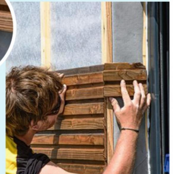
**34** Dans les angles, ces panneaux fabriqués s'assemblent d'onglet. Utilisez une scie adaptée. La coupe doit être parfaite pour éviter la pose de cornières de finition.
