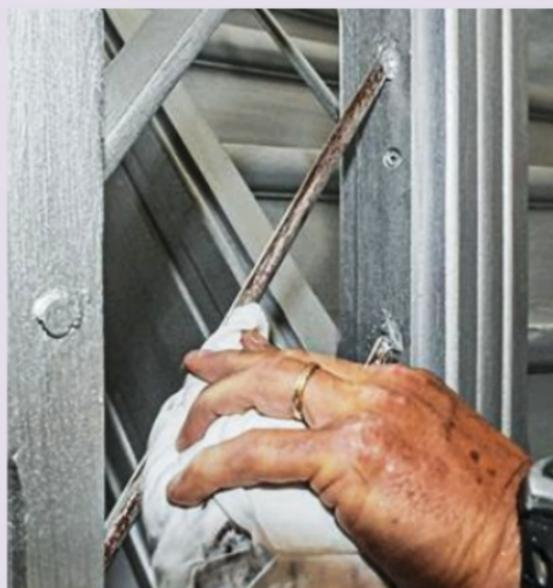
**6** Avant séchage du mélange, frottez les surfaces avec un chiffon non pelucheux jusqu'à obtenir l'effet souhaité. Répétez l'opération sur toutes les surfaces de l'escalier.
