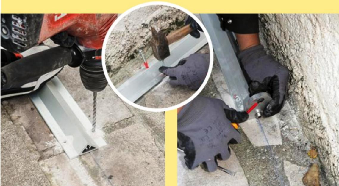
**4** Centrez le rail sur le tracé. Percez le sol au travers des trous de fixation. Dépoussiérez puis enfoncez directement au marteau les chevilles à frapper pour fixer le rail.
