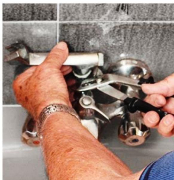
**1/** Coupez l'eau, puis ouvrez les robinets du mélangeur pour purger les alimentations. Avec une clé à molette ou une pince multiprise, démontez l'ancienne installation.
