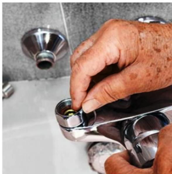
**4/** Sur les sorties murales d'alimentation, nettoyez les raccords puis vissez les nouvelles rosaces de finition. Installez les deux joints d'étanchéité à l'arrière des connexions du mitigeur.
