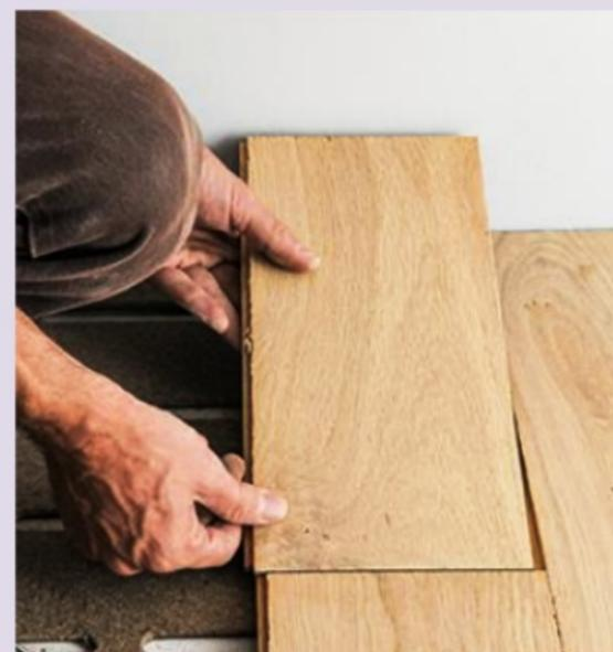
**19** Si le traçage a été précis, le bout de lame doit venir s'insérer parfaitement entre l'extrémité de la lame posée et le mur (en respectant l'espace de dilatation).
