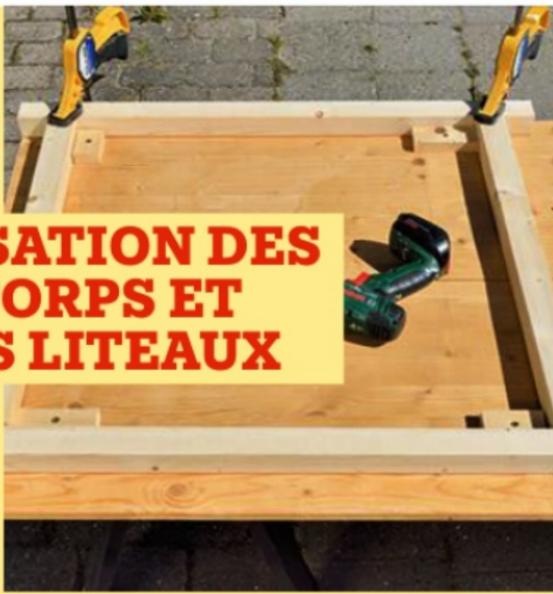
**15** Le garde-corps se compose de plusieurs cadres, fabriqués à l'aide de tasseaux. Assemblez ces derniers (montants et traverses) face contre chant (voir Info+ ci-dessous).
