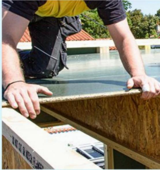
**27** Poursuivez par l'installation des panneaux de toiture (ép. 18 mm). Utilisez ces derniers pour les acrotères. Recouvrez-le tout d'une membrane d'étanchéité.
