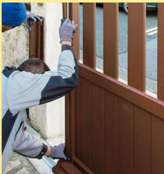
**19** Conjointement, posez la tringlerie sur le montant d'extrémité du vantail. Réglez sa verticalité au niveau à bulle.
