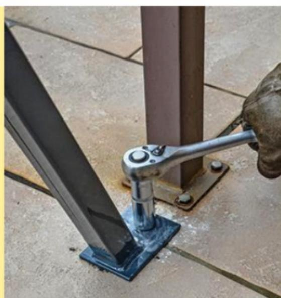
**8** Effectuez les trous au perforateur, aspirez, puis insérez des goujons d'ancrage pour fixer au sol chacune des jambes de force (ici à proximité du pied d'une pergola).
