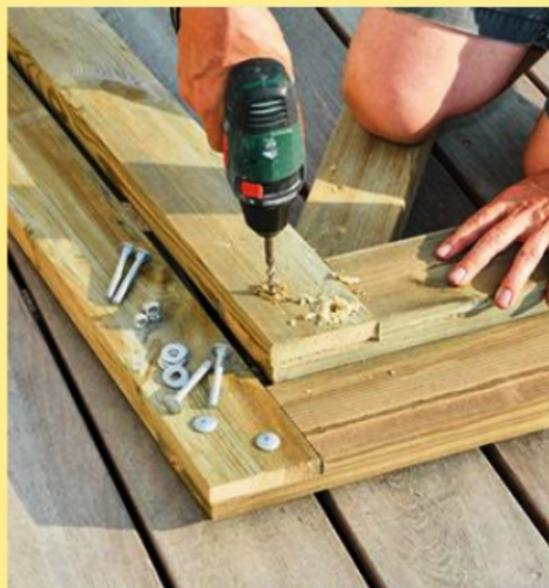
**5** Répétez l'opération pour l'ensemble des poteaux et des chevrons. Puis percez (Ø 10 mm) afin de placer des boulons assurant le maintien des assemblages à mi-bois.
