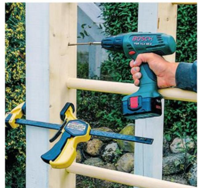
**9** Une fois les équerrages et les positionnements contrôlés, l'ensemble est définitivement vissé. Des vis inoxydables de 5 x 60 mm sont utilisées pour les espaliers verticaux (5 x 80 mm pour l'échelle horizontale).
