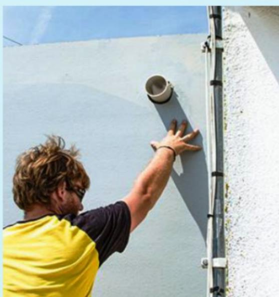
**40** À l'endroit de la boîte à eau, repérez et percez au diamètre le passage du tube d'évacuation dans le bardage. Le tube doit suffisamment dépasser du parement.
