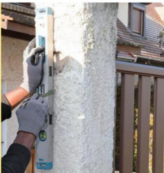
**29** Nettoyez les surfaces d'appui et effectuez les rebouchages qui s'imposent. Après séchage, tracez les nouveaux axes de pose en vis-à-vis sur les piliers.
