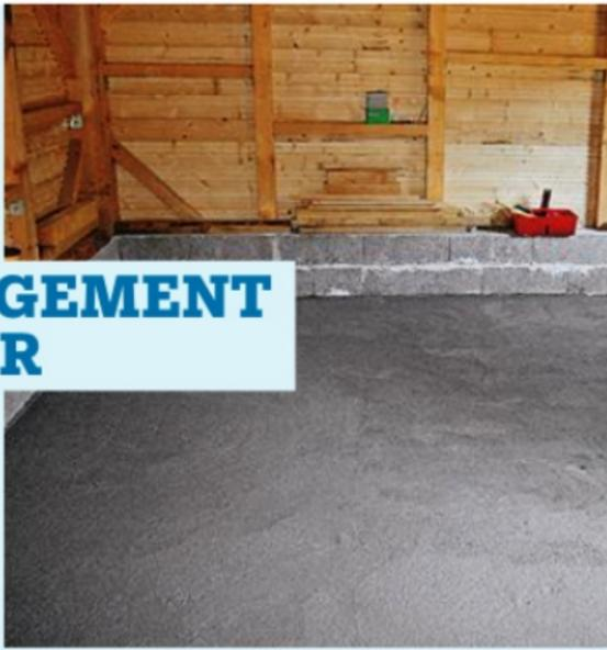
**23** À l'intérieur, une chape est coulée par-dessus la dalle. Le sol est ainsi plus confortable et permet de déplacer aisément panneaux et machines.
