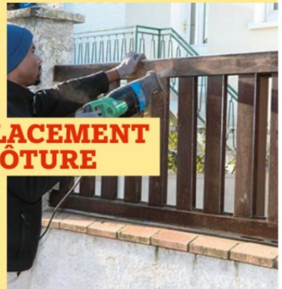
**28** La clôture se compose de trois travées sur muret, fixées entre des piliers. Une découpe à la scie sabre précède la dépose des éléments en bois.
