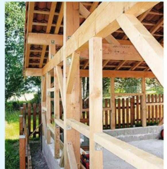
**14** Les derniers éléments de la structure peuvent être installés : montants, traverses et jambes de force. De part et d'autre des huisseries, les espaces doivent être respectés.
