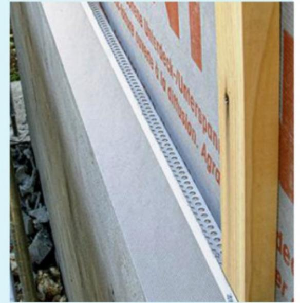
**31** L'épaisseur des lattes forme une indispensable lame d'air de ventilation. Avant de poser le bardage, fixez en partie basse une grille antinuisibles (obligatoire).
