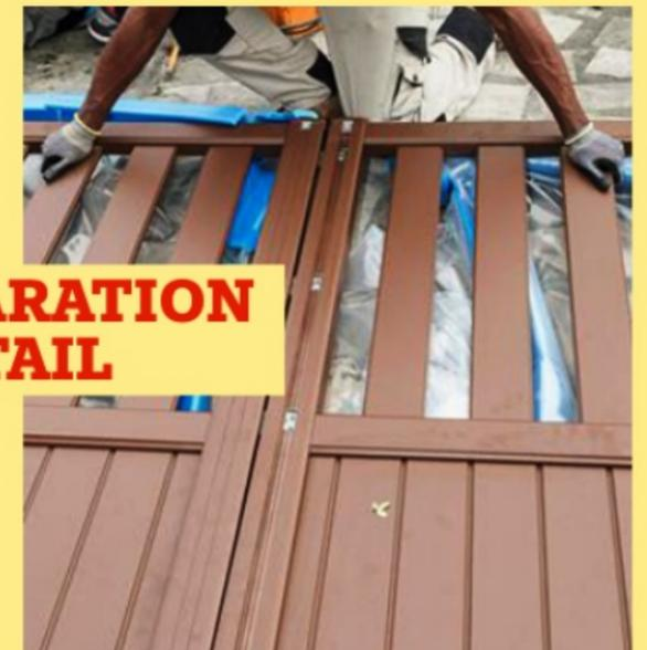
**6** Les deux vantaux posés à plat sur le sol, réunissez-les par leurs pattes d'assemblage. Au nombre de quatre, elles s'ajustent au millimètre près.
