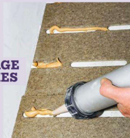
**11** Déposez un cordon de colle dans les alvéoles de la sous-couche. On utilise ici une colle souple monocomposant en recharges et un pistolet extrudeur.
