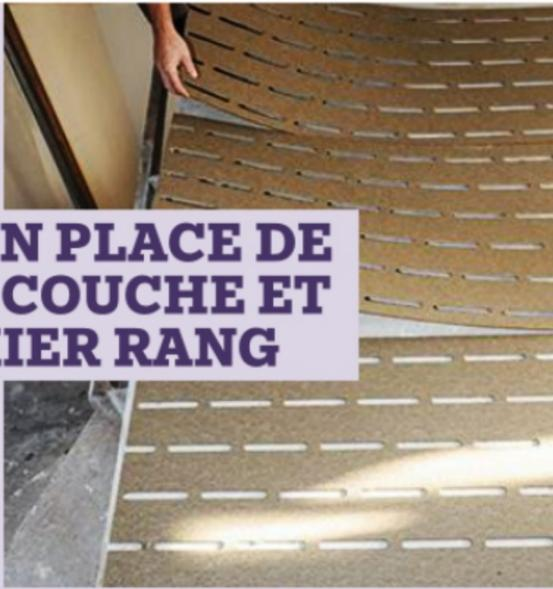
**1** Positionnez les premiers panneaux de sous-couche acoustique en partant du fond de la pièce. Les alvéoles sont perpendiculaires au sens de pose des lames.
