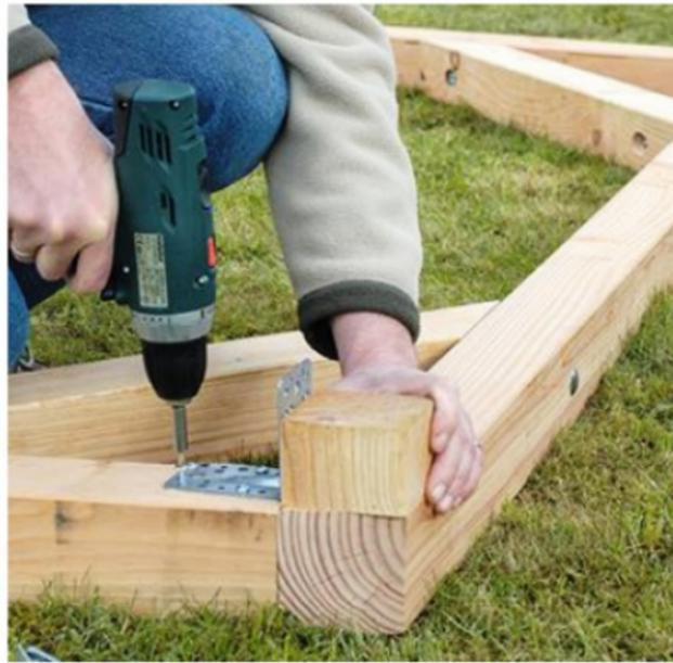
**2** Les « fermes » de la plate-forme sont assemblées sur le chantier : les poteaux avec la traverse avant ou arrière, puis les jambes de force. Les équerres des traverses latérales sont aussitôt vissées.
