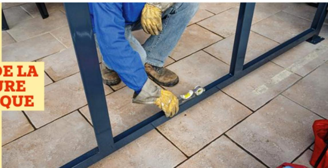
**1** Après un traçage au sol, posez la structure à son emplacement définitif et contrôlez son horizontalité avec un niveau à bulles. Vérifiez les points d'ancrage (platinas pré-percées).
