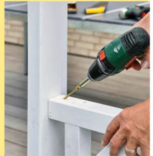
**19** La fixation se fait par vissage en biais à travers les traverses du cadre. Les vis seront ensuite masquées par l'ajout d'une main courante.
