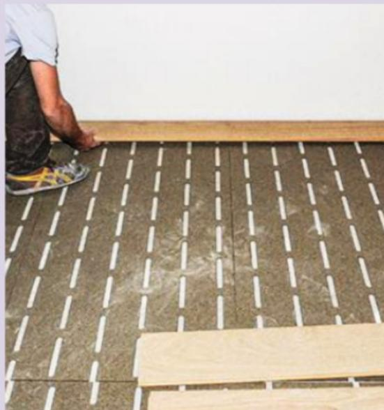
**4** Une fois la sous-couche acoustique installée, procédez à une pose à blanc des premiers rangs. Commencez par disposer les lames d'extrémité, le long du mur le plus long.
