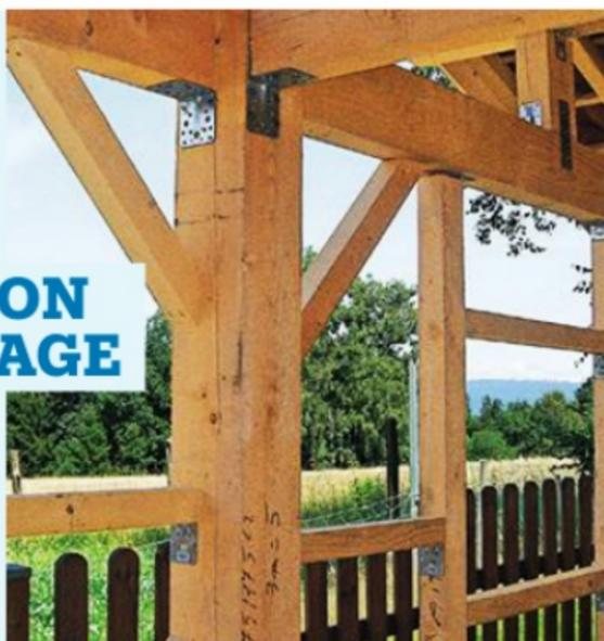
**15** Faute de disposer d'un outillage lourd de charpentier, la charpente principale et les éléments intermédiaires sont assemblés par connecteurs métalliques.
