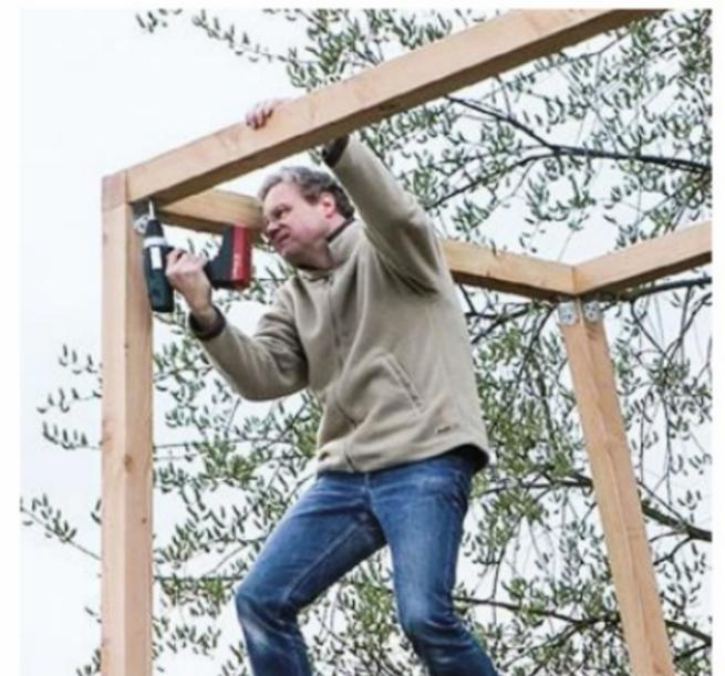
**9** Les traverses latérales hissées, les montants latéraux et intermédiaires sont installés : trois sur les côtés (identiques à ceux des angles), deux à l'avant et à deux l'arrière.
