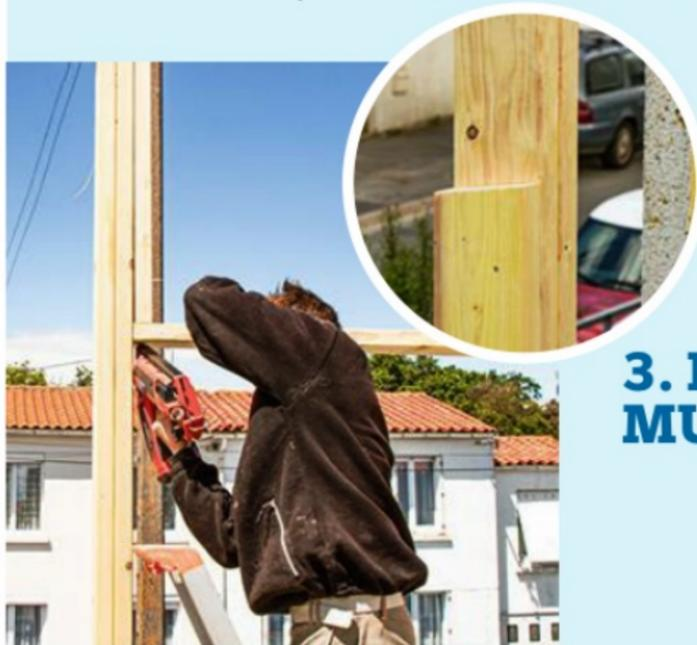
**21** Repérez l'emplacement des fenêtres. Débitez les pièces d'encadrement et vissez-les. En partie basse, doublez les montants pour former un appui. Respectez un angle de 10°.
