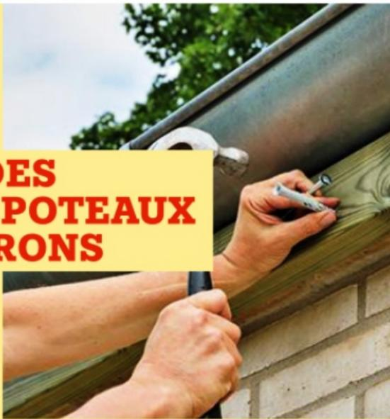
**1** Placez la panne sous la gouttière, contre le mur. Percez directement à travers le bois et la maçonnerie (Ø10 mm) pour placer des chevilles traversantes et des vis.
