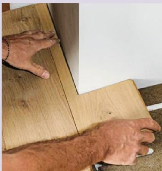
**10** Contrôlez l'ajustement de la découpe par un positionnement à blanc. Vous pouvez travailler au fur et à mesure de la pose.
