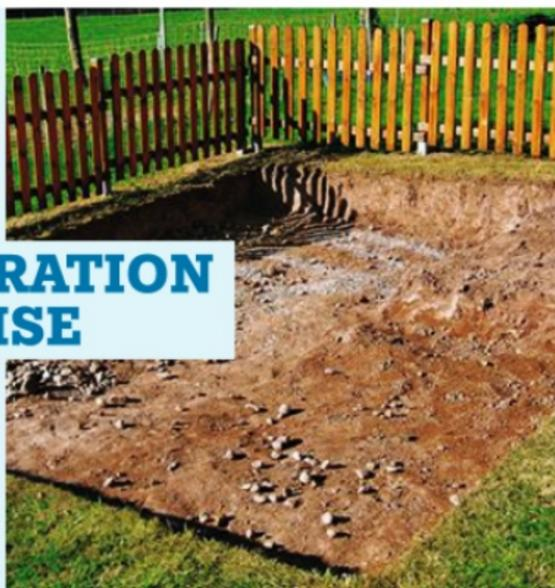
**1** La fouille tient compte de la légère pente du terrain. Le dénivelé entre les points extrêmes est de 40 cm. S'y ajoutent les 25 cm prévus pour l'épaisseur de la dalle.
