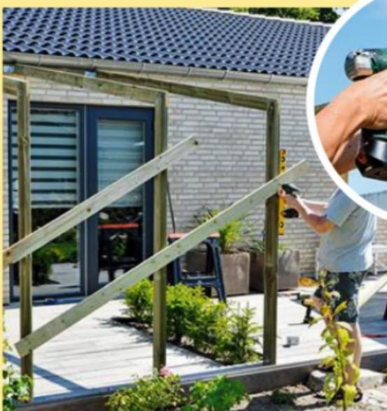
**10** Vissez des jambes de force provisoires contre les poteaux afin de les maintenir en position verticale. Pour éviter de marquer le bois, vous pouvez utiliser des serre-joints.
