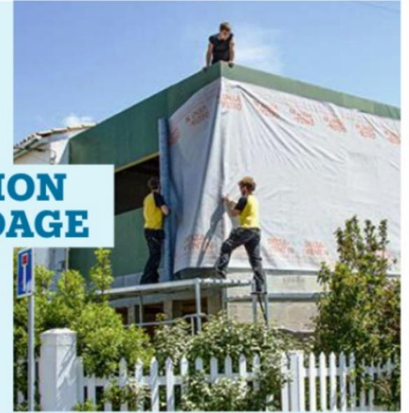
**28** Déroulez et agrafez l'écran pare-pluie sur les panneaux de contreventement. Effectuez la pose de bas en haut, pour que le lé supérieur vienne en recouvrement (20 cm).
