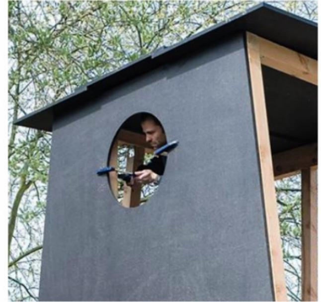
**12** Les trois panneaux d'habillage sont bridés en place avec des serre-joints, puis vissés ou boulonnés à la charpente. Les ouvertures ont été découpées au préalable.
