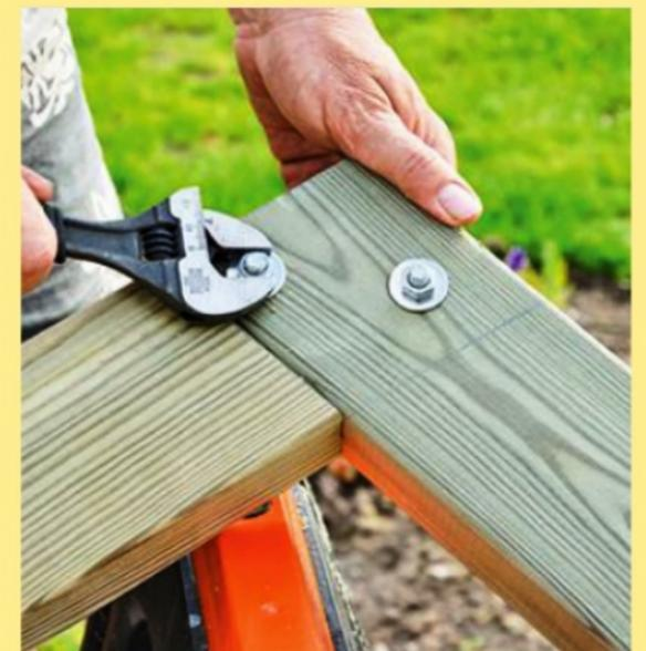
**6** Insérez les boulons à tête ronde et collet carré. Intercalez une rondelle entre l'écrou et le bois pour éviter d'enfoncer la surface du bois en serrant.
