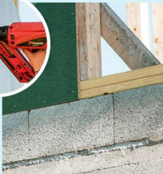
**25** Veillez à bien faire reposer les panneaux de contreventement sur le couronnement du mur, avant de les fixer à l'ossature.
