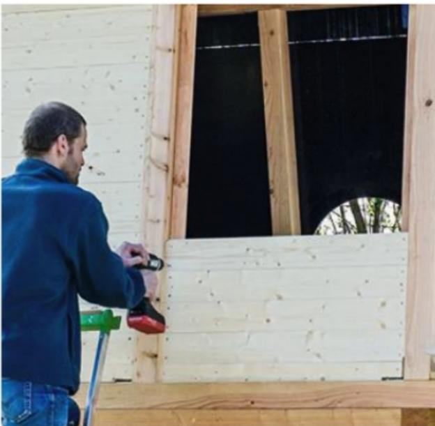
**13** La face gauche et les côtés de la façade sont habillés avec des lames de plancher (languette vers le haut). Vissés contre les montants, des tasseaux reçoivent les lames (également vissées).
