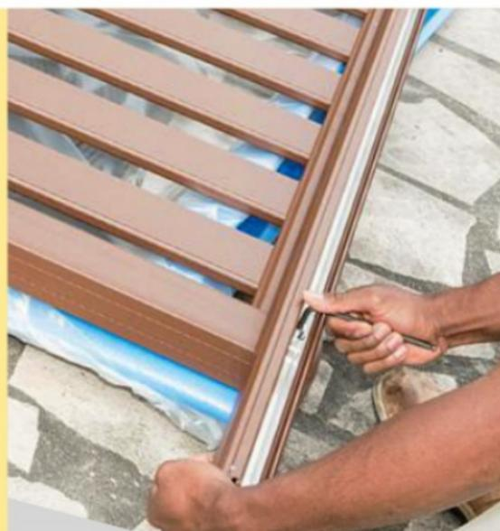
**8** Fixez le raidisseur supérieur sur la traverse haute du portail en le faisant dépasser dans le sens de l'ouverture. Réglez l'alignement et vissez à fond.
