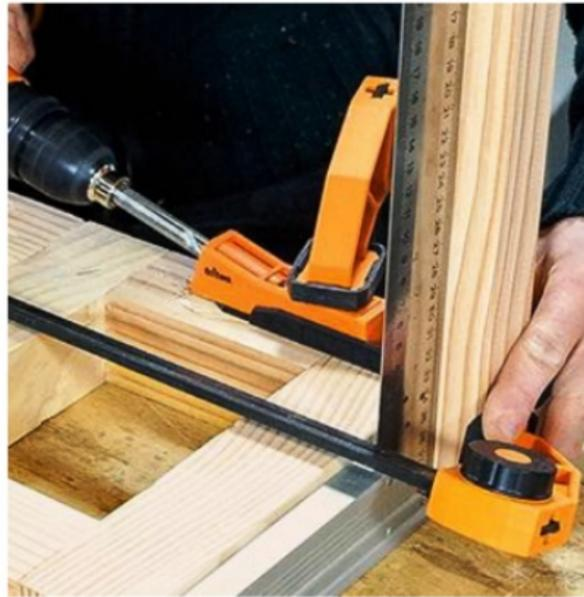
**6/** Assemblez une à une les lattes formant les marches. La première latte est maintenue verticalement contre une équerre. Des cales de 6 mm maintiennent un écart constant entre les lattes.
