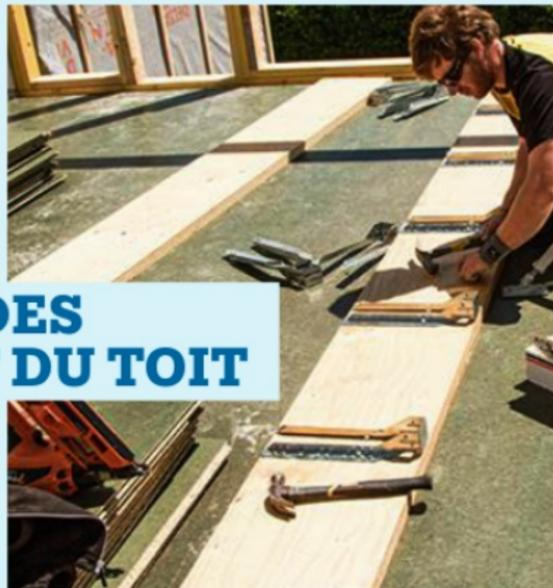
**22** L'ossature étant constituée, le moment est venu d'installer les « muralières » de la toiture plate. Clouez-y d'abord, tous les 60 cm, les sabots des poutres de la charpente
