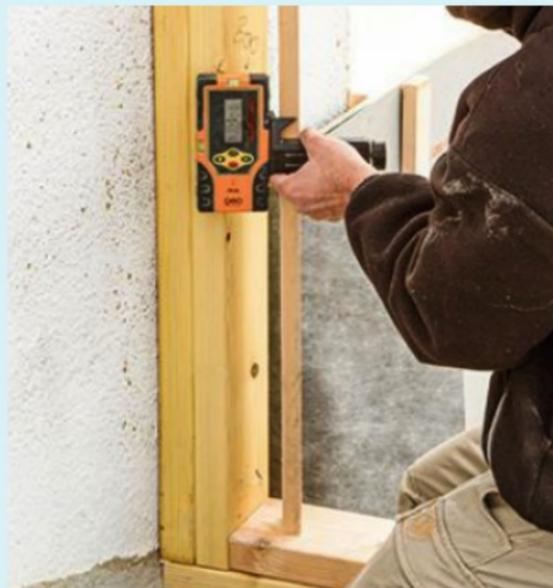
**16** À l'aide d'un niveau laser rotatif, déterminez la hauteur des montants de l'ossature. Relevez le point de référence à partir du premier montant.
