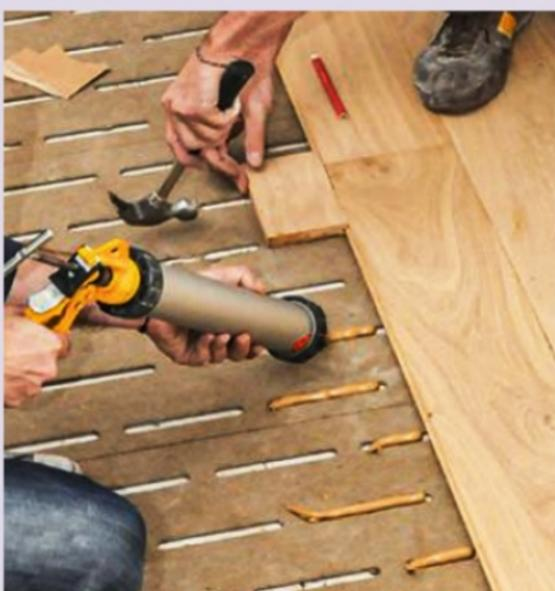
**17** Poursuivez la pose des rangées en encollant progressivement les alvéoles. Serrez bien les lames entre elles, utilisez si besoin le marteau et la cale martyr.
