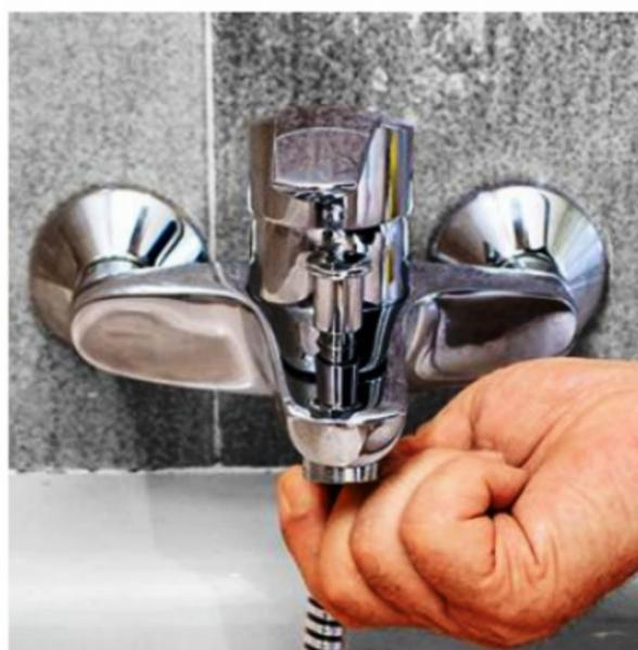
**6/** Installez le joint dans l'embout de connexion du flexible puis vissez ce dernier sous le bec du robinet. Cela permet de passer en mode douche en tirant simplement le bouton inverseur.
