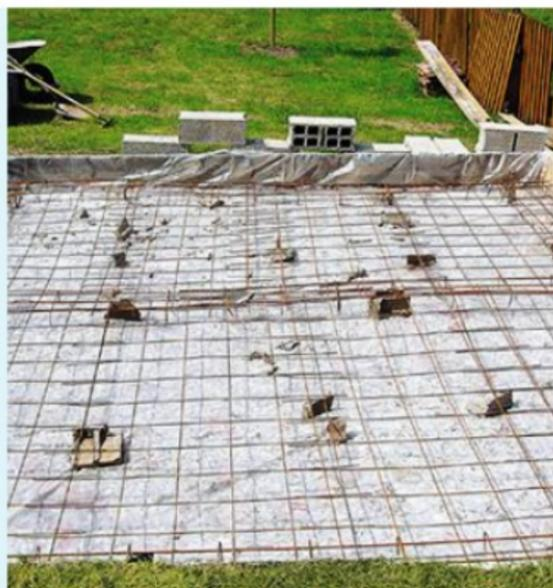
**2** Un hérisson d'environ 5 cm mêlant cailloux et tuiles cassées assure le drainage en fond de fouille. Un film polyane assure l'étanchéité. Le treillis soudé est calé par-dessus.
