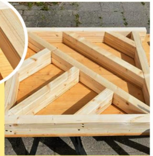
**17** Ce garde-corps a une fonction avant tout décorative, les barreaux sont disposés parallèlement et perpendiculairement à la diagonale du rectangle, puis vissés.
