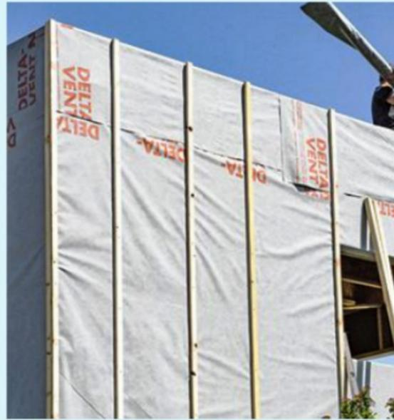
**30** Clouez les lattes (supports) de bardage sur les panneaux directement, au travers du pare-pluie. Respectez l'entraxe indiqué par le fabricant du parement.
