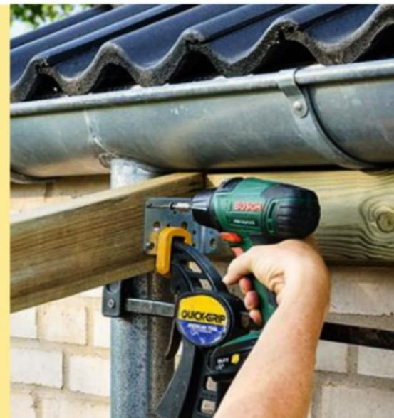
**9** Maintenez l'ensemble à l'aide de serre-joints. Pour éviter le tuyau de descente des eaux pluviales, le départ de la pergola est décalé par rapport à l'angle de la maison.
