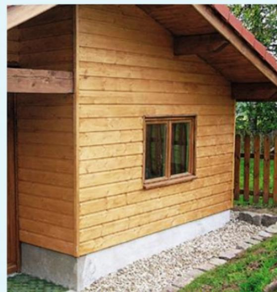
**22** Les poutres visibles à l'extérieur et l'extrémité des pannes sont traitées avec la même lasure que le pourtour des fenêtres. Ce contraste enrichit l'esthétique du chalet.
