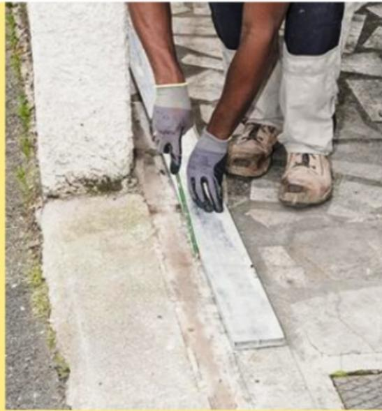
**2** Après avoir déterminé le sens d'ouverture du portail, à droite ou à gauche du passage, prolongez le tracé en conséquence au crayon et à la règle de maçon.
