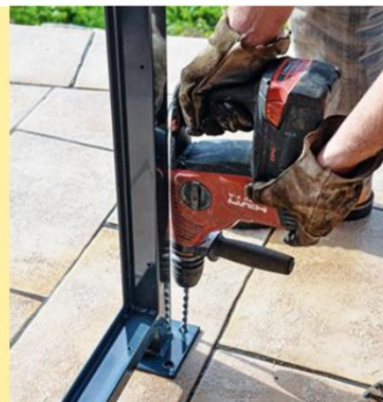
**2** À l'aide d'un perforateur équipé d'une mèche à béton, percez quatre trous à travers les deux platines formant les pieds du brise-vent.
