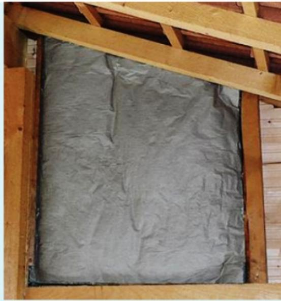
**24** Les parois sont isolées avec de la laine de roche en rouleau calée entre les éléments d'ossature. Clouées sur les poteaux et montants, des lames de bois habillent l'ensemble.
