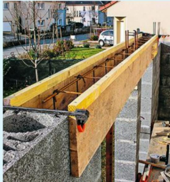
**8** Avant de couler le béton, des étais sont positionnés sous le coffrage. Le futur linteau est armé d'un ferrailage métallique de façon à renforcer sa structure.
