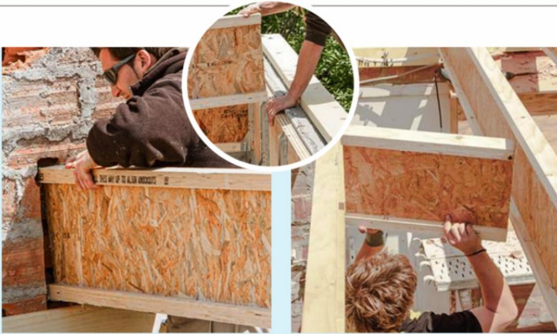
**9** Encastrez les solives dans les réservations des pignons, puis faites-les reposer dans les sabots. Clouez-les aux sabots et remplissez les cavités d'un mortier bâtard (ciment/chaux).
