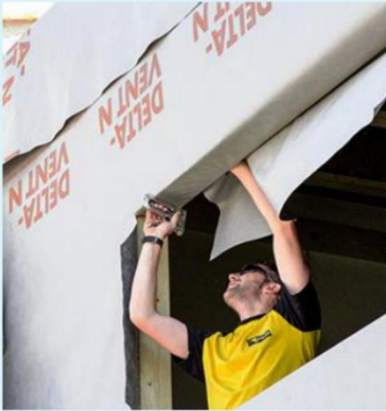
**29** Au niveau des ouvertures, découpez la membrane de manière à laisser suffisamment de débord pour recouvrir l'épaisseur de l'ossature. Agrafez-la tendue.
