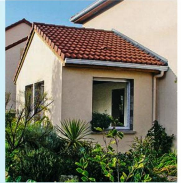
**15** La couverture en tuile béton est posée sur un pare-vapeur et un isolant en laine minérale. En façade, un enduit monocouche est appliqué en deux passes avec une finition grattée.
