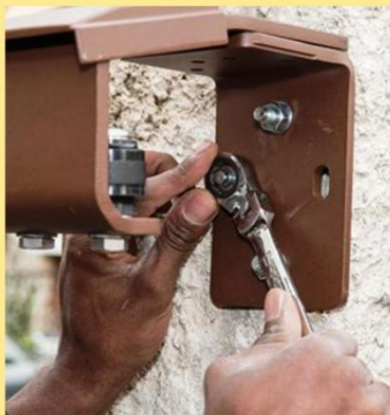
**14** Retirez les écrous et rondelles avant d'engager l'étrier sur ses tiges filetées. Remplacez-les pour effectuer la fixation. Serrez les écrous en vérifiant le bon coulissement, l'équilibrage et l'aplomb du portail. Il ne doit pas y avoir de friction. En cas de défaut, desserrez légèrement les écrous et rectifiez ce qui doit l'être.
