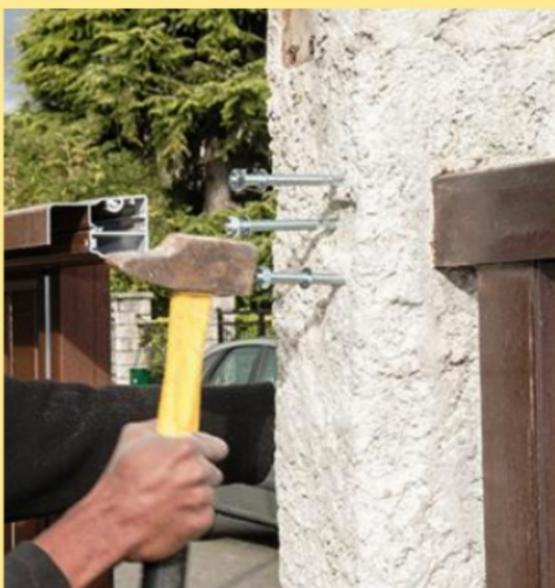
**13** Percez le pilier bien droit au diamètre des goujons à expansion. Enfoncez-les au marteau en laissant dépasser 15 mm de tige fileté.
