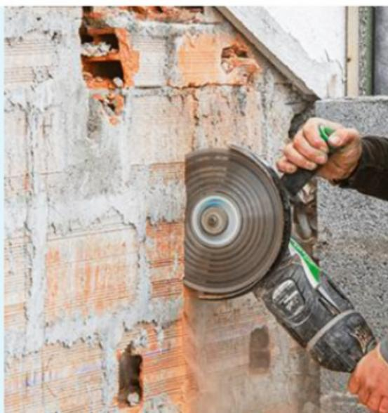
**2** Découpez les réservations à la meuleuse Ø 230 mm équipée d'un disque diamanté. Évidez sur 15 cm de profondeur à la massette et au burin.
