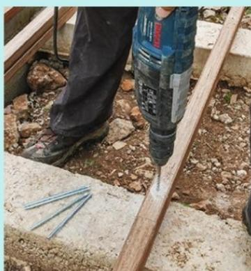
**15** La fixation sur les longrines peut se faire à l'aide de vis pour fixation directe dans le béton de 7,5 x 152 mm, après un préperçage au perforateur (Ø 6 mm).
