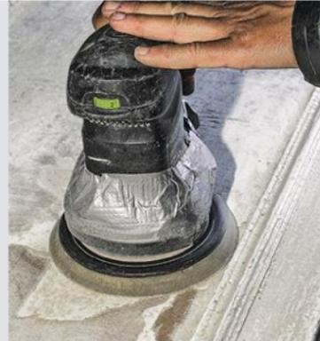
**2** Après nettoyage de la surface, poncez-la avec une ponceuse (grain 80 pour le décapage et grain 120 pour la finition). Poncez les moulures à la main.
