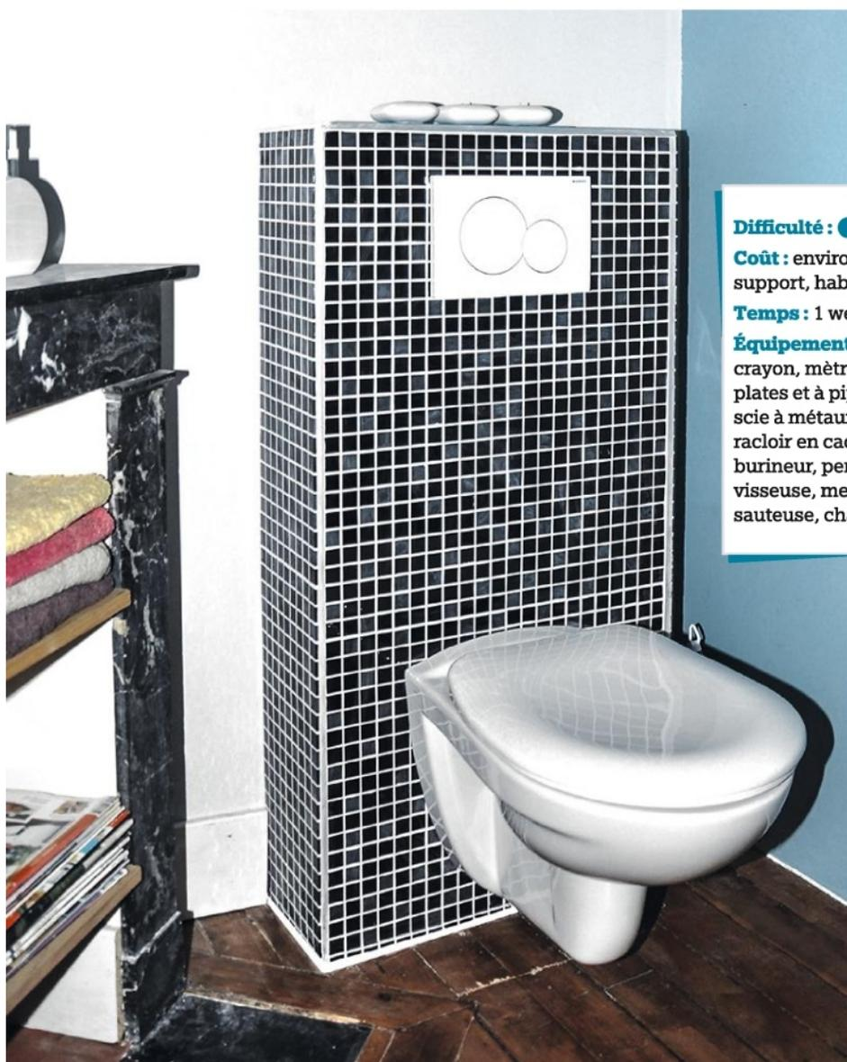
**L**orsque l'on veut installer des toilettes, on a le choix entre des W.-C. à poser ou à suspendre. Plutôt bon marché en entrée de gamme, les premiers se composent d'un pack comprenant la cuvette, le réservoir et son mécanisme
