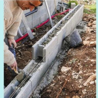
**2** Sur certains côtés, le muret est réalisé avec des blocs à bancher. Cette solution permet de laisser facilement l'accès aux tuyaux d'arrivée d'eau et aux buses des skimmers.
