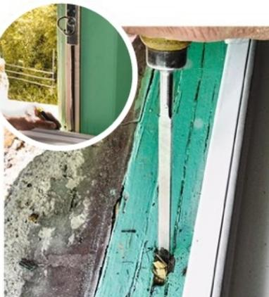
**8/** Reportez la position des extrémités des tringles sous le linteau et sur l'appui de baie (ici une traverse en bois). Réalisez leur logement à l'aide d'un ciseau à bois.
