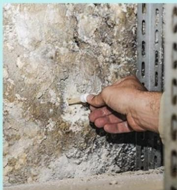
**10** Ces mèches permettent de détecter la présence des termites lorsque la cellulose est consommée. Elles sont alors remplacées par des pièges contenant l'inhibiteur.
