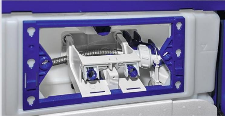
**23** Le bloc de commande se fixe à l'aide de clips sur la partie supérieure du réservoir. Les boutons-poussoirs de la plaque de finition (chasse d'eau) actionneront séparément les deux types de commande (3 ou 6 litres) par pression.
