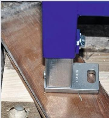
**6** La partie haute de la cuvette se situe généralement à 38 ou 40 cm du sol. Réglez la hauteur à l'aide des tubes carrés coulissants logés dans le piètement du bâti.
