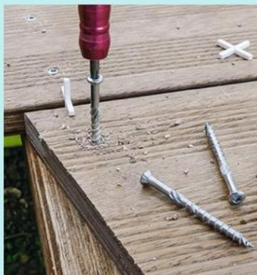
**22** Utilisez des croisillons de carreleur pour maintenir un écartement de 3 mm entre les lames. Pour les prolonger, elles sont recoupées selon un angle de 22,5° pour que les liaisons, à l'aplomb d'une lambourde, se fassent avec une seule vis par lame, placée du côté de l'angle aigu. De cette façon, la vis n'est pas trop proche des extrémités.
