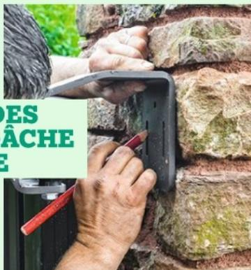
**21** Faites maintenir le portail et amenez l'un des montants devant le pilier. Repérez la position du guide supérieur, réglable en hauteur. Percez les trous des fixations à plus de 5 cm de l'arête d'une pierre.
