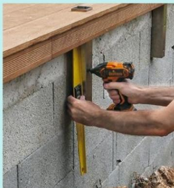
**29** Fixez les tubes d'aplomb contre le muret en béton, derrière le bandeau recouvrant les lambourdes. Ils traversent et dépassent de 5mm au-dessus des lames bordant la terrasse.
