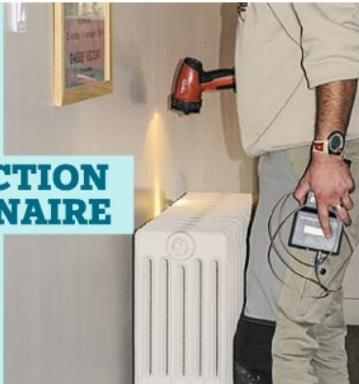
**1** La recherche de termites s'effectue en certains points précis : au seuil des pièces avec parquet ou plancher en bois, au ras des plafonds, derrière les radiateurs...
