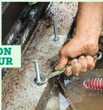
**25** À l'opposé, repérez l'endroit où s'arrête le vantail en ouverture maximale. C'est là que s'installe la butée d'ouverture. Vérifiez que l'amortisseur n'arrive ni trop haut ni trop bas.
