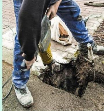
**2** Au droit de l'entrée, tracez au sol l'implantation des poteaux du portail et du portillon. Si besoin, déposez l'ancien revêtement de sol maçonné au marteau-piqueur.
