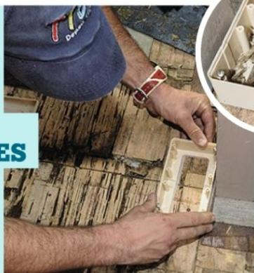
**6** Des pièges sont posés sur les zones de passage des termites. Ici, pour plus d'efficacité, la couche superficielle du bois est retirée à la pointe d'un couteau.
