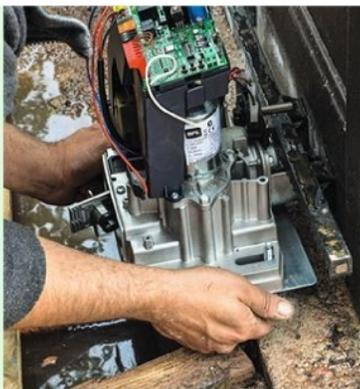
**28** Présentez le moteur (débrayé) sur sa platine et ajustez sa hauteur pour obtenir le jeu au pignon (conformément à la notice du fabricant) ainsi que sa position avant-arrière. Fixez-le ensuite sur les goujons. À l'arrière, ajoutez deux tiges filetées symétriques aux précédentes.
