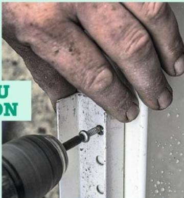
**12** Sur le poteau qui recevra la serrure du portillon, vissez une section de rail métallique en pied afin de pouvoir loger le soubassement de la clôture. Cela a aussi pour effet de le maintenir droit avant la fixation au sol et la pose du panneau grillagé.
