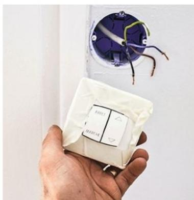
**1/** Retirez la plaque de finition puis démontez l'ancienne commande. Déconnectez les câbles d'alimentation en repérant les fils assurant la montée et la descente du volet (ici, noir et marron).
