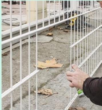
**11** Au niveau du coffret électrique, découpez le treillis métallique à la meuleuse, puis appliquez de la peinture (pot, aérosol...) sur les découpes pour éviter la rouille. Scellez tous les poteaux de clôture avant de commencer la pose du portillon.
