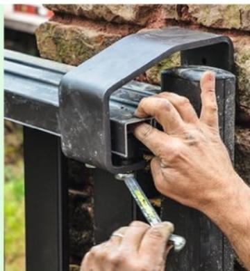
**23** Affinez le réglage en avançant ou reculant les galets. Ce sont eux qui permettent maintenant au vantail de rester parfaitement vertical d'un bout à l'autre de sa course.
