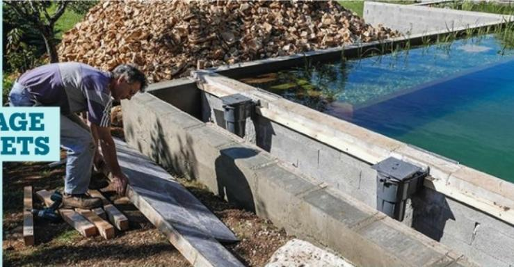
**1** Un côté de la plage est ici supporté par un muret en béton armé dosé à 350 kg/m<sup>3</sup>. Le coffrage de ce mur est réalisé avec des planches provisoirement maintenues par des lambourdes calées contre le mur du bassin. Après un temps de prise de trois jours, les lambourdes et le coffrage sont démontés.
