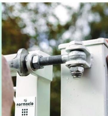
**14** Installez le vantail du portillon sur ses gonds puis serrez sommairement à la clé plate pour solidariser l'ensemble. Travailler à deux facilite la mise en place et le vissage.
