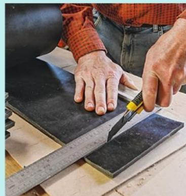
**9** Découpez au cutter des bandes de caoutchouc de 8 x 50 x 200 mm pour isoler les margelles en bois (particulièrement exposées à l'humidité) de l'arase en béton.
