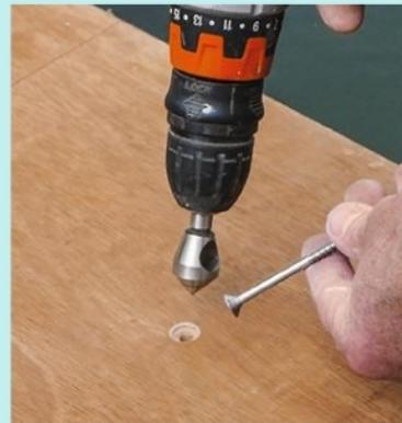
**11** Les perçages sont de préférence centrés sur la largeur de l'arase de la piscine. Fraisez les entrées des trous : les vis de 6 x 100 mm, doivent affleurer la surface.
