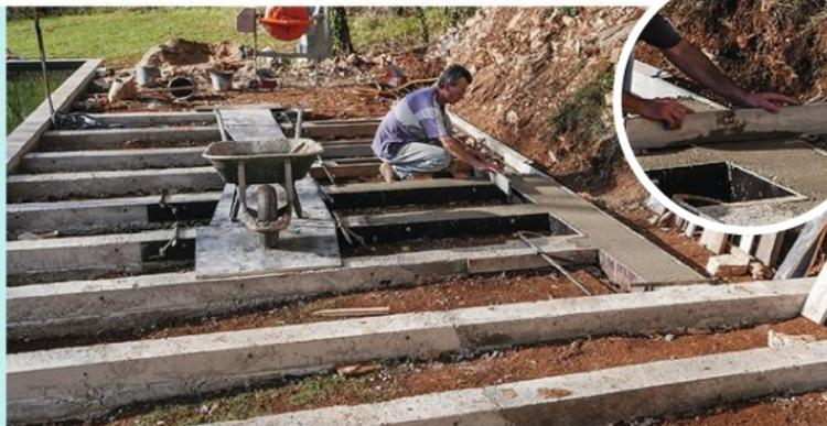
**7** Après avoir décoffré, prolongez les longrines en décalant les planches de coffrage jusqu'à la limite extérieure de la terrasse, en n'oubliant pas de lier les longrines au massifs de fondation ou aux murets. Arasez soigneusement l'ensemble avec une règle de maçon.
