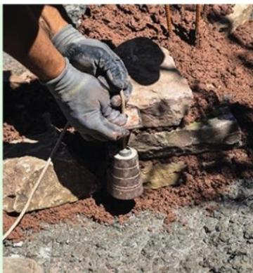
**14** Commencez à maçonner le pilier de 45 x 45 cm en croisant les joints verticaux. Rectifiez à la massette les pierres qui l'exigent et contrôlez l'aplomb de chaque élément.
