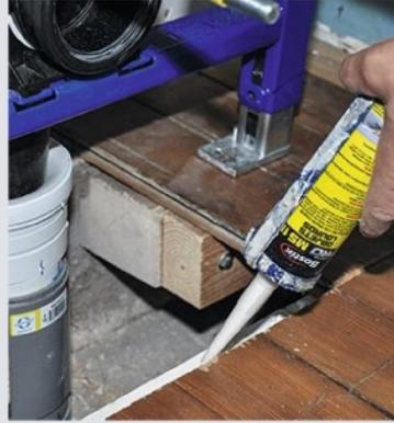
**18** Le bâti-support fixé et les réseaux terminés, il faut à présent remettre les lames de parquet initialement retirées. Un mastic-colle est utilisé pour assurer leur collage.
