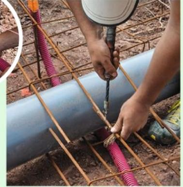
**3** Disposez l'armature de la longrine sur toute la longueur de la tranchée. Ligaturez les fers à leur jonction : ici de part et d'autre d'une canalisation en PVC (eaux pluviales).
