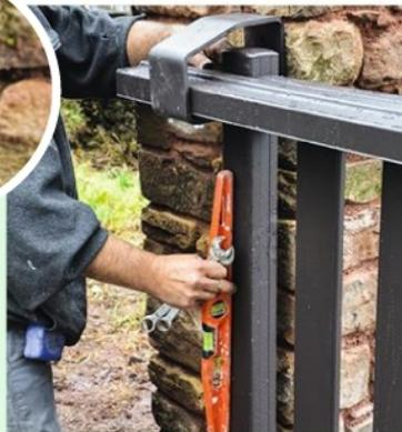
**22** Serrez les fixations du guide sans les bloquer. Engagez le guidage du portail sur les galets et contrôlez l'aplomb. Si besoin, ajoutez des entretoises derrière la platine de fixation.
