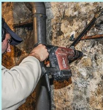
**9** Des trous sont percés dans les murs du sous-sol. Ils servent à introduire des appâts sous forme de mèches contenant de la cellulose.
