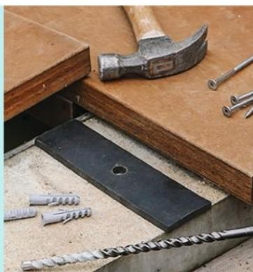
**12** Percez les cales en caoutchouc et le béton à travers les margelles, soigneusement mises en place, avec un foret béton de Ø 6 mm, puis un foret de Ø 10 mm pour placer les chevilles. Commencez par fixer les margelles sur les petits côtés. Le débord des bandeaux par rapport au liner doit être suffisant pour contenir le ressaut des skimmers.
