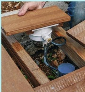
**24** Pour fixer et isoler du sol ce boîtier électrique étanche relié à un spot immergé, fixez-le sous une lame courte qui pourra toujours être dévissée en cas de nécessité.
