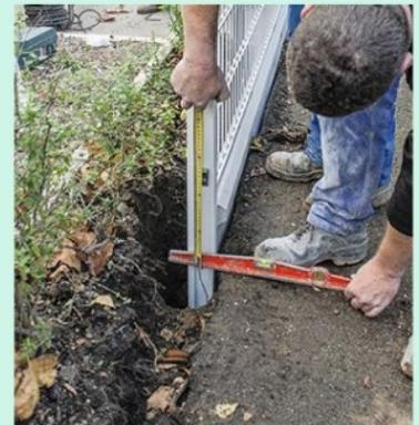
**6** Ajustez chaque poteau au niveau du sol. Pour cela, utilisez un mètre et un niveau. Ici, le scellement requis fait environ 25 cm de profondeur.
