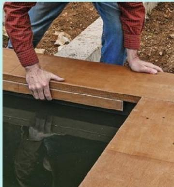
**10** Présentez les margelles. Dans les angles rentrants, prévoyez un retrait du bandeau correspondant au recouvrement d'une lame sur l'autre. Coupez de long les margelles.
