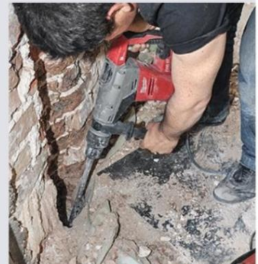
**16** Le passage de l'évacuation à l'étage inférieur nécessite de réaliser une saignée puis de percer la dalle pour atteindre le sous-sol où se trouve le collecteur général.
