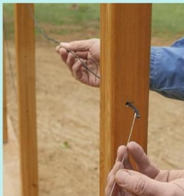
**31** La barrière de protection est assurée par un cordage tendu en polyester tressé de Ø 3 mm (résistance : 150 kg), traversant les poteaux. Pour faciliter le passage de la tresse, utilisez une aiguille à locher (matériel de pêche).
