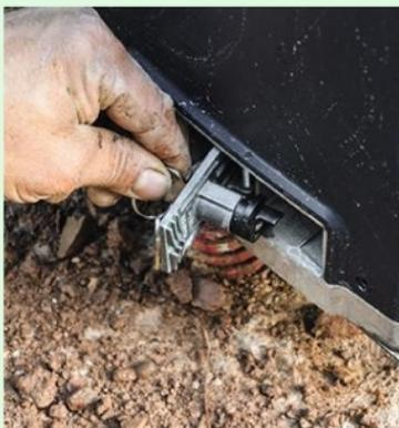
**33** Avant d'embrayer le moteur, vérifiez manuellement le mouvement du vantail en ouverture et fermeture. Remettez l'électricité. Mémo-risez le premier émetteur.
