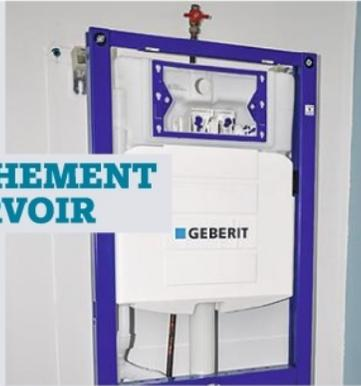
**9** Repérez la hauteur de tuyau en cuivre à recouper. Tenez compte du raccord coudé que vous allez souder. Retirez le bâti-support pour libérer l'espace le temps de la soudure.
