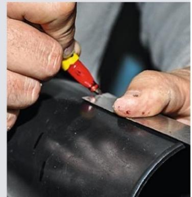
**28** Si les manchettes sont encore trop longues, répétez l'opération jusqu'à ce que le dos de la cuvette se retrouve contre la paroi carrelée.
