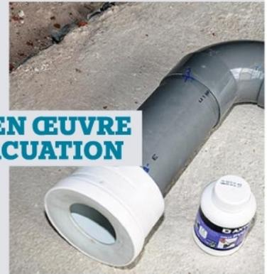
**14** Le bâti-support dispose d'une pipe intégrée à raccorder au tube d'évacuation PVC (Ø 100 mm) équipé d'un joint à lèvres.
