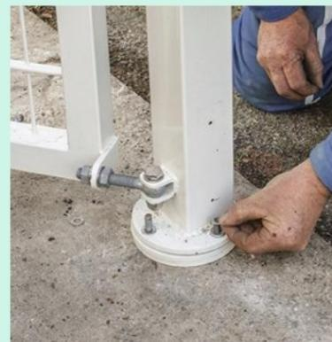
**18** Glissez deux platines supplémentaires pour retrouver l'aplomb du sol. Contrôlez au niveau à bulle puis vissez la platine du poteau.
