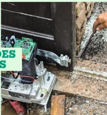
**30** Si aucune réservation n'a été prévue sous la longrine, percez-la de part en part. Passez le câble qui alimentera la cellule photoélectrique. Faites de même au bas du pilier.
