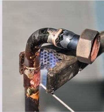
**10** Coupez le tube à la scie à métaux. Brasez un collet-battu avec douille filetée sur un raccord coudé (Ø 12 mâle/mâle) que vous soudez au tube à l'aide d'un manchon.
