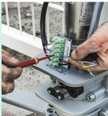
**30** Dénudez les câbles électriques sur 1 mm environ (voir astuce). Vissez chaque fil sur le domino du moteur en suivant les indications de la notice.
