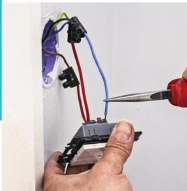
**5/** Raccordez les câbles sur les bornes à connexion automatique de la commande en plaçant le fil de phase sur l'indicateur L puis les fils de montée et descente (position 1 et 2).
