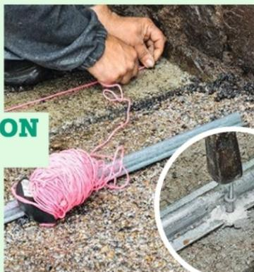
**18** Tendez un cordeau pour matérialiser l'axe du rail au sol. La notice du portail indique l'écart à laisser entre le rail et le pilier. Le respect de cette cote conditionne toute la pose.
