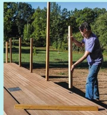
**30** Introduisez les piliers en mélèze de section 57 x 57 mm dans les tubes, la tête de la vis de fixation la plus basse servant de butée.
