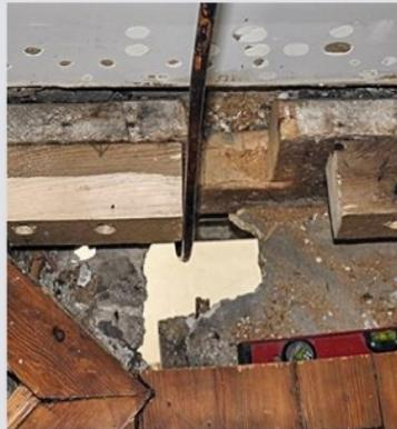
**4** Le tube d'alimentation en cuivre (Ø 10/12 mm) de la chasse d'eau - préalablement cintré sans raccords - provient de l'étage inférieur.
