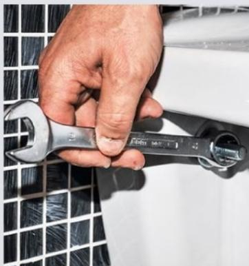
**31** À l'extrémité de chaque tige filetée, placez une rondelle en plastique, une rondelle plate et l'écrou qui sera serré modérément après contrôle du niveau.
