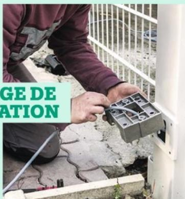
**25** Depuis la gaine électrique en attente au pied du poteau de portail, tirez un câble électrique à travers la réservation prévue dans le poteau. Vissez ensuite la platine.
