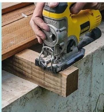
**19** Recoupez les lambourdes à leur longueur définitive avant de poser la lame de bordure. Celle-ci dépasse de 20 mm, en prévision de la pose d'un bandeau de finition.
