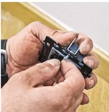
**8/** Si le boîtier est un ancien modèle, vous pouvez équiper la platine de vis et griffes. Vissez la platine jusqu'à l'écartement complet des griffes dans le boîtier.
