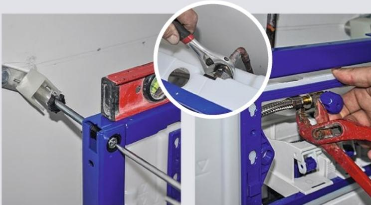
**12** Démontez le robinet et fixez le bâti au mur. Bloquez les vis à l'aide de collets en plastique noir fournis (bagues à clipser). Remplacez le robinet par le réservoir.
