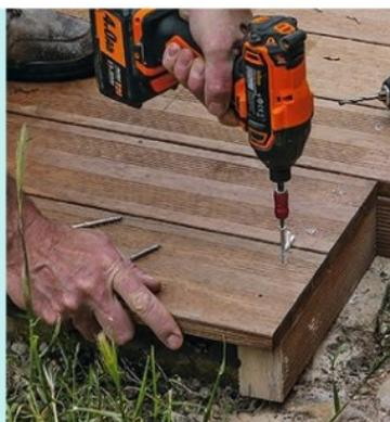
**20** Utilisez les mêmes vis (5 x 60 mm) pour la fixation des lames de terrasse et des bandeaux. Avec un bois dur, il est préférable de réaliser un avant-trou avec un foret de Ø 4 mm.
