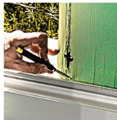
**2/** Reposez le volet et repérez les limites de la latte par rapport à la feuillure des traverses inférieure et supérieure de la menuiserie. Mesurez la hauteur totale de la crémone, logements compris.
