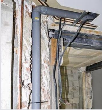
**17** L'évacuation (tube PCV) et l'arrivée d'eau cheminent le long du mur de l'étage inférieur. Elles seront ensuite cachées par un faux plafond et des plaques de plâtre.
