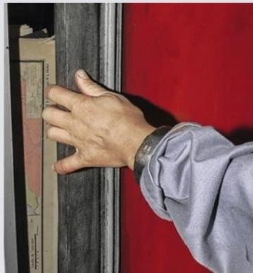
**12** Pour finir, vérifiez l'alignement des paumelles en emboîtant les vantaux. En cas de différences de niveau, ajustez-les.
