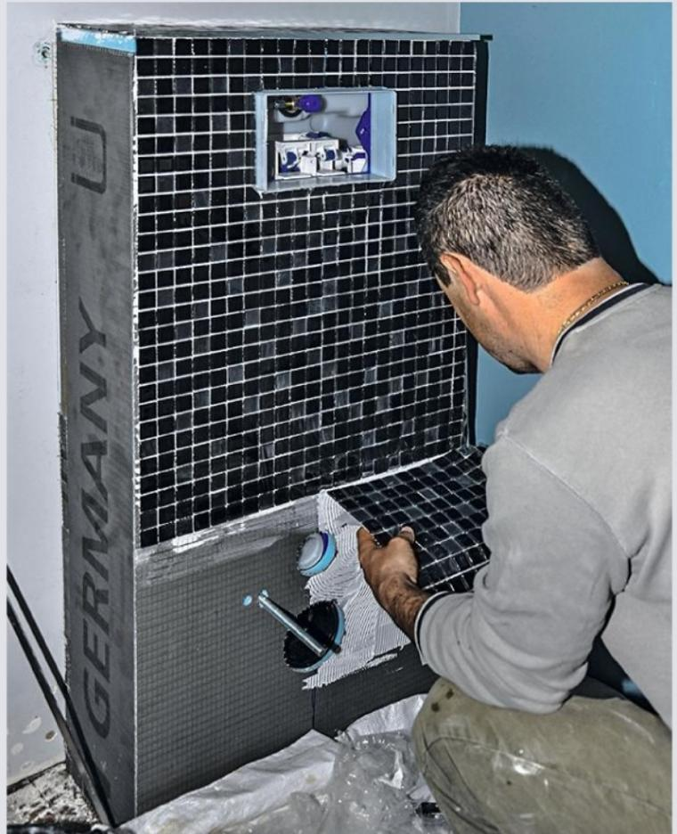
**22** Appliquez de la colle par petites zones. Positionnez la plaque, ajustez-la puis pressez. Après séchage, jointoyez la mosaïque (joint blanc) à l'aide d'un racloir en caoutchouc. Garnissez bien les joints, laissez-les tirer, puis passez une éponge humide pour obtenir une finition parfaite.
