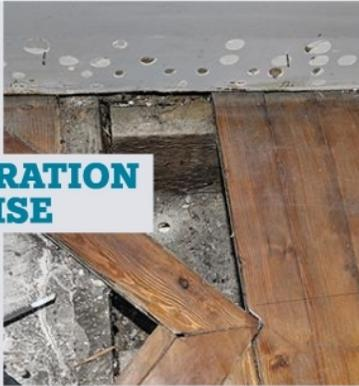
**1** Le nouvel espace toilette (ici dans une chambre) impose de retirer des lames de parquet, pour permettre la fixation au sol du bâti-support. Après repérage, les lames sont retirées une par une et conservées pour être réutilisées.
