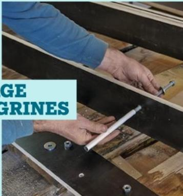
**3** Le bassin et les murets sont reliés par des longrines en béton armé. Leur coffrage est réalisé avec des panneaux liaisonnés avec des tiges filetées passant dans des tubes PVC.
