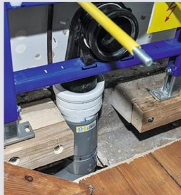
**15** Enfoncez le joint à lèvres dans la pipe du bâti-support. Il assure l'étanchéité de l'évacuation de la chasse d'eau. À noter : il ne doit surtout pas être collé.
