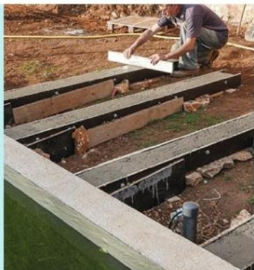
**6** Alignez et mettez de niveau les coffrages en prévoyant un retrait de 7 cm sous l'arase de la piscine (hauteur des lambourdes). Coulez le béton, tirez avec une règle en alu.
