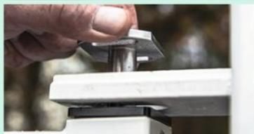
**22** Installez le premier vantail sur le pivot du bas puis placez le gond du haut maintenu par des boulons munis de rondelles. Faites de même pour le second bloc poteau et vantail.
