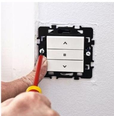
**7/** Vissez la platine sur le boîtier encastré. Contrôlez à l'aide d'un niveau à bulle le bon alignement, avant de terminer l'opération en serrant les vis à fond.
