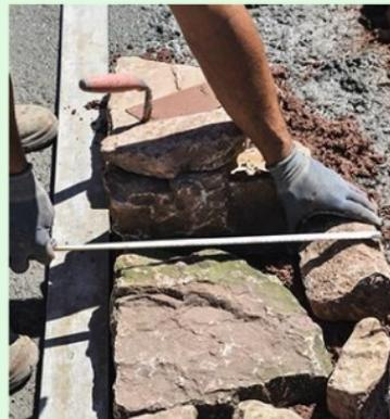
**12** Orientez contre le chevron la face la plus plane des plus grosses pierres. N'hésitez pas à vérifier régulièrement l'épaisseur de l'ouvrage lorsque vous complétez sa partie arrière.
