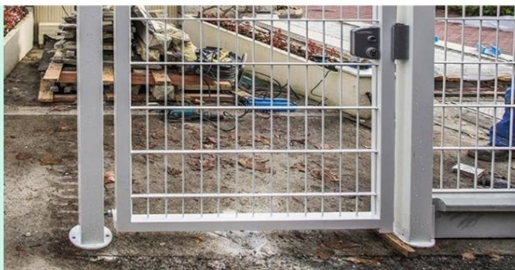
**15** Présentez le poteau porteur et son vantail en continuité du poteau receveur. Maintenez l'ensemble de niveau en utilisant des cales en bois afin que la serrure soit bien en face de la gâche.
