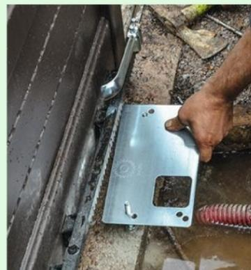
**27** Ajoutez des écrous et rondelles supplémentaires sur les goujons. Enfoncez la platine de fixation du moteur. Grâce aux écrous, prérezglez sa hauteur à plus de 25 mm du sol.
