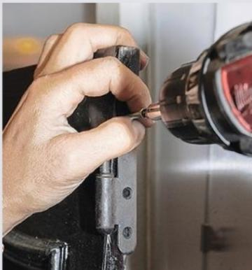
**11** Vissez les paumelles dans le chant des vantaux à 5 cm des extrémités haute et basse ainsi qu'au milieu. Pour éviter l'éclatement du bois, effectuez des prétrous avant vissage.
