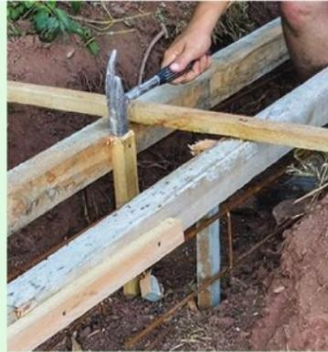
**7** L'écartement des chevrons est maintenu constant en interposant tous les 2 m des chutes de tasseaux : les unes clouées en travers et d'autres enfoncées dans le sol.
