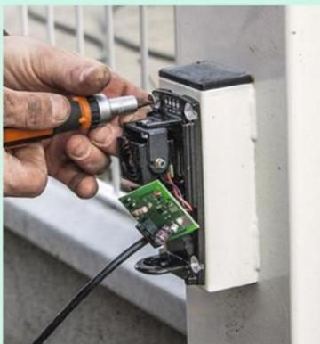
**33** Raccordez les câbles de la cellule photoélectrique. Vissez ensuite les platines en applique sur les poteaux puis placez leur couvercle étanche.
