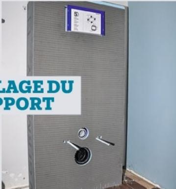
**20** Le coffrage est réalisé avec des panneaux prêts à carrelé (ép. 20 mm). Fourni prédécoupé, prémonté et percé, il est fixé à l'aide de vis autoforeuses.
