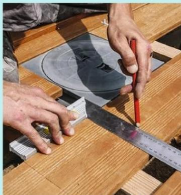
**17** Évitez d'avoir à recouper en largeur les lames du bord extérieur de la terrasse. Ici, il faut ajuster la première lame mise en place entre les regards des skimmers et la margelle.
