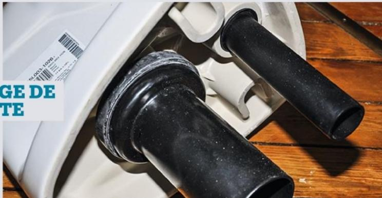
**27** Emboîtez les manchettes dans les sorties respectives de la cuvette et insérez-les dans chaque entrée du bâti-support jusqu'en butée. Faites une marque sur chaque manchette au ras du carrelage. Puis découpez les manchettes.
