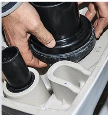
**29** Les manchettes recoupées prennent place dans les logements de la cuvette après avoir enduit les joints de graisse silicone. Coupez bien droit les tubes avec chanfrein d'entrée.
