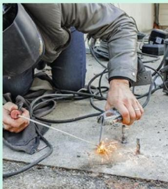
**17** Du fait de la pente, il faut ici rallonger les fixations pour installer le second poteau de niveau. Soudez des tiges filetées de même section sur les précédentes.
