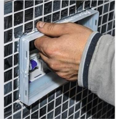
**24** Un cadre en plastique blanc vient se loger dans la fenêtre prédécoupée. Grattez au cutter les éventuelles surépaisseurs de joints qui pourraient gêner son clipsage.
