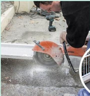
**4** Si nécessaire, recoupez le soubassement dans sa longueur. Pour cela, utilisez une découpeuse thermique équipée d'un disque pour maçonnerie.
