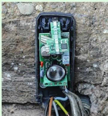
**31** Ouvrez le boîtier d'une cellule et repérez sa position au-dessus de la sortie du câble. Percez, chevillez et vissez l'embase. Dénudez et raccordez les conducteurs sur le bornier.
