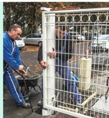
**24** Ajustez le vantail et son poteau porteur en utilisant des cales et en contrôlant l'aplomb au niveau à bulle. Scellez au béton rapide le pied de poteau, tassez et laissez tirer.
