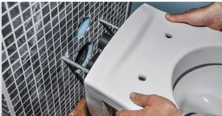
**30** Engagez la cuvette sur les tiges filetées vissées dans le bâti à la bonne longueur. Faites-vous aider pour cette opération, les manchettes devant être guidées par une personne allongée au sol pour qu'elles s'insèrent dans les joints à lèvres de l'arrivée d'eau et l'évacuation du bâti.
