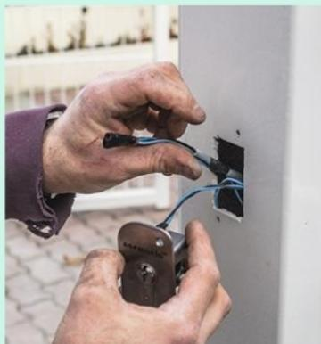
**34** Branchez le contacteur à clé d'ouverture et fermeture du portail en complément des télécommandes fournies. Vissez le boîtier dans la réservation prévue sur le poteau.
