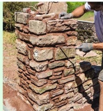
**16** Poursuivez le montage du pilier en disposant les plus grosses pierres aux angles. Creusez les joints avec un outil pointu et terminez à la brosse avant séchage du mortier.
