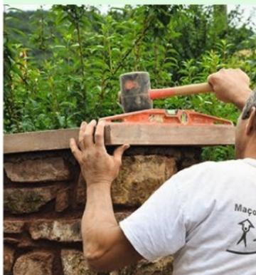
**17** Scellez le couronnement du pilier à l'horizontale. Bourrez bien le mortier, puis passez un coup de brosse sur le joint pour le creuser légèrement.
