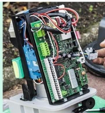
**31** Parallèlement, réalisez vos branchements sur le second moteur. Dénudez les fils, puis vissez-les sur le domino à brocher sur la carte électronique.
