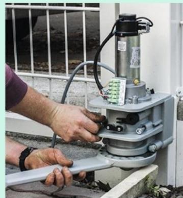
**28** Présentez puis vissez le moteur sur la platine de fixation du premier poteau. Les câbles en attente cheminent dans les passages prévus au niveau du moteur.
