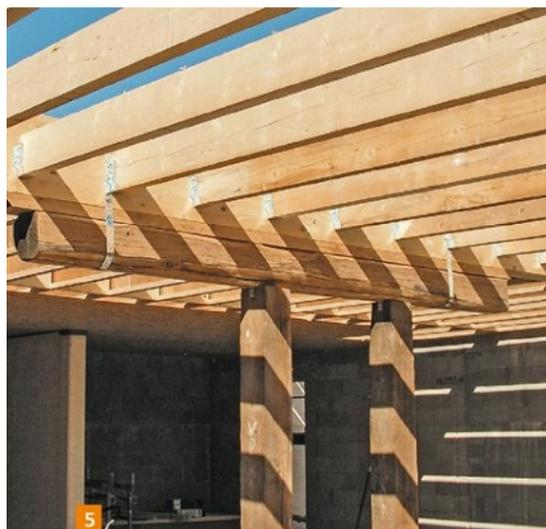
5. Le montage de l'ossature démarre par le plancher du rez-de-chaussée qui est posé sur les murs maçonnés du sous-sol. « Sur les conseils du bureau d'études, nous avons récupéré trois poutres de l'ancienne maison pour renforcer le plancher. Celui-ci est composé principalement de poutre en I de 40 cm pour pouvoir l'isoler avec de la paille. »
