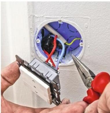
**6/** Repoussez les dominos derrière le boîtier d'encastrement pour ne pas gêner l'insertion de la commande du volet roulant. Élargissez le trou du boîtier si besoin à la pince.
