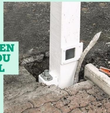
**21** Déposez un peu de béton dans l'excavation réalisée au départ puis placez le premier poteau du portail. Vérifiez son bon positionnement par rapport au gond sur pivot.
