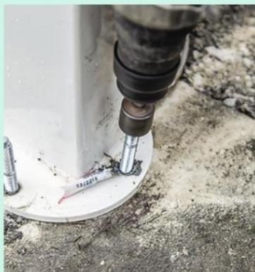
**16** Avec un perforateur équipé d'une mèche à béton ( $\varnothing$  10 mm), percez, chevillez et vissez des tirefonds. Ici, la fixation s'effectue par tige filetée à scellement chimique.
