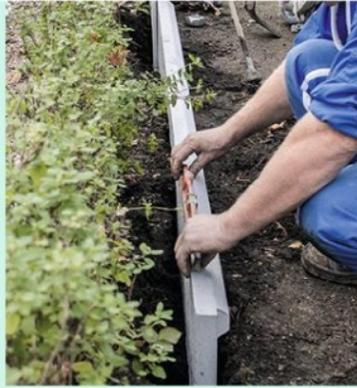
**8** Dans la tranchée, placez de niveau une deuxième section de soubassement. Ici, un soin particulier est nécessaire pour s'adapter à la pente du terrain.
