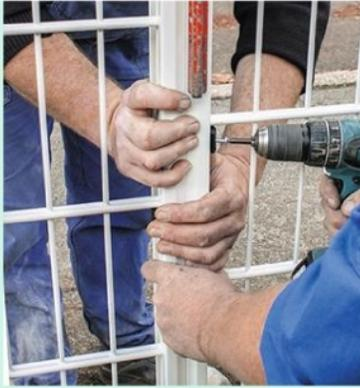
**7** Installez les clips de fixation fournis pour maintenir le panneau grillagé aux poteaux. Contrôlez l'aplomb et vissez les clips sur les poteaux (vis autoforeuses fournies).
