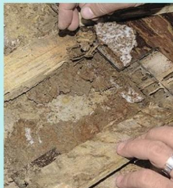
**5** Des sondages réalisés avec la lame d'un couteau ou d'un cutter confirment le diagnostic : les termites sont toujours là, comme en témoigne la couleur plus foncée du bois réduit en poudre. Maintenant que les différents endroits où l'infestation est avérée sont localisés, la seconde étape va consister à l'éradication des insectes par contamination de la colonie.
