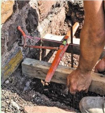
**6** Réglez la hauteur de l'un des chevrons au niveau laser et fixez-le sur les fers verticaux avec quelques pointes recourbées. Réglez ensuite l'horizontalité.
