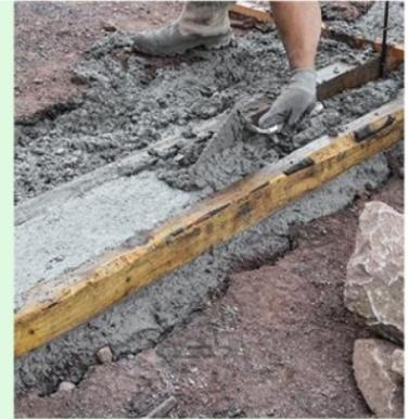
**8** Déversez le béton entre les chevrons (pas directement dessus pour éviter qu'ils ne s'enfoncent). Répartissez-le de façon homogène à la truelle.
