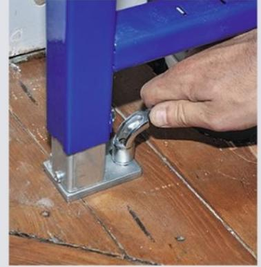
**19** Fixez définitivement les pieds réglés à la hauteur voulue. Dans le trou oblong de la semelle, percez un avant-trou de 5 mm et fixez avec un tirefond de Ø 8 x 80 mm.
