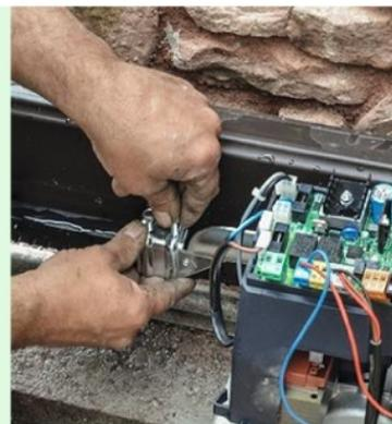
**29** Vissez sur la crémaillère la butée de fin de course d'ouverture et à l'autre extrémité celle de fermeture. Sans elles, le moteur ne peut s'arrêter automatiquement.
