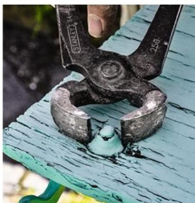
**1/** Placez le battant à plat sur deux tréteaux. La crémone est maintenue par des pitons ronds filetés, retenus par des écrous côté extérieur. Utilisez une pince ou des tenailles pour les enlever.
