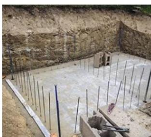
Les eaux usées sont envoyées dans un poste d'injection, puis réexpédiées par séquences dans le bassin de traitement constitué de blocs à bancher. Un caillebotis en bois, sans aucun système d'aération émergeant, coiffe l'ensemble et assure une intégration paysagère discrète.
