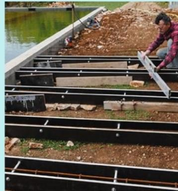
**4** Disposez les coffrages à intervalle régulier. Après coulage, les tubes PVC resteront noyés dans le béton, tandis que les écrous et les tiges filetées pourront être réutilisés.
