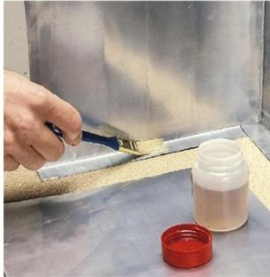
**4/** Avant l'assemblage des éléments en zinc par brasage, préparez les zones à souder. Nettoyez-les soigneusement avec du produit décapant appliqué au pinceau plat.
