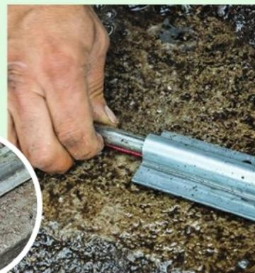
**19** Fixez le premier tronçon de rail avec des chevilles à frapper. Enfilez une éclisse tubulaire dans le suivant et assemblez-le au précédent. Ne chevillez pas sans vérifier l'alignement.
