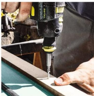
**4/** Bridez une latte au dos du volet à l'aide de deux serre-joints. Fixez-la avec quelques vis en inox réparties sur la longueur, mais à l'écart des extrémités à cause des chapiteaux.
