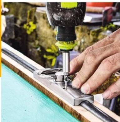
**5/** Engagez les ergots de la crémonne aux extrémités des tringles (la plus longue vers le haut). Vissez le boîtier de la crémonne à travers la latte jusque dans le volet lui-même.
