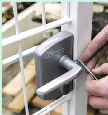
**20** Installez la béquille sur la serrure et réglez l'écartement et l'aplomb du portillon au niveau de la gâche à l'aide d'un mètre et d'une clé plate.
