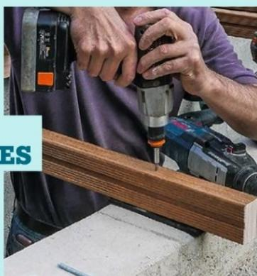
**14** Vissez les lambourdes reliant les petits côtés de la piscine et les murets supports. Côté piscine, les extrémités des lambourdes reposent sur un chevron vissé contre la paroi en béton.
