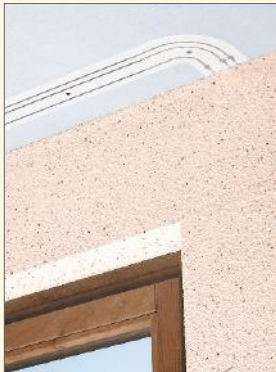
2 Die gleiche Schiene im Putz.
