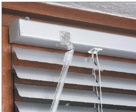
Der Acrylstab wird nur lose in die Lasche des Schneckengetriebes für die Lamellenverstellung eingehängt.
