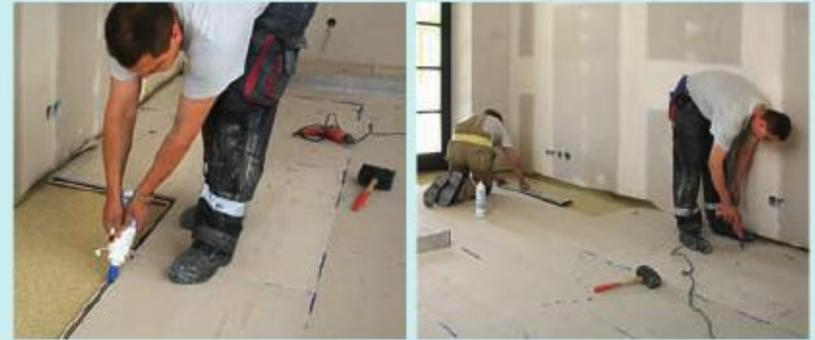
**Schritt 2:** Die einzelnen Estrichelemente werden miteinander verklebt (hier mit „Knauf Brio Falzkleber“ in zwei Klebeschnüren).
