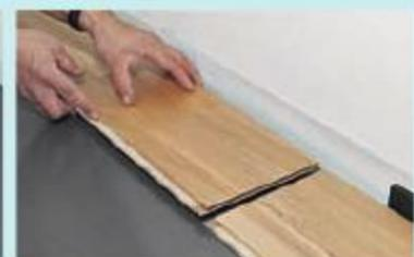
**Schritt 3:** Weitere Elemente der ersten Reihe sind an den Kopfenden von oben in die vorherige Diele einzuklicken. Ein kurzer Druck und die Diele rastet ein.
