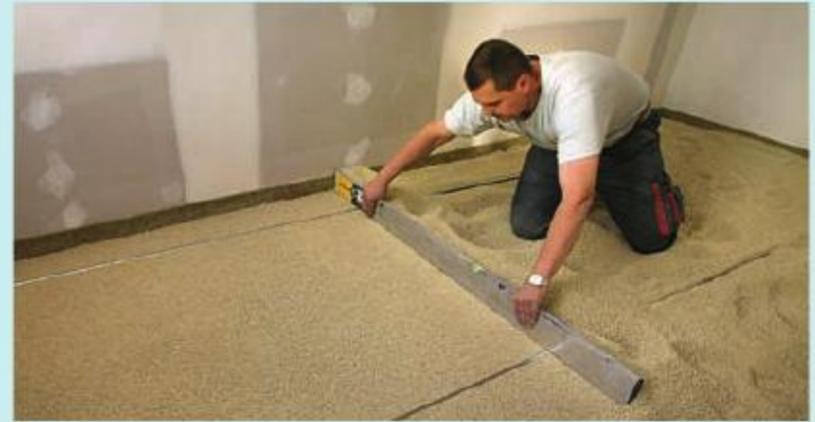
**Schritt 1:** „Knauf Trockenschüttung PA“ wird mit der Abziehlatte eingebaut. Nach Ausrichten der Auflageleisten wird die Schüttung abgezogen.
