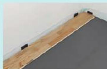
**Schritt 2:** In der rechten Raumecke beginnend werden die Elemente mit der Federseite zur Wand verlegt und mit Abstandskeilen fixiert.
