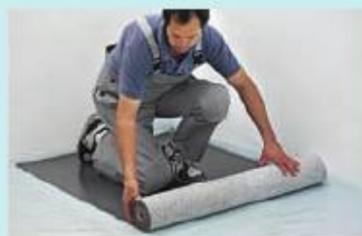
**Schritt 1:** Zur Trittschalldämmung und zum Ausgleich kleiner Unebenheiten wird eine zwei Millimeter dicke Korkdämmunterlage ausgerollt.
