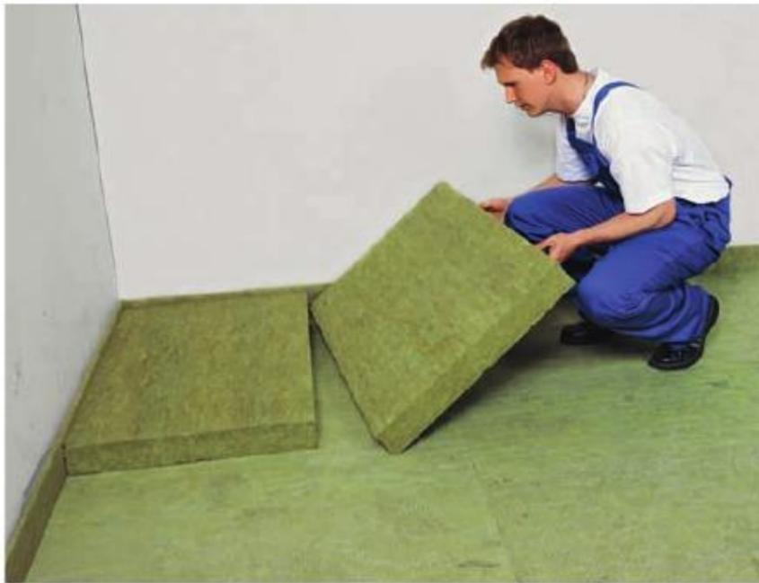
**Schalldämmend:** Decken zwischen fremden Wohn- und Arbeitsbereichen müssen die Anforderungen an den Trittschallschutz erfüllen. Das Federungsvermögen eines Dämmstoffes beeinflusst hierbei die Trittschalldämmung in hohem Maße. Schwimmende Estriche mit weich federnden Trittschalldämmplatten schützen vor störender Schallübertragung bei Decken und Böden. *Rockwool*
