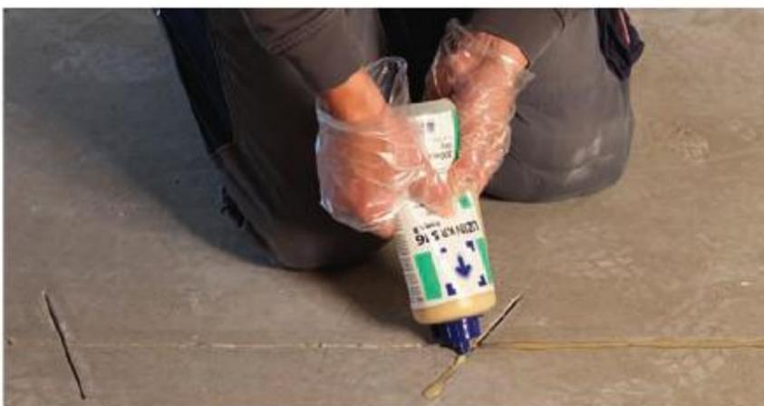
**Leicht beseitigt:** Risse im Estrich lassen sich mit dem Zweikomponenten-Silikatharz „Uzin KR 516“ sanieren. Das lösemittelfreie Silikatharz lässt sich durch einfaches Schütteln leicht mischen und ist bereits nach 15 Sekunden einsatzbereit. Das Harz ist geruchsarm während und nach der Verarbeitung und somit im laufenden Betrieb einsetzbar. *Uzin Utz*
