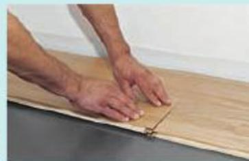
**Schritt 6:** Anschließend wird die Diele stirnseitig abgesenkt. Beachten Sie dabei, dass das Element stirnseitig bündig an das zuvor verlegte anstößt.
