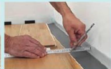
**Schritt 7:** Die Elemente der letzten Reihe werden an der Längsseite unter Berücksichtigung eines Dehnungsabstandes zugeschnitten.
