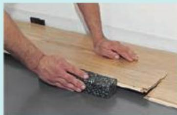
**Schritt 5:** Bei Bedarf mit Schlagklotz leicht nachklopfen.
