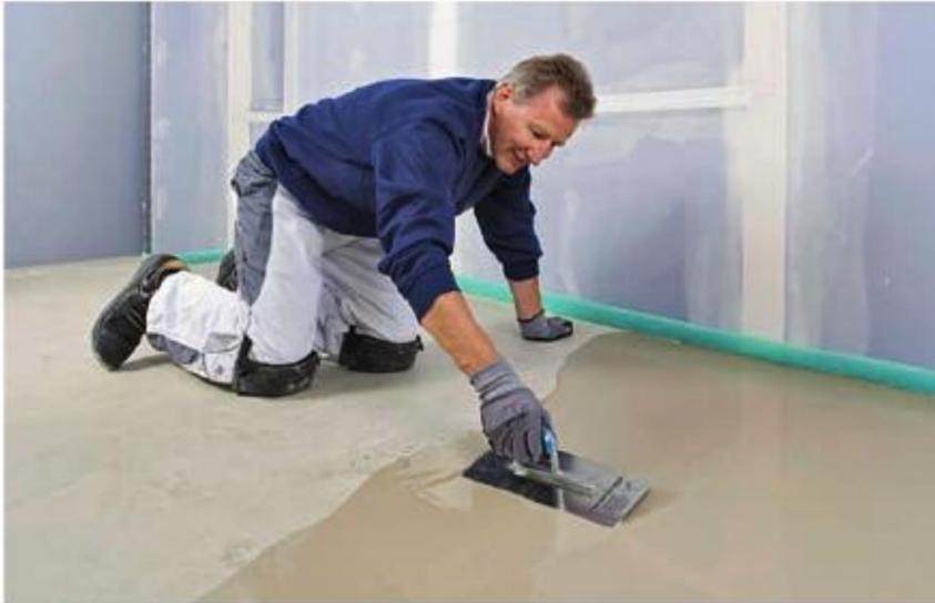
**Ausgleichende Basis:** Speziell in Altbauten ist es notwendig zunächst die Fläche auf dem Rohboden oder Estrich zu spachteln oder zu glätten, bevor der neue Belag aufgebracht wird. Die Feinspachtel- und Nivelliermasse „Knauf Alphadur 430“ ist eine selbstverlaufende Spachtelmasse und kann in einer Höhe von 0 bis 30 Millimeter aufgebracht werden. Die Spachtelmasse auf Gipsbasis ist bereits nach etwa drei Stunden begehbar. *Knauf Gips*
