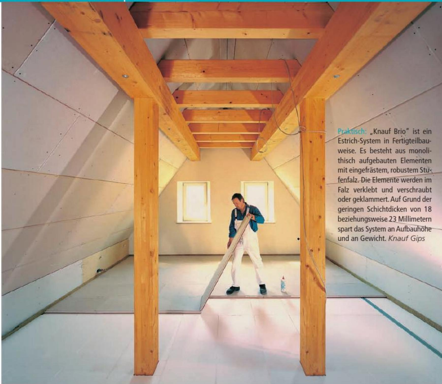
**Praktisch:** „Knauf Brio“ ist ein Estrich-System in Fertigteilbauweise. Es besteht aus monolithisch aufgebauten Elementen mit eingefrästem, robustem Stufenfalz. Die Elemente werden im Falz verklebt und verschraubt oder geklammert. Auf Grund der geringen Schichtdicken von 18 beziehungsweise 23 Millimetern spart das System an Aufbauhöhe und an Gewicht. *Knauf Gips*
