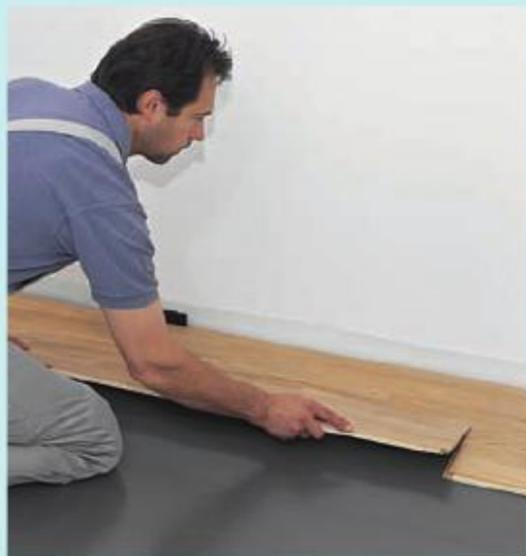
**Schritt 4:** Mit dem Reststück der ersten Reihe wird in der nächsten begonnen. Dadurch wird der Verschnitt erheblich reduziert. Die weitere Verlegung erfolgt elementweise.
