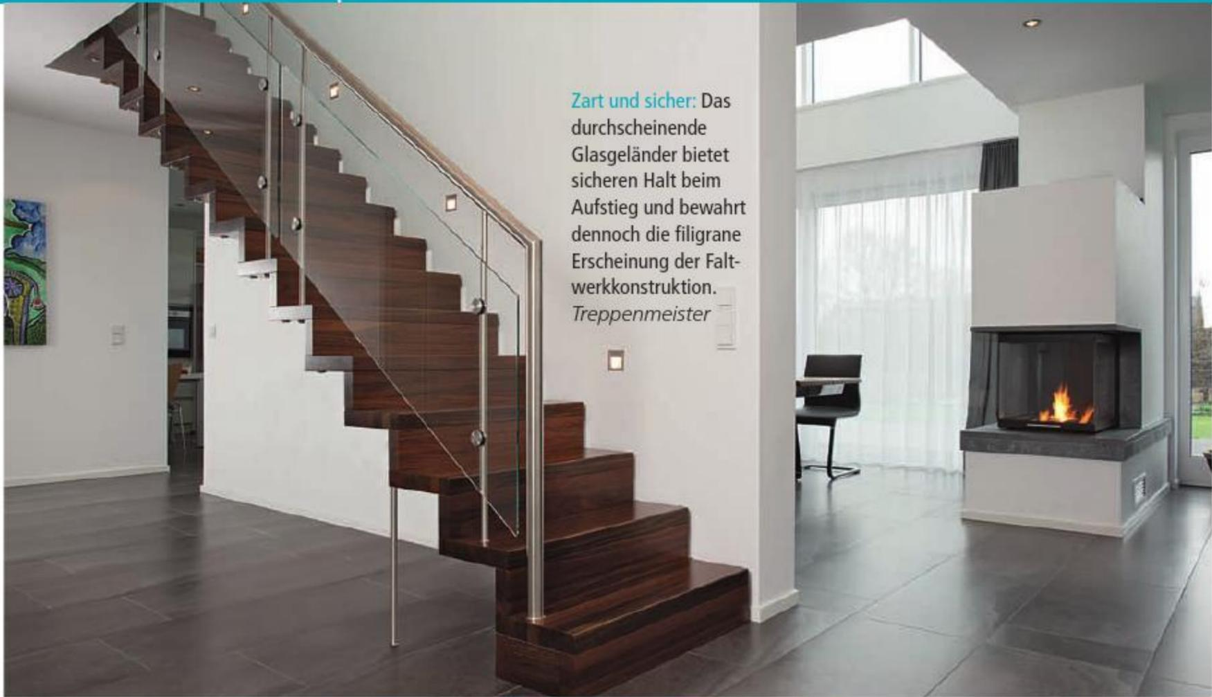
**Zart und sicher:** Das durchscheinende Glasgeländer bietet sicheren Halt beim Aufstieg und bewahrt dennoch die filigrane Erscheinung der Faltwerkstruktur.
