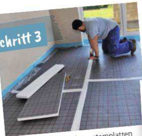
Verlegung der Zusatzdämmung
