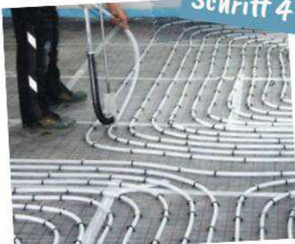
Heizrohrverlegung in Schneckenform
