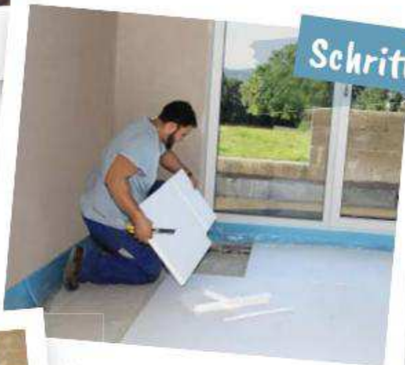
Verlegung der Zusatzdämmung
