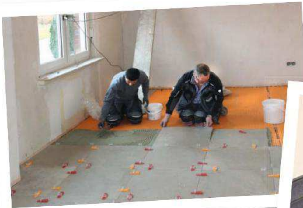
Direkt nach Begehrbarkeit des Estrichs wird die Entkopplungsmatte verklebt, auf der am Ende die Fliesen kommen.
