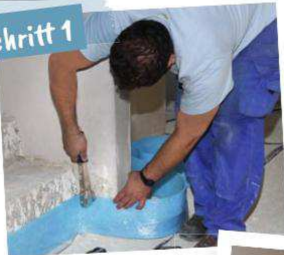
Befestigung des Randdämmstreifens
