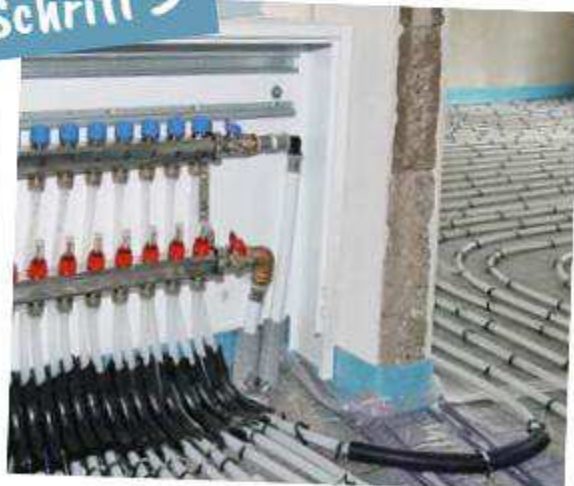
Durchführung der abschließenden Druckprobe
