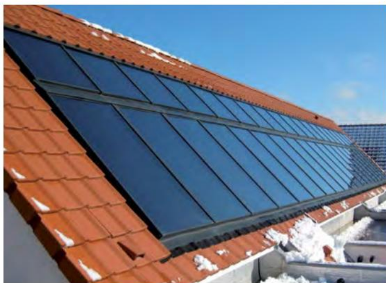
Eine intelligente Absorberschicht schützt hier die Kollektoren vor (sommerlicher) Überhitzung: Bei Erreichen einer bestimmten Temperatur schaltet sie die Sonnenkollektoren ab. www.viessmann.de
