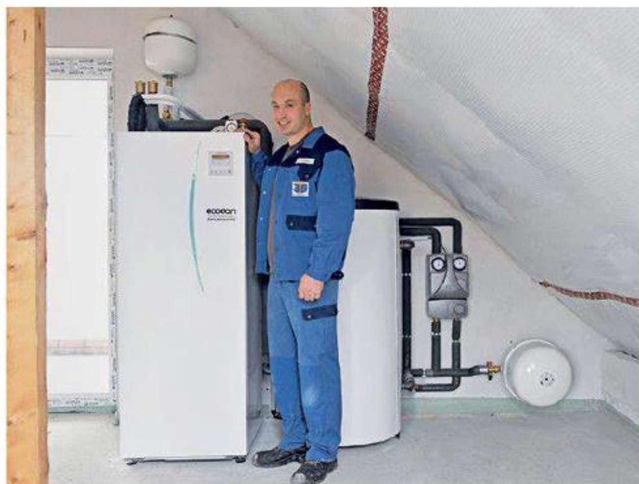
Weniger Platz im Freien benötigen Luft-Wärmepumpen in Splitbauweise. Das System „Ecodan“ mit „Zubadan“-Technologie liefert auch bei Temperaturen von -15 Grad noch 100 Prozent Leistung. (Mitsubishi Electric)
