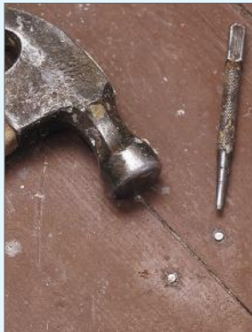
2 Vor dem Abschleifen müssen alle Nagelköpfe mindestens zwei Millimeter tief versenkt werden.
