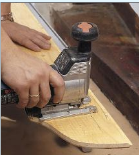
2 Mithilfe einer Schablone wird die Kontur der ersten Auftrittsfläche auf eine Fertigparkettdiele übertragen und mit einer Stichsäge ausgeschnitten.
