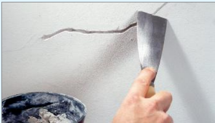
7 Aufgefüllt werden sie anschließend mit einem kunststoffvergüteten Gipsputz.
