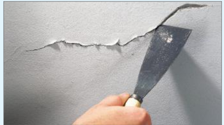
6 Löcher und Risse kratzt man mit der Kante eines Spachtels aus.
