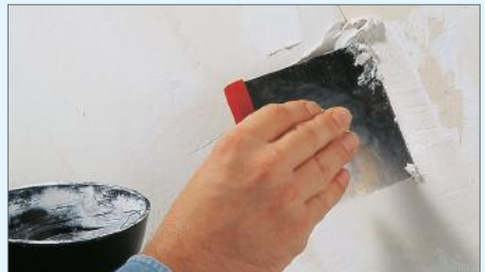
8 Größere Unebenheiten und Löcher lassen sich sehr gut mit einem breiten Japanspachtel glätten.
