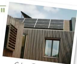
Solar PV array
