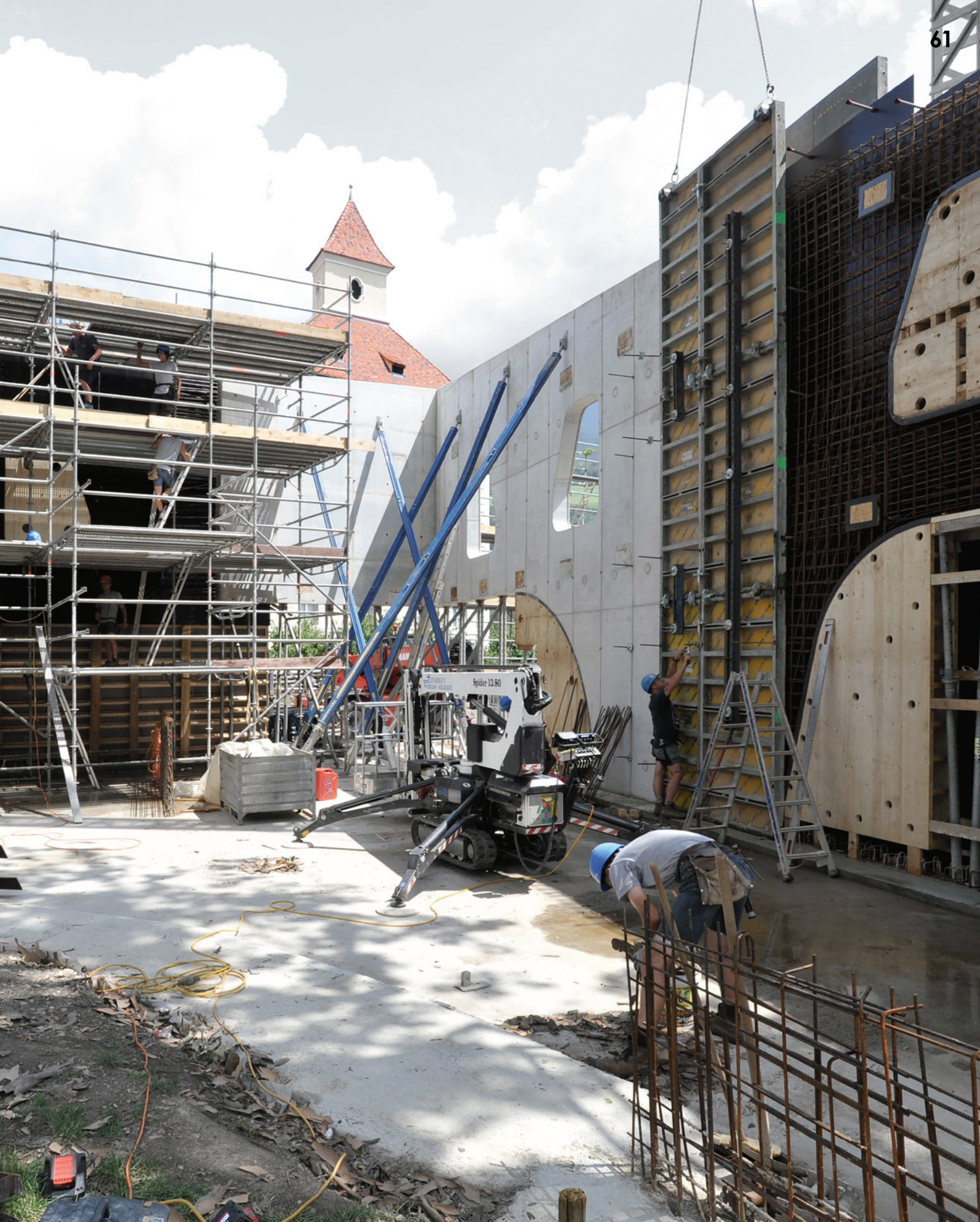
Holz hier in dienender Funktion: für die Schalungen der geschwungenen Formen des Sichtbetonpavillons
