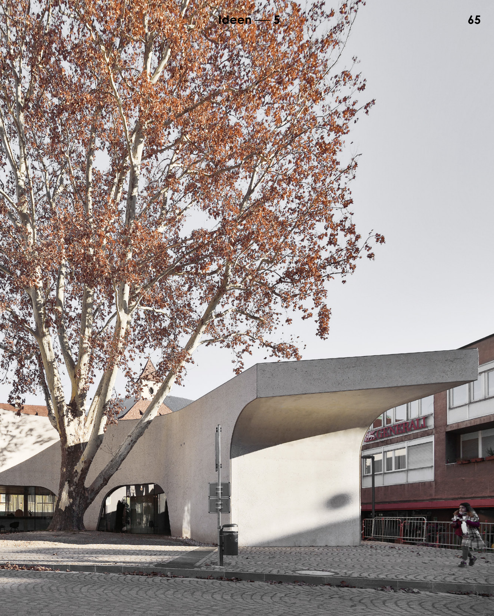
Als „Treehugger“ umfasst der neue Pavillon für die Touristeninformation die große, alte Platane.
