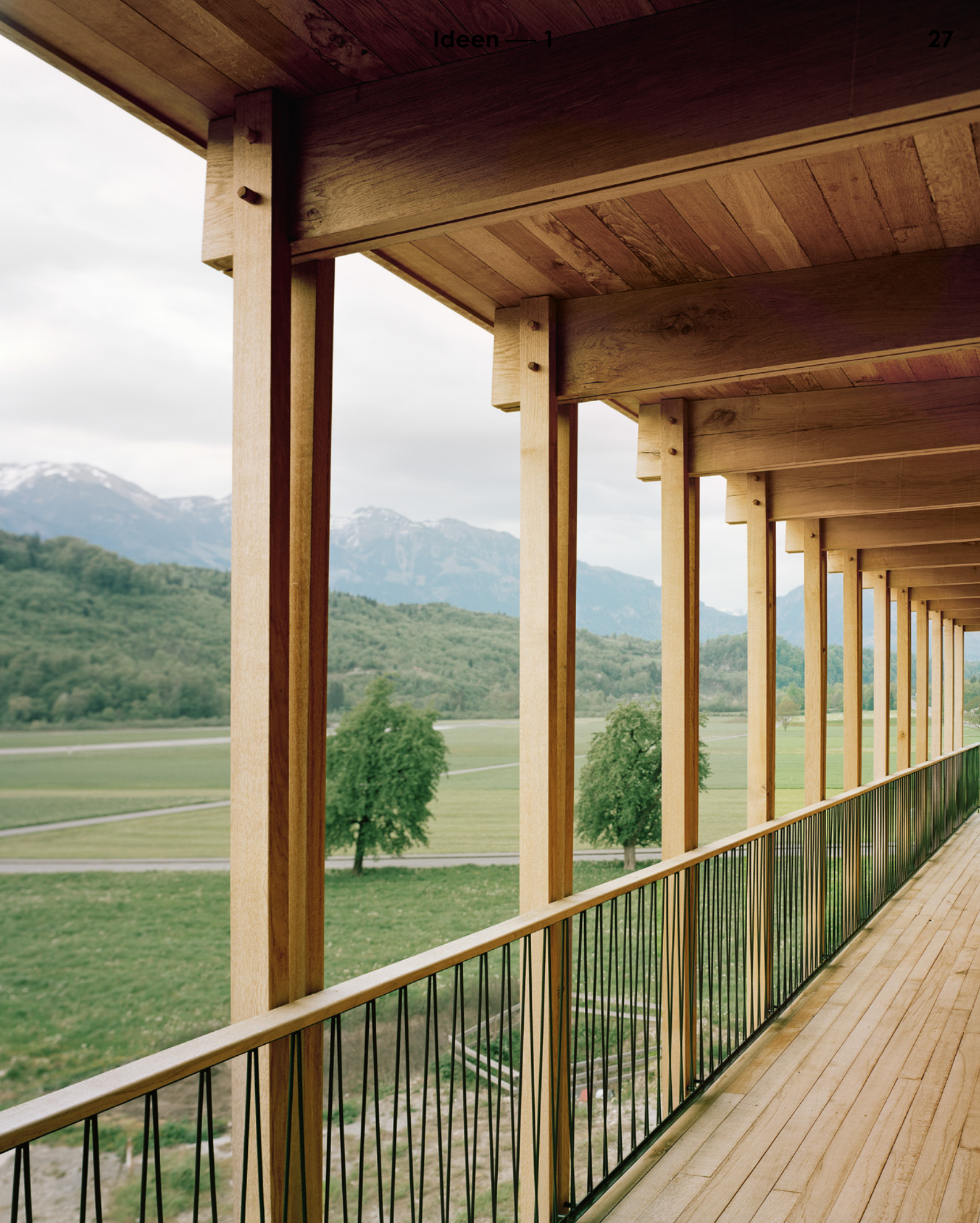
Die Konstruktion der umlaufenden abgehängten Lauben besteht aus Gründen des Witterungsschutzes aus Eichenholz.
