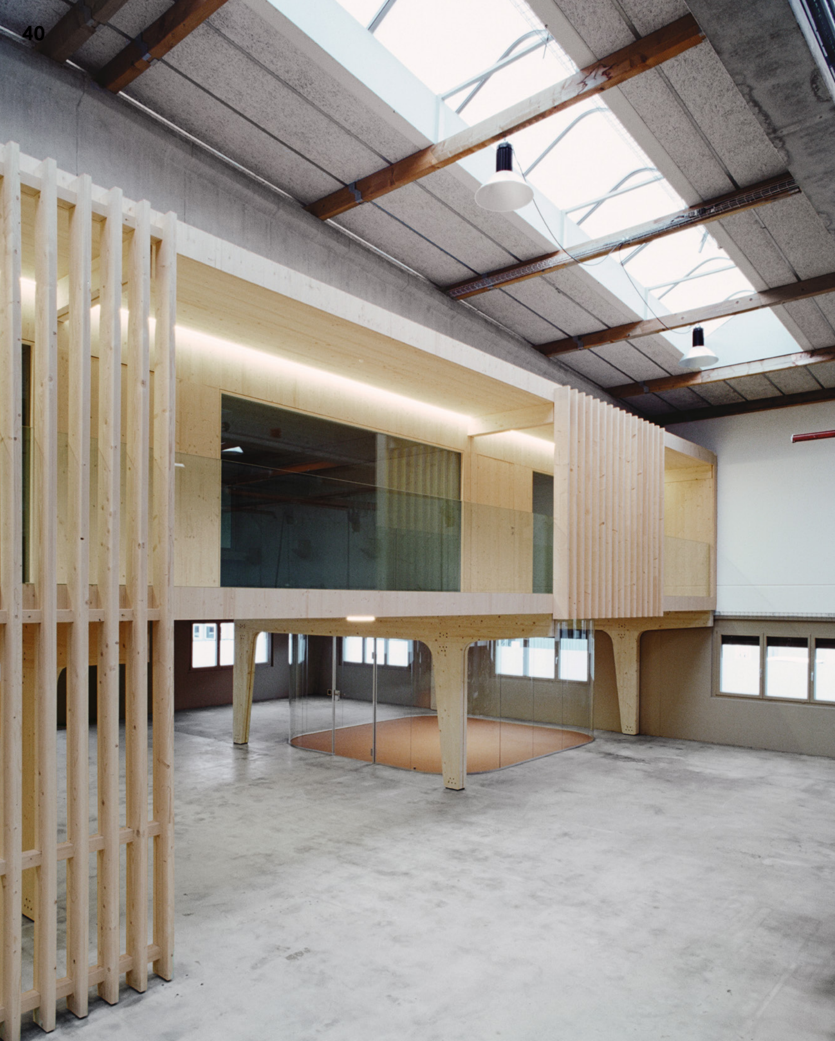
Spiel der Elemente: Massivholzdecken, Sichtschutzlamellen, filigrane Stützen und die „Glaszylinder“ als Besprechungsräume
