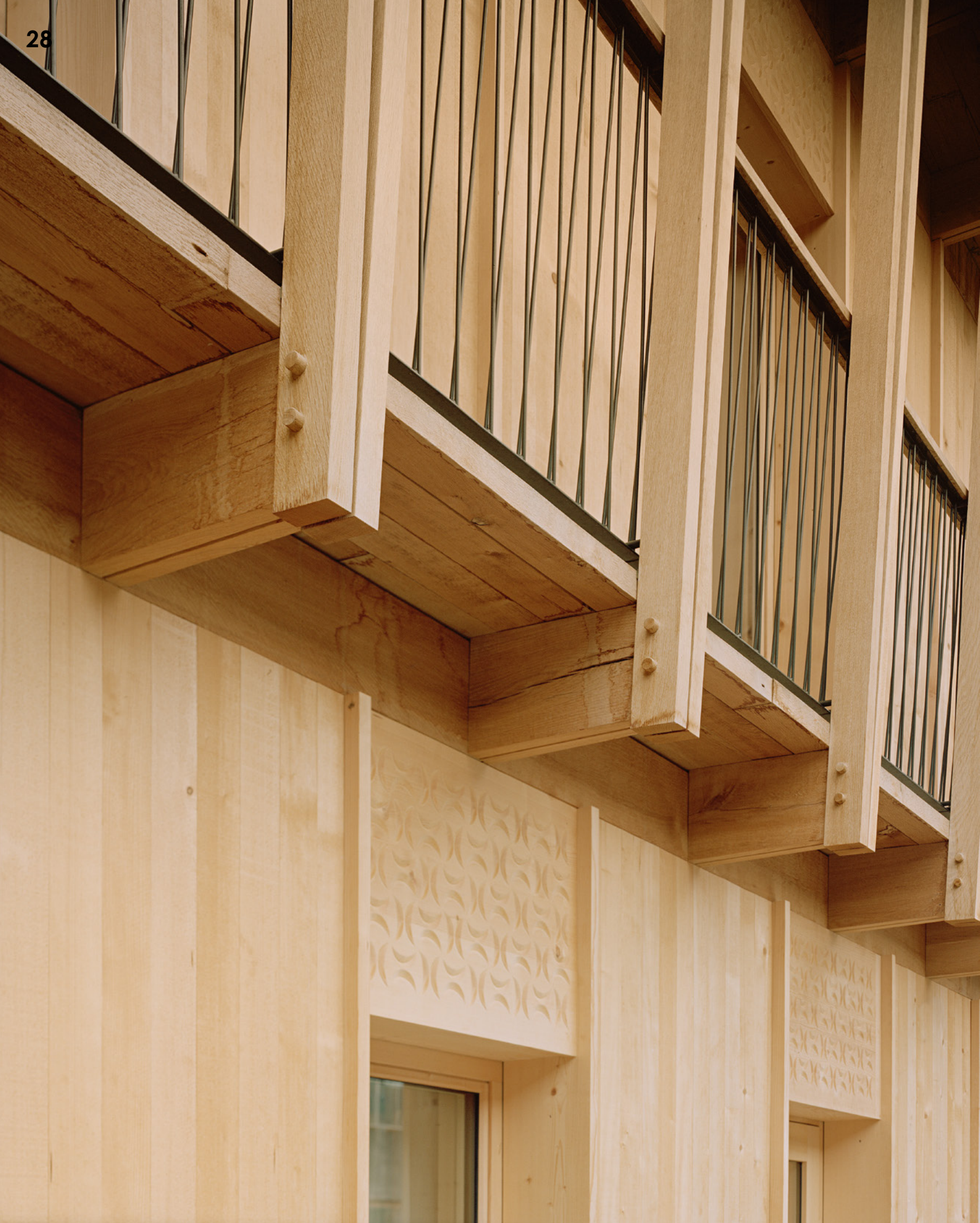
In die Platten über den Fassadenöffnungen sind ornamentale Mondmotive eingegräst, die auf das Mondholz verweisen.
