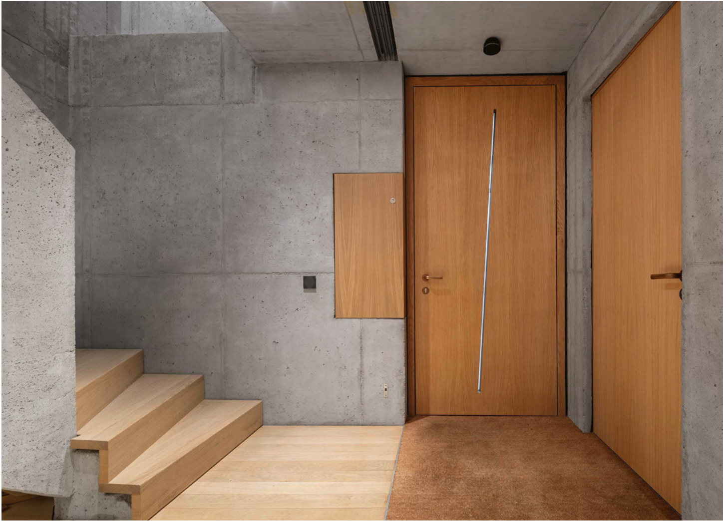
Zu den sorgfältig ausgeführten Sichtbetonflächen und dem hochwertigen Eichenholzausbau passt der Hans-Poelzig-Entwurf aus Bronze für die Türdrücker.
