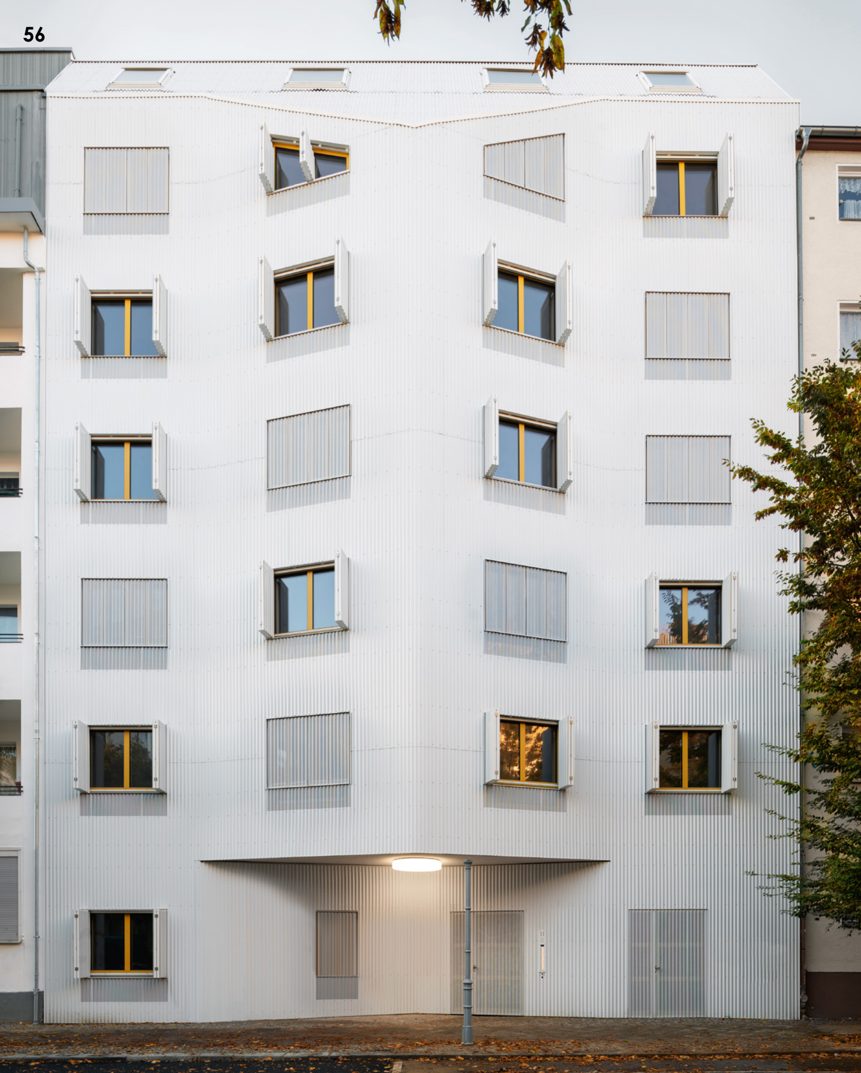
Straßenfassade mit geöffneten Klappläden. Das Aluminiumblech an deren Außenseiten ist perforiert, so fällt Tageslicht auch im geschlossenen Zustand herein.
