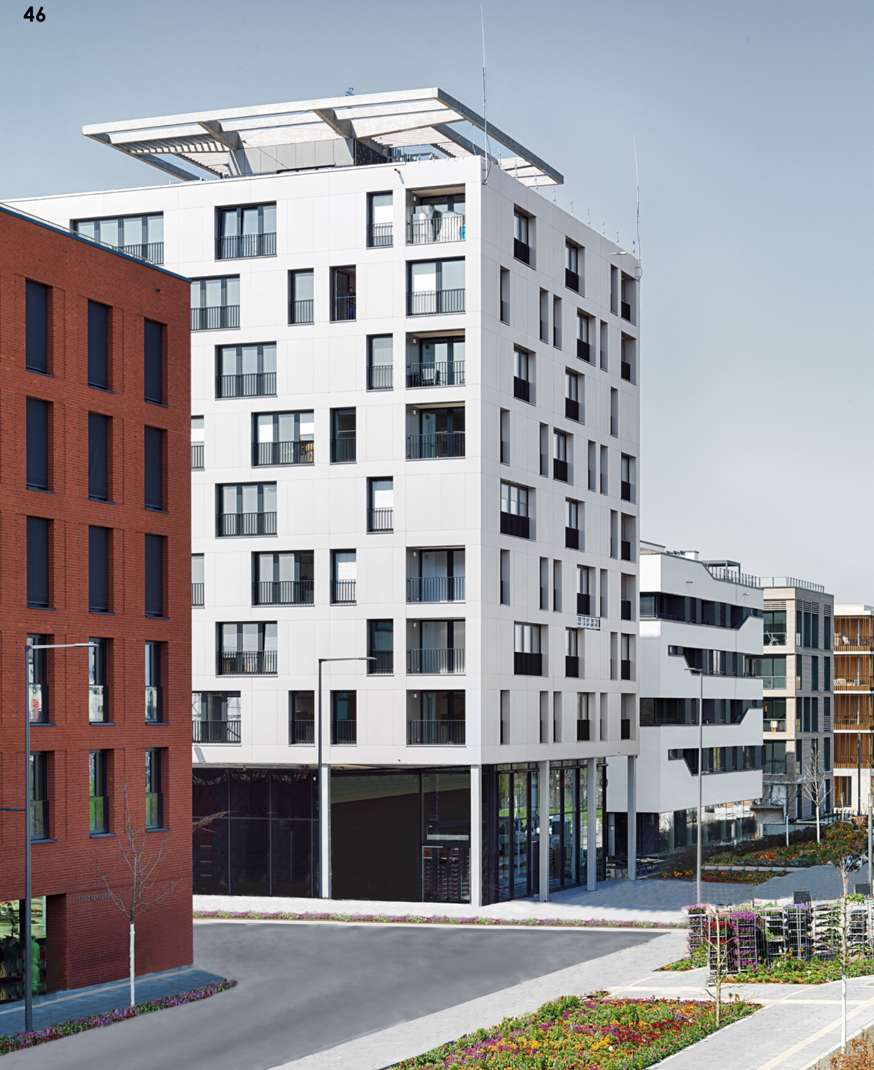
Der zehngeschossige Turm ist mit seiner Metallverkleidung nicht gleich als Holzbau zu erkennen.
