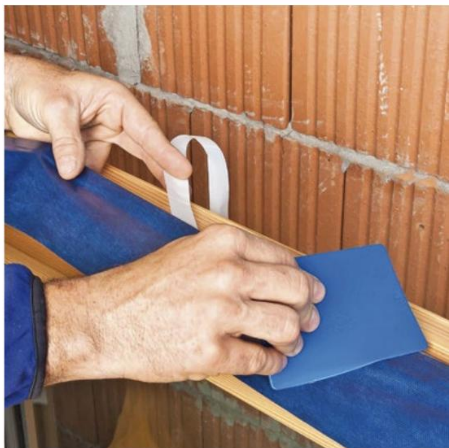
Vorbereitung des Fensterrahmens vor dem Einbau: Das feuchtevariable Anschlussband wird sowohl innen als auch außen umlaufend auf dem Blendrahmen lückenlos verklebt. Es wirkt innen dampfbremsend und luftdicht, außen schützt es zuverlässig vor Wind und Schlagregen.
