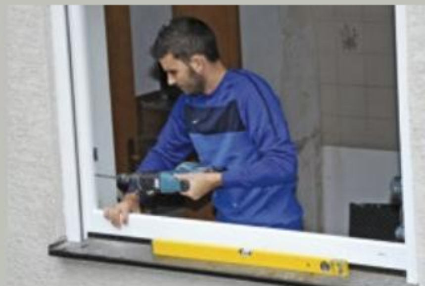
7. ... die Fensterbauer die Rahmen so fest, dass die bestehenden Außensimse perfekt anschließen konnten. Auf deren Tausch hat man verzichtet.
