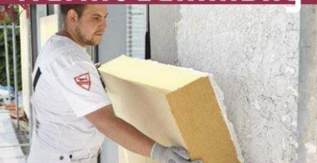
Fassadendämmung mit Holzfasern
