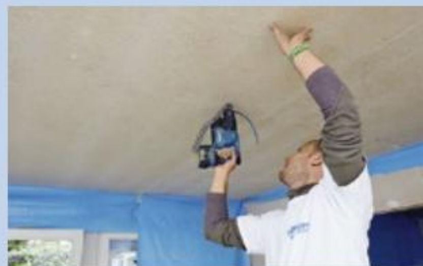
10. Die vorhandenen OSB-Platten an den Decken wurden komplett mit den Activ'Air-Gipsfaserplatten überdeckt.
