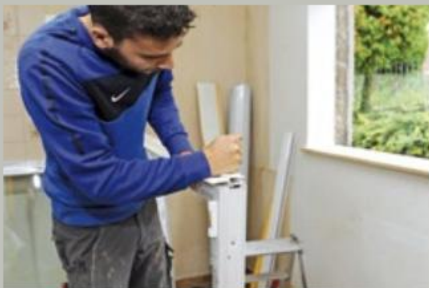
5. Hier werden noch seitlich die beiden Rollladenführungsleisten aufgedrückt. Als Rollladen wählte man hier ebenfalls welche aus Kunststoff.
