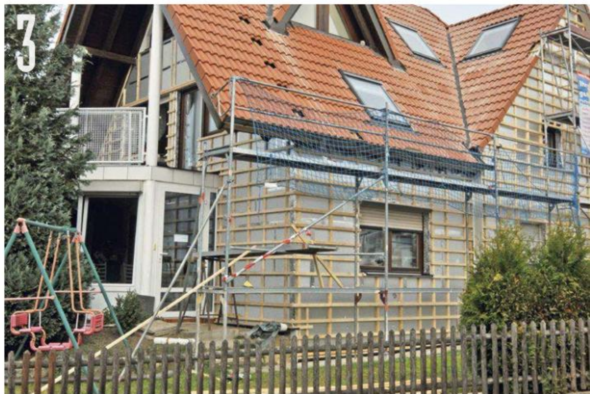
Die Dämmplatten werden lediglich mit Konterlatten mechanisch an der Wand befestigt und gegebenenfalls zusätzlich mit einem Spachtelkleber (z. B. Schwenk Sk-Leicht) an der Bestandsaußenwand fixiert. So entsteht eine homogene, luftdichte Dämmschicht, die sofort bereit ist für die Aufnahme der Wetterschutz-Bekleidung.
