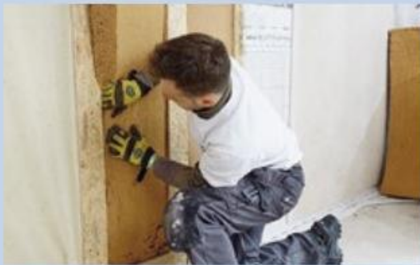
5. Bei der Dämmung der Außenwände setzte man auf eine diffusionsoffene Dämmung aus Holzfaserplatten.
