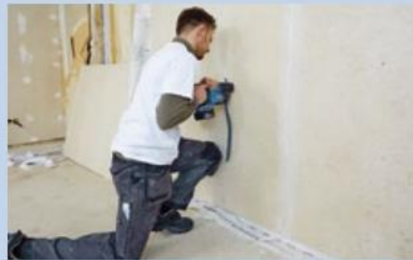
7. Alle Außenwände erhielten eine innenseitige Beplankung aus Rigidur H Activ'Air-Gipsfaserplatten, ebenso alle Trennwände.
