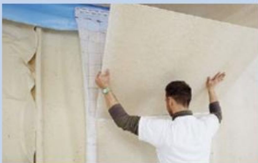
8. Die robusten Rigidur H Activ'Air-Gipsfaserplatten sorgen mit ihrem Wirkkomplex dafür, dass Schadstoffe wie Formaldehyd ...
