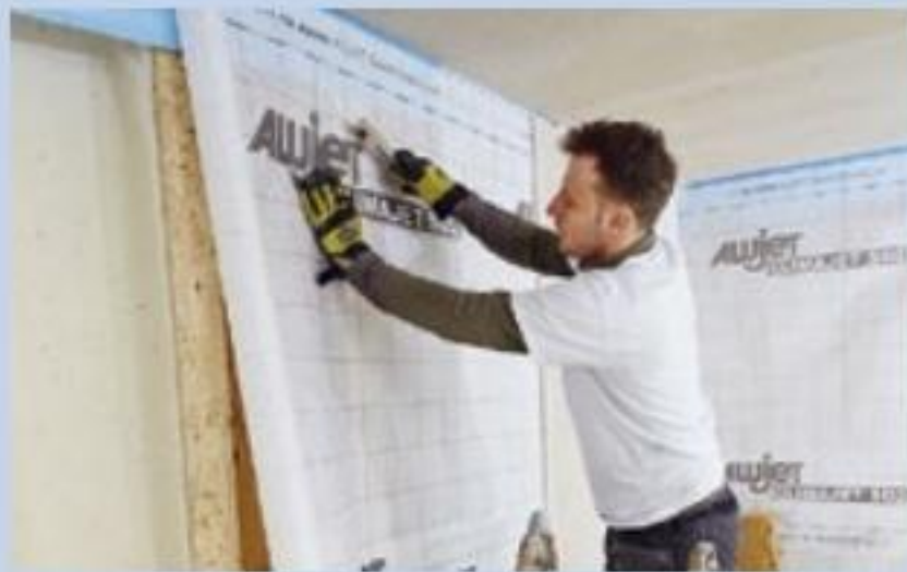
6. Über diese wurde abschließend eine feuchtigkeitsregulierende Dampfbremse aus hochreißfestem Vlies verlegt.
