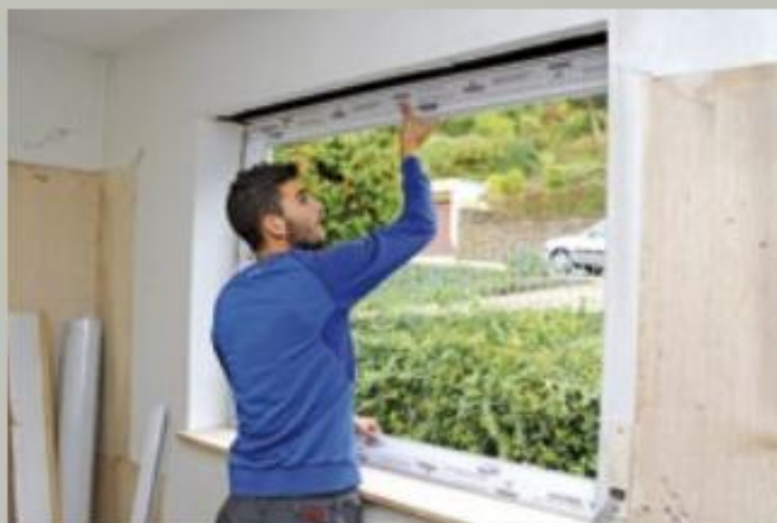
6. Die neuen weißen Kunststoffrahmen passten dann exakt in die Öffnung. Sogar die Innensimse konnten bleiben. Nach dem Ausrichten setzten ...
