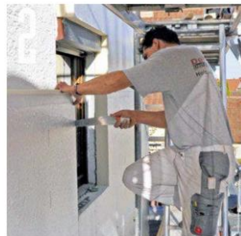
Die einfache Bearbeitbarkeit des Hartschaums – z. B. beim Zuschnitt an Fensterlaibungen – ist ein weiterer Vorteil bei der Fassadensanierung.
