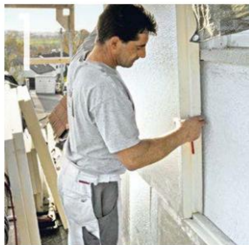
Die leichten und mit Nut und Feder ausgestatteten Dämmplatten bilden eine oberflächenfeste und wärmebrückenfreie Dämmschale vor der Altfassade.
