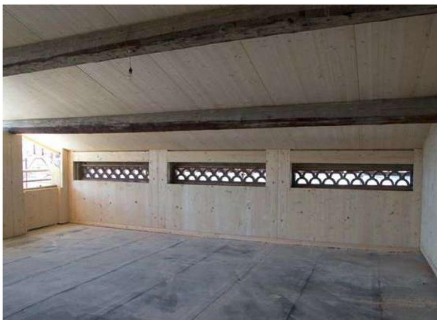
Die Außenwände der Altane wurden mit Massivholz-Wandelementen eingefasst und damit statisch stabilisiert.
