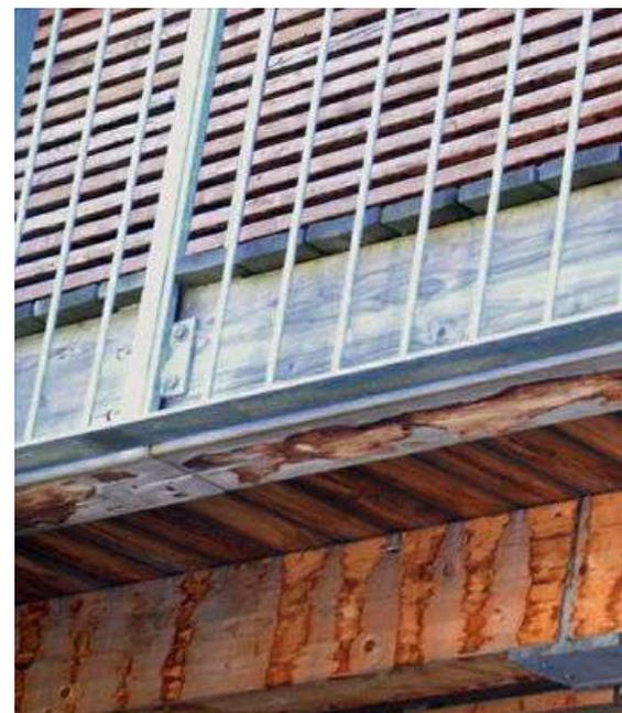
Wasserspuren von der Balkonoberfläche verunstalten die Balkonuntersicht.
