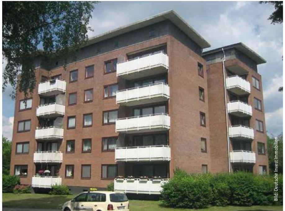
So sahen die Bestandsbauten vor der Aufstockung aus. Es waren Fünfgeschosser mit einer Flachdachkonstruktion.
