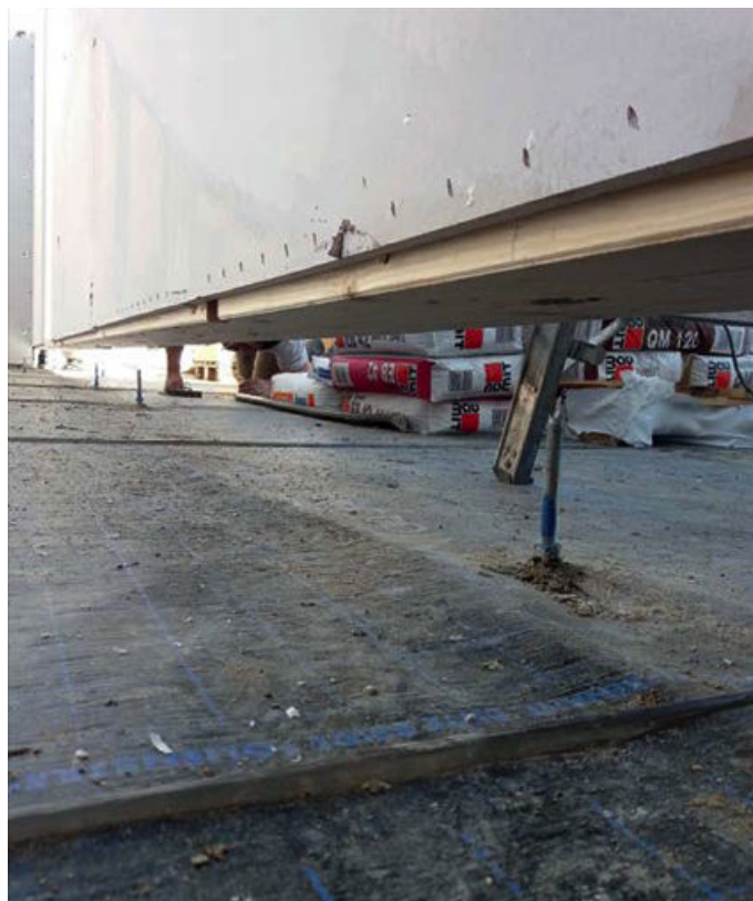
Die Wand gleitet in die vorher eingebauten Schraubbolzen. Damit sitzt sie unmittelbar nach dem Versetzen kraftschlüssig, höhenfertig und auch liniengerade in ihrer Endposition.
