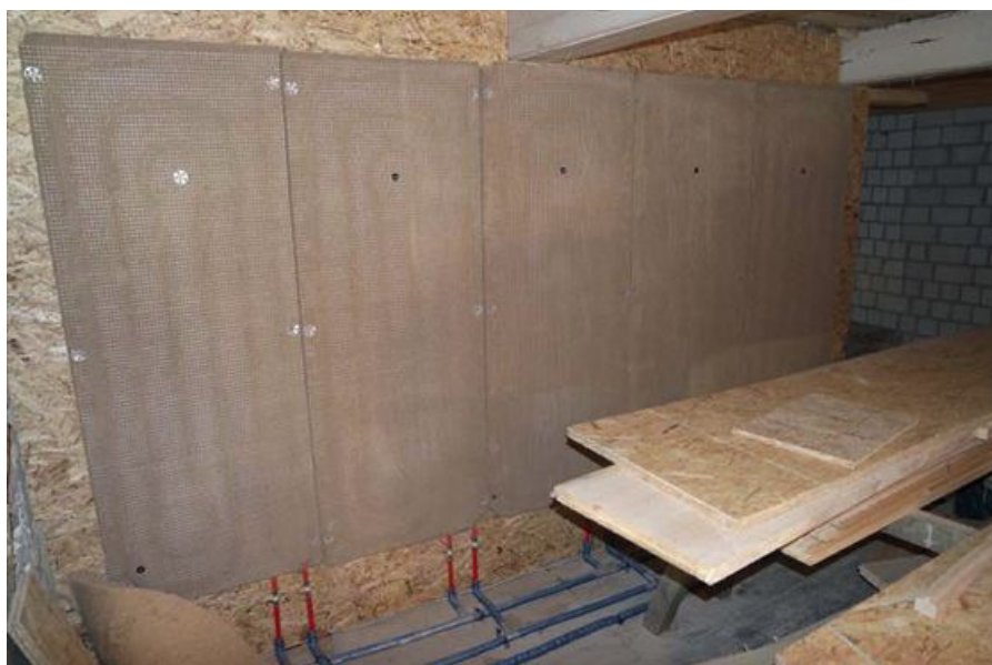
Wandflächenheizungen sorgen künftig für wohlige Wärme und sollen außerdem die Wände trocken- und den Hausschwamm fernhalten.
