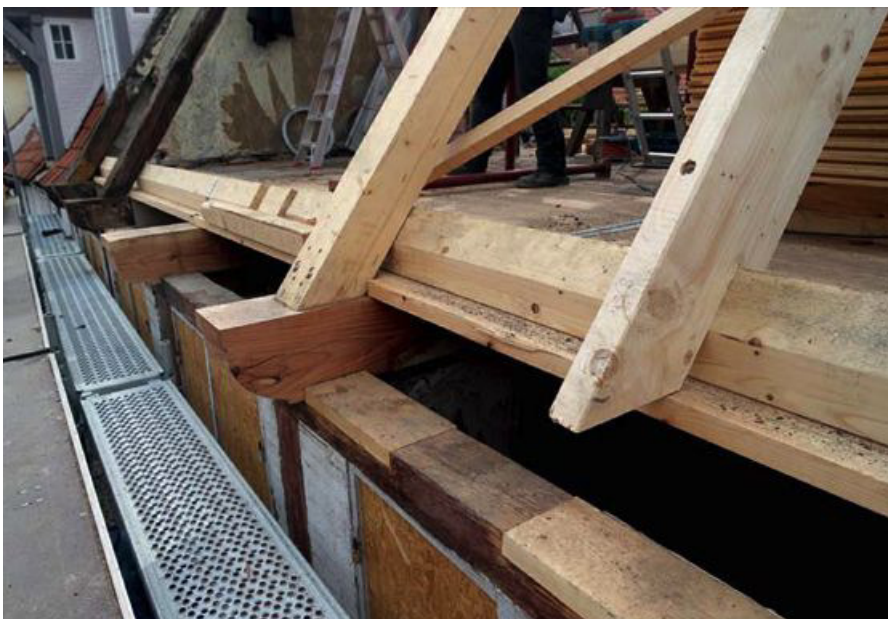
Auch das Dachgebälk wurde mit vielen neuen Bauteilen und denkmalgerechten Reparaturverbindungen instandgesetzt.
