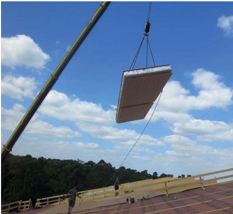
Die mittels Kran eingehobenen, in Gänze vorgefertigten Hohlkastenelemente mit innenseitigen Akustikleisten bringen im Verbund eine statisch wirksame Dachscheibe hervor.
