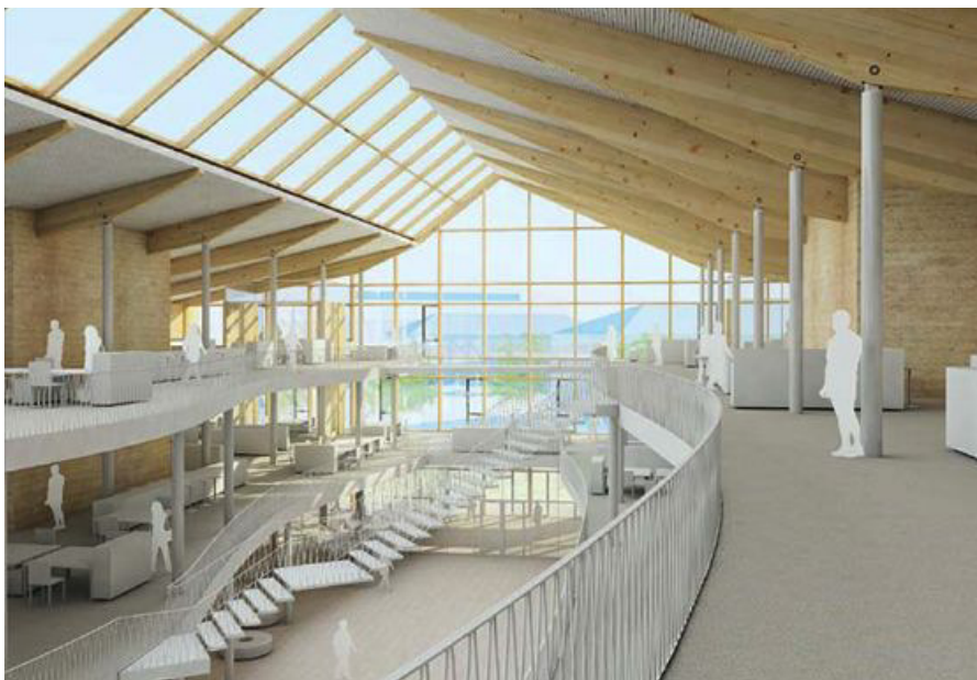
Weite, Licht und Offenheit kennzeichnen die neue Alnatura-Zentrale, die von einem sichtbaren BSH-Dachtragwerk mit Oberlichtband abgeschlossen wird.
