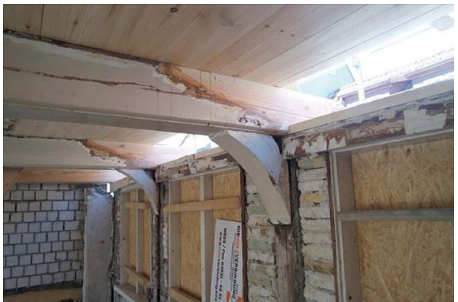
Es sollte möglichst viel der historischen Bausubstanz erhalten bleiben. Daher waren zimmermannsmäßige Reparaturverbindungen das Mittel der Wahl.
