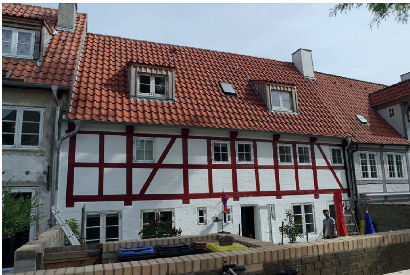
Auf der rückwärtigen Südseite wurden neue Dachgauben aufgesetzt. Das Dach wurde komplett energetisch ertüchtigt und neu gedeckt.
