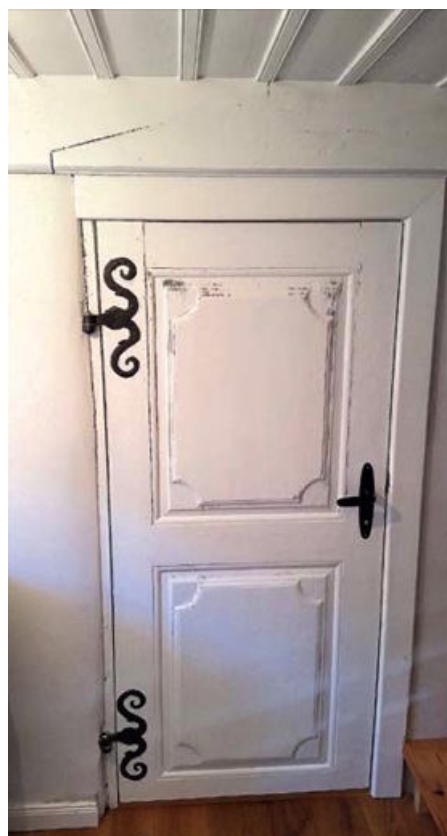
Historische Elemente wie Türen oder auch Fenster wurden aufgearbeitet und wieder eingebaut.
