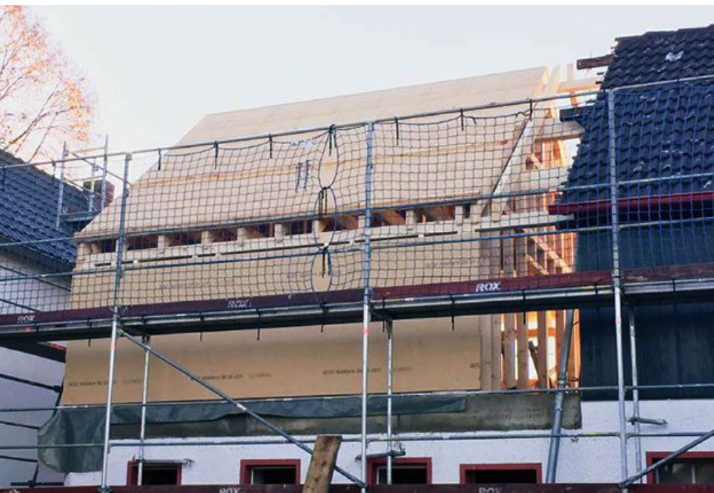
Abb. 1: Bei dieser Aufstockung wird die gewählte Holzfaserdämmplatte sowohl für die Aufdach- als auch für die Fassadendämmung eingesetzt.
