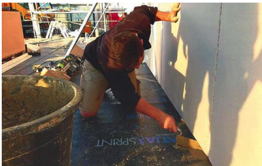
Ausgemörtelt wird zwischendurch, beispielsweise in Kranpausen.
