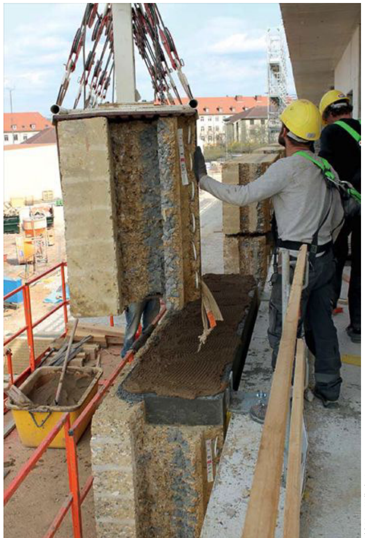
Die Gebäudehülle besteht einzig aus den aufeinandergesetzten und mit einem Lehmmörtel verbundenen Stampflehmelementen.
