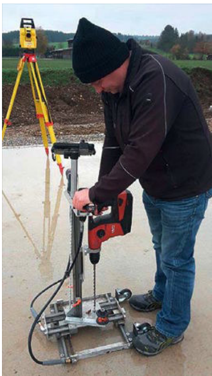
Eingemessen werden die Schraubbolzen mittels eines elektronischen, motorisierten Tachymeters im Einpersonenbetrieb. Der Bohrständer ist mit Controllerpad und Bohrhammer ausgestattet. Zwei handliche Akkuschauber mit flexiblen Wellen ermöglichen das millimetergenaue Justieren des Bohrers.
