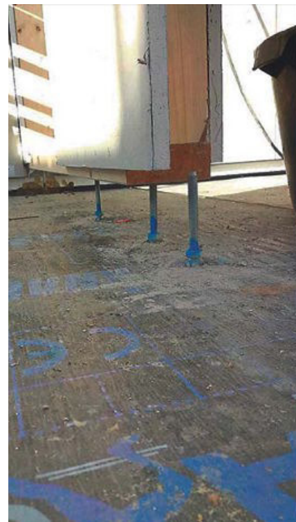
Die Mutter auf dem Schraubbolzen wird in der Höhe genau ausgerichtet. So sitzen die Wände unmittelbar nach dem Versetzen in der richtigen Höhe.
