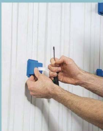
5. ... und mit Hilfe eines Schraubendrehers in der vordersten Öffnung des Zips dasselbe fest anziehen, bis es an seiner ersten Sollbruchstelle abreißt.
