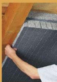
Zwischensparrendämmung mit flexibler Glaswolle. www.fmi-mineralwolle.de
