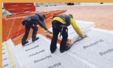
Aufsparrendämmung mit Polyurethan-Elementen und Alu-/Spezialbahn. www.bauder.de
