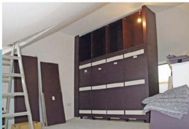
Der Aufsatzschrank wird zur Schlafzimmersseite hin geöffnet. Die Türen werden mit griffloser „push2open“-Technik ausgestattet.
