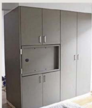
... Deckenanschluss wurde mit Gipsfaser gebaut. Ein Spezialelement nimmt den Flachbildschirm auf.
