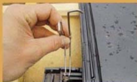
Die Universalsturmklammer II wird in die Kerben geführt und unter die Tragplatte eingeklickt. www.erlus.de
