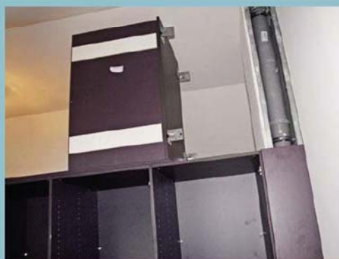
Das ist bei Maßanfertigungen möglich: Der Versorgungsschacht wurde einfach von außen nicht sichtbar in den Schrank integriert.
