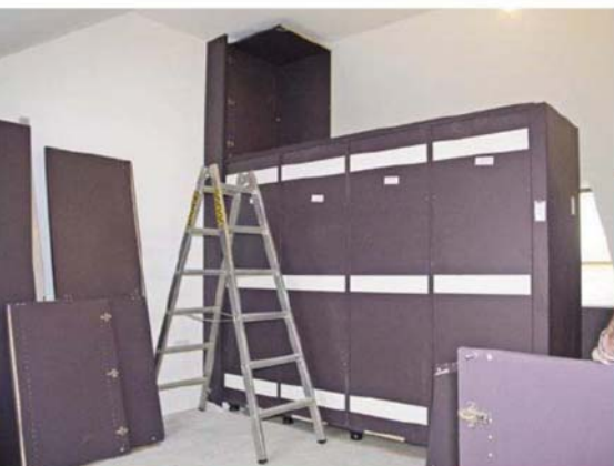
Die Ansicht von der größeren Seite des Raumes. Die Rückseite des Schrankes wird mit Elementen im Korpusdekor verkleidet.
