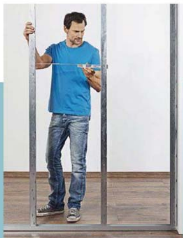
1. Die horizontalen Profile unter Verwendung von Dämmstreifen mit Boden und Wand verschrauben, dann im Abstand von 58 cm die senkrechten Profile einsetzen.
