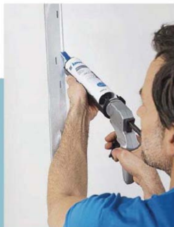
3. Die Spezialtülle der Kleberkartusche an der inneren Profilkante ansetzen und den Kleber gleichmäßig und umlaufend auf die Profile auftragen.
