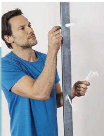
2. Die Zips von hinten nach vorn durch die mittleren Schlitze der CW-Profile führen – ganz unten, ganz oben und dazwischen immer in gleichmäßigen Abständen.
