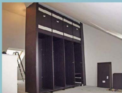
Die Türen des Unterschranks werden zum Ankleidebereich hin geöffnet. Der obere Bereich ist mit fest montierten Platten geschlossen.
