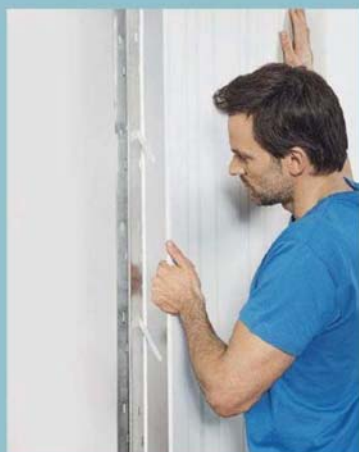
4. Das erste Board an den Profilrahmen ansetzen, ausrichten und das nächste Element bündig ansetzen. Zum Andrücken die Zips von hinten durch die Caps führen ...
