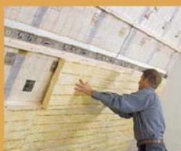
Untersparrenlösung mit querliegenden Zusatzdämmung oder ...
