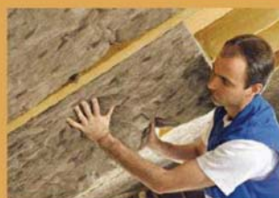
Zwischensparrendämmung mit flexibler Glaswolle. www.fmi-mineralwolle.de
