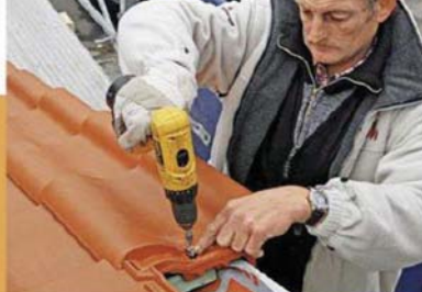
System Sturmfix: Eine Edelstahlklammer wird in gesetzt und verschraubt diesen mit der Lattung. Ziegel wird aufgedrückt und rastet so sicher ein.
