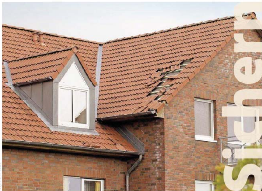
Windangriffe können direkt unter den Ziegeln wirken oder auf der Gegenseite durch Umwirbelungen und Unterdruck. www.wienberger.de
