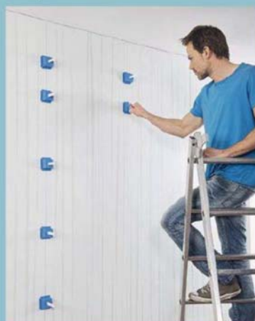
6. Ist eine Wandseite fertig, können Mineralwolleplatten eingesetzt werden. Schließlich nach Trocknung des Klebers an den Zips ziehen, bis sie abreißen.
