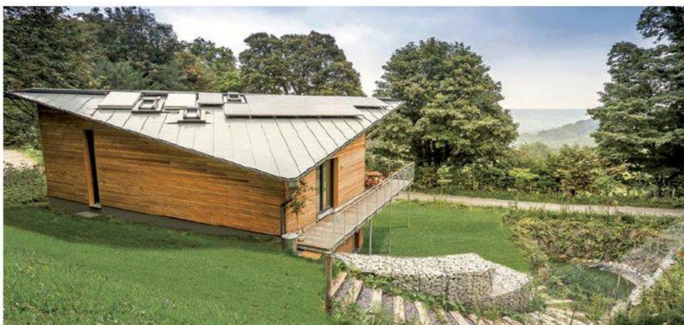
Die Neigung des Daches orientiert sich an den sanften Hügeln der Umgebung. Ergänzt um Photovoltaik- und Solaranlage geben seine ausgefallene Form und eine graue Zinkeindeckung dem Äußeren des Hauses etwas Futuristisches, das die rein naturnahe Wirkung der Lärchenholzfassade ein Stück weit aufhebt. Weite Dachüberstände spenden im Sommer Schatten.
