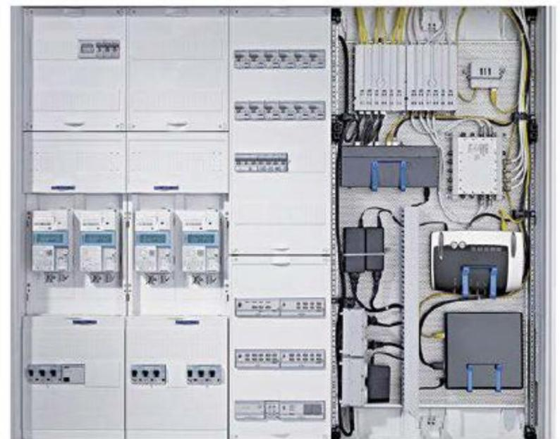
So sieht ein geöffneter Elektroinstallations-Verteilerschrank in einem Haus mit moderner BUS-Installation aus. Neben den Sicherungen für die einzelnen Stromkreise befindet sich hier auch die intelligente Steuerungszentrale der Hausautomation. [www.hager.de](http://www.hager.de)
