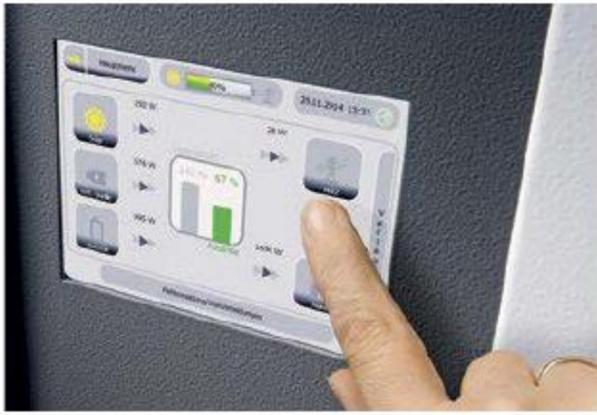
Das Hauskraftwerk der Firma „E3DC“, das auch in Okal-Häusern zum Einsatz kommt, bietet in einem Gehäuse Batteriespeicher und Wechselrichter und fungiert als zentrale Schnittstelle für die Energieverteilung von der Regelung der Photovoltaikanlage bis zur Versorgung des Hausnetzes. Bei Stromausfall wird das Haus automatisch autark weiterversorgt. Ein Touch-Display zeigt Solarleistung, Batterieladezustand und Stromeinspeisung oder -bezug, die Bedienung ist zusätzlich auch per Smartphone möglich.
