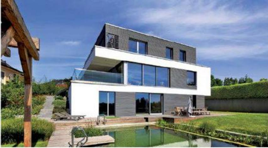
Um Wärmeverluste zu minimieren, wurden an der Nordseite nur wenige Fenster vorgesehen, auf der Südseite öffnet sich das moderne Passivhaus der Familie Kieffer auf allen drei Ebenen mit großen Glasflächen. Sonnenenergie und Abwärme der Haushaltsgeräte reichen dank hohem Dämmstandard der mit Hobelspänen gedämmtem Außenwand aus, um das Haus zu beheizen. Bei Bedarf kann eine Fußbodenheizung zugeschaltet werden. [www.baufritz.com](http://www.baufritz.com)
