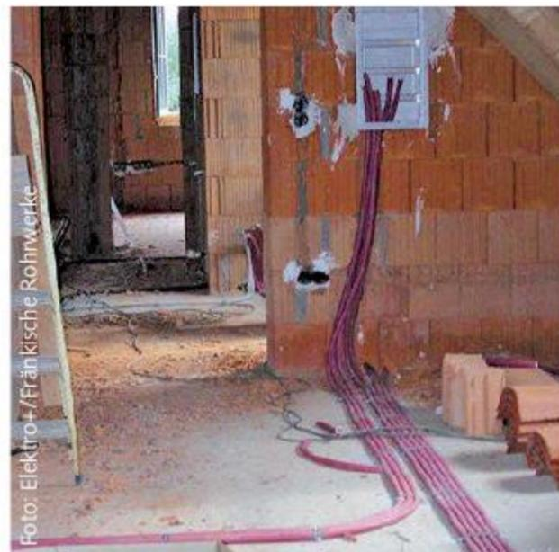
Ähnlich dem Blutkreislauf unseres Körpers durchziehen Elektroinstallationen das ganze Haus. Sehen kann man die Kabelführung nur im Rohbau – sie verschwindet später unter Böden, Wand- und Deckenverkleidungen und wird nur noch durch Schalter oder Wanddisplays offensichtlich.
