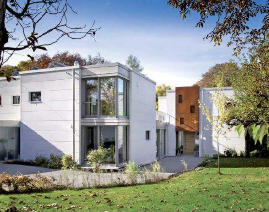
Die Eingangsseite des Patchwork-Familien-Hauses: Die Porenbetonfassade wurde für guten Witterungsschutz mit einer Silikonbeschichtung versehen. Der Eingangsbereich wird von einer Cortenstahl-Verkleidung mit charakteristischer Rost-Patina optisch hervorgehoben.
