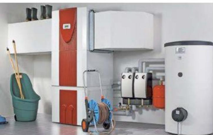
Im Neubau sind vor allem Luft-Wasser-Wärmepumpen sehr beliebt. Im Keller aufgestellte Geräte werden an zwei Luftkanäle angeschlossen: Einer saugt die Außenluft an, der andere führt die abgekühlte Luft ins Freie. Praktisch dafür ist die Eckaufstellung. [www.dimplex.de](http://www.dimplex.de)
