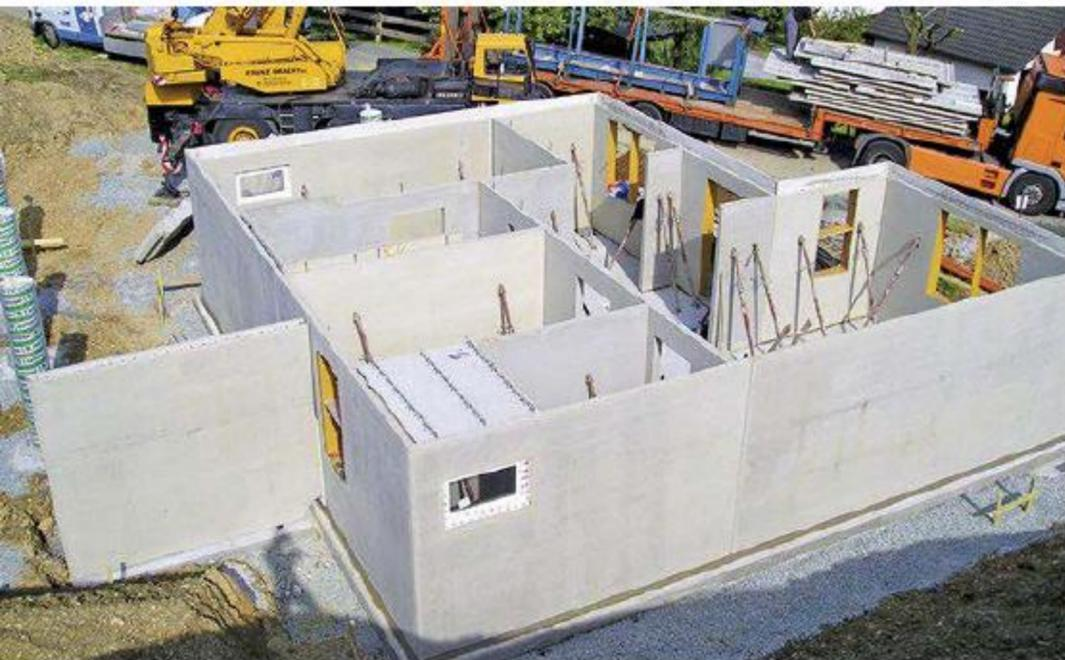
**FERTIGKELLER** werden maßgenau im Werk vorgefertigt und in kürzester Zeit aufgebaut. Die Wände des „Basis-Kellers“ bestehen aus Fertigteilen aus wasserundurchlässigem (WU)-Beton, vorgefertigte Großflächenplatten werden vor Ort zu einer massiven Betondecke vergossen. [www.partnerbau.de](http://www.partnerbau.de)
