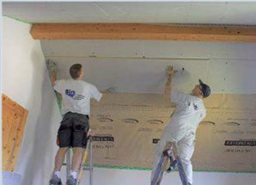
4. Die Platten von oben beginnend quer zu den Sparren verlegen und dicht aneinanderstoßen.
