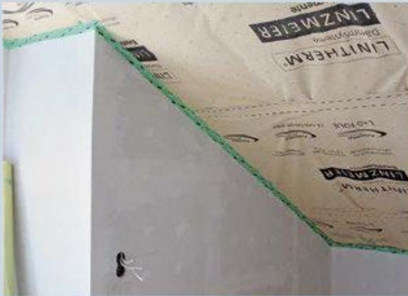
1. Als erstes wurde die Dampfsperren-Folie verlegt und zu den Wandwinkeln hin abgedichtet.
