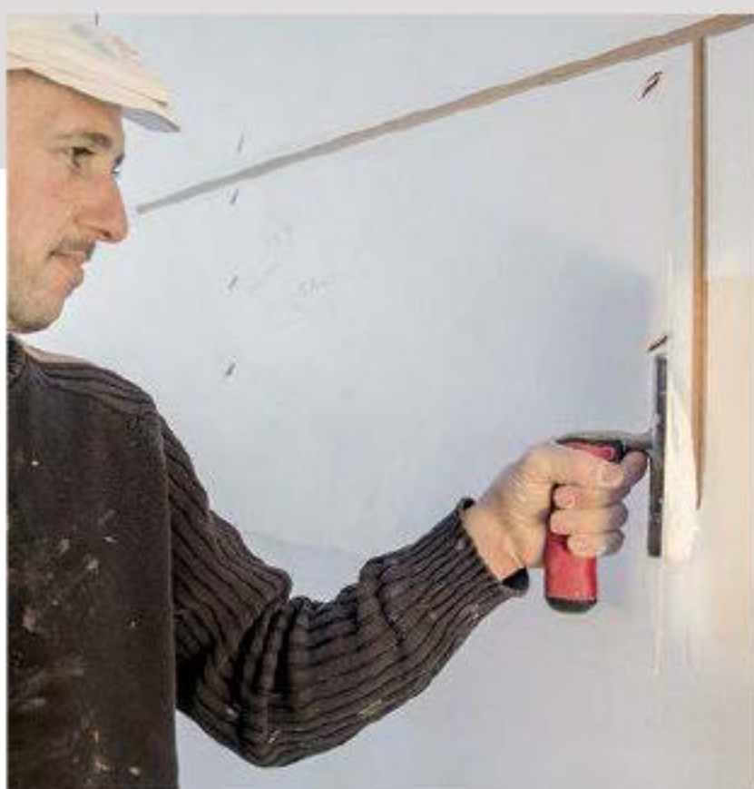
6. Für perfekte Oberflächen hat man die Stöße viermal verfugt und geschliffen (= Q4-Qualität).
