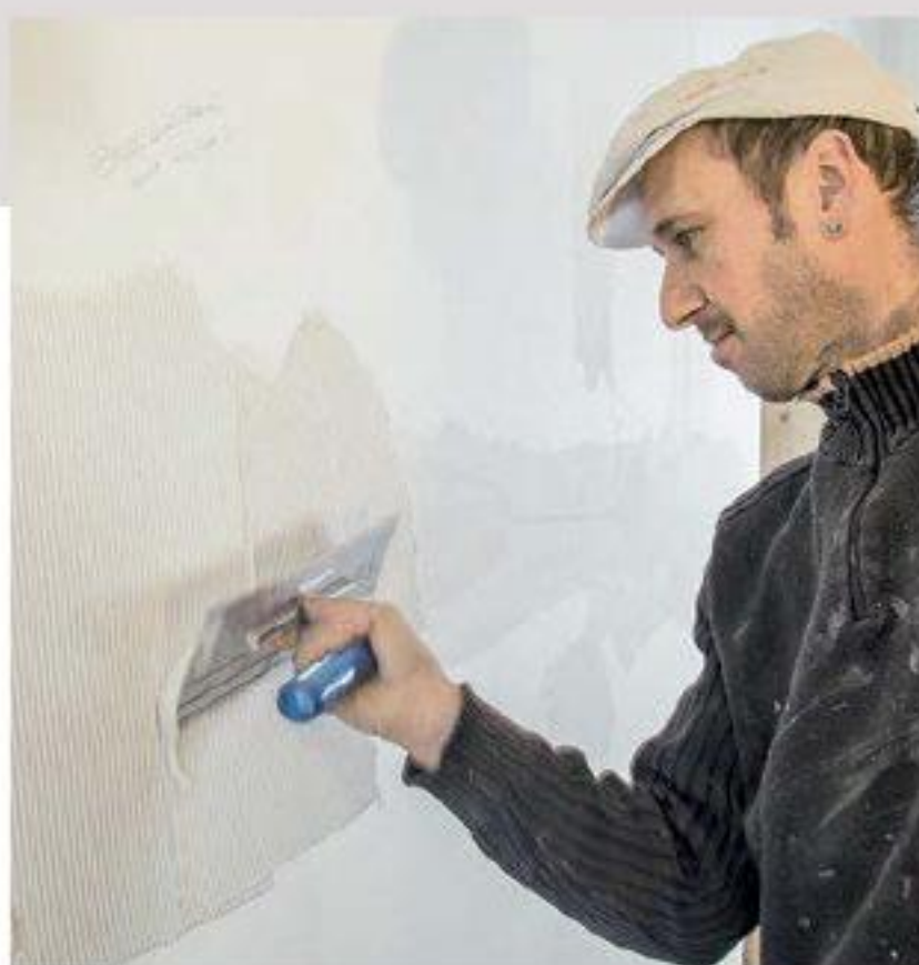
7. Die weiße Plattenoberflächen wurden anschließend fein verputzt. Der Putz konnte ...
