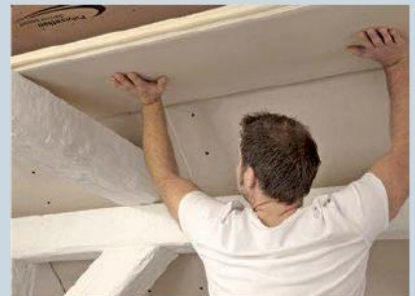
9. Hier hat man oberhalb der Kehlbalken eine raumbildende Zwischendecke eingezogen.
