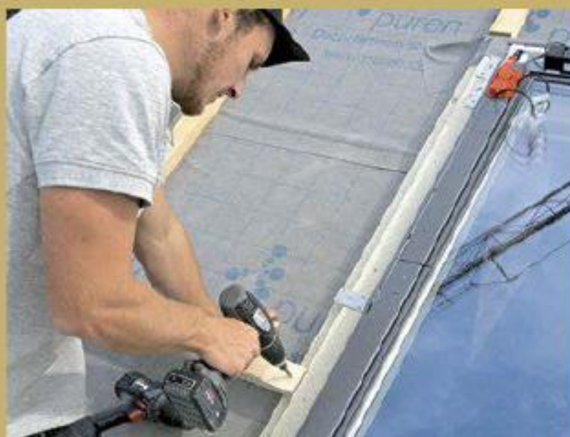
5. Danach anschließend werden die Dachlatten auf der Dämmzarge montiert.
