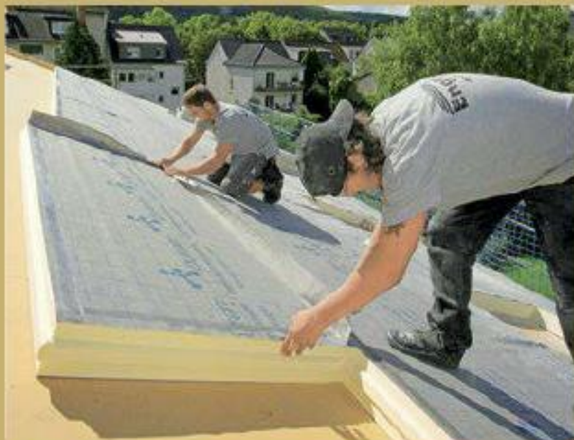
1. Die Elemente der Steildachdämmung lassen sich schnell und dabei passgenau verlegen.
