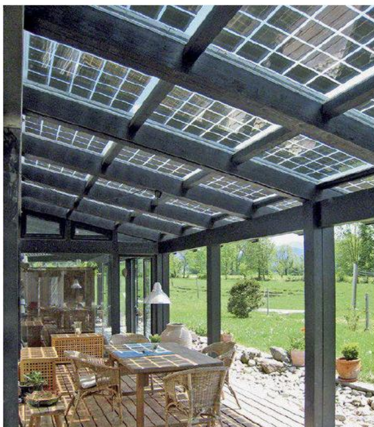
„Unter Strom“ aber ganz entspannt kann man bei diesem Solarterrassendach die warme Jahreszeit genießen. Die Konstruktion der festinstallierten Überdachung besteht hier aus Holz und speziellen Solarmodulen aus Sicherheitsglas. www.easyterrassendach.de
