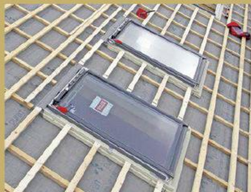
6. Fertig ist die systematische, bauphysikalisch perfekte Fenstermontage mit Dämmzargen.
