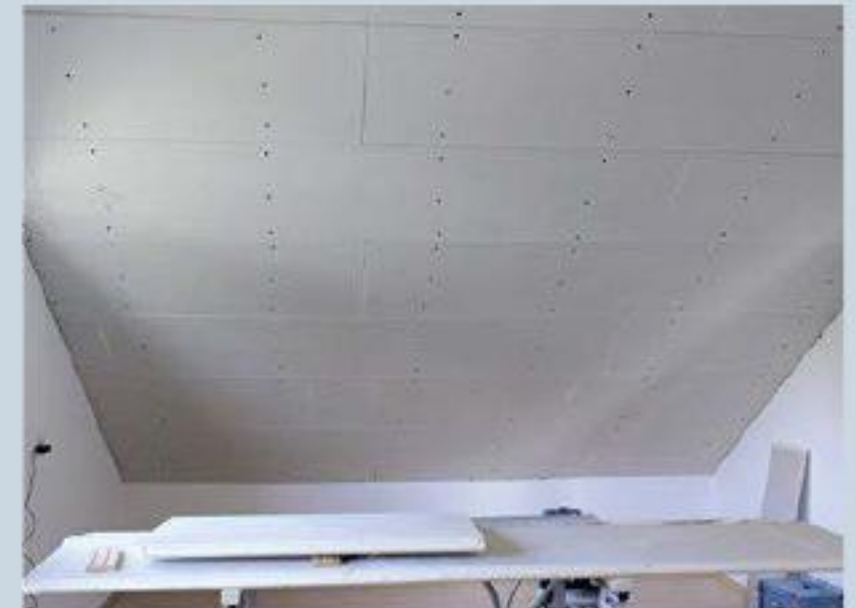
6. So sieht dann eine von innen gedämmte und gleichzeitig verkleidete Schräge aus.
