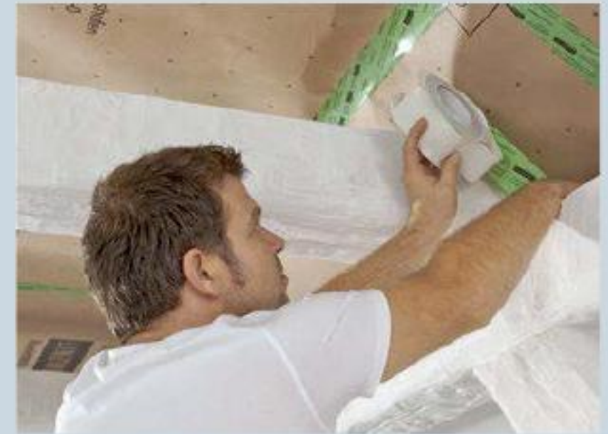
3. Wo es komplizierter wird, hilft entsprechendes Abkleben mit dem Dichtband.
