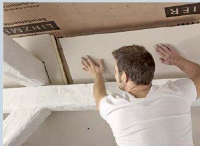
8. Auch an den Querstößen müssen die Plattenkanten satt zusammengesteckt werden.
