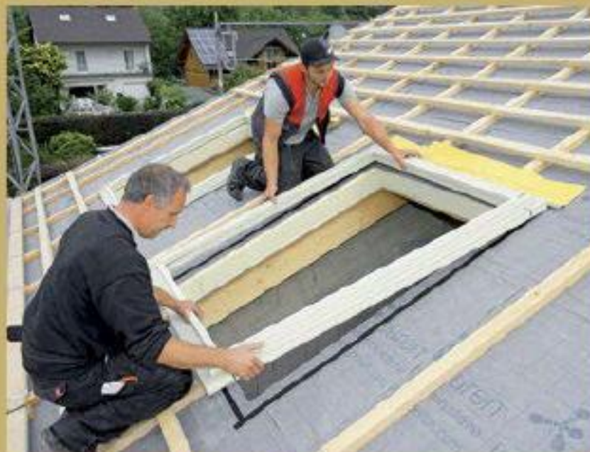
2. Die Einzelteile der Dämmzargen werden rund um die vorbereiteten Fensteröffnungen ...
