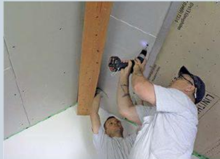
5. Die zweite Dachschräge dicht an die erste anschließen und Elemente verschrauben.
