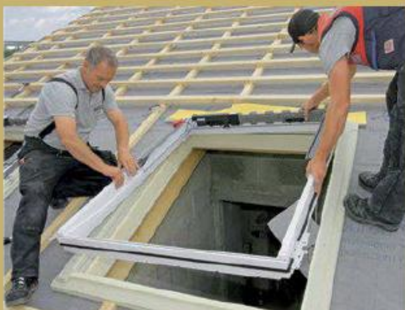
4. Es folgt der Einbau des mit Kompribändern bestückten Fensterrahmens in die Dämmzarge.
