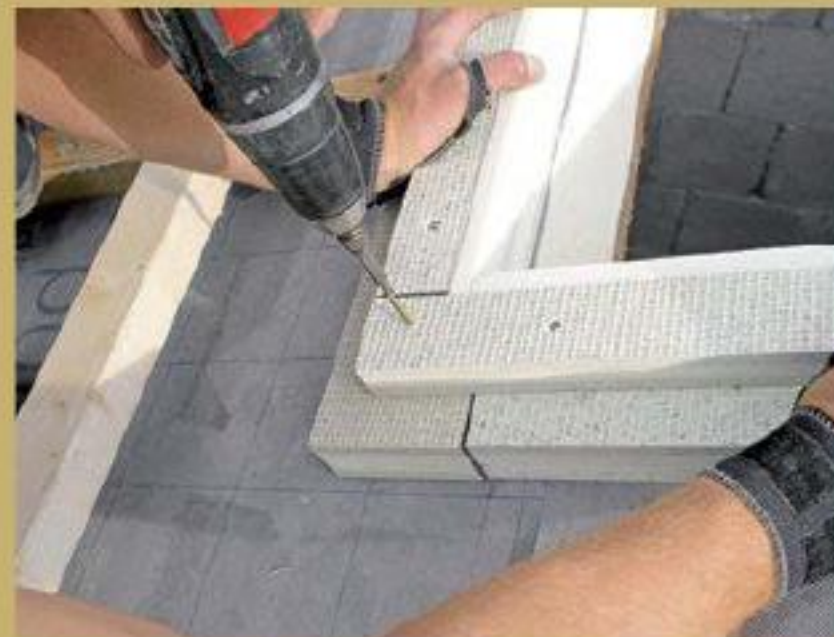
3. ... ausgelegt und verschraubt. Jeweils eine Schraube pro Ecke fixiert den Rahmen.
