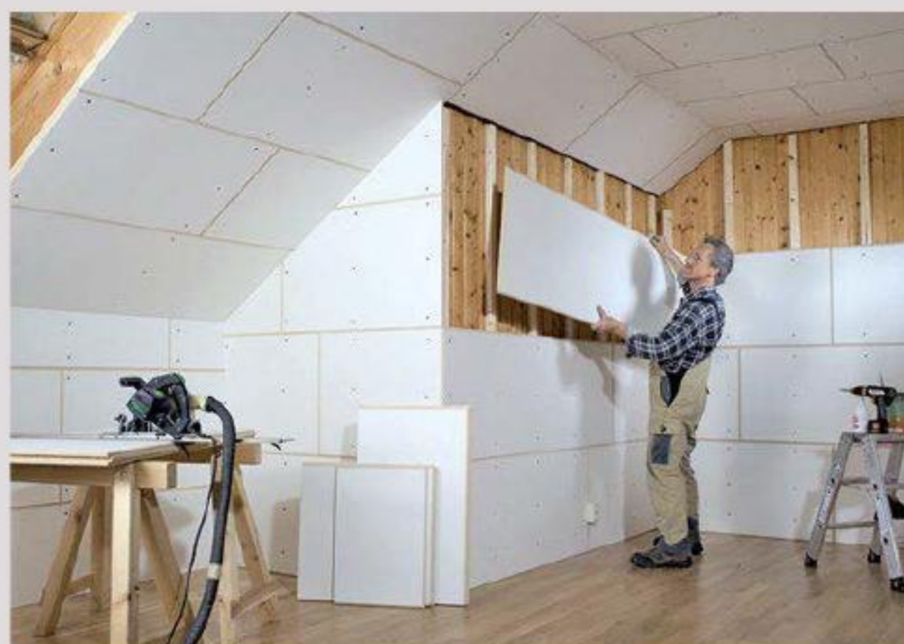
3. Von unten nach oben beginnend und in Querrichtung verlegt, war der Dachraum schnell beplankt und sah auch schon richtig wohnlich aus. Die Nut-und-Feder-Kante sorgte schnell und sicher für versatzfreie Flächen.
