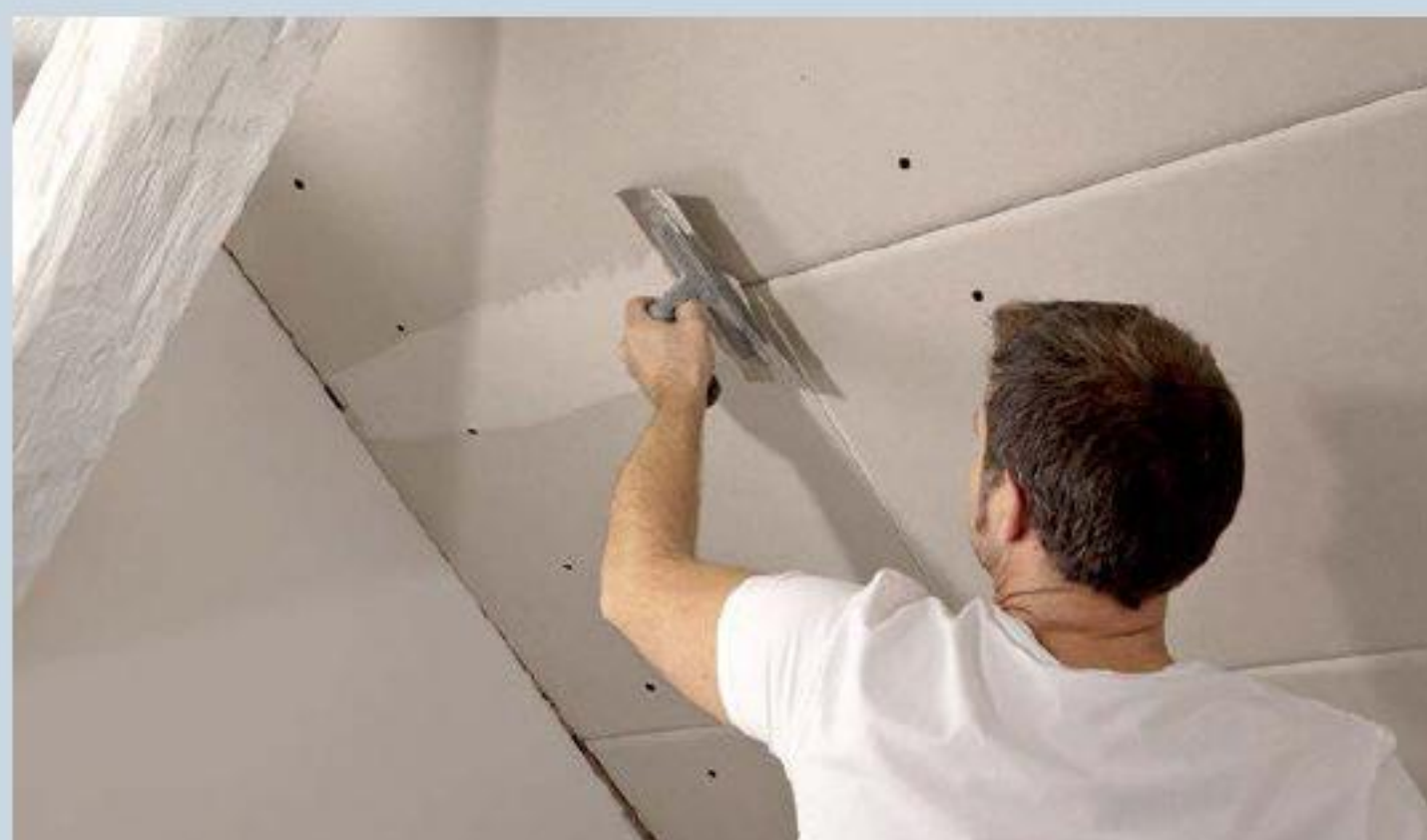
10. Die leicht gerundeten Fugenbereiche lassen sich mit breiter Traufel ansatzlos glatt abspachteln. Ebenso spachtelt man die Schraubstellen ab.
