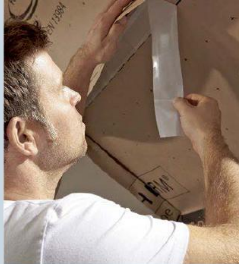
2. Die Überlappungsbereiche der Folienbahnen sind selbstklebend bzw. selbstabdichtend.
