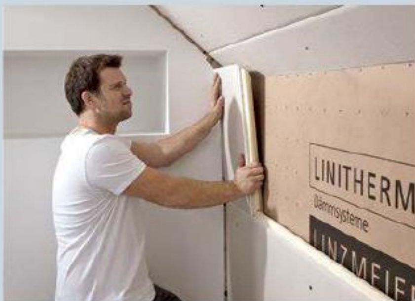
7. Am Kniestock die entsprechende Platte passgenau anschrägen und lückenlos anschließen.
