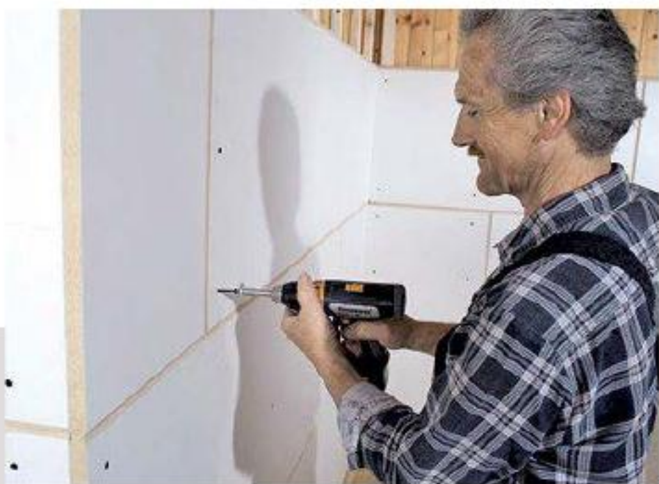
3. Befestigt wurden die Platten mit Schnellbauschrauben – an Wand und Drepelflächen auf der Traglattung, am Dach an den Sparren direkt.
