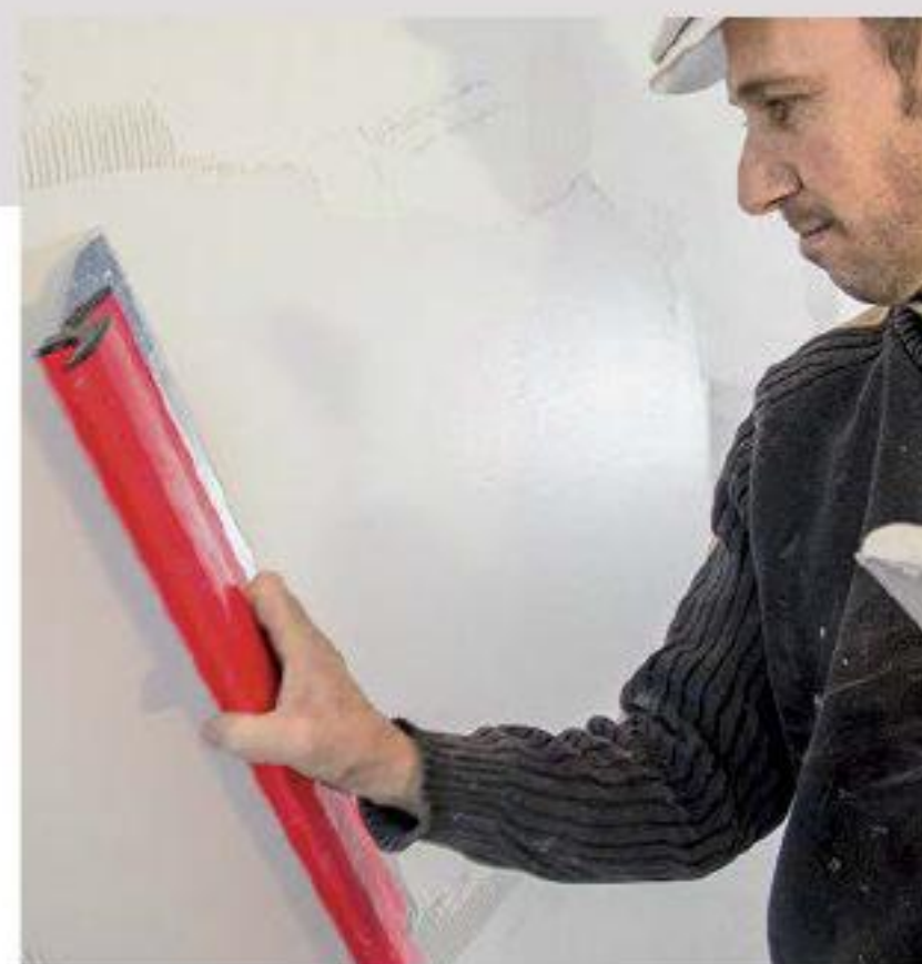
8. ... dann mit einer breiten Kartätsche glattgezogen werden – so resultierte eine moderne Optik.
