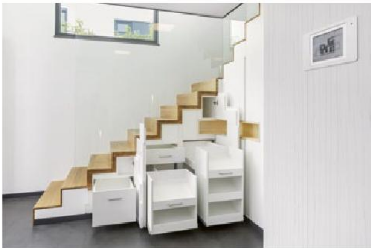
Ein Treppenunterbau mit verblüffender technischer Raffinesse: Hinter den gestuften Drehtüren befinden sich ausziehbare Schubkästen. In geschlossenem Zustand weist nichts auf die Einbauten hin. www.luxhaus.de
