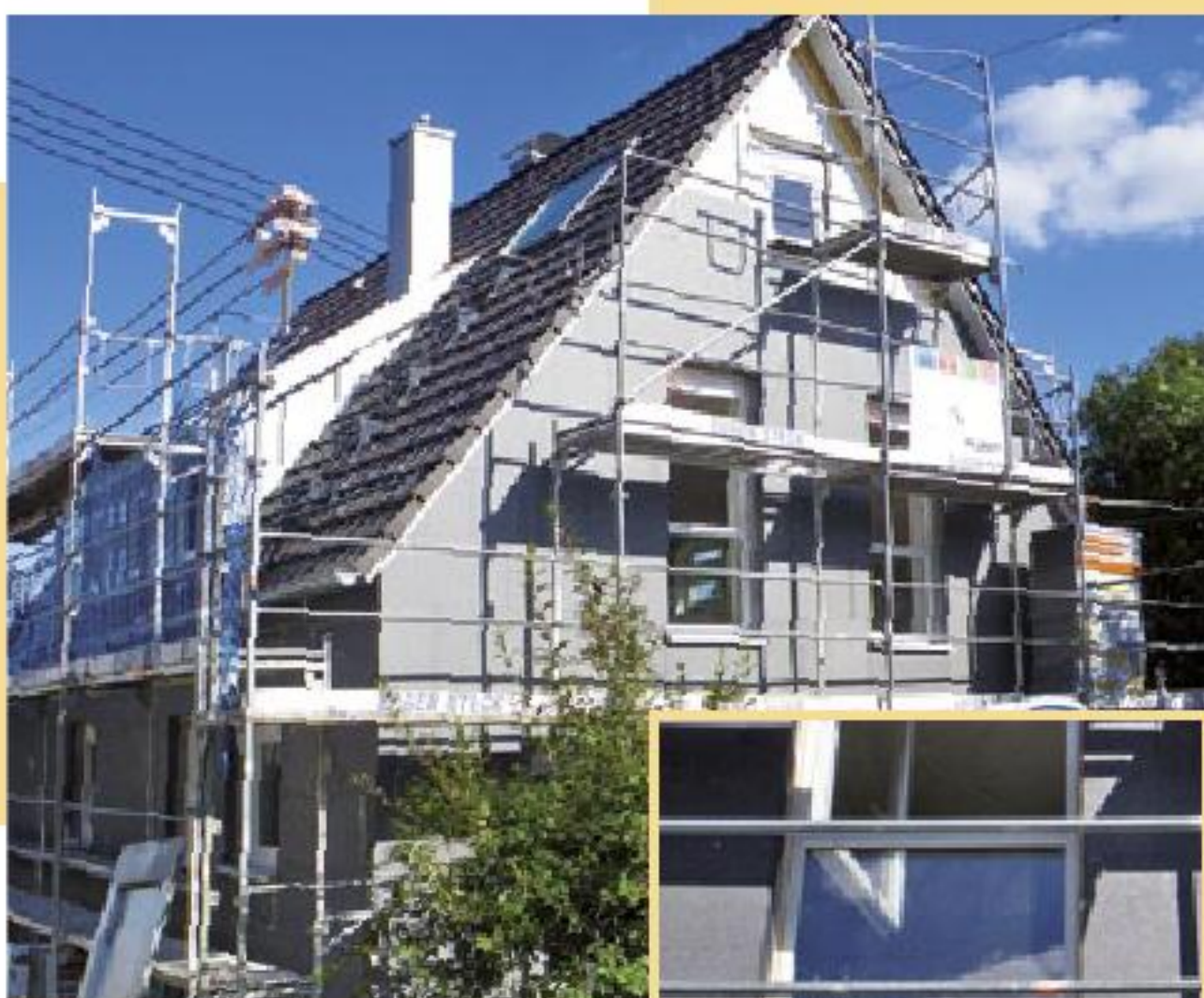
Fenster-Einbau in zwei Tagen. Danach wurden die neuen Fenstersimse montiert und die Fenster mit den Fassadendämmplatten leicht überdämmt.
