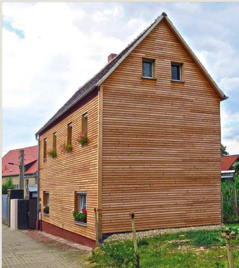
Dank der verdeckten Befestigung bleibt die Oberfläche intakt und bietet so weniger Angriffsfläche für witterungsbedingte Schäden.
