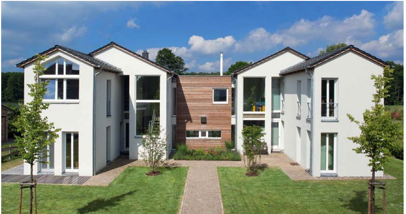
Das Erscheinungsbild des U-förmigen Gebäudes wird durch Längs- und Querachsen bestimmt, die für optimale Sichtbeziehungen der Räume zueinander sorgen.
