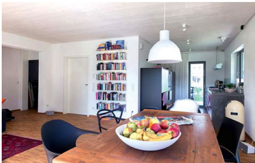
Insgesamt stehen über 1000 m 2 zur Verfügung. Das Holz der Brettsper Holzdecken bleibt von unten sichtbar. Es wurde lediglich weiß lasiert.
