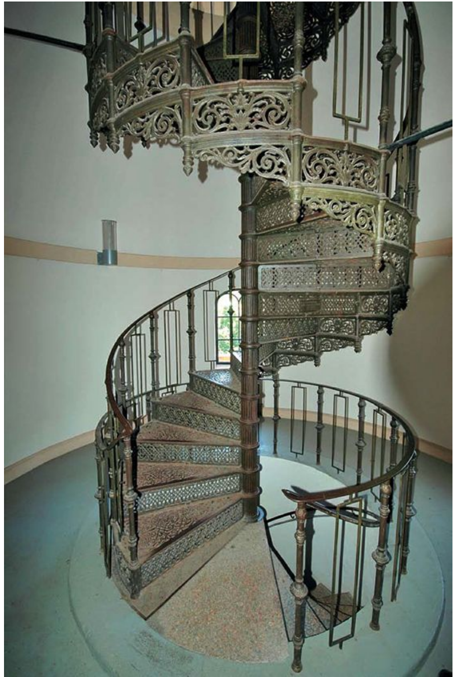
Mit den technischen Möglichkeiten entstanden auch aufwändige industriell gefertigte Treppen aus Kunstguss.
