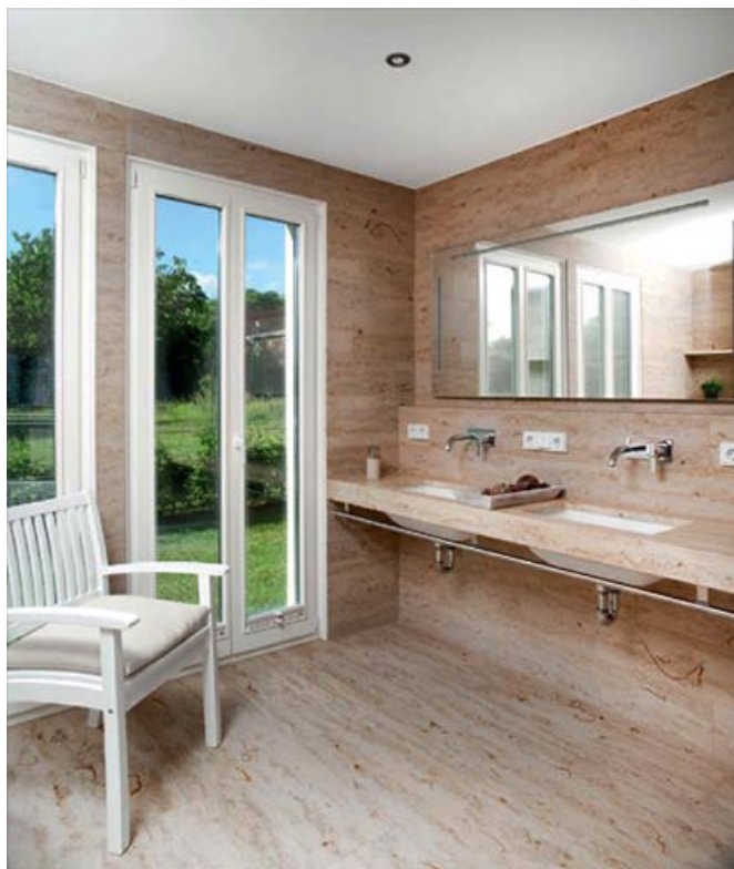
Wandbekleidungen, Waschtisch und Fußboden bestehen aus Marmor. Das Bad in der Erdgeschosswohnung wurde weitgehend barrierefrei geplant; der Waschtisch kann bei Bedarf unterfahren werden.
