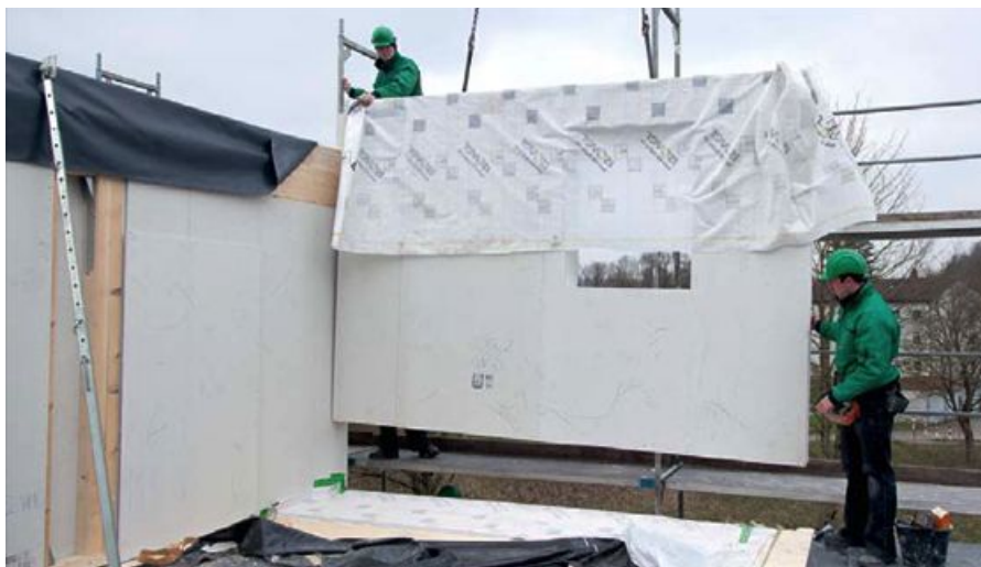
Der Rohbau des viergeschossigen Gebäudes wurde in sechs Wochen fertiggestellt.
