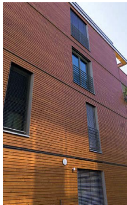
Ein Teil der Fassade ist als hinterlüftete Holzbekleidung ausgeführt.
