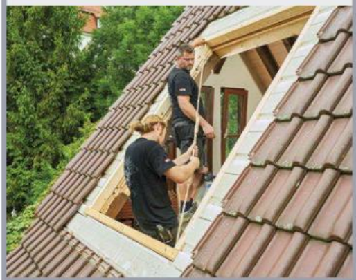
15 Damit keine Wärmebrücken entstehen, wird umlaufend zwischen alter Dämmung und Holzrahmen mit Dämmschaum verfüllt.
