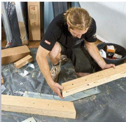
10 ... begonnen wird, und zwar mit dem Zusammenbau des neuen fensterteilenden Hilfssparren. Zwei Multiplex-Balken (Ansichtsbreite: 100 mm) werden mit Hilfe ...
