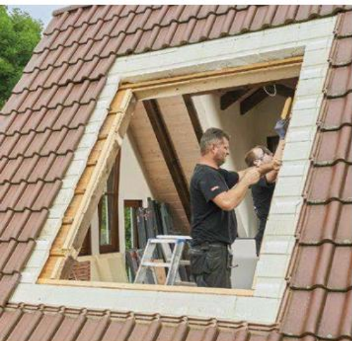
9 Neue Dimension: Noch ein paar vorbereitende Arbeiten rund um den neuen Dachausschnitt, bevor dann mit dem eigentlichen Einbau ...
