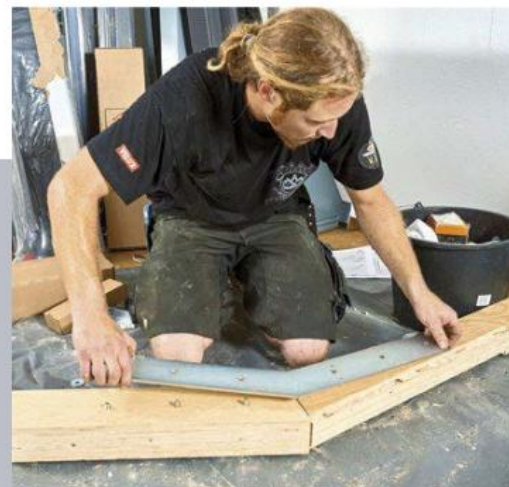
11 ... zweier abgewinkelter, solider und verzinkter Metallaschen sowie sechs Gewindestangen zu einem Knicksparren zusammengehalten.
