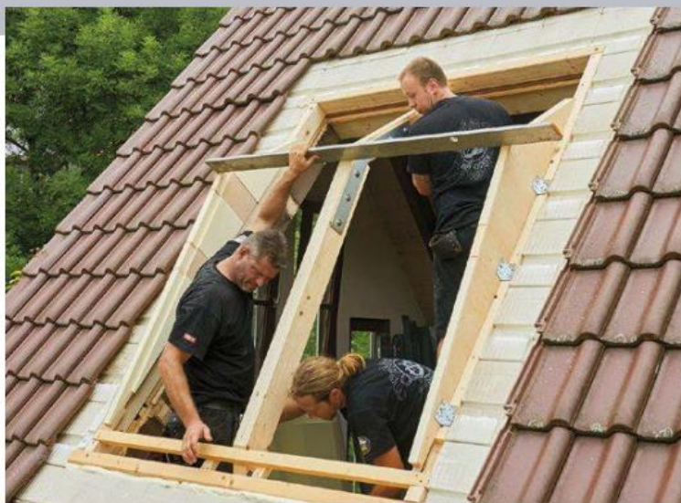
20 Mit Hilfe von Schrauben fixiert man sie schnell mit den Seiten und am mittleren Knicksparren.
