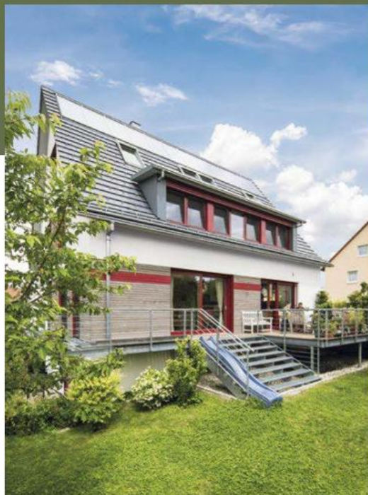
Der Serientäter: Ein langer Streifen Dach wurde hier genutzt, um gleich siebenmal in Reihe dem Freiheitsdrang nachzukommen. Dabei ging man raumübergreifend vor, was außen gar nicht auffällt. www.ghs-architekten.net
