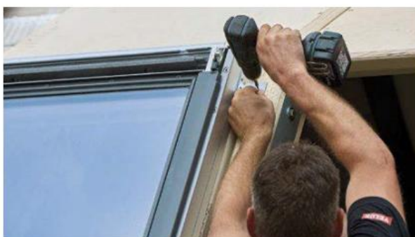
22 Über die bereits vormontierten Tragwinkel lassen sich die Fensterrahmen nun zügig anschrauben.
