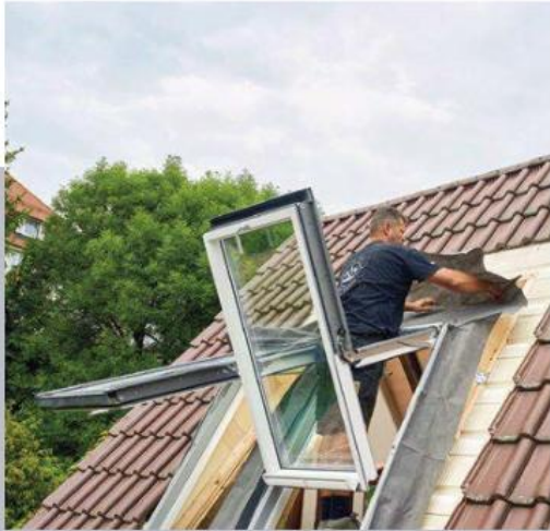
26 Auch oben über den Deckel-Elementen bis hin zur vorhandenen Dämmung wird mit Bahnen-zuschnitten für Winddichtigkeit gesorgt.
