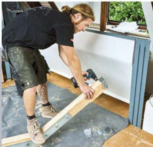
13 An den beiden Enden sorgen angeschraubte Balkenschuhe später für eine gute Anbindung des Hilfssparrens an den Querbalken des neuen Dachausschnitts.
