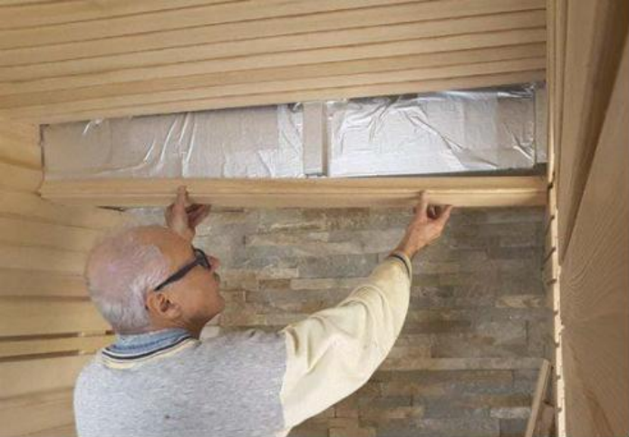
32 ... das dann als eine Einheit an den entsprechenden Traghölzern befestigt wurde und die Kante nahtlos und fugenkonform umkleidet.
