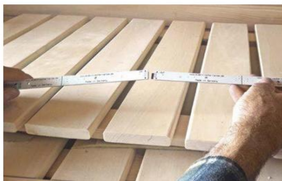
40 Die Gesamtlänge der Saunawand decken drei LED-Schienen-segmente ab, die dann per Steckverbindung eine Einheit bilden.
