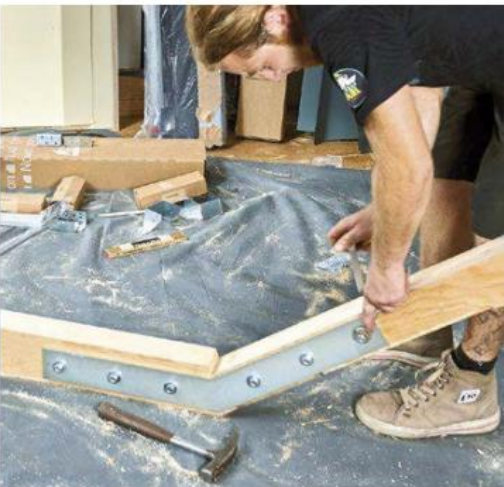
12 Mit Muttern und U-Scheiben wird das Ganze fest zusammengezogen. Damit ist dann auch die Form der neuen Dachfensterlösung vorgegeben.
