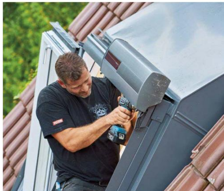
38 Die Solarrollläden sitzen jeweils oben am Flügel und lassen sich nach einem Einrasten noch zusätzlich fixieren. Sie sind Ton in Ton gehalten mit der sonstigen grauen Alu-Verblechung.
