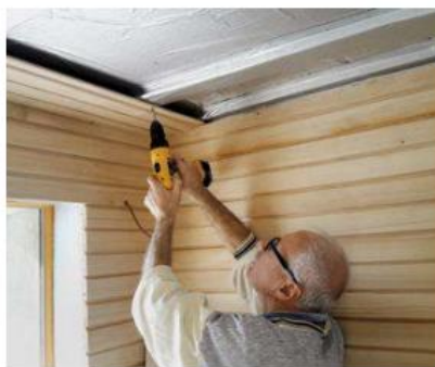
28 Die Deckenprofile halten dann durch direktes Verschrauben an den Traghölzern.
