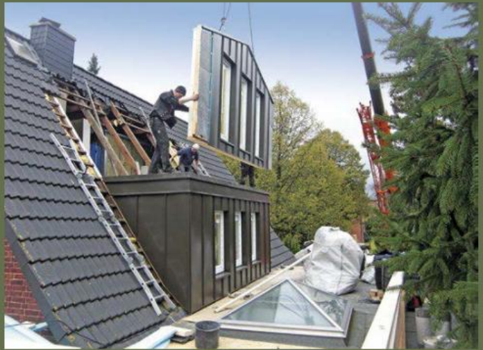
Der Raffinierte: Flucht nach draußen gleich über zwei Geschosse hinweg, das war hier die Vorgehensweise. Dabei ging man schrittweise vor. Erst schob man ein Fertigteil in den unteren Bereich ein, darauf baute sich dann mit Kranhilfe der Überbau auf. Ein gelungener Gesamtplan. www.diers-holzbau.de
