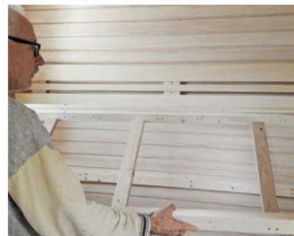
33 Die einzige lange Wand war für die hoch-eingebaute Bank reserviert – mit Rückenlehne.
