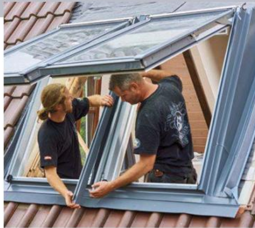
33 Es folgen dann die Abdeckschienen – sowohl seitlich als Abschluss an den Dreieckblechen als auch in der Mitte.
