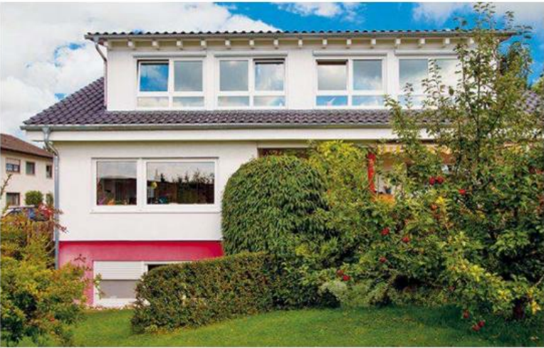
Der Langfinger: Viel Nutzen und Mehrwert suchend nahm man hier fast die ganze Dachfläche in Angriff, um dann eine fast dachlange Anlage aus zwei kombinierten Einzelgauben zurückzulassen. Nach der Aktion war alles unbeschadet und in optisch einwandfreiem Zustand wiederhergestellt. Das Gebäude wirkt so, als sei überhaupt nichts geschehen. www.holzbau-weiss.de
