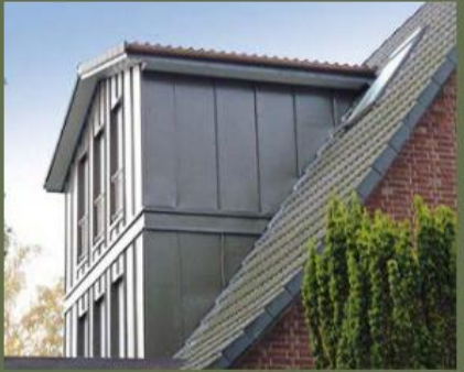
Der Raffinierte: Flucht nach draußen gleich über zwei Geschosse hinweg, das war hier die Vorgehensweise. Dabei ging man schrittweise vor. Erst schob man ein Fertigteil in den unteren Bereich ein, darauf baute sich dann mit Kranhilfe der Überbau auf. Ein gelungener Gesamtplan. www.diers-holzbau.de
