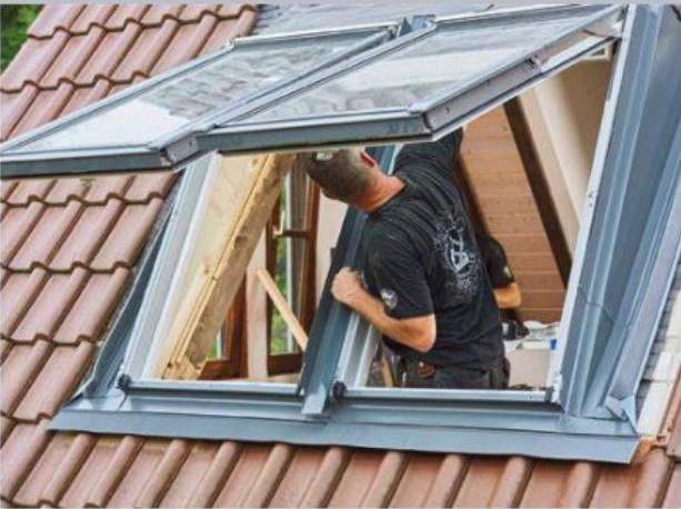
32 Inzwischen sind auch schon die Seitenverkleidungen angebracht und im Zwischenbereich wird ein Formblech eingebaut.
