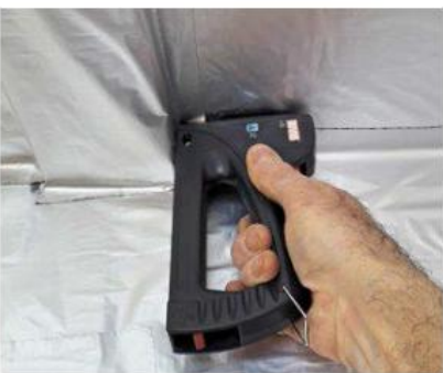
27 Per Tacker fixiert man die Klebahn an schwierigen Stellen zusätzlich.
