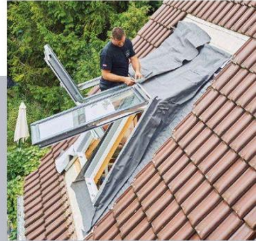
28 Und so sieht das Ganze im Überblick aus: Mit der Überlappung der beiden Deckelbahnen ist das gesamte Fensterbauteil dicht eingepackt.
