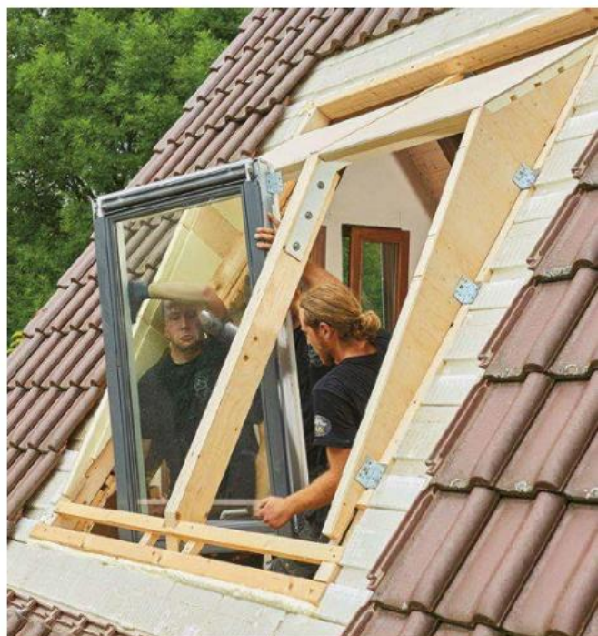
21 Das erste Fenster wird sogleich komplett eingebracht und findet auf einer unten angebrachten Dachlatte Halt.
