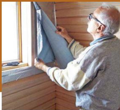
23 ... weitergehen konnte, wurde erst wieder ein Foliestück eingepasst und flächig auf Dämmplatten und Holzrahmen verklebt.
