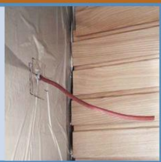
18 Mit Hilfe der selbstklebenden Alu-Dampfsperre wird nun die gesamte Dämmhülle vor Feuchtigkeitseintritt geschützt. Bahnen zuschneiden, oben ankleben und Schutzfolie dabei abziehen.
