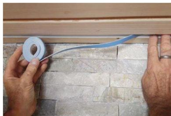
41 Damit die 1,5 m lange LED-Schiene hält, wird oben im U-Profil ein Doppel-Klebeband eingedrückt.
