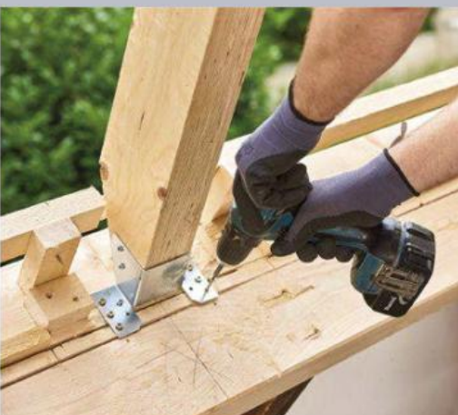
17 Unten und oben verbindet man ihn nun über die Balkenschuhe sicher mit dem aufgedoppelten Kantholzrahmen.
