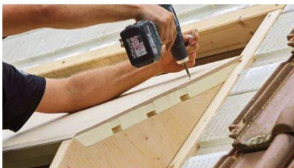
17 Unten und oben verbindet man ihn nun über die Balkenschuhe sicher mit dem aufgedoppelten Kantholzrahmen.
