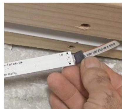
39 Das 24 V-Kabel von außerhalb der Sauna steckt man in die LED-Schiene.
