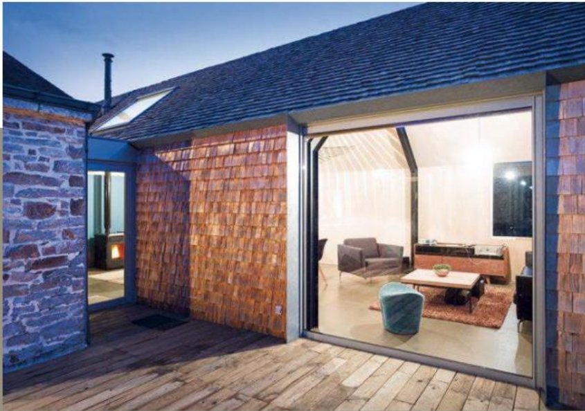
Das Dach des kleinen Holzhauses ist mit Holzschindeln eingedeckt. Das gleiche natürliche Baumaterial kam auch bei der Gestaltung der Außenwände zum Einsatz.
