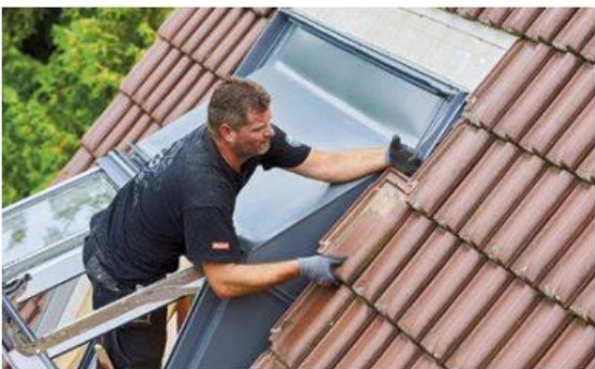
36 Die Schaumkeile dienen der Abdichtung und werden beim Auflegen der Ziegel dicht an deren Unterseiten angedrückt.
