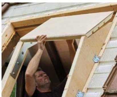
15 Damit keine Wärmebrücken entstehen, wird umlaufend zwischen alter Dämmung und Holzrahmen mit Dämmschaum verfüllt.
