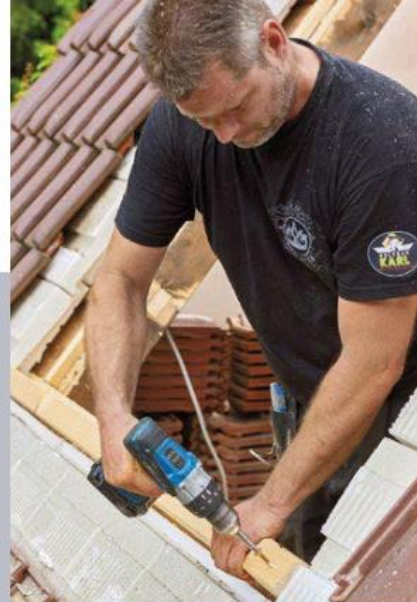
14 Diese werden nun noch passgenau zugesägt, horizontal ausgerichtet und verschraubt. Der Kantholzrahmen läuft übrigens rundherum.
