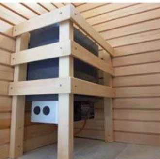
35 Der Ofen bekam eine Hitzeschutz-Umbauung aus demselben Profilholz.
