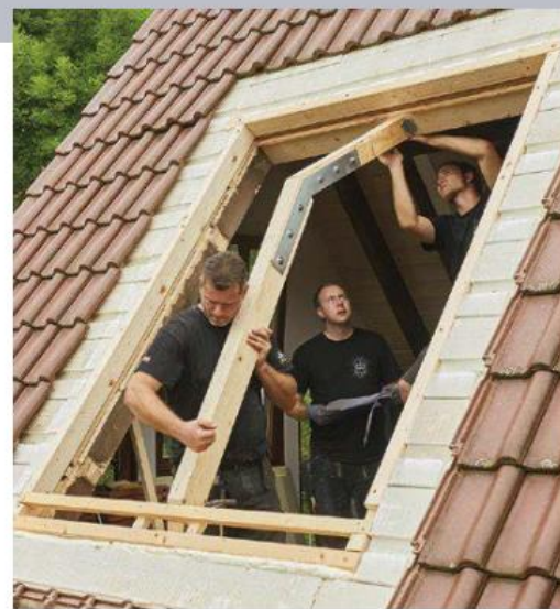
16 Nun der spannende Moment: Der Einbau des Winkelsparrens, der gegenüber der Dachschräge deutlich steiler steht und aus dem Raum tritt.
