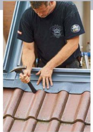
34 Mit sanftem Druck formt der Zimmerer die Kunststoffschürze an.
