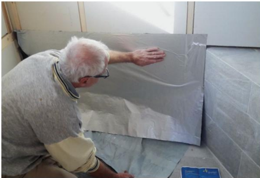
18 Mit Hilfe der selbstklebenden Alu-Dampfsperre wird nun die gesamte Dämmhülle vor Feuchtigkeitseintritt geschützt. Bahnen zuschneiden, oben ankleben und Schutzfolie dabei abziehen.
