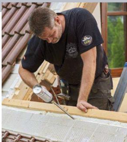
15 Damit keine Wärmebrücken entstehen, wird umlaufend zwischen alter Dämmung und Holzrahmen mit Dämmschaum verfüllt.
