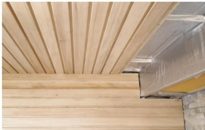
29 Da Abdeckleisten unerwünscht waren, wurden die Deckenprofile an dieser Seite exakt abgelängt und dicht ans Wandbrett stoßend verlegt.
