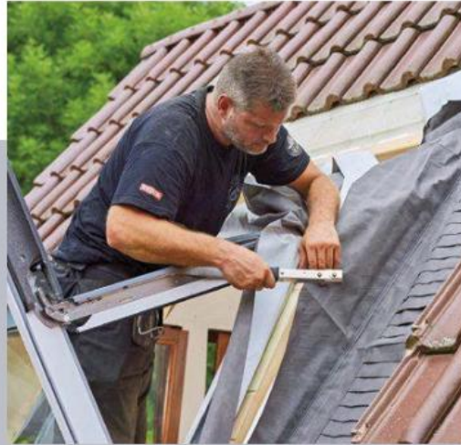
27 Die Befestigung des seitlich hochgezogenen Textils, das bis unter die Eindeckung ausgebreitet wird, erledigen die Profis mit dem Schlagtacker. Das geht ruckzuck!
