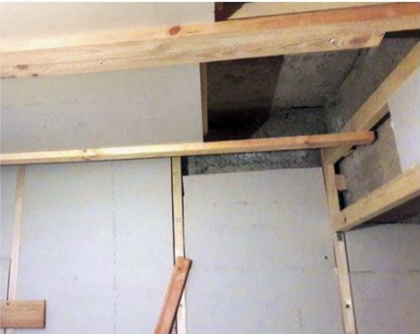
17 So langsam schließt sich die Dämmhülle und für den Deckenabschluss fehlen nur noch zwei Passtücke.
