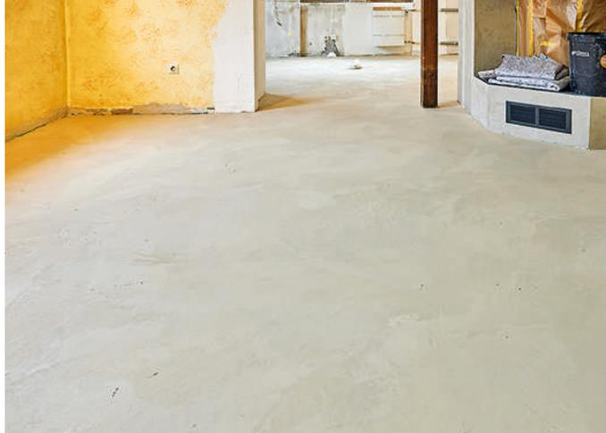
**28** Ein erster Gesamteindruck nach Beendigung des zweiten Auftrags. Und schon mindestens eine Stunde nach Fertigstellung kann wieder – nachdem man die Begehrbarkeit überprüft hat – mit der Stahltraufel abgezogen werden.
