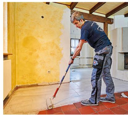
**6** Als Grundierung dient ein Haftgrund speziell, der mit einer Florwalze längs und quer aufgerollt wird. Trocknungszeit: 1 bis 1,5 Stunden.
