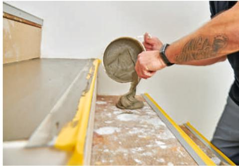
**12** Breiig-zäh wird diese in kleineren Teilmengen auf die zuvor sauber abgesaugten Trittlflächen gebracht.
