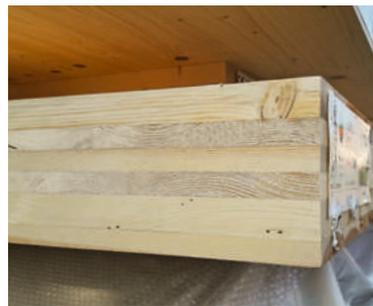
**8** Und so sieht das kreuzlagenverleimte Brettsperrholz im Detail aus. Die Bodenplatte beispielsweise ist 16 cm dick.
