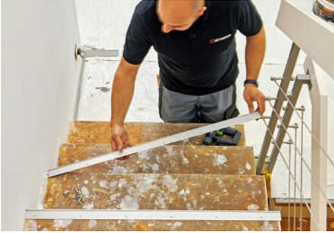
**8** Da die Treppe ja mit einem dünneren Material belegt werden sollte, waren Kantenschienen erforderlich.
