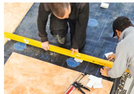
**4** In der Dämmung sind Ausgleichsplättchen integriert, die für eine horizontale Lage der Bodenplatte sorgen.
