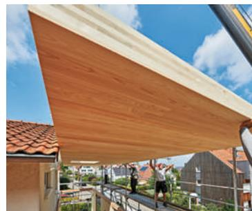
**21** Millimeterarbeit am Dachüberstand. Hier auch schön zu sehen, dass die Unterseite querverlegtes Lärchenholz zeigt.
