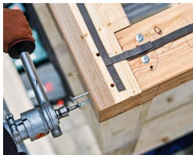
**19** Seitlich eingebrachte Schrauben halten Quer- und Längspfetten zusammen. Die aufgeklebten Dichtbänder sorgen ...
