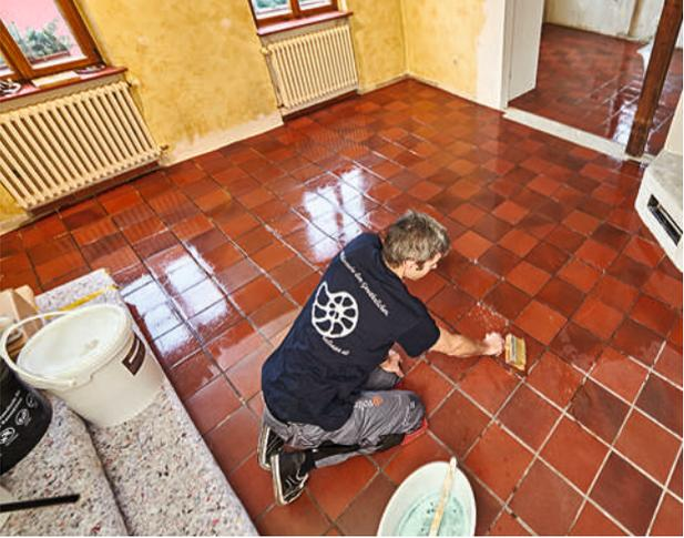
**4** Die Flüssigkeit wird mit einer Bürste satt aufgetragen und auf der Fläche verteilt. Durch das Absäuern (die Nässe etwa 20 Minuten wirken lassen) werden alte Rückstände entfernt.
