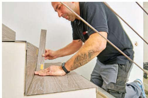
**23** Das passgenaue Streifenstück wird danach eingefügt und fugenlos verklebt. Der Vinylbelag hat keine Nut- und Feder-Verbindung, sondern wird dicht gestoßen verlegt.
