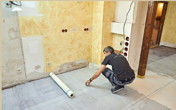
**8** ... die gesamte Fliesen- fläche Gewebehahnen mit 10 cm Überlappung ver- legt wurden. Das ist nicht immer dringend erforder- lich, wurde jedoch hier so sicherheitshalber aus- geführt, zumal sich der Fliesenboden im Bereich der Küche auf einer Bal- kenkonstruktion aufbaut.
