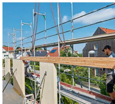
**14** ... noch die langen Verbindungsbalke, die die drei Wandsegmente sicher zu einer Gebäudeseite zusammenfügen.
