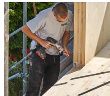
**12** Mit von außen schräg eingedrehten Schrauben werden die Bauteile im Plattenfalz verankert.
