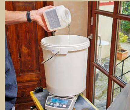
**34** Der Härter wird in entsprechend vorgegebener Menge zugeführt, dann wird alles gut verrührt. Wir beginnen an ...
