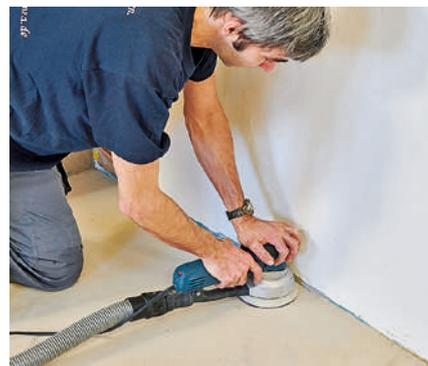
**31** ... die Randbereiche bearbeiten oder auch die Bodenflächen unter Heizkörpern. Mit einer Absaugung bleibt das Ganze relativ staubarm.
