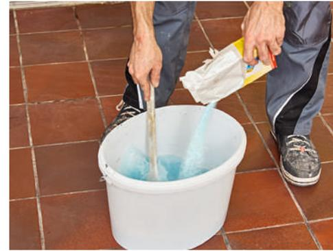
**3** Mit einem Anlauger-/Entfetter-Mittel, das mit Wasser angerührt wird, geht es zunächst darum, den alten Fliesenboden zu reinigen.
