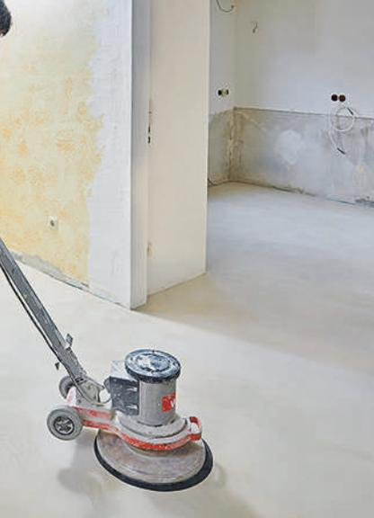
**29** Nach vollständiger Austrocknung erfolgt ein durchgängiger Feinschliff mit einer 80er-Korn-Schleifscheibe und zwar als Vorbereitung für die Endversiegelung.
