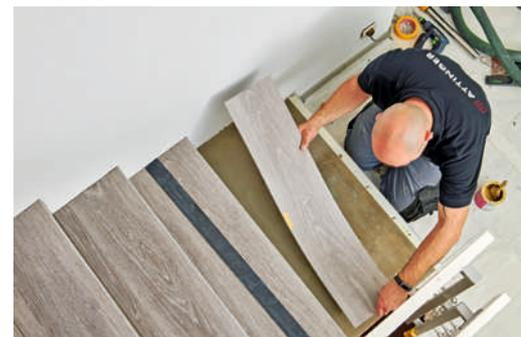
**24** Und so arbeitet man sich von oben nach unten herab. Die Stufen sind dann bereits kurz nach Verklebung schon mal fürs Erste begehbar.
