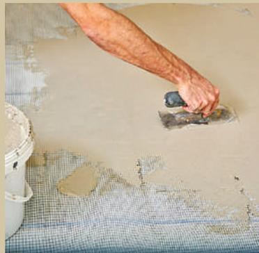
**11** ... ins Armierungsgewebe eingerieben werden können, was dazu dient, im ersten Schritt das Fugenraster einzunivellieren.
