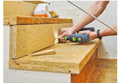
**6** ... Stellbretter ausreichend und sicher an der alten Treppenunterkonstruktion befestigt.
