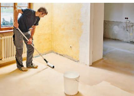
**36** Für die Fläche eignet sich am besten eine Nylonwalze (Parkettlackwalze macht keine Luftblasen!) mit zirka 60 mm Durchmesser. Hierbei längs und quer arbeiten.
