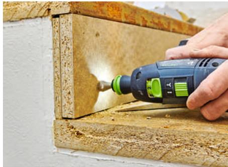
**5** ... durch sowie Schraubenvertiefungen, die man mit einem Senkbohrer erstellt hat, waren die ...
