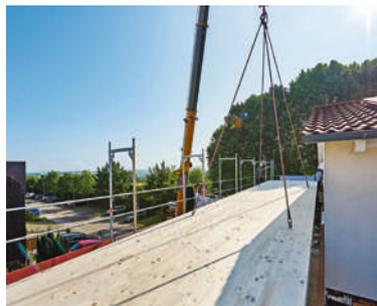
**7** Zwischen Hauswand und Gerüst senkt sich die lange Tafel langsam herunter bis sie satt auf der Mineralwollelage liegt.
