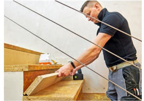
**3** Ebenso aus Spanplatten: Die Aufdoppelungen für die Stellstufen, die zuvor genau zugesägt wurden.
