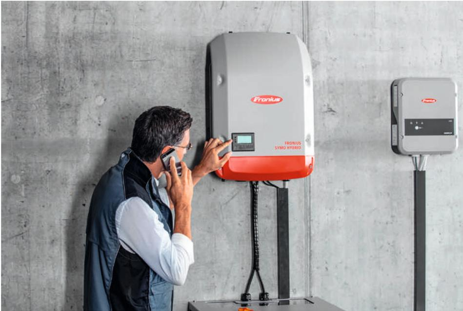
Der Wechselrichter Symo Hybrid von Fronius vereint Batterieladegerät, Batterie-wechselrichter, Hybridwechsel-richter, Controller und Anlagen-Monitoring in einem Gerät. Es versorgt einerseits die Verbraucher im Haushalt und speichert zusätzlich überschüs-sige Energie einer PV-Anlage im Batteriespeicher zwischen. Fronius
