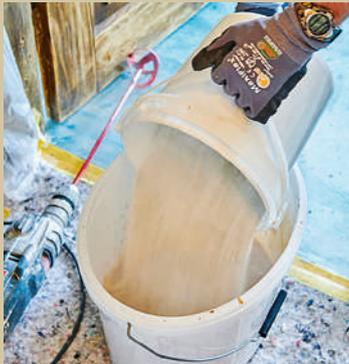
**19** ... das Mikrozeimentpulver eingefüllt. Das Mischungsverhältnis ist pro Eimer (vgl. Abb. 15) immer so einzuhalten!
