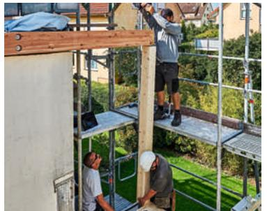
**17** Die frei überstehende Wandpfette (s. Abb. 2) wird am Außeneck mit einem Pfosten unterstützt.
