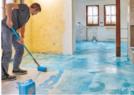
**14** Zuerst wird noch mit einer dicken Fellwalze eine Grundierung aufgetragen, die für eine optimale Haftung der Beschichtung auf der Grundspachtelung sorgt.
