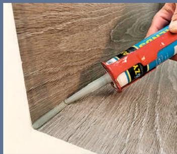
**29** Nun werden noch die offenen Fugen am Treppenbelag selbst und hin zu den Sockelstreifen mit Silikon geschlossen.
