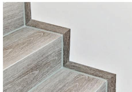
**31** An den Wänden hat man übrigens auf Sockelleisten verzichtet und dafür aus Restmaterial vom Vinylbelag Streifen mit Gehrungsschnitt verklebt.
