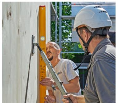
**11** Mit in der Bodenplatte fixierten Drehstützen sind die Wandplatten schnell exakt ins Lot gebracht.
