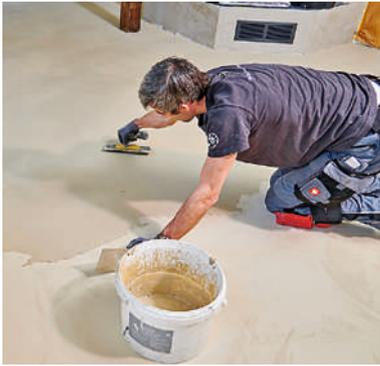
**27** Gerade bei der zweiten Schicht kommt es aufs zügige Arbeiten nass in nass an, um ein einheitliches Flächenbild zu bekommen.
