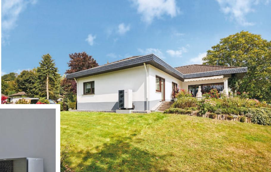
Ideal für Bestandsimmobilien, die modernisiert werden sollen: Die neue aroTHERM plus ist eine Luft-Wasser-Wärmepumpe, die Vorlauftemperaturen von bis zu 75 Grad Celsius im Wärmepumpenbetrieb erreicht. Vaillant
