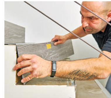
**21** ... der Vinylbelag wird ja direkt bis unter die Schienenkante geschoben und dort auch verklebt.
