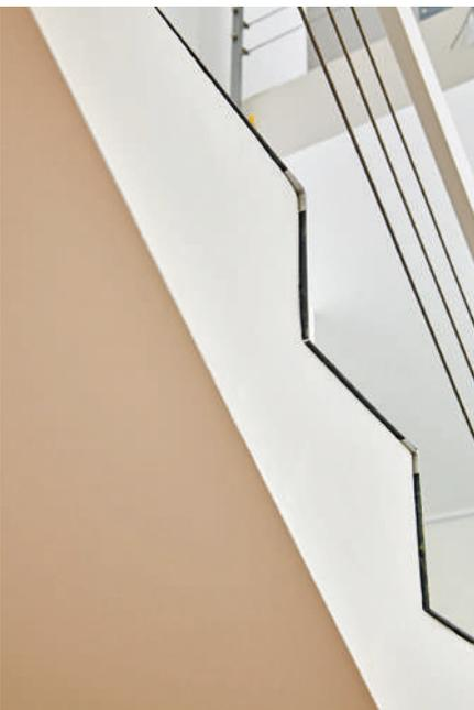
**25** Nun noch ein Blick auf die Außenseite. Die Profilschienen und Vinylzuschnitte hat man bewusst in einer einheitlichen Länge überstehen lassen, um dadurch eine gerade Kontur zu bekommen.
