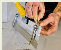
**9.** Für den Höhenausgleich setzt man die Schiene höher.
