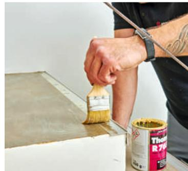
**20** Wichtig ist, dass der Kleber auch bis über die Alu-Schiene und bis vor an die Profilkante aufgetragen wird. Denn ...
