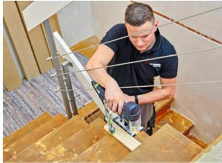
**2** Die seitlichen Überstände der Stufenplatten (diese sind aus Spanplatten) hat man bündig abgesägt.
