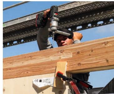
**16** Dann stellen lange Schrauben, die von oben her eingedreht werden, die dauerhaft bündige Position der Querpfette sicher.
