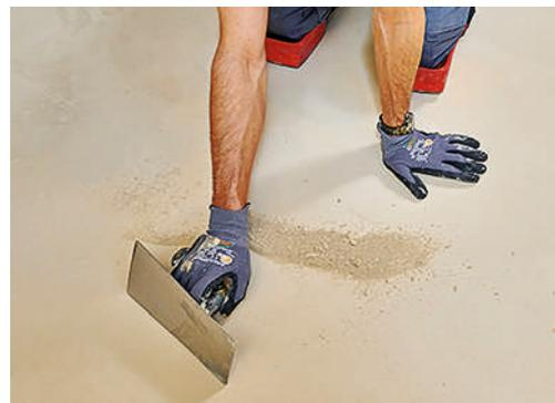
**24** Nach mindestens 3 Stunden Trocknungszeit (je nach Raumsituation/Luftfeuchtigkeit auch mehr) stärkere Grate oder Unebenheiten mit der Traufelkante abkratzen.
