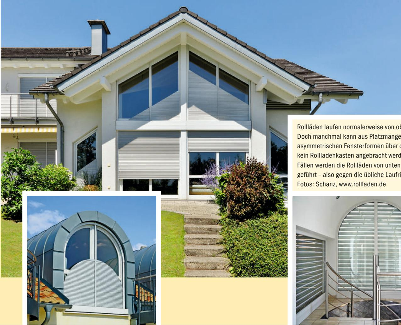
Rollläden laufen normalerweise von oben nach unten. Doch manchmal kann aus Platzmangel oder bei asymmetrischen Fensterformen über dem Fenster kein Rollladenkasten angebracht werden. In solchen Fällen werden die Rollläden von unten nach oben geführt – also gegen die übliche Laufrichtung.
