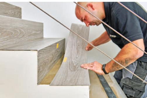
**22** Zunächst werden die Stellflächen beklebt, dann folgen die Stufen. Hier beginnt man vorne an der Profilkante mit der original breiten Vinylplanke.
