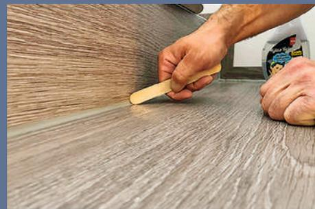
**30** Mit Glättmittel eingesprüht und mit Hilfe eines runden Holzstäbchens abgestrichen, sehen die farblich angepassten Silikonfugen dezent-elegant aus.
