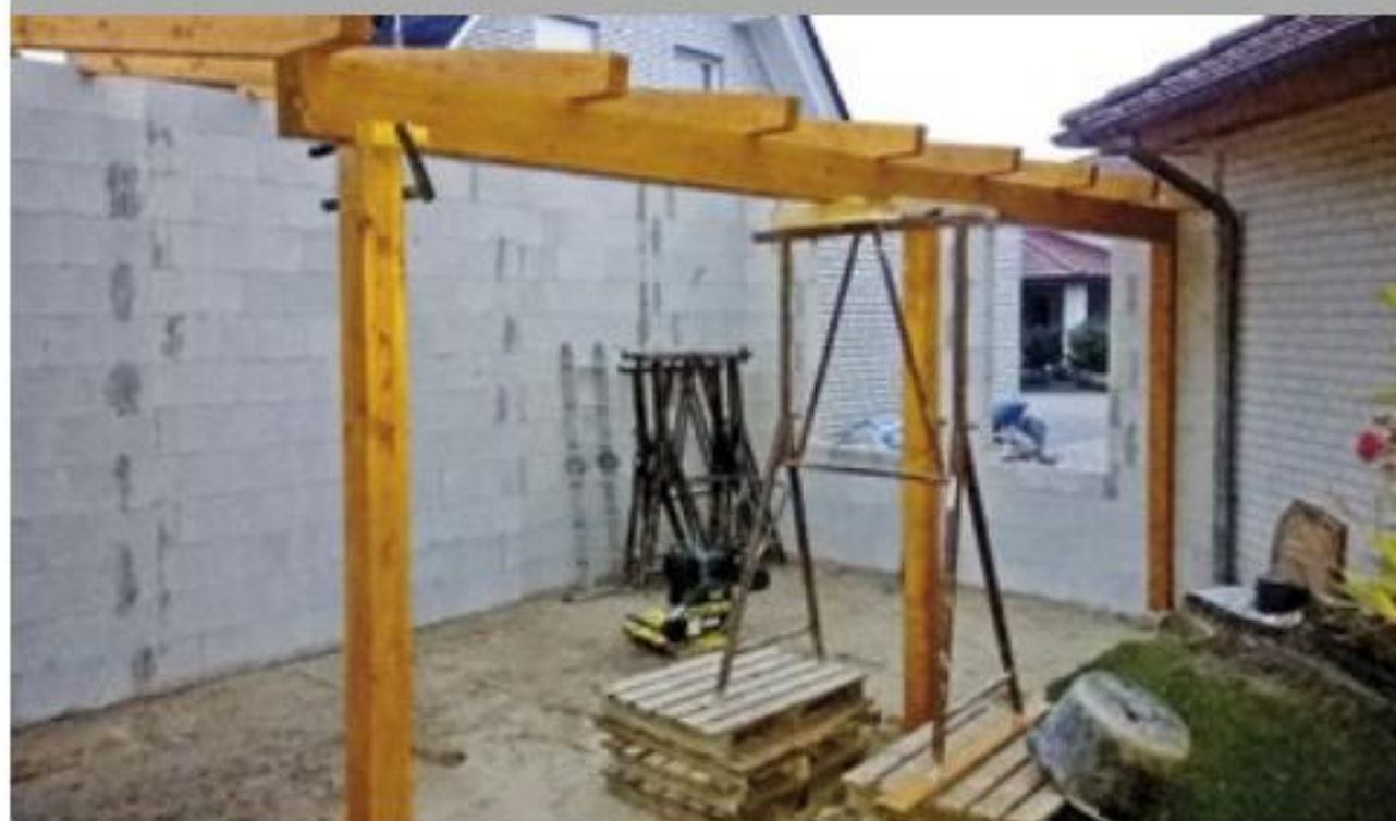
7. Dann wurden die Pfosten gesetzt und alle Holzbauteile sicher miteinander verbunden.
