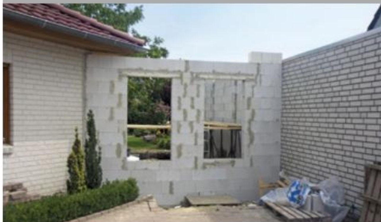
5. Ein Blick von Außenseite her. Über den Fenstern muss noch die Dachschräge aufgemauert werden.
