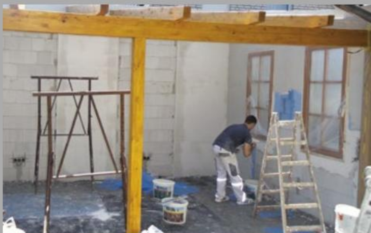
10. Das Verputzen der hohen Mauern aus Kalksandstein hat man dann wieder den Handwerkern überlassen.
