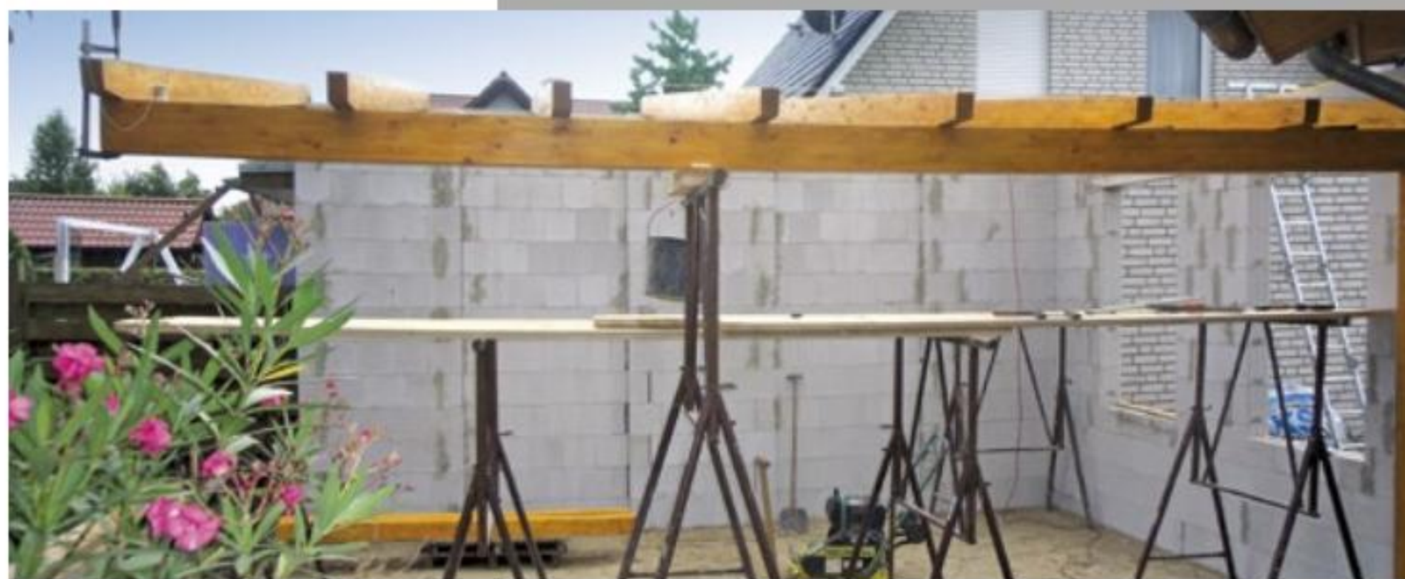
6. Die Pfetten und Sparren der Dachkonstruktion wurden zunächst provisorisch aufgelegt.
