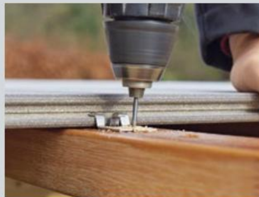
9. Dazu werden die Klammern an jeder Tragholzstelle unter die vorherige Diele geschoben, bis deren Nasen in der Nut greifen. Dann wird wegen der Härte des Holzes vorgebohrt.
