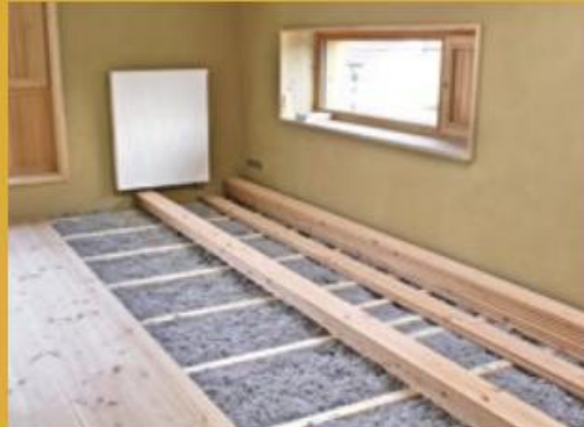
10. ... eine Zellulosedämmung lückenlos einbringen zu können. Die Douglasie-Dielen wurden verschraubt. Auch die Leitungen zu den Heizkörpern konnten so leicht verlegt werden.
