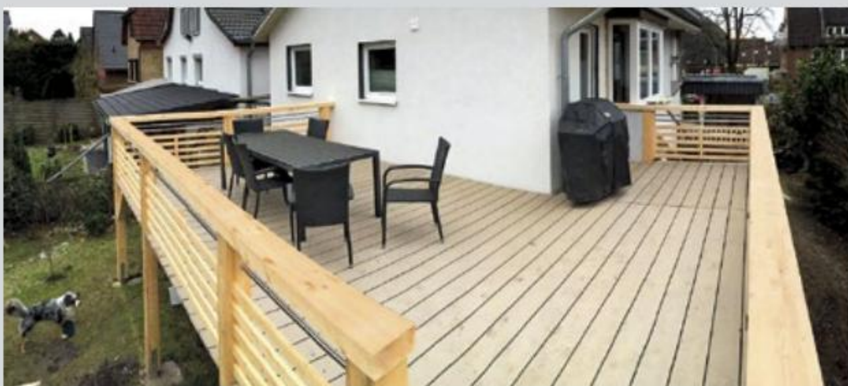
16. Die Pfosten insgesamt sind 2,60 Meter lang, das Geländer ist 90 Zentimeter hoch. Oben bildet ein Leimholzbalken einen schönen Abschluss, darunter zwei Edelstahl-Zierstäbe.
