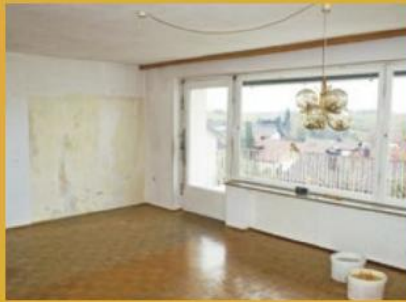
5. So sah der Wohnbereich bislang aus. Gedrungene Decke, eine Brüstung versperrt den freien Blick nach draußen und links eine Trennwand, die so nicht mehr gewünscht war, denn ...
