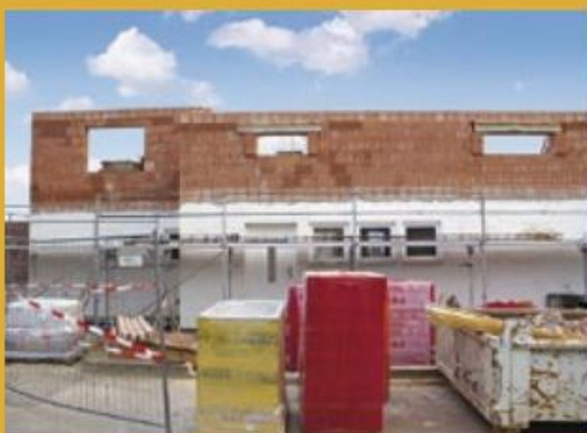
1. Der einstöckig nutzbare Winkelbungalow blieb in seiner Grundstruktur erhalten, musste jedoch auf sein Walmdach verzichten, um dann um ein Geschoss erweitert zu werden.
