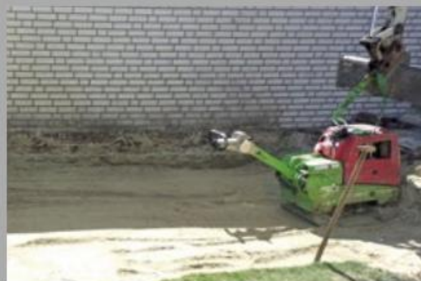
3. Dann wurde das Planum für die Terrasse aufgebaut und mit dem Rüttler verdichtet.
