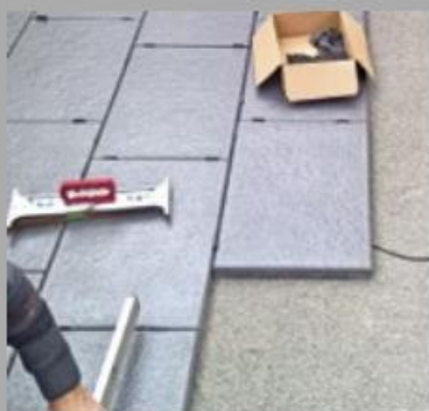
12. Fliesenkreuze zwischen den einzelnen Platten im sorgen für den richtigen Fugenabstand.
