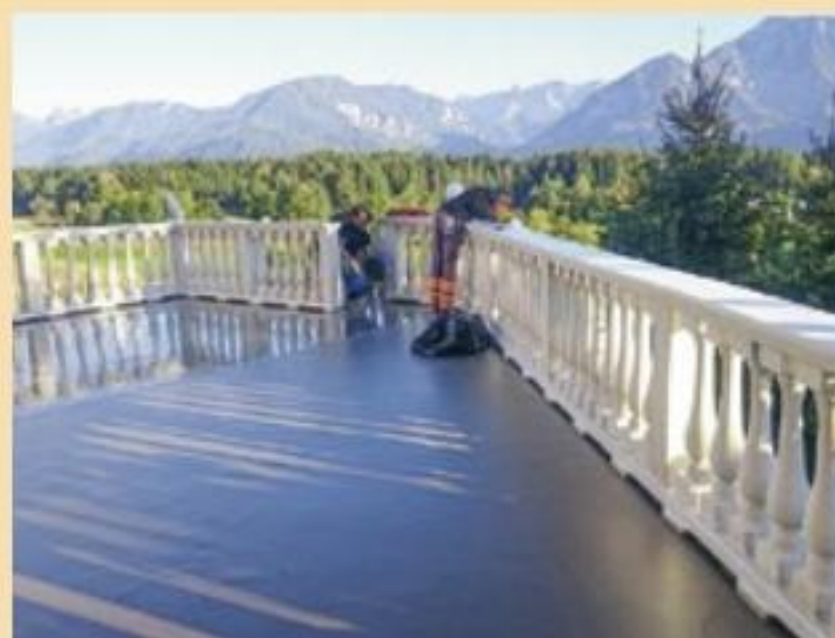
3. Mit der vliesarmierten Systemkomponente Triflex ProTerra haben sie das 70 Quadratmeter große Areal in der Fläche abgedichtet.
