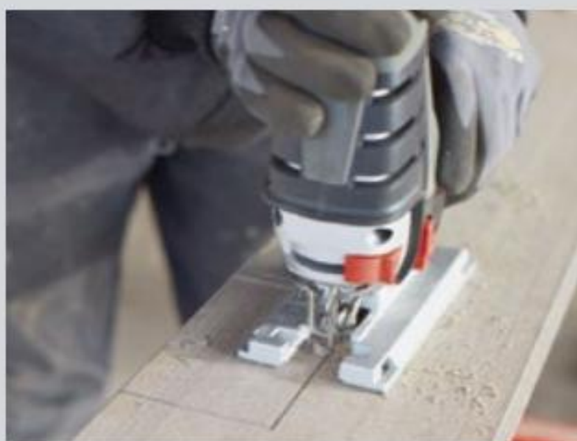
14. Für die Pfosten mussten die Dielen teilweise entsprechend ausgeklinkt werden. Das massive WPC-Material lässt sich wie Holz auch sägen (hier mit der Stichsäge) und anderweitig bearbeiten.
