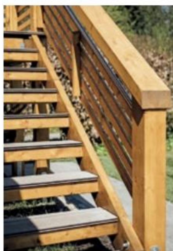
18. Und auch der neue Treppengang hat nichts mehr von einer Hühnerleiter. Die Stufen wurden ebenfalls mit WPC-Dielen belegt.
