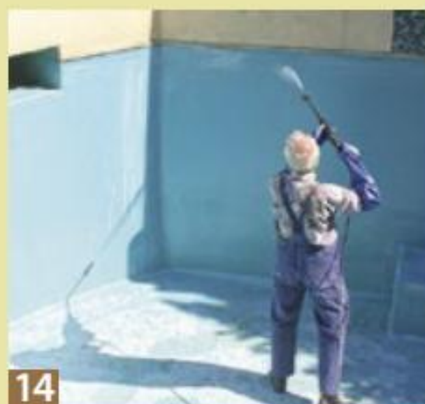
10 Mit einem Entkalkungsmittel lässt sich der Kalk auflösen und entfernen. Das Gel hat den Vorteil des besseren Stehvermögens.
