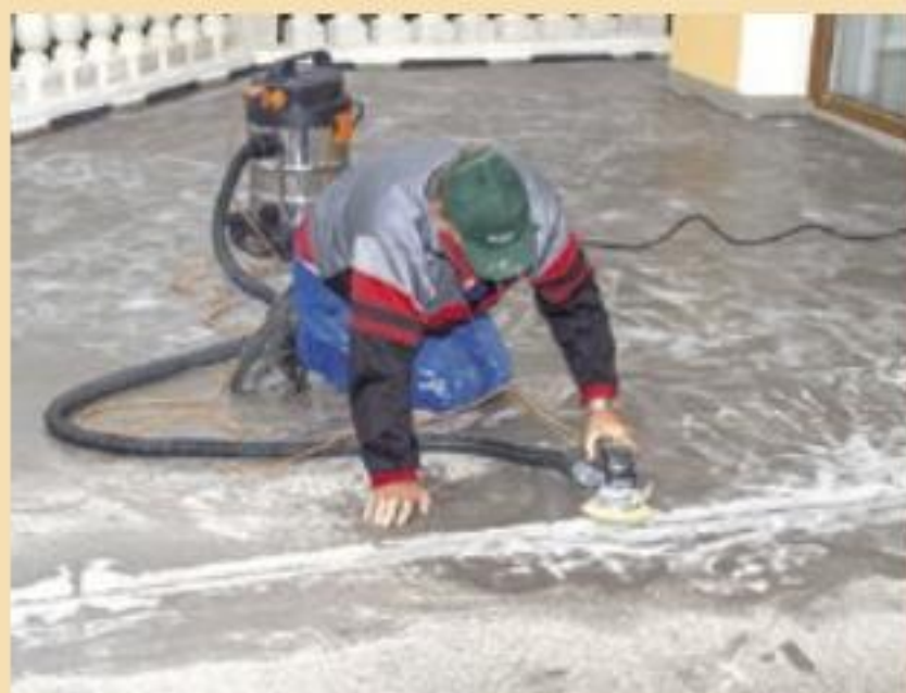
1. In einem Arbeitsschritt haben die Fachverarbeiter den freigelegten Terrassenestrich abgeschliffen und die Fläche komplett grundiert.
