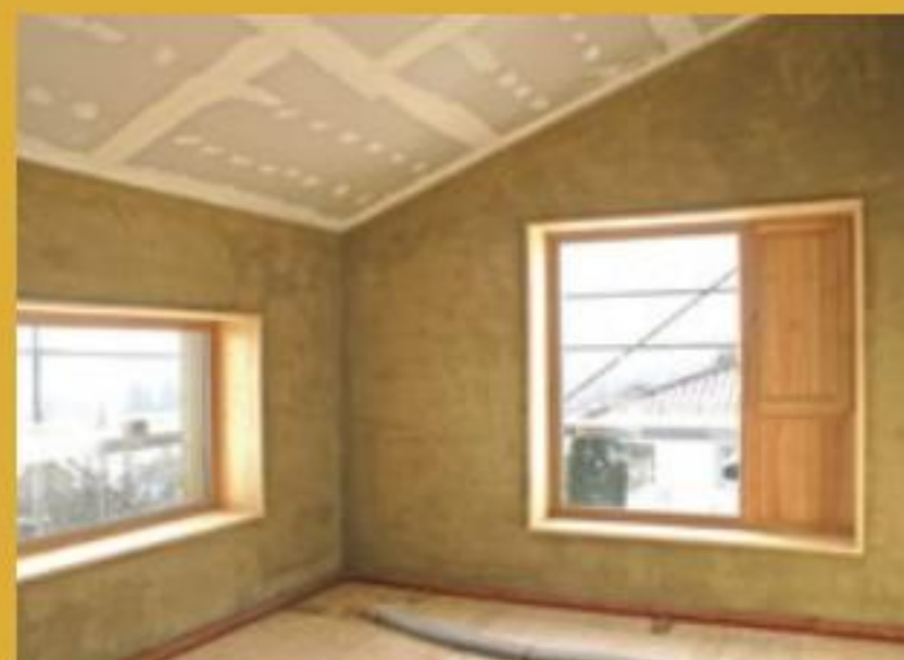
8. Gipskartonbeplankung mit Kalkputzlage bilden die innere Dachschräge, breite Fensterlaibungen aus Lärchenholz verwandeln die festen Scheiben zu markanten Bilderrahmen.
