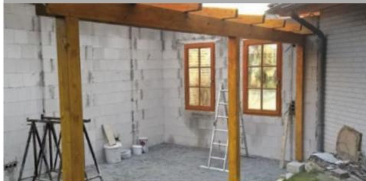
9. Dann wurden die Fenster eingebaut, die Dachgläser, die von Klemmschienen gehalten werden, kamen erst später dran.
