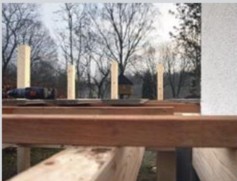
7. Nun zeigt sich der Vorteil des vorherigen exakten Aufbaus der Unterkonstruktion. Die Traglatten liegen plan auf. Sie wurden übrigens aus dem extrem harten Bangkiraiholz gefertigt.
