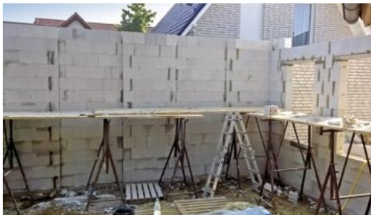
4. Die drei Meter hohe Mauer zum Nachbarn und die Wand mit den Fensterausschnitten ließ man von Handwerkern hochziehen.
