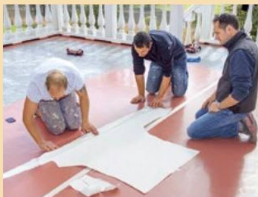
4. Zur Darstellung einer Windrose kam Creative Design zum Einsatz. Es wird auf die zuvor mit ProFloor hergestellte Nutzschicht aufgebracht.
