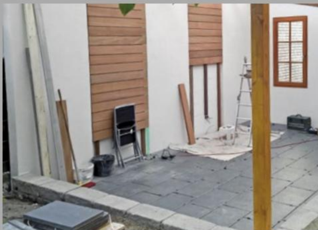
13. In die beiden Vertiefungen der Wand werden die dekorativen Hölzer mit den Lichtbändern bündig eingebaut.
