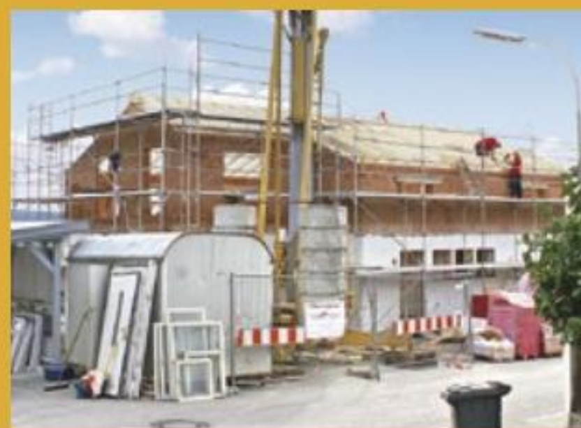
3. Dieselbe Kontur, jedoch jetzt erhöht und mit einem Satteldach versehen, das an den Giebelseiten mehr Wohnraum und Fensterplätze ermöglicht. Die Neigung fiel etwas flacher aus.
