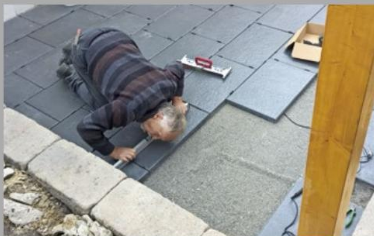
11. Die Bodenfliesen wurden dann wieder in Eigenleistung auf dem Splittbett verlegt.
