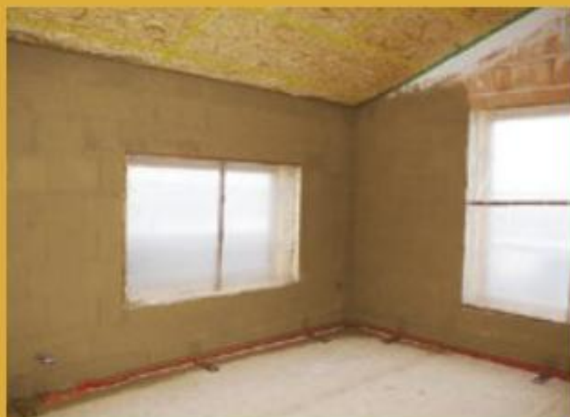
7. Im neuen Dachgeschoss sind Schlafräume und Bad untergebracht. Wohngesundheit als oberstes Gebot: Ziegelmauerwerk, Lehmputz als Wandbelag, OSB-Platten als Dampfbremse.
