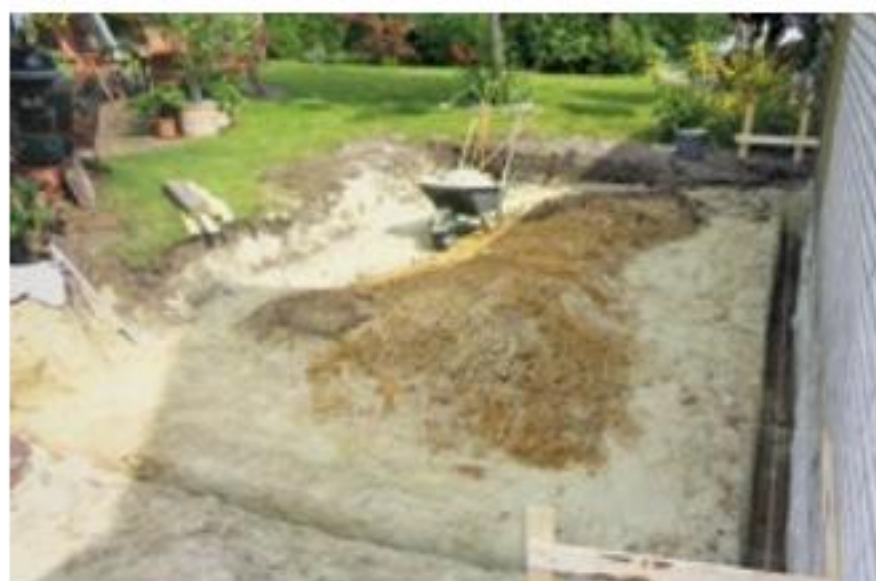
1. Die Besitzer ließen den Boden im 6 x 4 Meter großen Terrassenbereich auskoffern, dann ...
