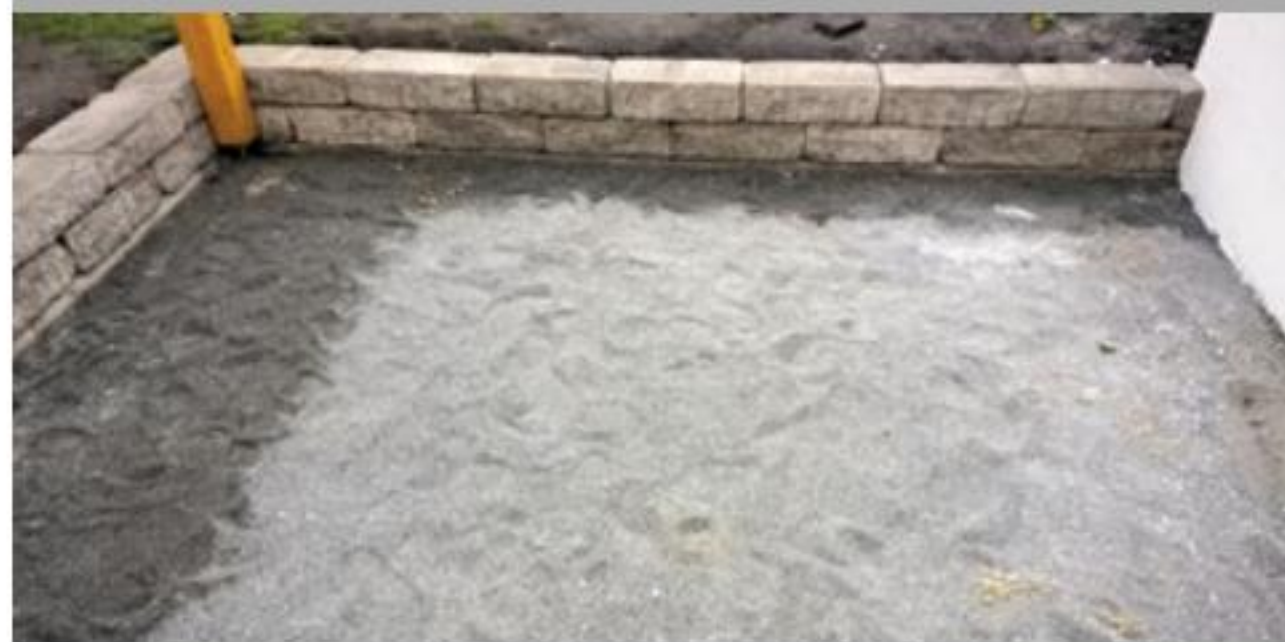
8. Die Mauersteine im Format 50 x 25 x 15 cm wurden mit etwas Montagekleber versehen und aufeinandergesetzt.
