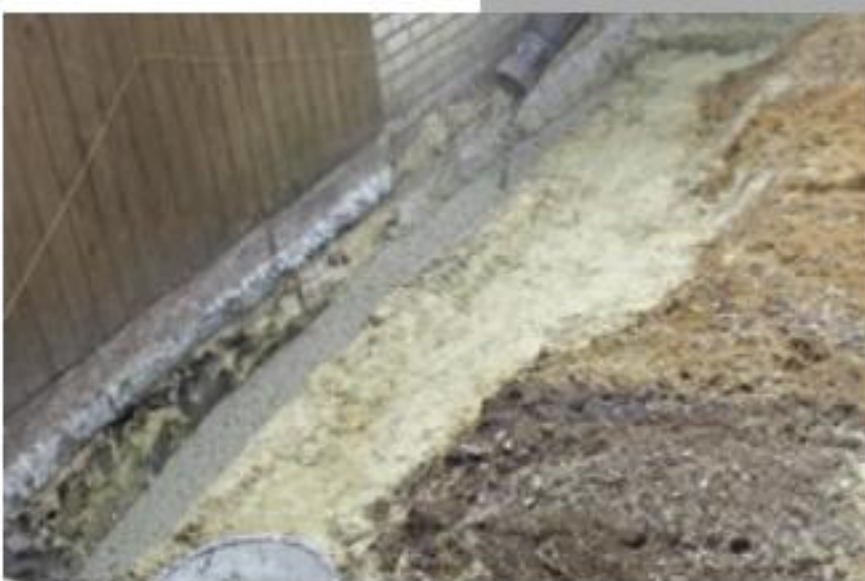
2. ... wurden die Streifenfundamente für die Mauern ausgehoben und mit Beton verfüllt.
