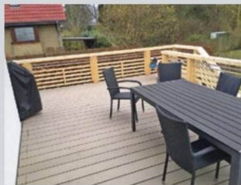
15. Zwischenzustand nach Fertigstellung. Gut zu sehen, dass die Dielen an der Fassade auf Abstand verlegt sind. Die Fuge sorgt dafür, dass sich das Material in der Länge ausdehnen kann.
