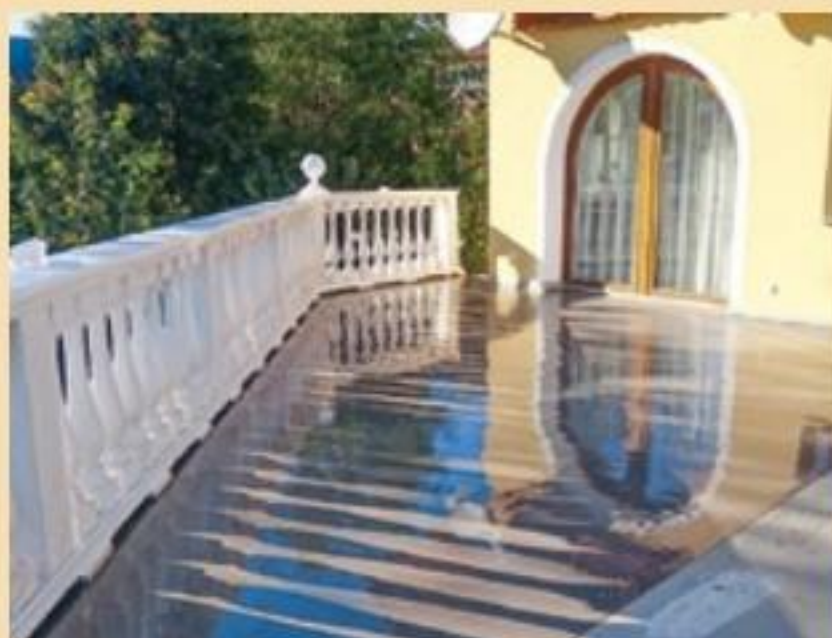
2. Zur Einbindung der Balustrade, der Wandanschlüsse und Türübergänge in die Abdichtung wurde eine spezielle Randabdichtung appliziert.
