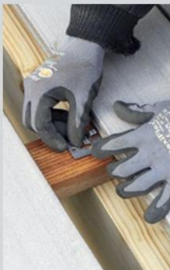
8. Zur sicheren Befestigung der Dielen werden spezielle Klammern verwendet. Diese ermöglichen eine unsichtbare Verschraubung der WPC-Dielen.
