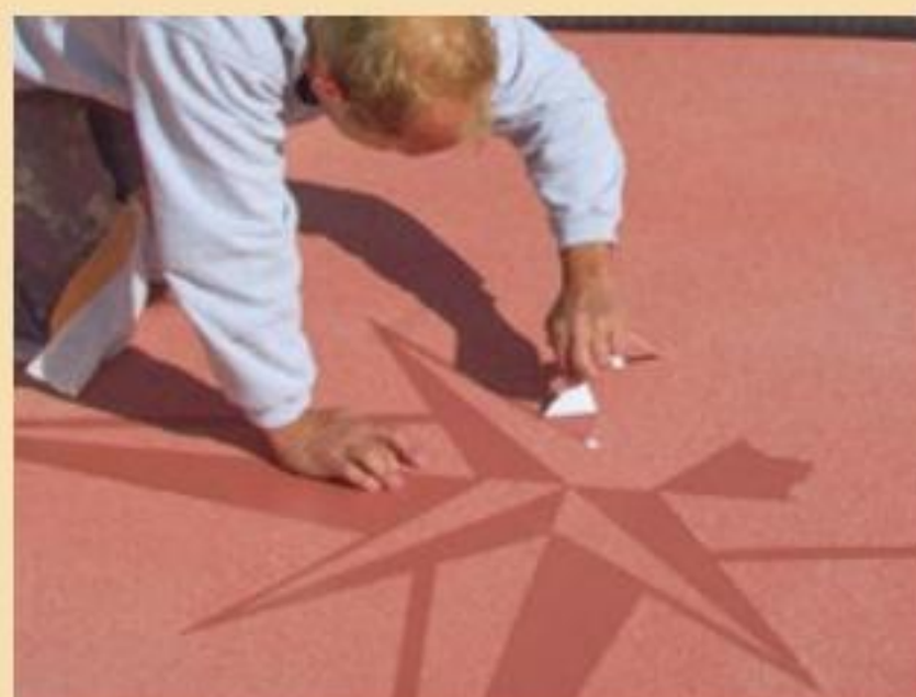
6. Die Motivfolie wird auf die erste Versiegelung aufgebracht, farblich ausgeprägt und wieder entfernt. So wird das gewünschte Motiv sichtbar.
