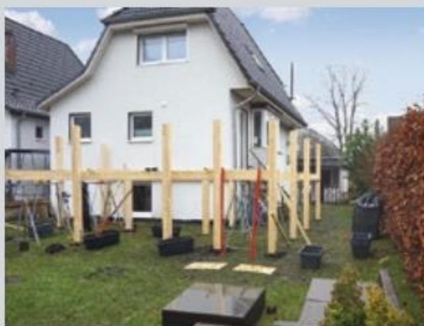
2. Die 17 Balken wurden mit H-Pfostenträgern versehen, miteinander zur Stabilisierung verbunden und über den Erdlöchern exakt ausgerichtet.
