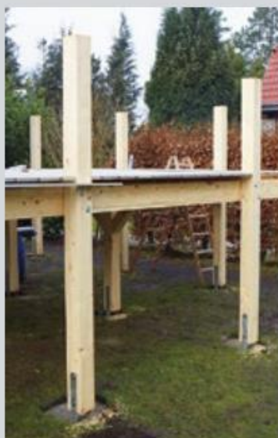
13. An der Außenkante hat man die Dielenenden etwas überstehen lassen – auch des Schutzes der Unterkonstruktion wegen.
