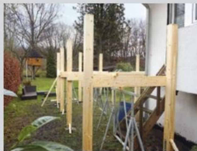
3. Die Terrasse läuft ja ums Hauseck herum und endet dann nach der bisherigen Holzstiege. Die Pfosten wurden dann auch noch bodennah ...
