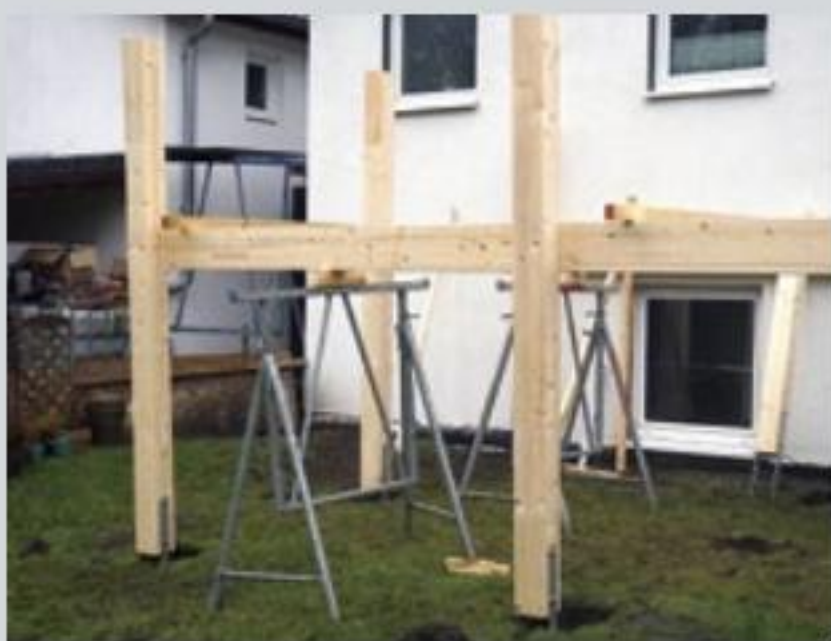
1. Für die Tragkonstruktion dienen Brettschichtbalken aus Fichte (14 x 14 cm). Diese hat man vom Zimmermann maßgenau fertigen lassen.
