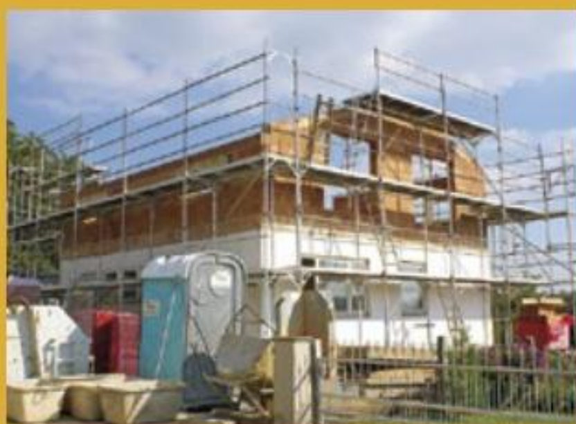
2. Das Ziegelmauerwerk ließ dann gleich auch genügend Öffnungen frei für eine optimale und dennoch ausgewogene Fensterbestückung. Die Schlafräume bekamen Kniestock-Glasbänder.
