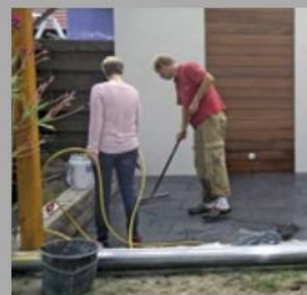
14. Nach dem Entfernen der Abstandhalter wurden die Fliesen-fugen mit Mörtel zugeschlämmt.
