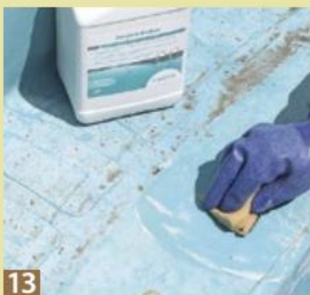
09 Nach Abtrocknen der Folie erkennt man den eigentlichen Grund der Verschmutzung: Kalkablagerung an Boden und Wand.
