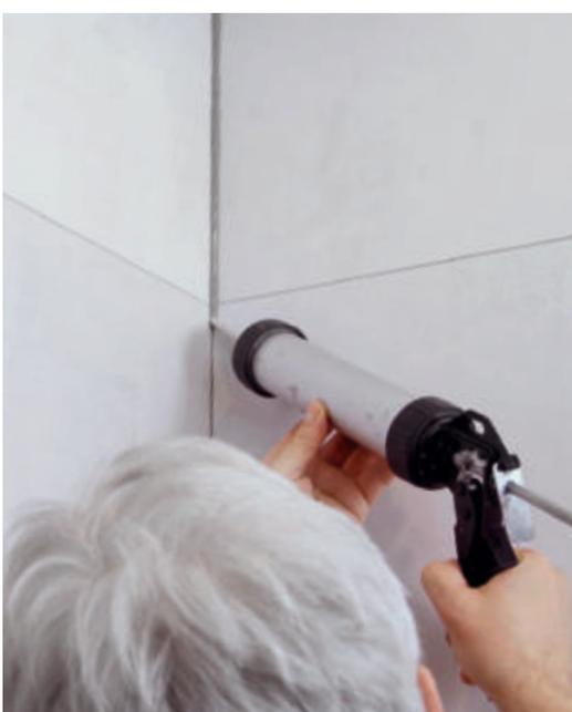
**12** Wo Fugen entstehen – im Eck und beispielsweise am Boden oder an Duschtassen – wird elastisch verfugt.
