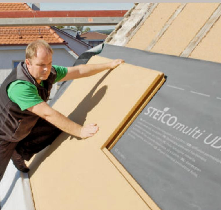
Produkte zur Auswahl. So zum Beispiel Steico Special dry. Dies ist ein Dämmstoff der neuen Generation und eine zukunftssichere Modernisierungslösung für ausgebaut, bewohnte Dachstühle. Die im Trockenverfahren hergestellte, feste Holzfaser-Unterdeckplatte sorgt für einen zusätzlichen Wärmeschutz. Sie wird oberhalb einer Bahnenlage quer zur Zwischensparrendämmung verlegt. [www.steico.de](http://www.steico.de)
