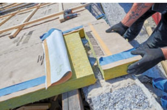
**20** Noch einmal die Problemstellung der Verbindung der Platten nebeneinander – hier sicher gelöst per Steckverbinder oberhalb der Giebelmauerkrone.
