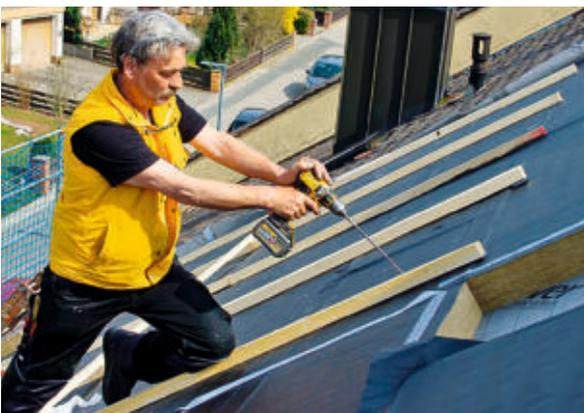
**21** Mit Doppelgewindeschrauben – wechselseitig mit 60 Grad eingedreht – befestigt man die Konterlattung und zwar durch die Dämmung bis in die Sparren. Mit ...
