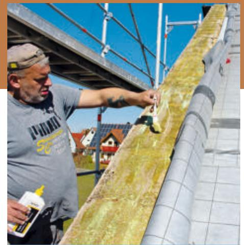
**8** Die Folie, die jetzt oberhalb der Zwischensparrendämmung liegt, ist später ein Teil der luftdichten Gebäudehülle. Als nächstes die Verklebung mit dem Giebelmauerwerk vorbereiten: Oberfläche abfeigen und Grundierung auftragen.
