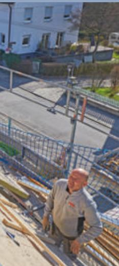
**17** Wir arbeiten uns nun weiter hoch und erreichen die Fläche neben der Gaube. Stoßversatz der Platten: 40 bis 50 cm. Vorne ist ein Dachflächenfenster eingeplant. Dieser Bereich wird jedoch erst einmal zugedämmt.
