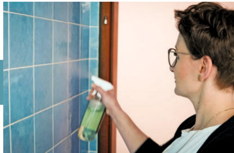
**3** Erster Arbeitsschritt: Das Reinigen und Entfetten der Fliesen. Zunächst wird ein Flächenreiniger aufgesprüht.
