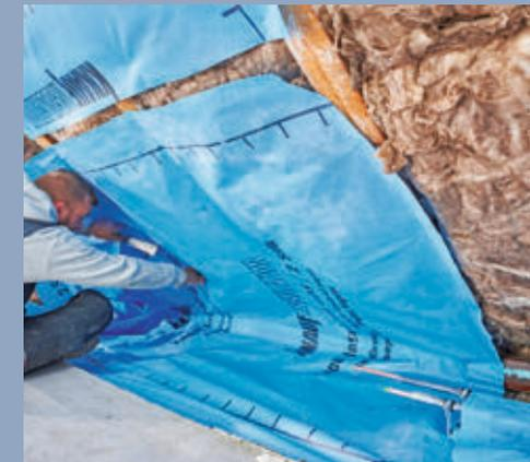
**52** Und so sieht dann die Bahnen-Verlegung aus. Die Kleberspur sorgt für den dichten Abschluss. Die Folie wird per Schlagtacker fixiert.
