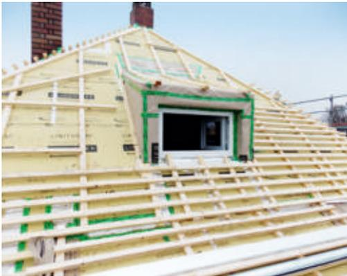
Das Hauptdach – ein Walmdach – erhielt eine Aufsparrendämmung, während der Turm wegen seiner komplizierten Zwiebelkontur und den engen Rundungen mit einer Innendämmung ausgestattet wurde.
