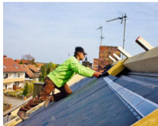
**22** ... Latten als Steighilfe arbeitet man bis zum First hoch und passt die Reststücke ein. Am besten von einer Dachseite her die Dämmelemente überstehen lassen.
