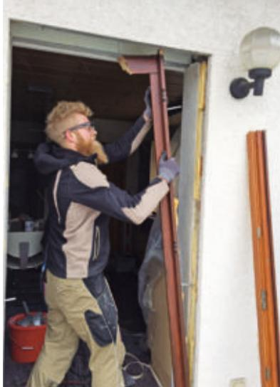
**2** ... innen zum Innenputz mit einer Trennscheibe aufschneiden (Staubmaske tragen) und dann den alten Rahmen herausbrechen.
