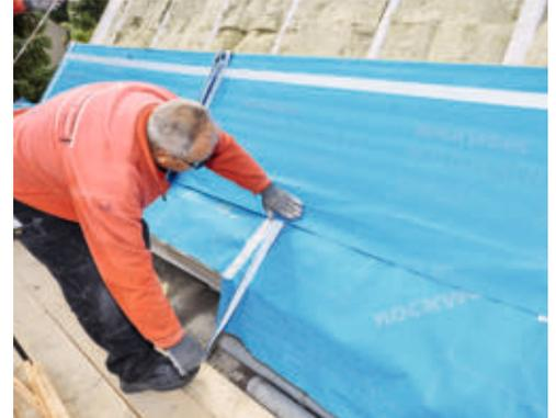
Die Klemmfilze aus Steinwolle lassen sich passgenau in die Sparrenfelder einlegen. Die querliegende Zusatzdämmung aus Steinwolle-Elementen oberhalb der Sparren wird regenwasserdicht verklebt.
