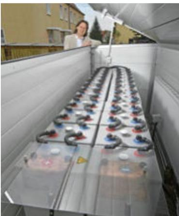
Mit dem mit Eigenstrom betriebenen Elektroauto fahren die Leukefelds etwa 7000 km im Jahr. Die Blei-Gel-Akkus zur Speicherung des überschüssigen Stroms befinden sich in einer Truhe außerhalb des Hauses.
