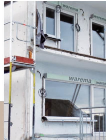
**27** Der letzte Schritt der Fenstermontage: gedämmten Rollladenkästen, die später in integriert sind. Die Stromkabel sorgen für
