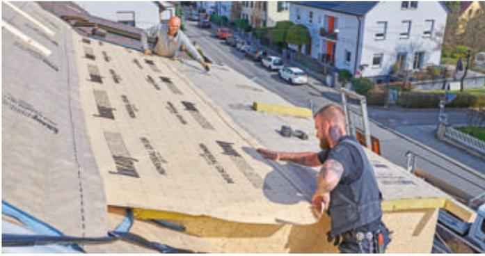
**27** Gesamtüberblick Gaubendach: Rechts sieht man, dass die Dämmplatten über die Gaubenseiten überstehen, und zwar deshalb, weil auch diese gedämmt werden (s. Abb. 30). Zuvor wird aber noch eine zusätzliche Abdeckbahn verlegt.
