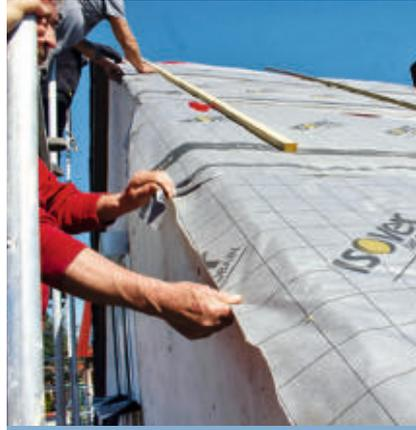
**10** Direkt im Anschluss die Dichtfolie mit kräftigem Druck (Finger oder Walze) in die frische Klebemasse einpressen.
