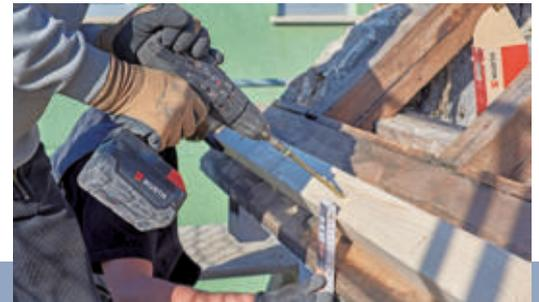
**6** Lange Schrauben greifen dann in die Dachsparrenköpfe. Die Vorderkante des neuen Schubalkens liegt in senkrechter Flucht gegenüber des verbleibenden Traufbretts.
