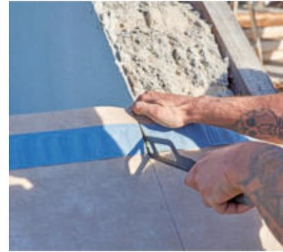
**11** Die Platte kann man auch überstehend verlegen und dann exakt an der Fassadenlinie bündig absägen.
