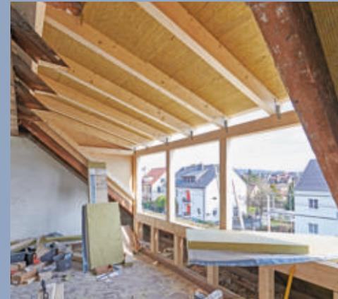
**35** Das Ganze von innen: Das Gaubendach mit seiner Aufsparrendämmung und der dreigliedrigen Frontkonstruktion für die Fenster.
