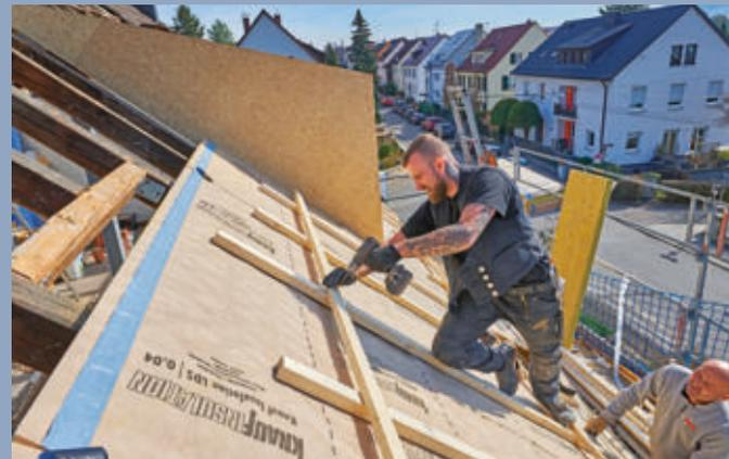
**19** Um besser und sicherer weiter nach oben zu kommen und um die Dämmplatten nicht unnötig zu belasten, werden provisorische Dachlatten auf den Konterlatten geschraubt.
