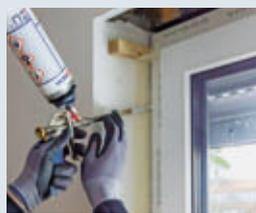
Montageschaum von innen: Bevor der luftdichte Abschluss mit Dichtband hergestellt wird, den Schaum lückenlos einbringen.
