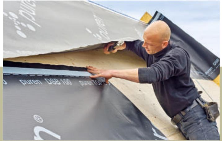
**9** ... dann, wenn sie unter die erste Bahn geschoben und angetackert wird. Wie weit die Bahn unter die obere geschoben werden muss, zeigt die gestrichelte Markierungslinie unterhalb des Klebbereichs an.
