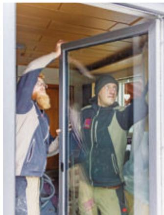
**18** Auch die Fensterflügel werden eingebaut. Den Flügel zunächst unten in den Haltestift am Rahmen einführen, dann den Flügel ausrichten.
