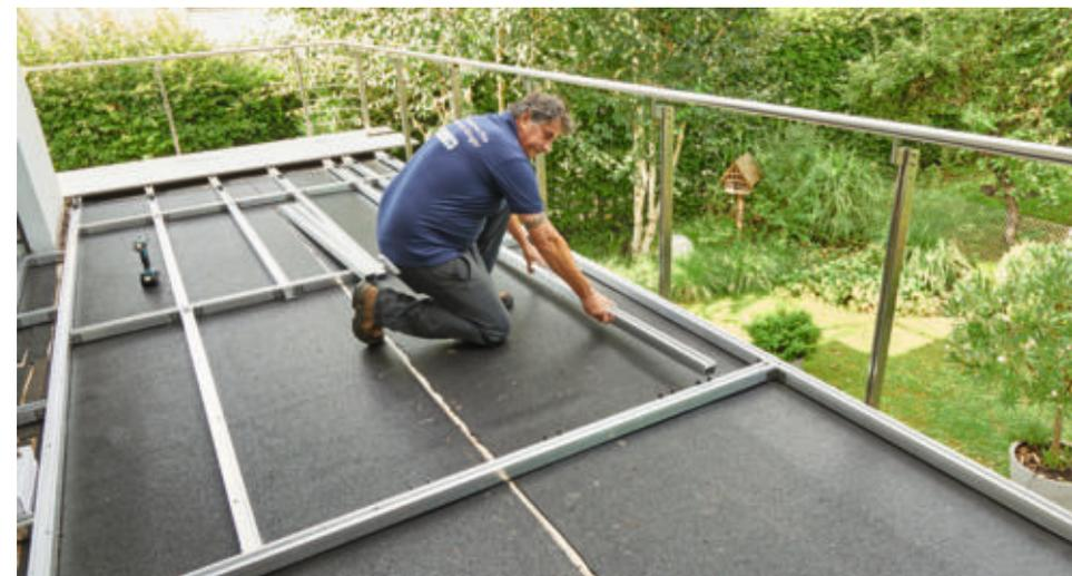
**4** Je nach Anordnung der Dielen orientiert sich die Unterkonstruktion um 90 Grad gedreht. Hier zum Beispiel eine Übereck-Balkonsituation, bei der dann auch die Dielen in Richtung Balkonkante laufen.
