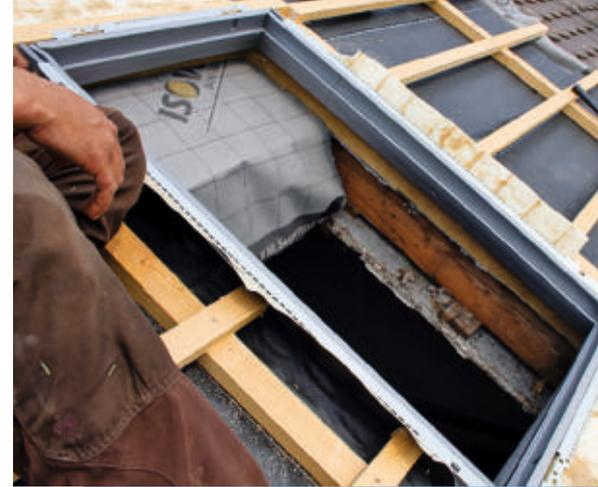
**26** Bevor der Blendrahmen eingebaut wird, den Fensterflügel aushängen. Dann die Einbautiefe festlegen, damit das Fenster später in der richtigen Höhe sitzt.
