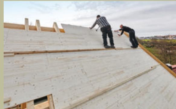
**3** Deswegen wurde der gesamte Dachaufbau oberhalb der Sparren angelegt. Zunächst dient eine Holzschalung als Untergrund bzw. als Sichtfläche zum Raum hin.
