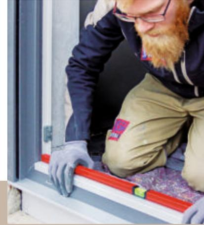
**10** Die Rahmen nun mit der Wasserwaage ausrichten. Wenn später die Fassade gedämmt wird, sollten die ...
