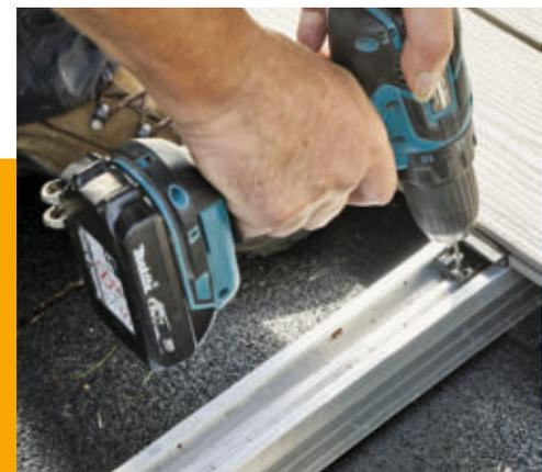
**6** Dann werden die Clips auf der Unterkonstruktion festgeschraubt. Der Fugenabstand stellt sich dann automatisch auf 4,5 mm ein.
