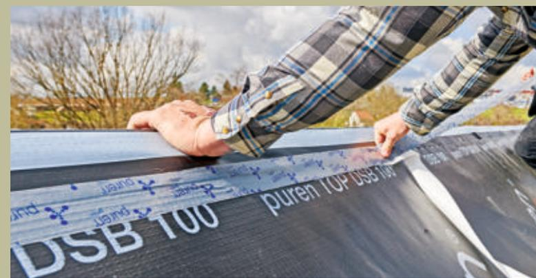
**16** Dieser Überlappungsbereich wird dann mit einem Klebeband abgedichtet.
