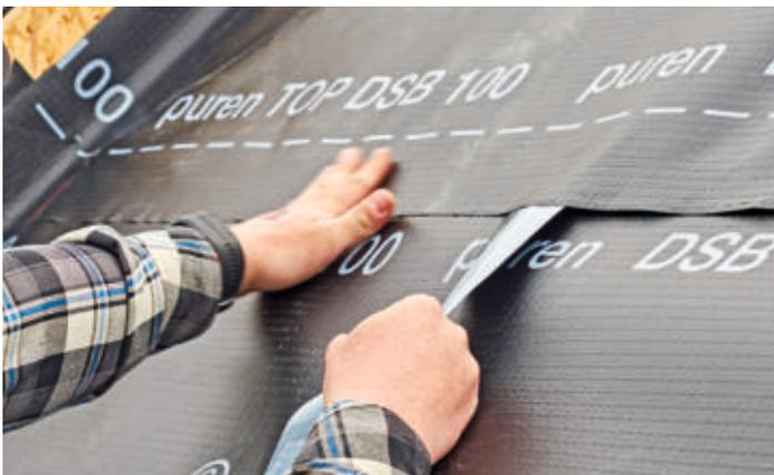
**10** Alle Bahnen untereinander werden über die Selbstklebestreifen regendicht verklebt. Die Überlappungsbreite ist dabei leicht einzuhalten, die Schutzfolie wird einfach abgezogen und die Verklebung mit den Fingern hergestellt.
