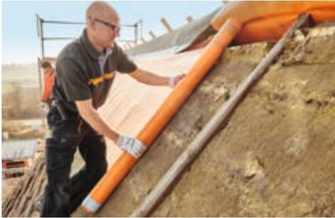
Mit über der Altdämmung verlegter Dampfbremse war der Neuaufbau der Polyurethan-Dämmung problemlos und wegen der Großformatigkeit auch recht zügig vonstatten gegangen.
