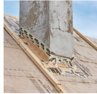
**29** Penibel dicht ausgeführt werden muss zudem die Schornstein-Einbindung hin zur Dämmebene.
