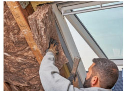
**42** Damit hier die Dämmwollestreifen auch sicher fixiert werden können, empfiehlt sich ein Schlagtacker, mit dem man schnell punktuell Klammern setzt.
