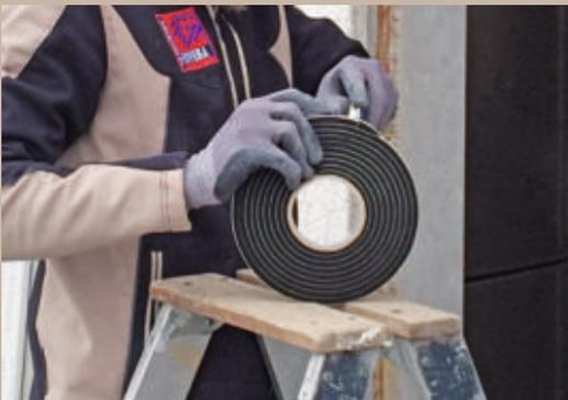
**6** Die Montage beginnt mit dem Aufkleben eines vorkomprimierten Dichtungsbands („Komtriband“). Einmal rund um den Fensterrahmen abrollen. Es ist selbstklebend.
