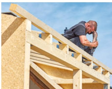
**23** Am Ende der Gaubendachsparren wird frontbündig ein Kantholz befestigt – als untere Begrenzung für die Dämmplatten.
