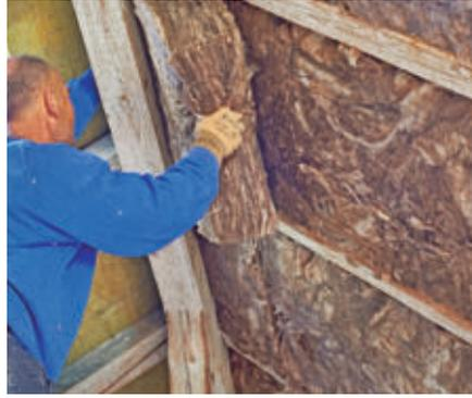
**48** Wir sind jetzt erst einmal wieder bei der Dachschräge, wo der Zimmerer gerade die Gefache bis hoch zum First ausdämmt.
