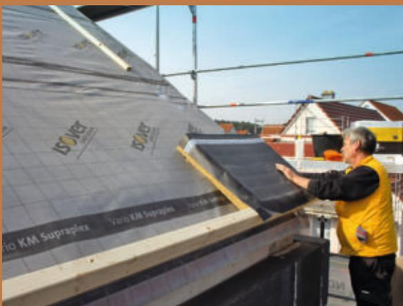
**17** ... Aufsparrendämmung anschrauben und die erste Dämmplatte direkt daran anlegen. Diese Dämmelemente sind aus hochverdichteter und formstabiler Steinwolle.
