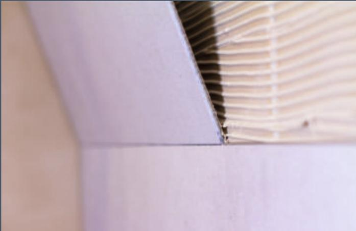
**5** Die untere Reihe ist gelegt, oben mit dem Rest der letzten Platte beginnen oder im Halbverband verkleben. Platte aufsetzen und ins Kantenprofil eindrehen.
