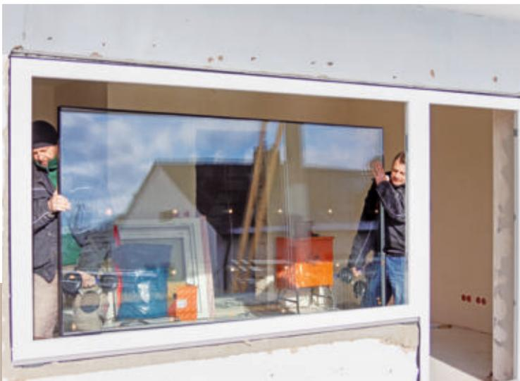
**16** ... können aber auch schwere Scheiben von zwei Personen gut transportiert und im Fensterrahmen justiert werden. Festglasteile werden grundsätzlich von innen eingebaut. Der nächste Schritt ist dann ...
