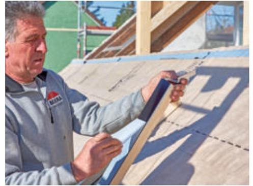
**14** Das Selbstklebeband hat auch unten noch eine Schutzfolie, die dann kurz zuvor abgezogen wird, bevor man die Latte auf der Dämmung verschrauben möchte.
