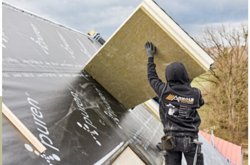
**31** Hier noch einmal die schalltechnisch optimierende Unterseite des Systems. Die Steinwolle-Kaschierung ist absolut formstabil und hochverdichtet. Somit ist bester Schallschutz im Zusammenspiel mit der sehr guten Wärmedämmeigenschaft des Polyurethans gegeben.
