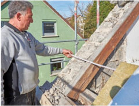
**9** Schon bei der untersten Plattenreihe daran denken, die Dämmlage bis ganz über die Giebelmauer zu ziehen. Das Restelement wird exakt bemessen zugeschnitten.
