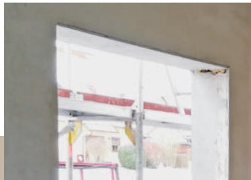
**5** Eine oben angeschraubte Zementbauplatte schließt den alten Kasten ab. Die Abbruchlaibungen werden glatt verputzt.
