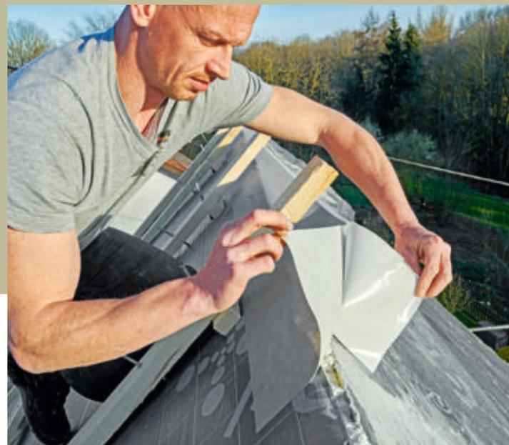
**27** Um auch hier eine wasserdichte Überdeckung zu bekommen, wird ein breiter selbstklebender Folienstreifen über den Firstgrat gezogen und beidseitig zu gleichen Teilen auf der Unterdachbahn verklebt.
