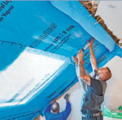
**53** Die Dachschräge erhält die nächsten quer verlegten Dampfsperrenbahnen, wobei Stöße und Überlappungen sorgfältig ...
