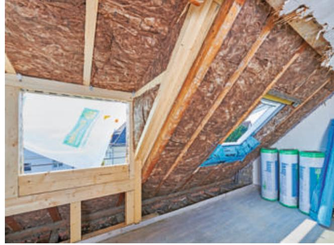
**49** Jetzt vervollständigt sich das Dämmbild. Die Dachschrägen werden bis zum Fußpunkt gedämmt, später wird aber eine Drempe wand hochgezogen – in Verlängerung der Gaubenkonstruktion.
