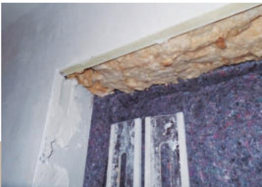
**4** Die alten Rollläden entfernen und den Hohlraum mit Mineralwolle füllen. Die neuen Rollladenkästen werden später in der Außendämmung integriert.
