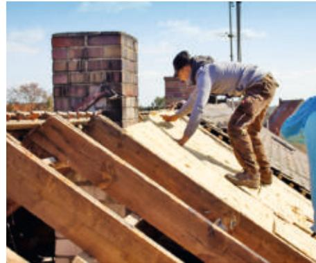
**4** Nun können gleich die ersten Dämmplatten für die Ebene zwischen den Sparren zuge-schnitten und eingebaut werden. Die Platten seitlich etwas zusammenpressen und einfügen.
