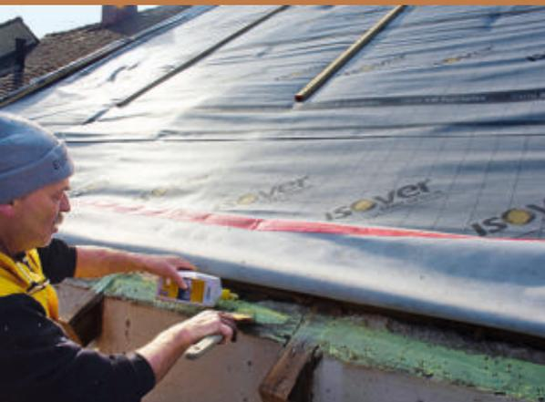
**14** Der traufseitige, luftdichte Anschluss der Folie an die Außenwand-Mauerkrone wird ebenfalls mittels Primer vorbereitet, den man mit Pinsel oder Rolle auftragen kann.
