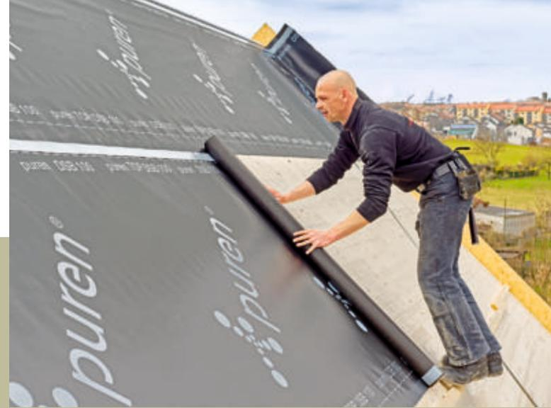
**8** Die nächste Bahn wird unterhalb der ersten ausgerollt. Die Standlatten am besten im entsprechenden Abstand fixieren, sodass die Rolle auch ungehindert verlegt werden kann oder auch nicht abrutscht. Den ersten Halt findet sie ...
