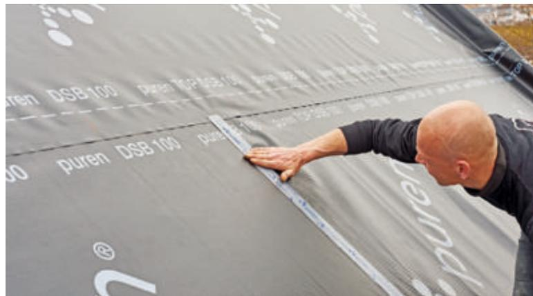
**11** Dort, wo senkrechte Stöße vorkommen, erhalten diese eine Abdichtung mit Hilfe eines Spezialklebbandes. Das kommt jedoch selten vor, da die Bahn mit 50 Laufmeter Länge quasi immer von Ortgang zu Ortgang verlegt werden kann.
