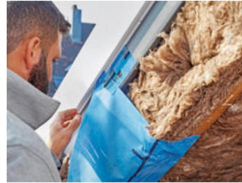
**46** Die Folie reicht dann bis zur Nut des Fensterrahmens und wird dort mit Klebeband abgedichtet. Die Folie hält auch die Dämmung fest.
