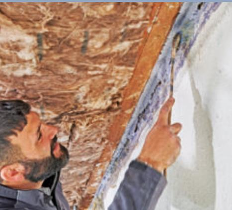
**50** Vorbereitung fürs Ankleben der Dampfbremse an der Innenseite der Giebelwand. Dazu wird ein Haftverfestiger aufgetragen.
