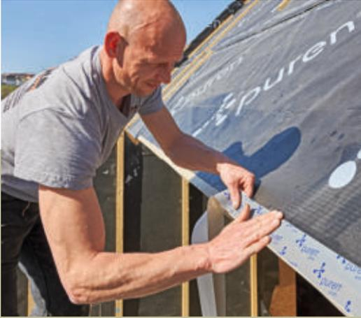
**18** Am Rand der Brettschalung oberhalb der Dachterrasse endet die Bahn kurz zuvor und wird auch hier per Klebebandüberdeckung dicht angeschlossen.
