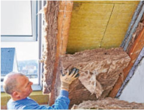
**44** Ideal ist es übrigens, in der Dämmebene zwischen den Sparren eventuelle Heizungs- oder Stromleitungen zu verlegen. Das Dämmmaterial deckt dann alles ab.
