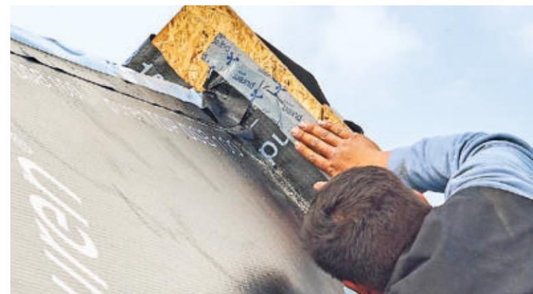
**12** An den Ortgangbrettern rechts und links werden die Bahnenenden jeweils entsprechend gekürzt und zwar so, dass sie noch am Brett hochgezogen werden können. Dort werden sie ebenfalls rengedicht mit Klebebändern angeschlossen.
