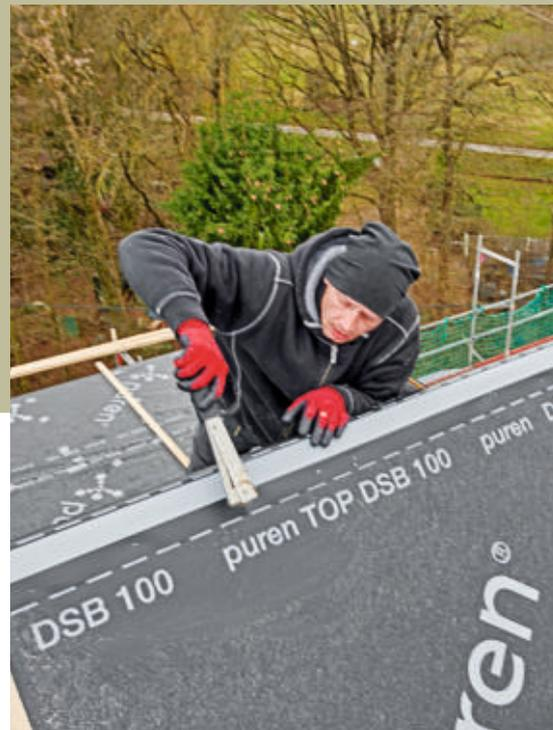
**15** Die oberste Folienbahn wird über den First hinübergezogen bis herunter auf Höhe der Markierung der ersten Bahn der anderen Dachhälfte und dort angetackert.
