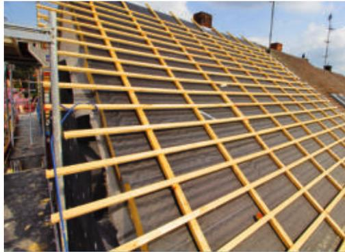
**24** Auf den Konterlatten werden die ziegeltragenden Dachlatten (Querschnitt 40 mal 60 Millimeter) mit Schrauben oder Nägeln sicher befestigt.
