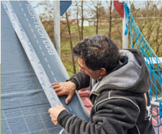
**30** Dicht wird es hier wiederum mit Hilfe eines Klebebands, das die Kante überdeckt. Damit ist die Ausführung eines wasserdichten Dachrands dauerhaft gegeben.
