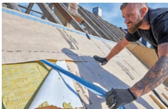
**21** Die Längsüberlappung wird immer in gleicher Weise ausgeführt: Schutzfolie abziehen und innerhalb des Überlappungsbereichs die beiden Bahnen zusammenkleben.
