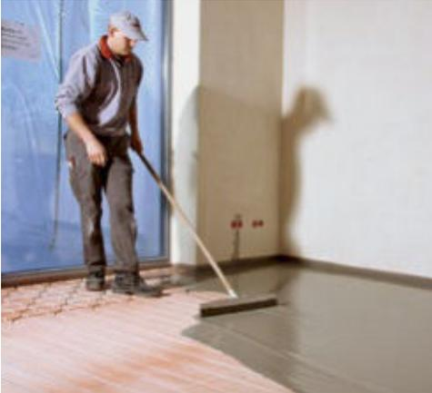
Die 3 mm dicke zementäre Vergussmasse ist bereits nach drei Stunden begehbar.
