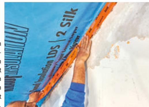
**57** Nachdem man die Folie etwas herübergezogen und in den Kleber gedrückt hat, überklebt man den Nahtbereich noch einmal mit einem Klebeband.
