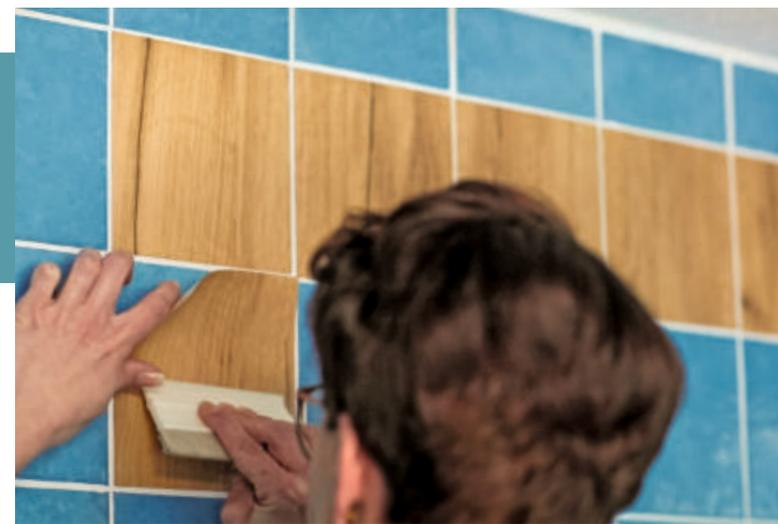
**10** ... Raker wird jedes Folienquadrat vollflächig angerieben, auch um etwaige Luftpneinschlüsse zu vermeiden.
