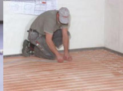
Nach dem Einbringen der Platten werden die Rohre in die vorgefertigten Nuten gedrückt.
