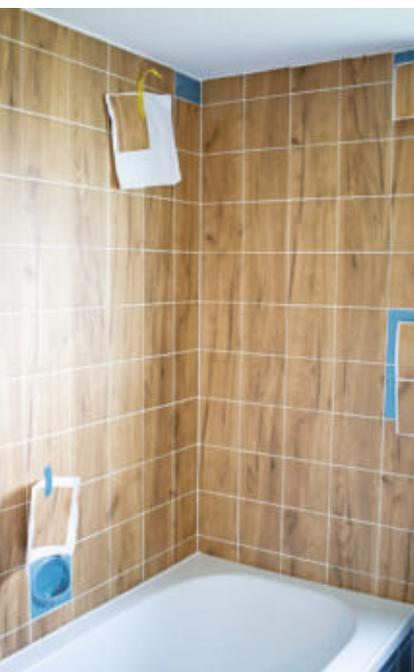
**11** Bis auf ein paar Reststellen sind die beiden Eckwände an der Badewanne fertig. Die Holzmaserung verläuft über die gesamte Fläche.
