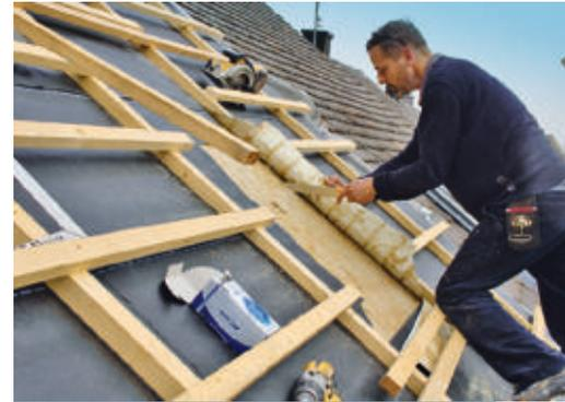
**25** Einbau Dachflächenfenster: Fensteröffnung auf der Unterdeckbahn exakt markieren und danach die Dämmung herauschneiden.
