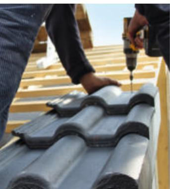
**31** Damit das Dach durch Windsogspitzen nicht abgedeckt werden kann, die Dachpfannen mit Sturmklammern fixieren. Die Ortgangpfannen bekommen eine Verschraubung.
