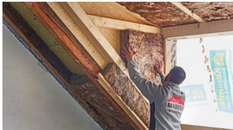
**43** Die Gaubenseiten sind ja mit Balken konstruiert, sodass hier die Dämmwolle einfach bis zur OSB-Platte eingedrückt werden kann. Als Kante für die spätere Gipsplattenverschalung setzt man entsprechende Latten am Sparren an.
