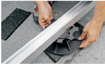
**2** Sie können auf ebenem Untergrund plan aufgelegt werden (Balkon mit geringer Aufbauhöhe) oder auf Stelzlagern, die sich höhenverstellen lassen.
