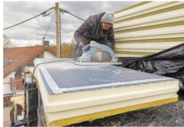
**22** Hier einmal im Detail der Plattenaufbau – unten die Lage aus Mineralwolle. Mit einer großen Säge sind die Elemente gut zu bearbeiten, gegebenenfalls von beiden Seiten aus sägen.
