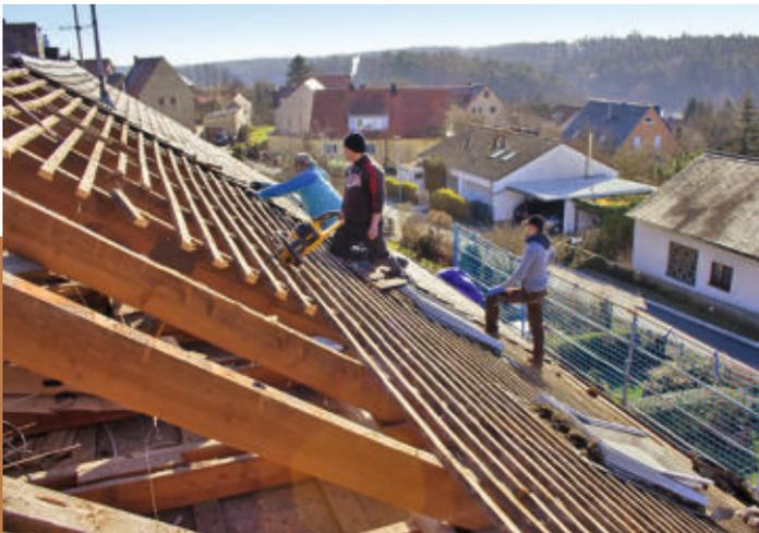
**3** Jetzt die ersten Dachlatten z. B. mit einem Brecheisen entfernen. Vom First beginnend, zunächst in einen Bereich von etwa zwei Metern die Sparren freilegen. So bieten die übrigen Latten noch eine sichere Standfläche.
