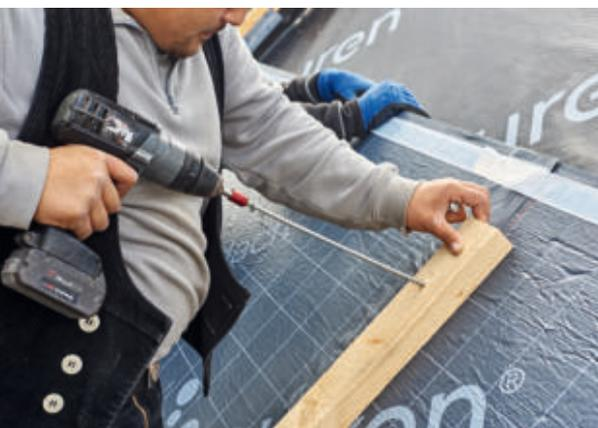
**32** Die Konterlattung besteht aus Kanthölzern, die immer in Sparrenlage durch die Dämmung verschraubt wird. Das kann man etappenweise machen, um so auch leichter ...
