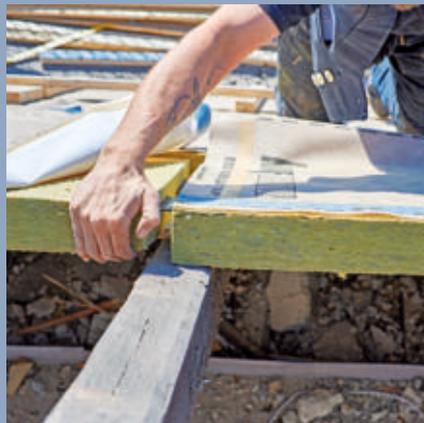
**18** Wenn – wie hier – der Plattenstoß knapp am Balken vorbei verläuft, behilft man sich wieder mit den Kunststoffverbindern (vgl. S. 19 unten).
