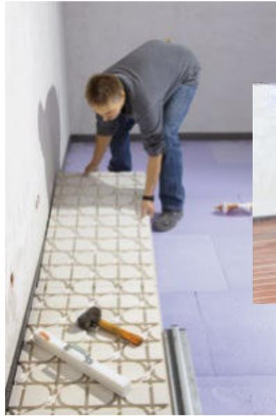
Die Gipsfaserplatten werden per Klick-System zu einer stabilen Fläche verbunden.
