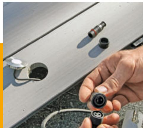
**8** Ebenso ist es möglich, trotz niedriger Aufbauhöhe, ein Beleuchtungssystem einzubauen. Die flachen LED-Spots werden wasserdicht verkabelt.
