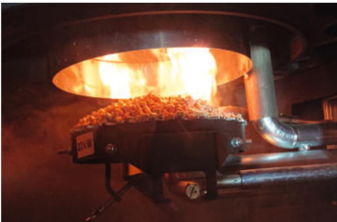
Der Pelletskessel der Kunklers mit einer Heizleistung von 25 Kilowatt unterstützt die Solarthermieanlage auf dem Dach vor allem im Winter.
