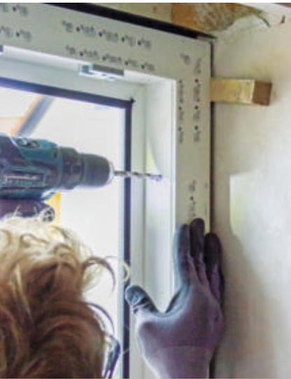
**13** Nun Löcher etwa 10 bis 15 cm vom inneren Rahmeneck durch den seitlichen Fensterfalz bohren.
