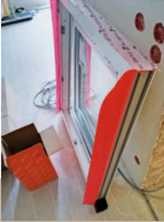
**8** Raumseitig ein selbstklebendes Dichtband andrücken, das später mit der Laibung verklebt wird (s. Abb. 22).
