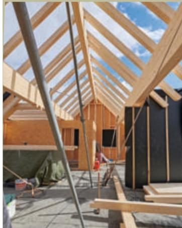
**2** Das neue Dachstuhlgebälk stellt eine imposante Konstruktion dar und sollte später im Dachraum sichtbar bleiben.
