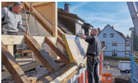
**7** Das erste Dämmelement wird verlegt: Es kann von rechts oder von links her gearbeitet werden, da die Mineralwolleplatten gerade Schnittkanten haben.
