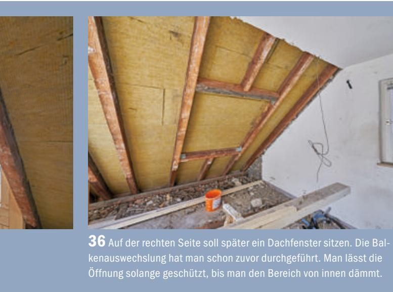
**36** Auf der rechten Seite soll später ein Dachfenster sitzen. Die Balkenauswechslung hat man schon zuvor durchgeführt. Man lässt die Öffnung solange geschützt, bis man den Bereich von innen dämmt.
