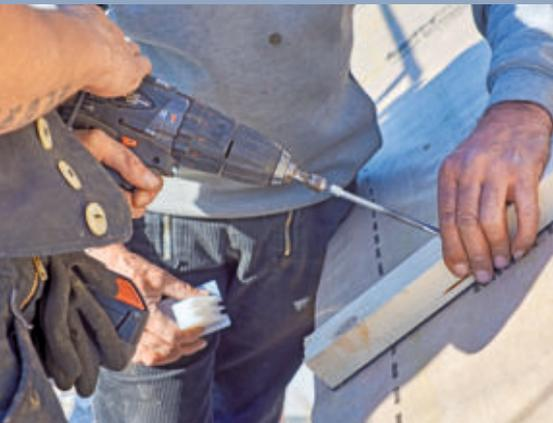
**15** Dann heißt es wie bei allen Aufsparrendämmsystemen bzgl. der Windkräfte, die am Dach wirken können: Einmal so im 60-Grad-Winkel schrauben, ...
