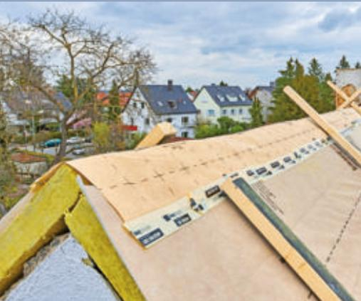
**33** Am First lässt man die beiden Dämmlagen dicht aneinanderstoßen und überdeckt den First mit einem breiten Streifen Unterspannbahn.
