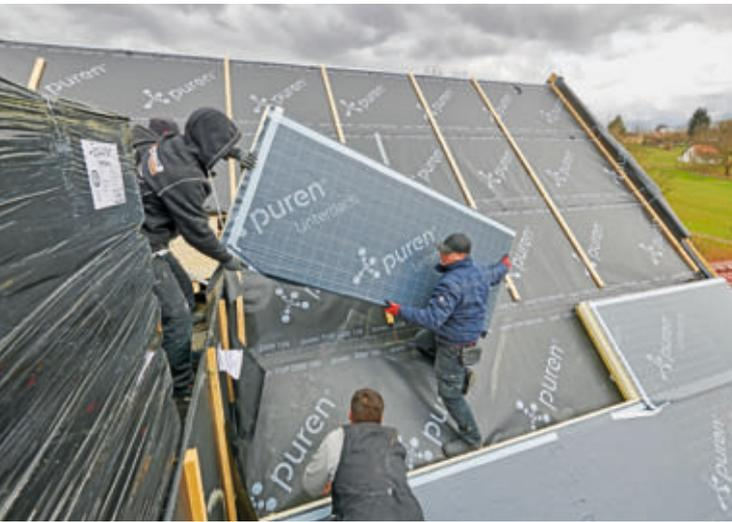
**21** Mit den recht großen Elementen ist eine Dachfläche dann schnell gedämmt. Die Platten werden im versetzten Verband (also ohne Kreuzfugen) verlegt.
