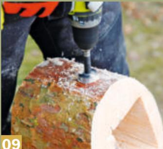
**09** In der oberen Hälfte wird mit einem Forstnerbohrer das Einflugloch gebohrt. Für Kohlmeise und Sperling: 35 mm, für andere Meisen: 30 mm.
