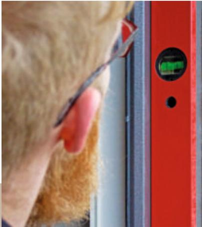
**11** ... Rahmen im Idealfall bündig mit der alten Fassade sitzen, damit die Dämmung übers Profil laufen kann.
