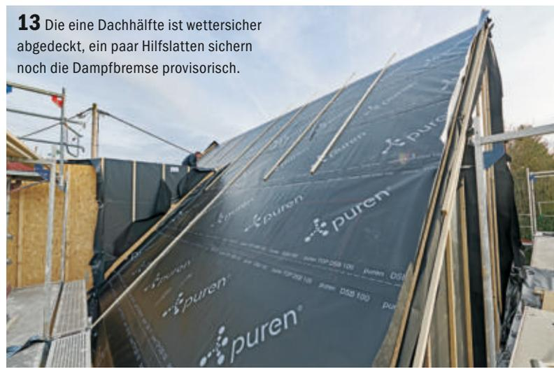
**13** Die eine Dachhälfte ist wettersicher abgedeckt, ein paar Hilfsplatten sichern noch die Dampfbremse provisorisch.
