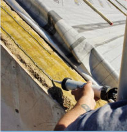
**9** Nachdem die Grundierung getrocknet ist, werden zwei Kleberaupen der zweikomponentigen Klebe-Dichtmasse aufgezogen.
