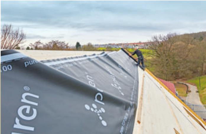
**6** Damit man im Weiteren die glatte Holzfläche sicher begehen kann, schraubt man ein paar Hilfslatten horizontal an den Sparren an. Nun folgt die Verlegung der Dampfsperrbahn (Konvektionssperre) in Querrichtung. Oben beginnend ...
