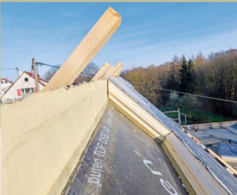
**26** Wenn beide Dämmlagen zusammentreffen, bleibt im optimalen Fall nur noch ein schmaler Spalt zwischen den Schnittflächen. Dieser wird dann noch mit PU-Schaum lückenlos verfüllt. Damit schließt die Dämmung auch hier wärmebrückenfrei ab.
