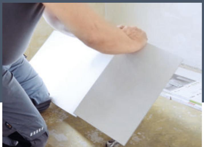
**11** ... muss man nicht einmal ganz durchschneiden – anritzen und abbrechen genügt. Die Bruchkante wird dann mit einem Klingenzug (Cutter) entgratet.
