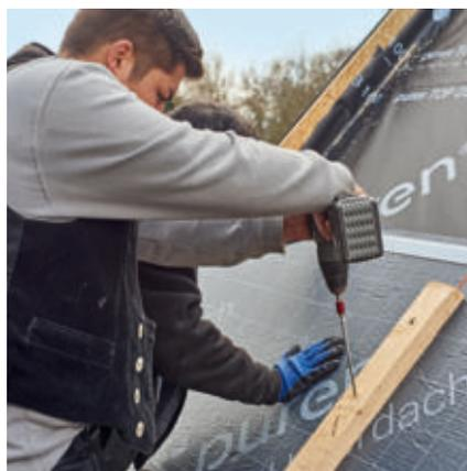
**33** ... von unten nach oben zu arbeiten. Also: Dämmplatte verlegen, Konterlatte setzen, dann in der nächsten Reihe oberhalb weiter dämmen.
