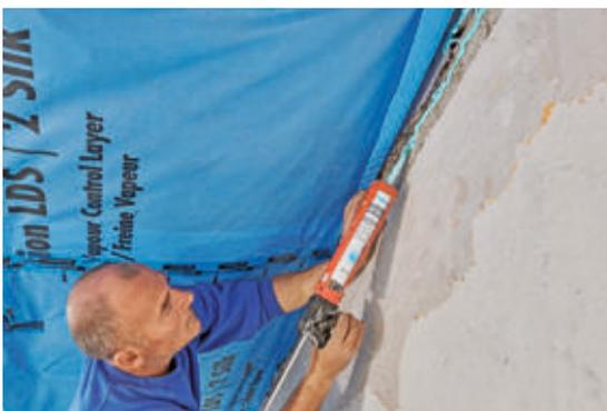
**56** Noch ein neurralgischer Punkt: Die Folie muss auch an der Giebelwand dicht verlegt sein. Derselbe Kleber sorgt auch hier für absolute Dichtheit und festen Halt.
