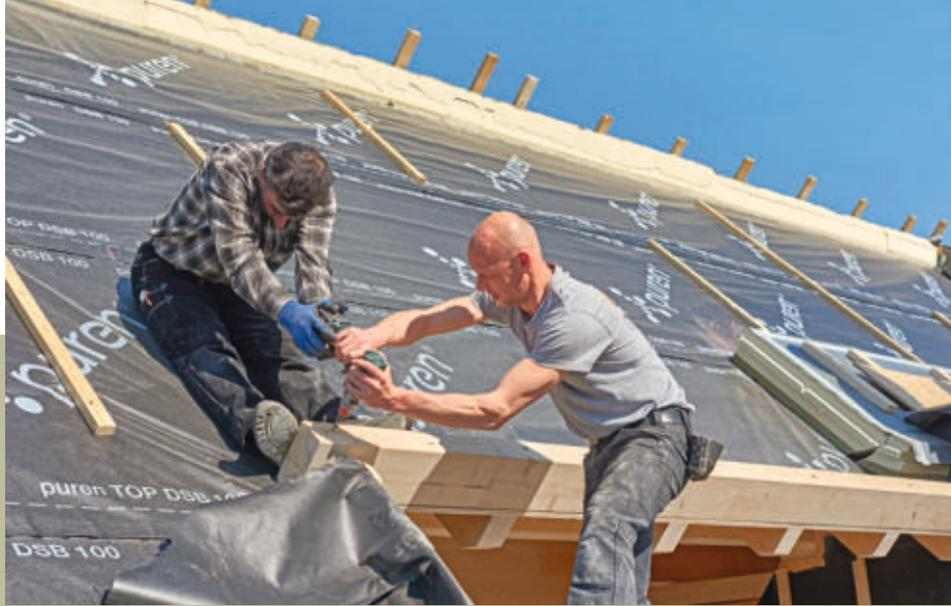
**19** Die Dachkante wird dann – wie am Hauptdach auch – mit einem Kantholz in Dämmplattendicke ausgebildet. Mit langen Schrauben bis durch in die Sparrenköpfe hält dieser Balken dann sicher fest.
