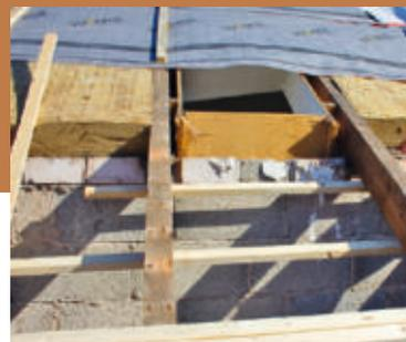
**6** ... so nicht durchs Betreten beim Arbeiten beschädigt. Mit einer provisorischen Sicherung längs der Sparren mit Hilfe von Latten bleibt die Folie auch bei Windböen sicher liegen.
