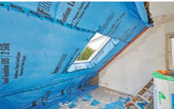
**58** Luftdicht eingepackt und in zwei Ebenen gedämmt – dem weiteren Innenausbau steht nichts mehr im Weg. Es folgt die Innenbeplankung sämtlicher Dachflächen.
