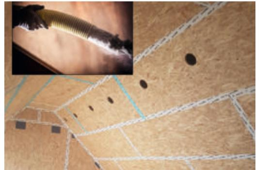
Drei Dachsituationen für die Einblastechnik: Links eine Dampfbremsbahn als innerer Abschluss, oben die Variante mit OSB-Platten. Unten wird zwischen einer Dachschalung und der Gipsplatteninnenschale ausgeblasen.
