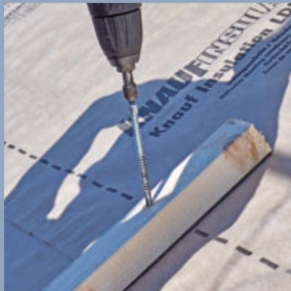
**16** ... und an der nächsten Schraubstelle einmal so. Mit entsprechenden Gewindeschrauben geht das dann übrigens auch ohne Vorbohren.
