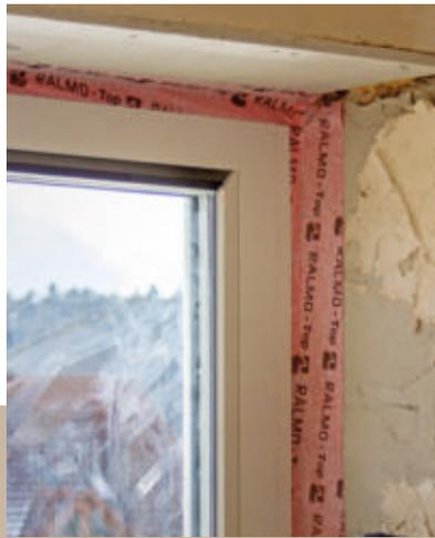
**22** Ebenso oben im Sturzbereich (hier an der Abdeckung des ehemaligen Rollladenkastens). Selbstklebänder sparen Zeit.
