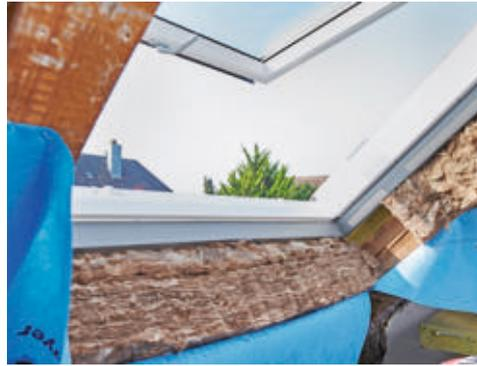
**45** Natürlich muss die Dämmung auch rund ums Dachflächenfenster lückenlos anschließen. Hier sieht man schon die blauen Lappen der Dampfbremsfolie.
