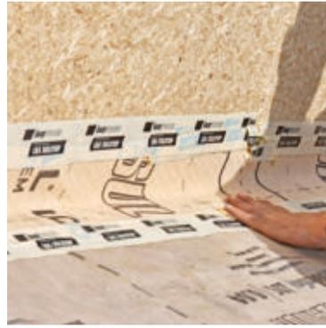
**28** Auch muss erst der Wandanschlussbereich der Gaube mit der Unterdachfolie und Klebebändern abgedichtet werden.
