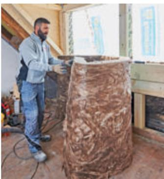
**37** Und das ist dann das Material für die Zwischensparrendämmung. Eine flexible Glaswolle, von der man ...
