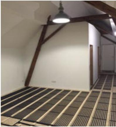
Bei der Verlegung des Systems kamen Register zwischen einem und fünf Meter Länge zum Einsatz.
