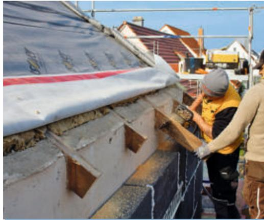
**13** Zur Vorbereitung des Übergangs zur Fassaden-dämmung (hier als Wärmedämmverbundsystem) werden jetzt auch die alten Sparrenköpfe gekappt.
