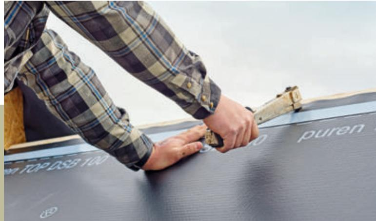
**7** ... tackert man die straff gezogene Bahn oberhalb des Klebestreifens an. Es handelt sich übrigens um eine Kunststoffbahn auf Polyolefin-Basis mit Aluminiumeinlage und Gittergewebeeinlage für eine hohe Reißfestigkeit.
