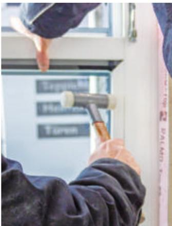
**17** ... das Fixieren der Festverglasung im Rahmen mit Glasleisten, die man mit dem Gummihammer vorsichtig in den Schnappverschluss drückt.
