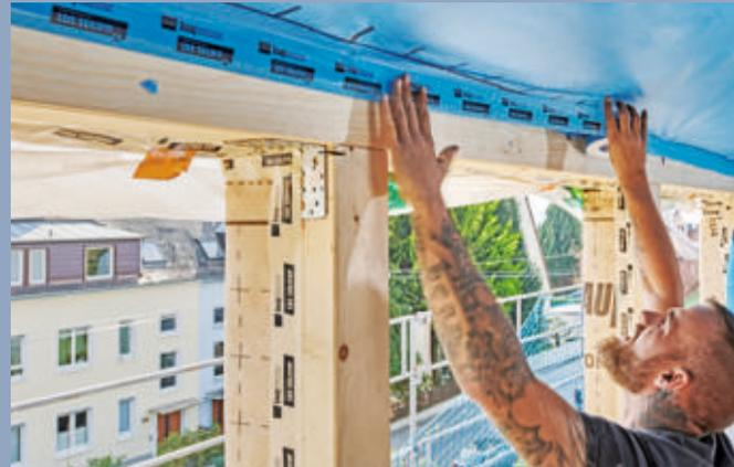
**55** Abgeklebt wird auch der Anschluss der Folie am Sturzbalken der Gaube. Die Folie etwas herunterziehen und dann das Klebeband verlegen.
