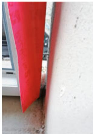
**20** Die Fenster sind fixiert, die Arbeitsschritte für Dämmung und Dichtung beginnen. Das Kompriband ist noch nicht ausgedehnt.
