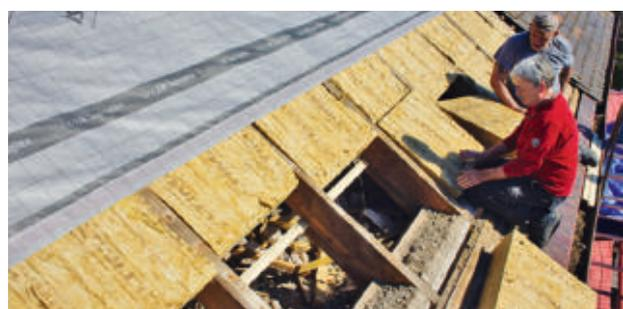
**7** Und so arbeitet man sich herunter bis zur Traufe – wobei immer auch gleich eine Dichtfolienbahn (Klima-Membran) quer über die Dämmlage gespannt wird.
