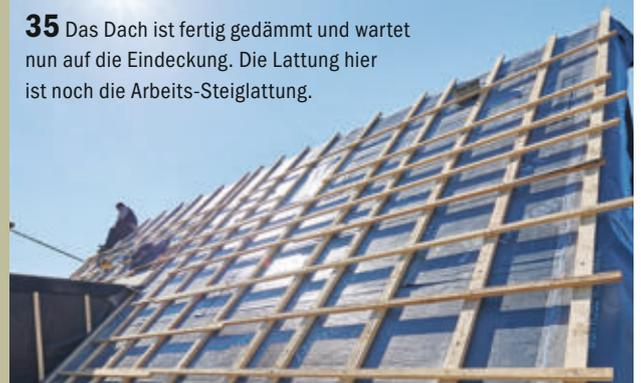
ren Zeiten entgegenzuwirken, ist eine gute Dämmung mit entscheidend für das Wohlfühlklima. Innen also Holz als wohnliches Material, darüber eine leistungsstarke Aufsparrendämmung mit beidseitiger Kaschierung aus Reinaluminium. Diese Deckschichten haben übrigens die primäre
