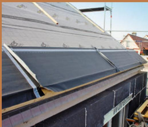
**18** Alle weiteren Platten nun so in eine Reihe legen, dass die aufkaschierte Unterspannbahn mit umlaufenden Klebestreifen auf die jeweils benachbarte Platte überlappt.
