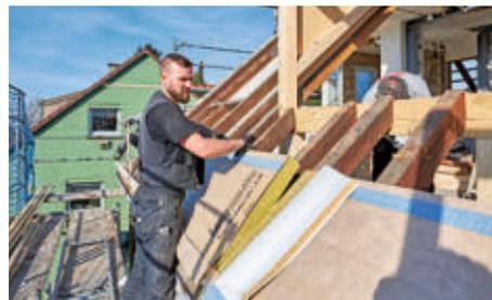
**8** Das nächste Element setzt dicht gestoßen ans liegende an. Hier sieht man schon gut den seitlichen Überhang der aufkaschierten Unterdachbahn, der dann die Abdichtung gewährleistet.
