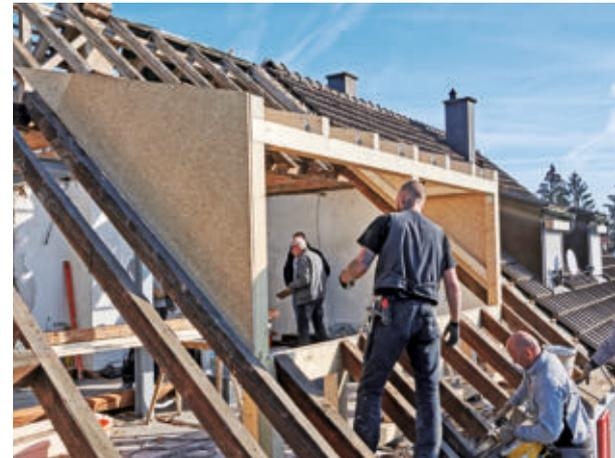
**4** Das Dach der Gaube ist mit geringstmöglichem Gefälle ausgelegt, um möglichst weit vor ans Fenster treten zu können.
