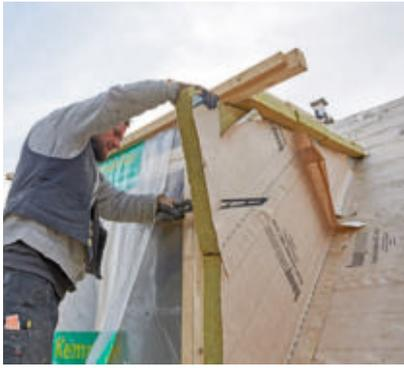
**30** Mit denselben Dämmplatten dämmt man dann die Gaubenseiten – alles passgenau zugeschnitten.
