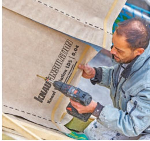
**31** Da die Seiten aus OSB-Platten sind, lassen sich die Dämmplatten sicher an der senkrechten Fläche befestigen. Schrauben mit kleinen Tellerköpfen sind hier am besten.
