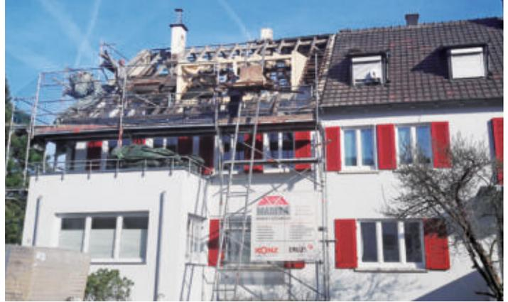
**2** ... deutlich mehr Raumgewinn. Das Dach wurde abgedeckt und ganz geöffnet, das Gaubengerippe steht mit seitlicher Außenbeplankung mit OSB-Platten.
