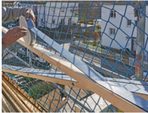
**13** Nach zwei Dämmplattenreihen kann man auch schon die ersten Konterhölzer vorbereiten. Zunächst klebt man das Nageldichtband auf der Rückseite auf.
