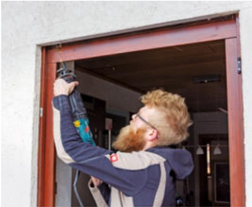
**1** Rückbau der alten Fenster: Sobald die alten Fensterflügel ausgehängt sind, die Rahmen in der Nähe der Ecken mit einer Säbelsäge durchtrennen. Den Übergang ...
