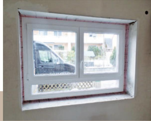
**23** Und so sieht ein innen rundum abgedichtetes Fenster aus. Auch nach unten hin zur Brüstungsmauer wird übrigens der Rahmen luftdicht angeklebt.
