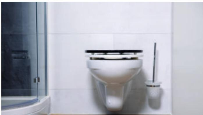
Wer auf Fliesen abschlagen verzichten möchte, der kann zur Renovierung eines Badezimmers diese keramikähnlichen Platten zur Umgestaltung von Wänden einsetzen. Sie sind leichter als Fliesen und müssen nicht verfugt werden. Glatte Untergründe benötigen kein Nivellieren.
