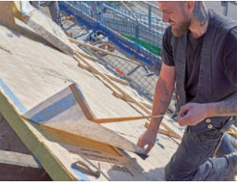
**12** Und so sieht die Verklebung der Unterdachbahn aus. Die Klebestreifen werden sukzessive abgezogen und die Überlappung angedrückt.
