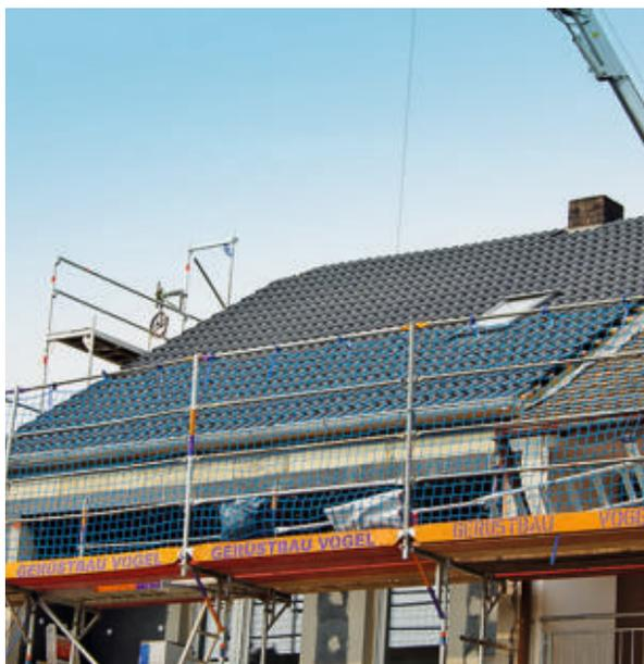
**32** Das Dach ist vollständig gedämmt und fertig eingedeckt. Die Dacheindeckung ist aus Beton und nennt sich Frankfurter Pfanne ([www.creaton.de](http://www.creaton.de)). Durch die zusätzliche Aufsparrendämmung ist der neue Dachaufbau nur 10 cm höher als das Nachbardach, das erst nach unserer Dämmmaßnahme ebenfalls saniert wurde.
