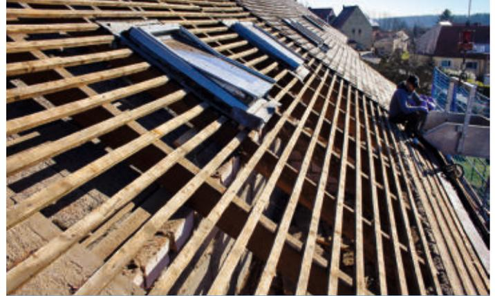
**2** Der sogenannte Rückbau der Dacheindeckung bereitet üblicherweise keine Probleme. Dachpfannen und Ziegel liegen lose auf der Lattung und können am First beginnend einfach abgenommen werden.
