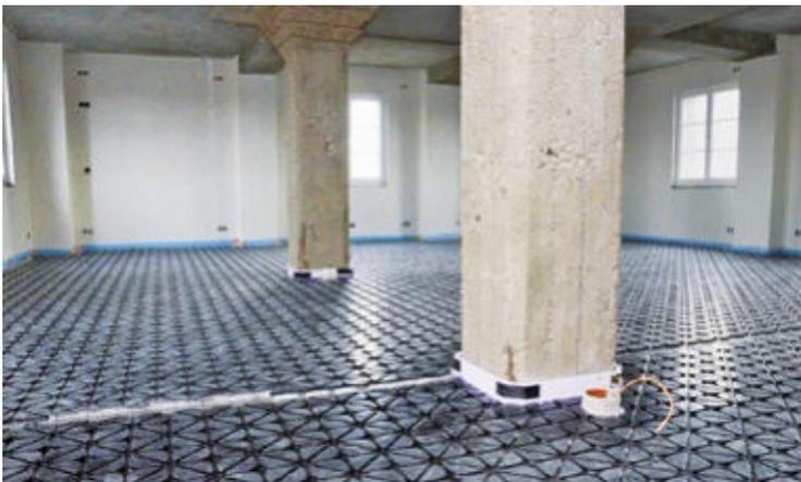
**Die hochflexiblen PE-Xa-Rohre werden nach dem Verlegeplan in die Vertiefungen eingebracht, darauf kommt später der Calziumsulfat-Fließestrich.**
