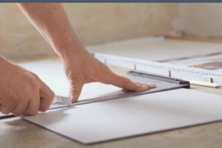
**10** Ansonsten benötigt man nur ein scharfes Cuttermesser und einen Stahlwinkel, um die Platten quer oder längs maßgenau zuzuschneiden. Dabei ...
