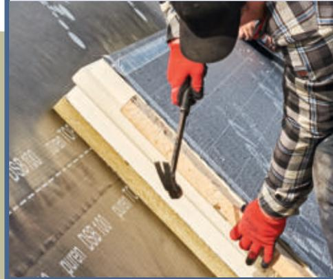
**20** Inzwischen haben bereits die Dämmarbeiten am straßenseitigen Dach begonnen. Die Dämmelemente werden von rechts nach links reihenweise verlegt und bilden mit ihrer Nut-und-Feder-Kante eine dichte Gesamtebene.
