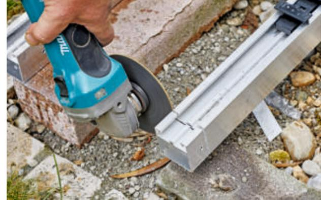
**1** Die speziell formgefrästen Aluminium-Unterbauschienen lassen sich je nach Längenbedarf abschneiden, zum Beispiel mit einem Trennschleifer.
