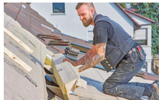
**25** Zwischen Gaubenfläche und Hauptdachschräge lassen sich dann entsprechend zugeformte Passstücke einfügen.
