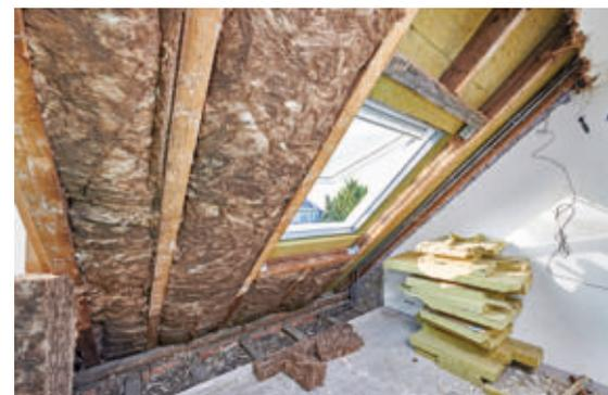
**39** Da man die Dämmwolle mit etwas Zugabe zuschneidet, lassen sich die Matten gut eindrücken. Sie halten dann ohne weitere mechanische Befestigung.
