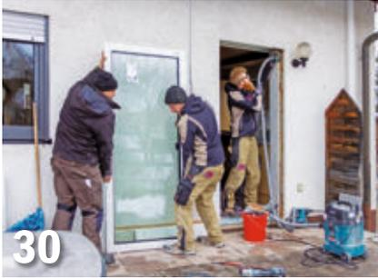
Ein Reiheneckhaus wird modernisiert. Im ersten Teil der Baustellen-Serie werden neue, hochwärmedämmende Fenster eingebaut.
