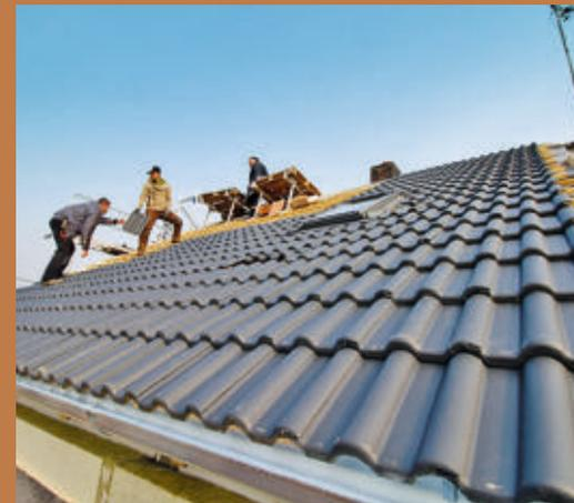
**30** Jetzt wird das Dach gedeckt: Erst die Regenrinne mit leichtem Gefälle zum Fallrohr montieren, dann von unten her die Dachpfannen verlegen.
