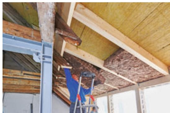
**38** ... nun entsprechend der Balkenabstände Einzelstücke herausschneidet. Hier beginnt unser Dachprofi am Gaubendach. Die Balken sind so dick wie die alten Dachsparren.
