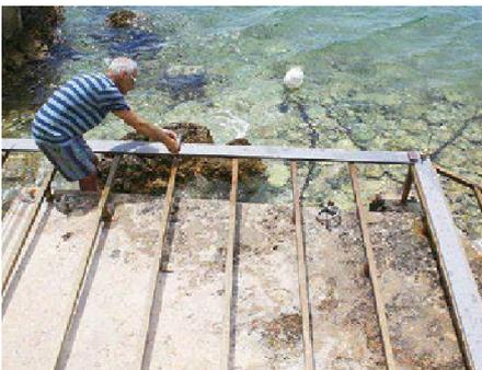
**4.** Die Randdielle wird festgespannt, rechts die um 90-Grad verdreht verlaufende Trenndielle.
