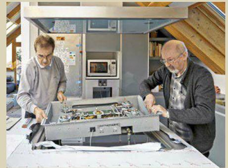
**34.** Die Gas-Einbaueinheit passt genau in den Plattenausschnitt und wird bündig eingesenkt.
