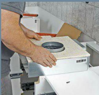
**A.** Mit Schwertschaummatten wird die Umlufteinheit schallgedämmt.
