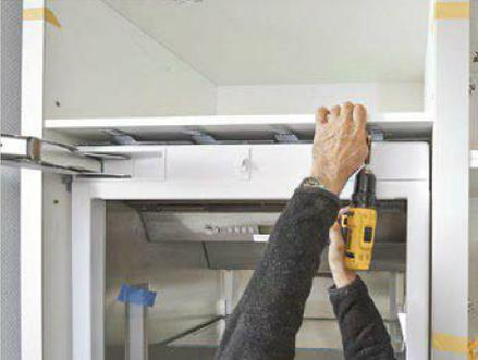
13. Oben wird er über vier Verbindungslaschen am Zwischenboden angeschraubt und gesichert.
