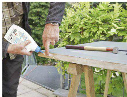
18. Die Arbeitsplatte für die Spüle wird vorbereitet: Auf die Rückkante wird Leim angegeben, ...
