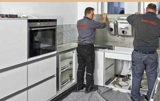
**16.** Die Spüle besteht aus zwei Unterbaubecken, die einzeln unter der Keramikplatte fixiert sind.
