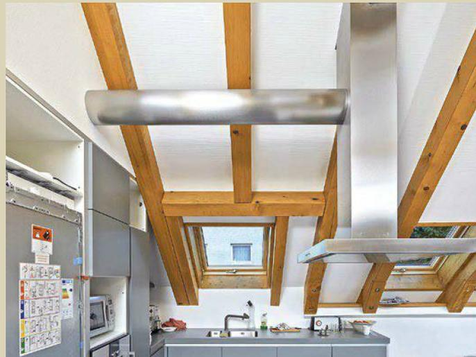
31. Über eine Querverbindung in Richtung Oberschrankreihe wird schließlich die Abluft übers Dach abgeführt. Der Anschluss liegt dabei hinter der Trockenbauwand, die oberhalb der Schränke bis hoch zur Schräge führt.
