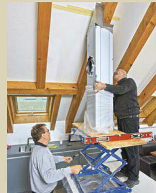
**28.** Die Dunstabzugseinheit wurde gemäß der Sparrensituation formtreu angefertigt und per Scherenhubbühne positioniert.
