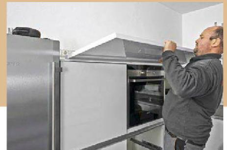
25. ... Korpusse noch mit einer dicken Deckplatte optisch und mechanisch zusammengehalten.
