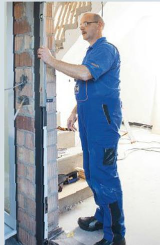
**9.** Der senkrechte Sitz zwischen den neu gemauerten Pfeilern wird mit der Wasserwaage überprüft.
