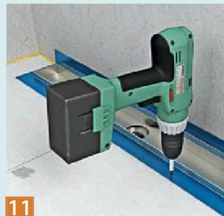
**11** Mit den beigegefügt Fermacell Powerpanel TE Schrauben wird die Rinne fixiert. Die Rinne dabei leicht an die Wand drücken!
