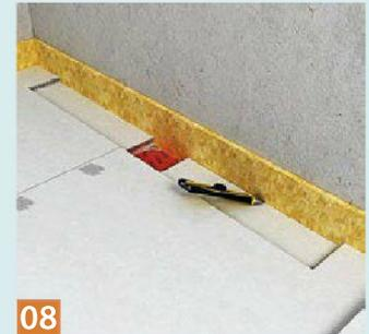
**08** Nun muss zunächst der Randdämmstreifen bündig abgeschnitten werden, dann entfernt man den Schutzaufkleber vom Ablauf.
