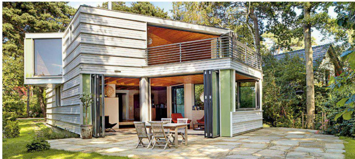
Bei dieser großzügigen, raumhohen Übereck-Anlage öffnet man die Falttüranlage nach beiden Seiten. Rechts und links parkt jeweils ein Elementestapel mit der Öffnungsrichtung nach außen. [www.solarlux.de](http://www.solarlux.de)
