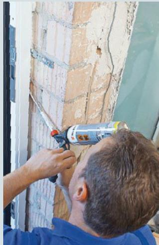
13. Der dann eingebrachte Monta-geschaum ist die dritte Dichtungs-ebene in der Bauanschlussfuge.
