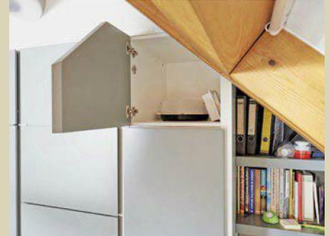
15. Die Front wurde ebenso passgenau vorfertigt, so dass sie perfekt schräg abschließt.
