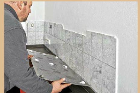
23. Im Kochbereich dient eine punktförmig angeklebte Edelstahlplatte als Spritzschutz.
