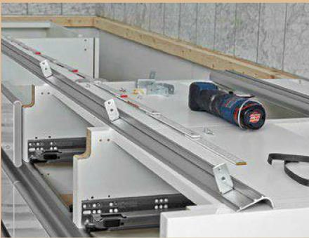
**10.** Die obere Alu-Leiste ist ein L-Profil und wird in die obere Aussparung der Schrankwände ...
