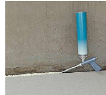
5. Ist die Fläche verlegt, müssen alle offenen Rand- und Anschlussfugen ausgeschäumt werden.
