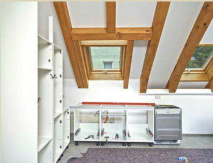
6. Erste Zwischensituation im Dachschrägeneck mit den exakt ausgerichteten Korpusreihen.
