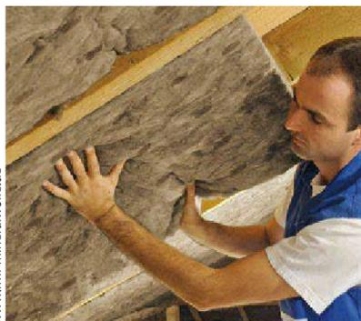
Eine zusätzliche Untersparrendämmung reduziert Wärmebrücken im Bereich der Dachsparren effizient.
