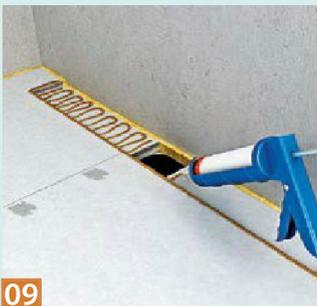
**09** Die Rinne wird mit Klebstoffraupen eingeklebt. Kleber muss auch im Flanschbereich aufgetragen werden. Dann setzt man ...
