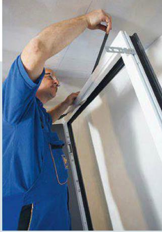
5. Anschließend wird der Haustür-rahmen rundum mit einem Bau-anchlussdichtband versehen.
