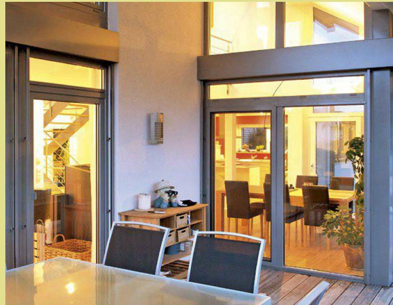
Verglasungen in Alu-Kunststoff-Ausführung: Rechts führt eine Hebe-Schiebetür aus dem Haus, links eine Drehtür. [www.kneer-südfenster.de](http://www.kneer-südfenster.de)
