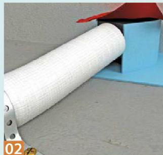
**02** Das ebenfalls gedämmte Ablaufrohr fixiert man am Boden und deckt den Topf mit dem roten Schutz aufkleber ab.
