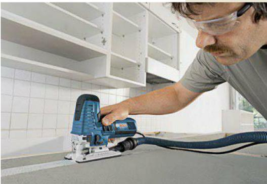
Schichtstoffplatten werden mit Oberfräsen, CNC-Fräsen oder leistungsstarken Stichsagen zugeschnitten. [www.bosch-professional.com](http://www.bosch-professional.com)
