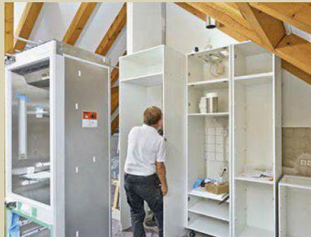
7. Sonderanfertigung und Einbau der Umkleidung für den fahrbaren Kühlschrank (s. Abb. 12).
