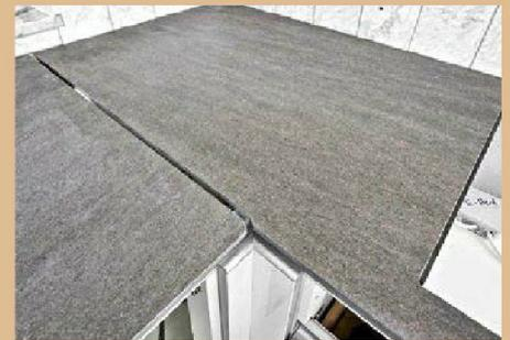
21. Detail-Perfektion: Am 90-Grad-Winkel der U-Küche sind die Stoßkanten exakt zugeformt.
