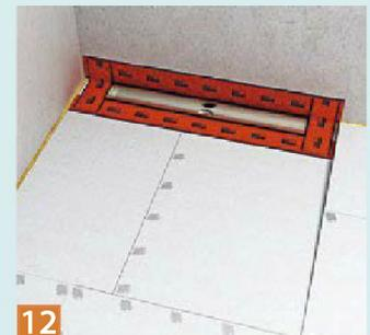
**12** Nun wird die Schutzfolie der Rinne entfernt und das Butyl-Abdichtungsband auf Rinne und Gefälleelemente geklebt.
