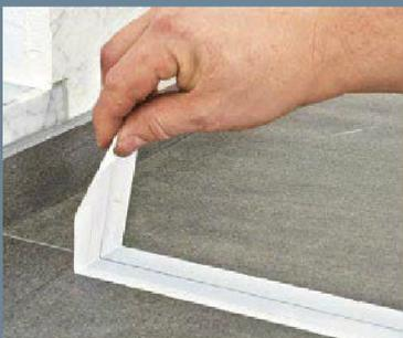
d. Nach den Abziehen des Klebebands bleibt eine schmale Verfüllung stehen.
