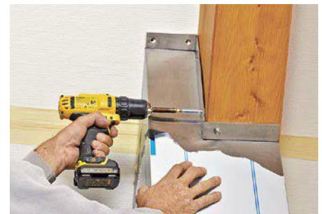
**29.** Elegant befestigt: Die Edelstahllaschen umschmiegen das Holz, über Gewindestangen und Hutmuttern wird das Gewicht sicher abgetragen.
