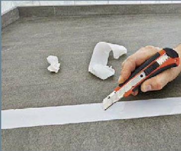
a. Den Fugenbereich mit Klebeband abkleben, dann die Fuge freischneiden.
