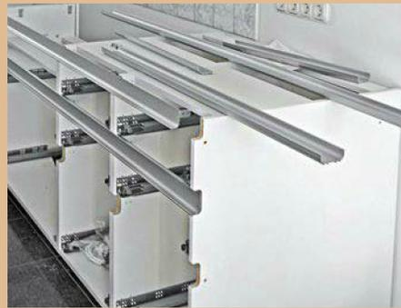
**11.** ... eingelegt und verschraubt. Darunter das zweite Profil, das ebenfalls bündig abschließt.
