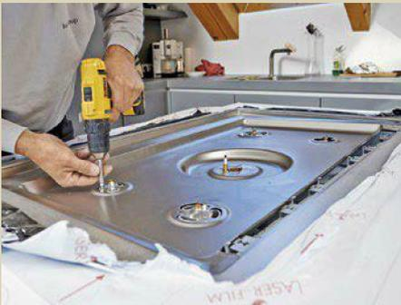
**35.** Anschließend kann schon gleich die Edelstahl-Muldenabdeckung verschraubt werden.
