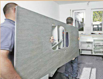
**13.** Diese sind aus 10 mm dicker Spezialkeramik und wurden bereits mit Ausschnitten versehen.
