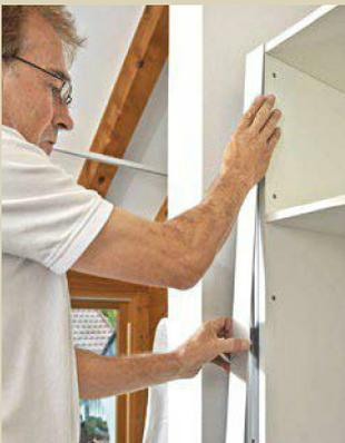
10. ... die dann front-seitig (wie die Doppel-leisten auch) mit einer Aluminium-sichtblende abgedeckt werden.
