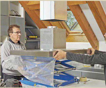
30. Die Edelstahlsele wird ebenfalls per Hubtechnik sicher und problemlos an den Abluftkanal angedockt und dann daran angeschraubt.
