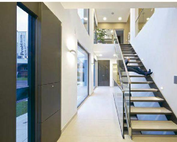
Ein offenes und freundliches Entrée. Das Glasgeländer der Flachstahlwagentreppe wurde mit einer Klemmverbindung ohne sichtbare Befestigungen ausgeführt. Boden- und Treppenbelag sind gleich. [www.stadler.de](http://www.stadler.de)
