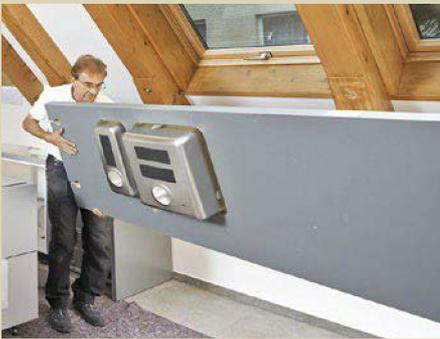
**20.** In die Platte wurden 2 Edelstahl-Spülbecken per Lasertechnik flächenbündig eingearbeitet.
