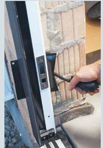
**10.** Sogenannte Winbags (aufblasbarer Luftbeutel) helfen zusätzlich beim Ausrichten der Türzarge.
