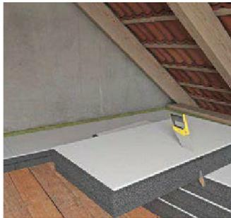
3. Das jeweilige Endstück einer Reihe wird mit einem Fuchsschwanz auf die passende Länge gesägt.
