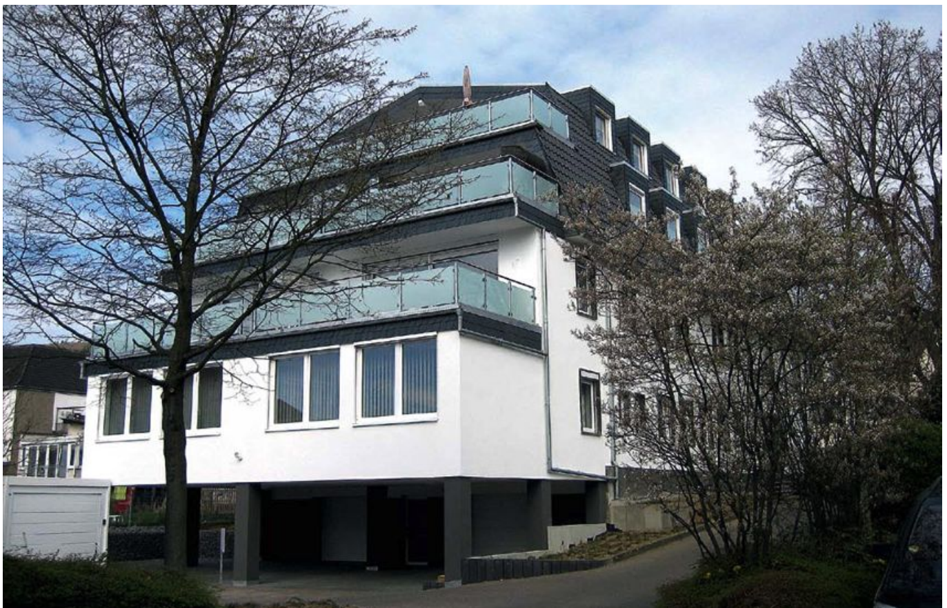
Die rückwärtige Gebäudeverlängerung dient den gestuft angelegten Terrassen.
