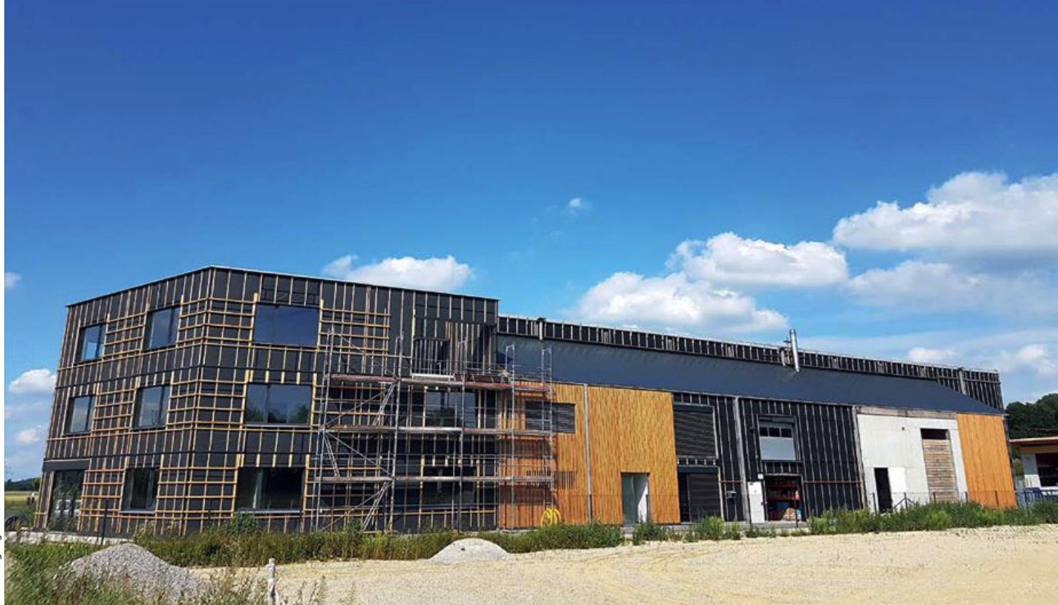
Rund 1.000 m 2 Platz bietet die neue Abbundhalle von Holzbau Leitsch. Derzeit montieren die Handwerker die hinterlüftete Holzfassade.
