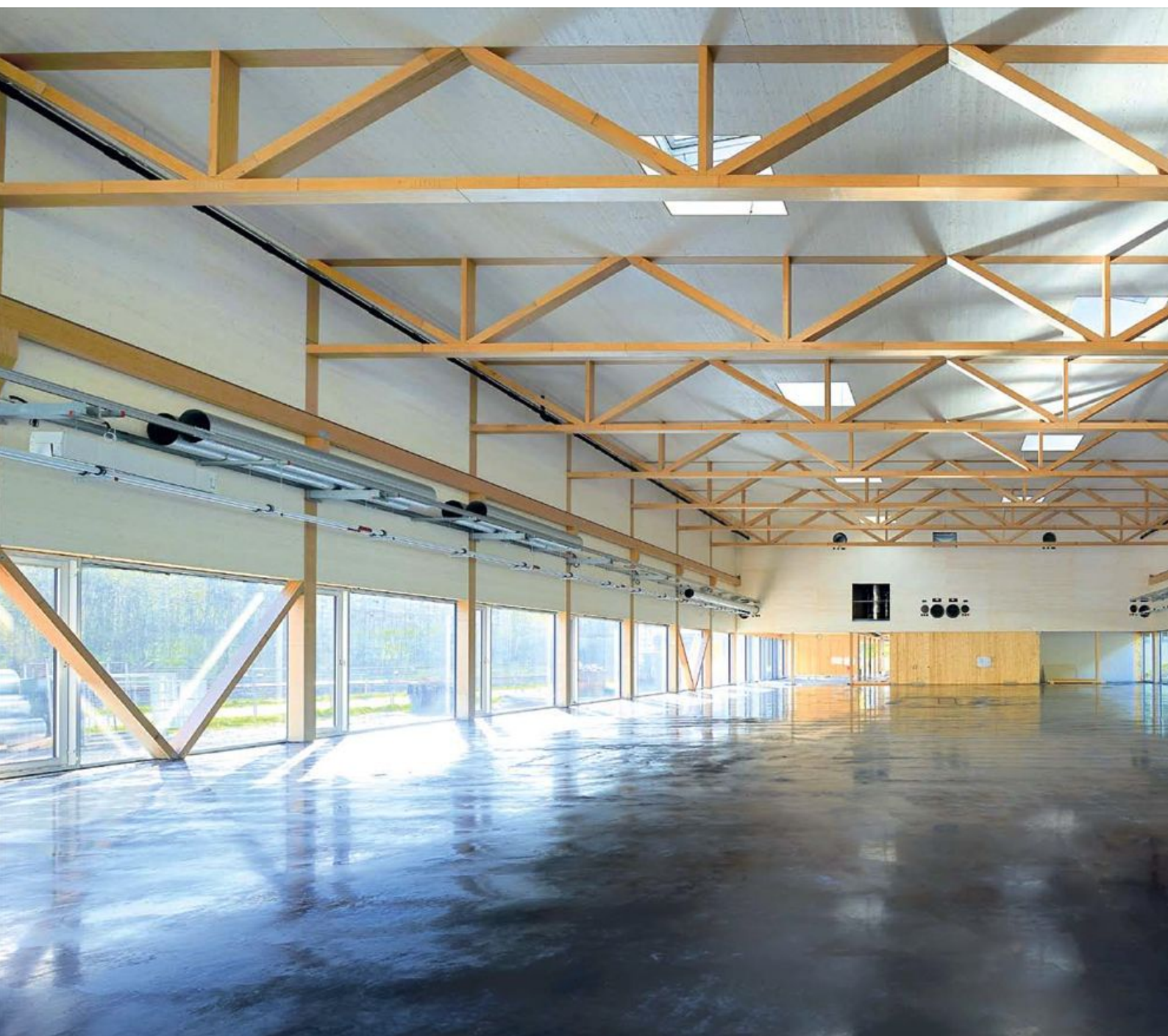
An die elobau-Werkshalle in Probstzella mit ihrem Fachwerkbinderdach schließt ein eingeschossiger Bürotrakt an.
