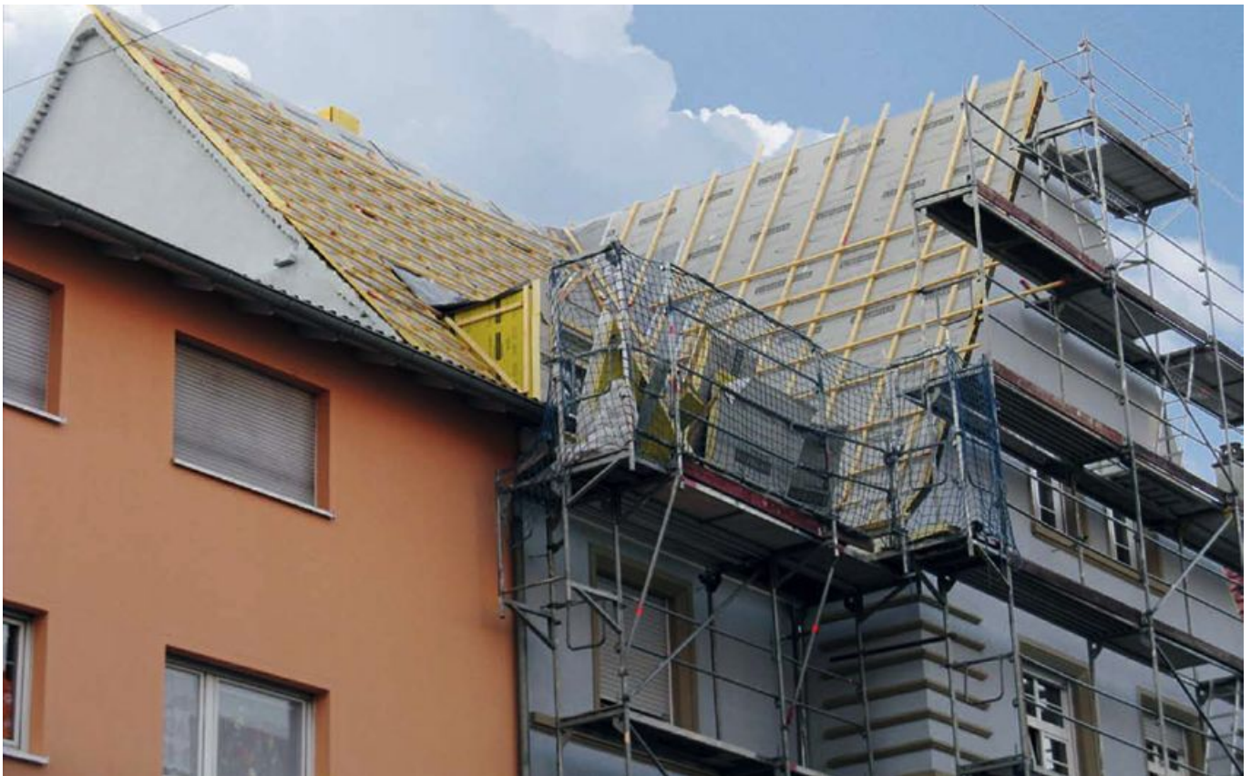
Bild 1: Im Baubestand leisten Aufdachdämmungen gute Dienste. Sie sind leicht, rasch verlegt und als Systeme bauphysikalisch optimiert. Dennoch sollten sich Planer und Handwerker vor einer Sanierung die bestehende Bausubstanz genau anschauen.
