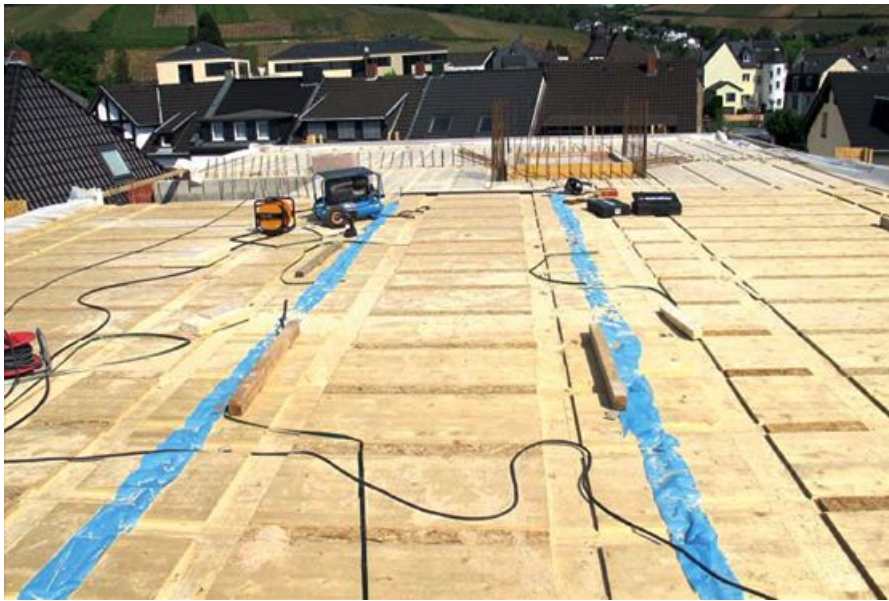
Die Verlegung der Deckenelemente aus Brettschichtholz für die HBV-Decke.
