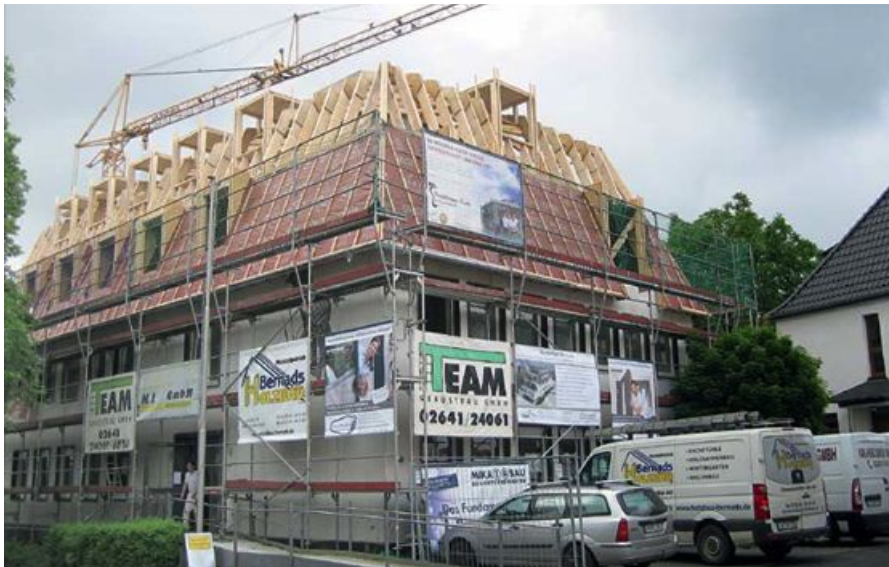
Die Aufstockung konnte ohne Störungen des Wohnumfelds der Joerrestraße ausgeführt werden.
