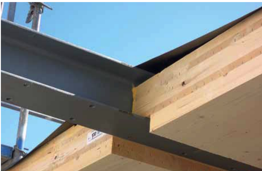
Die deckengleichen Stahlunterzüge erhielten unterseitig eine Brandschutzbekleidung und eine Holzplatte zur Abdeckung. Am Ende schließt alles oberflächenbündig ab.
