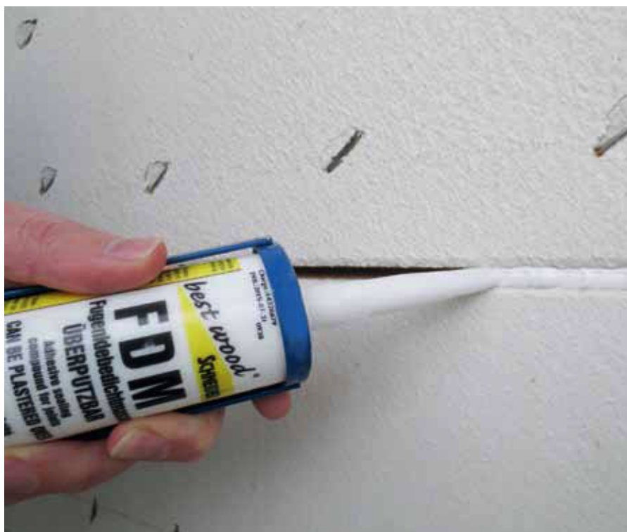
Fugen von 2 bis 5 mm zwischen den Platten werden mit einem systemeigenen Dichtstoff verschlossen.
