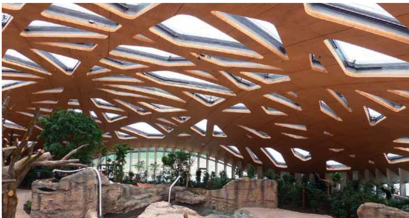
Beim neuen Elefantenhaus im Züricher Zoo wurden esb-Platten oberhalb der Brettspertholzschale als Tragschicht für die Dachabdichtung eingesetzt.
