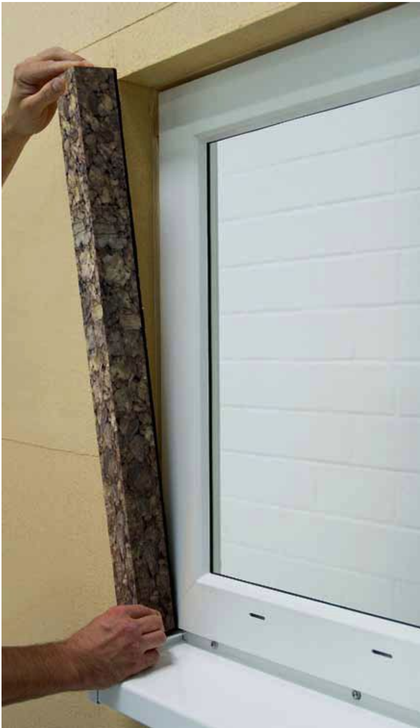
Die Laibungsplatten sollten feuchtebeständig sein. Dazu eignet sich XPS oder auch Kork.
