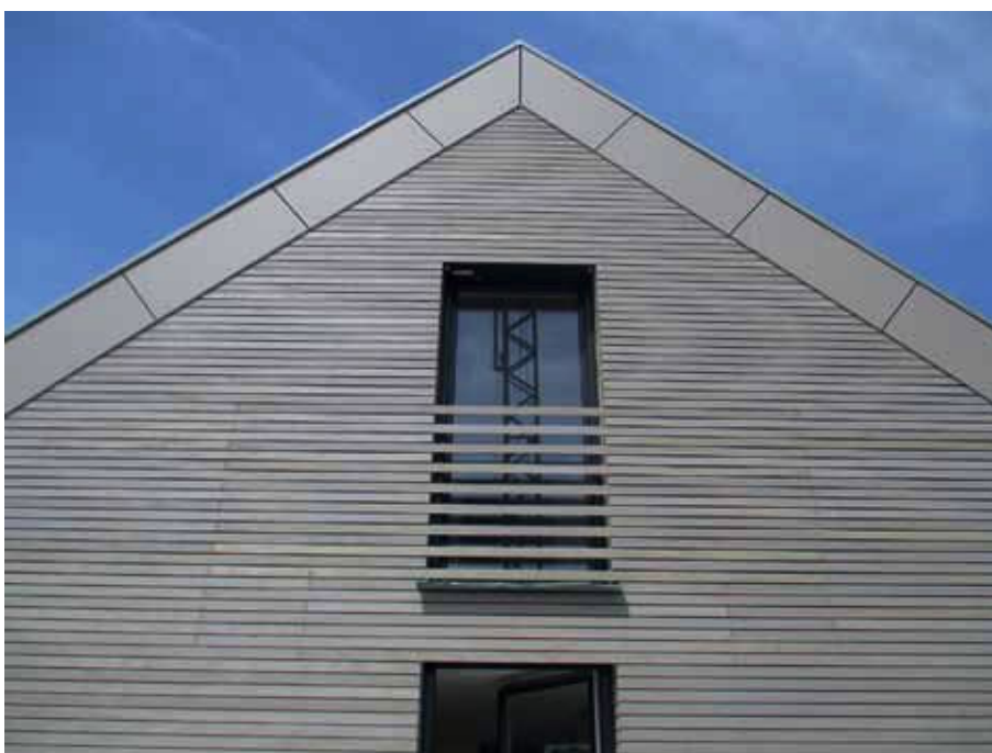
Die Giebel sind mit einer Rhombusschalung bekleidet. Am bodentiefen Fenster im Obergeschoss bildet die Schalung auch die Absturzsicherung.
