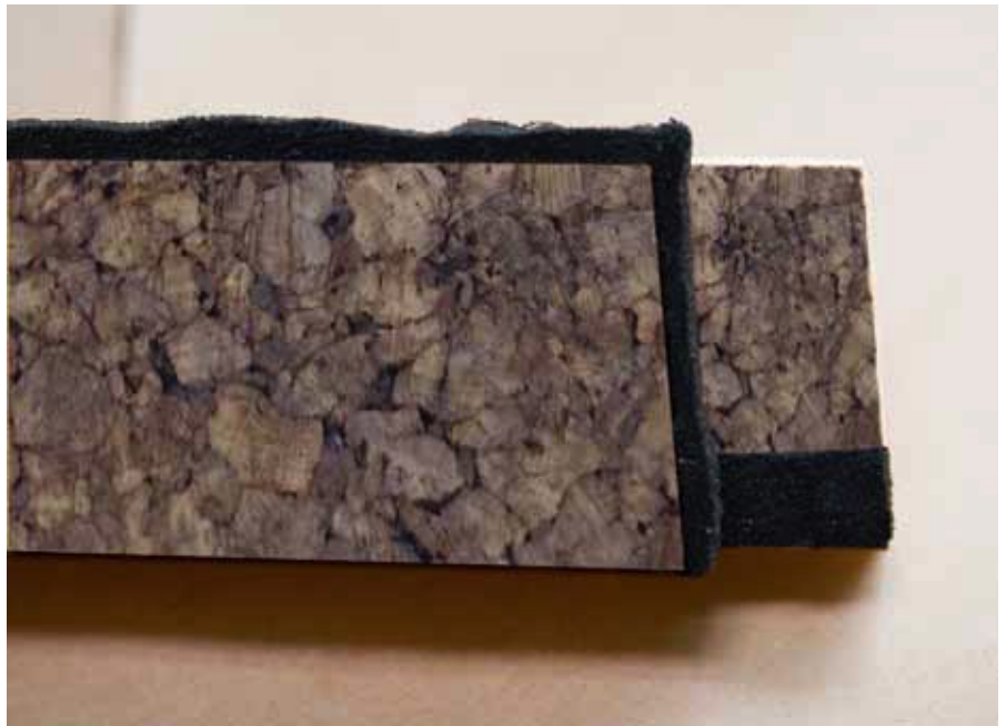
Vor der Montage müssen die Laibungsplatten mit Dichtungsbändern ausgestattet werden.
