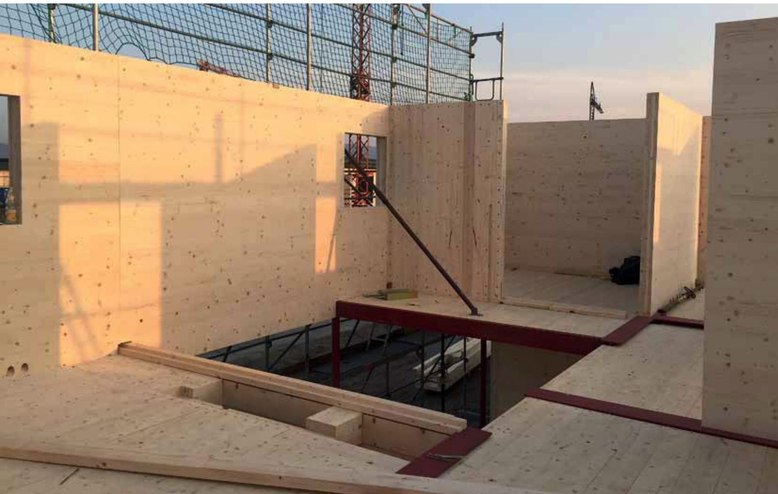
Der Baukörper besteht aus Kreuzlagenholzelementen, deren einzelne Brettlagen leimfrei miteinander verbunden werden.
