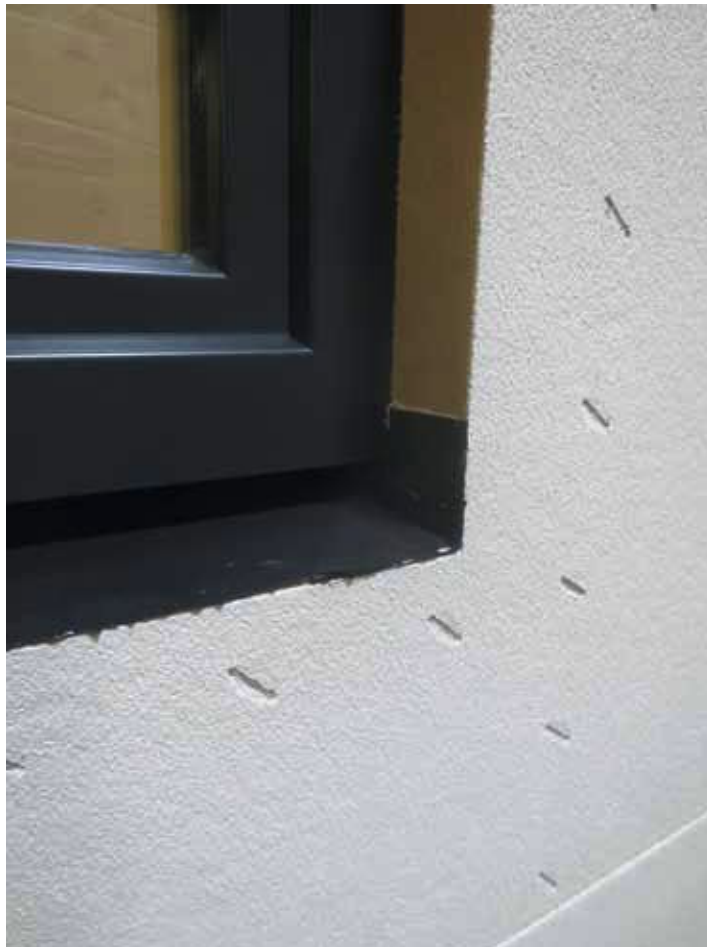
Horizontale Plattenkanten wie sie etwa bei Fensterbrüstungen entstehen, müssen vor Durchfeuchtung geschützt werden.
