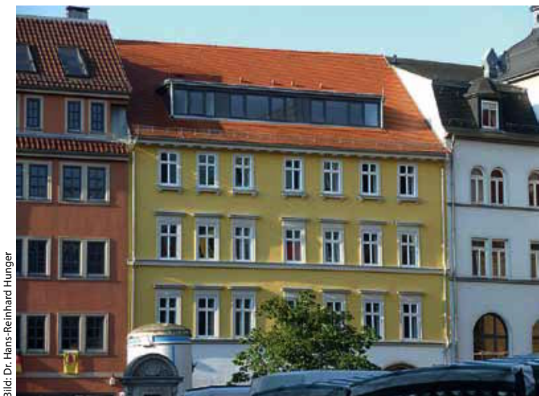
Nach der Sanierung zeigt das Gebäude wieder das Erscheinungsbild des 19. Jahrhunderts. Die Jury lobte die Ingenieure für ihre Leistung und für die Wahrung des ursprünglichen Gebäudecharakters.
