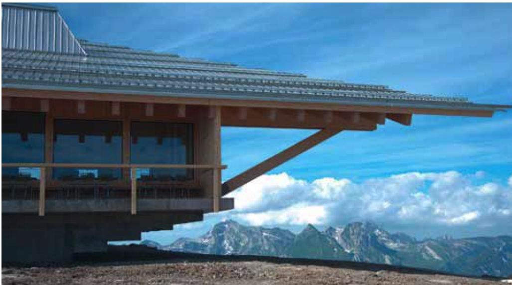
Im Querriegel befindet sich das Restaurant, dessen südliche Seite voll verglast ist und Zutritt auf die davor liegende Terrasse bietet. Bis zu 350 Gäste finden im Lokal Platz, weitere 90 im Außenbereich.
