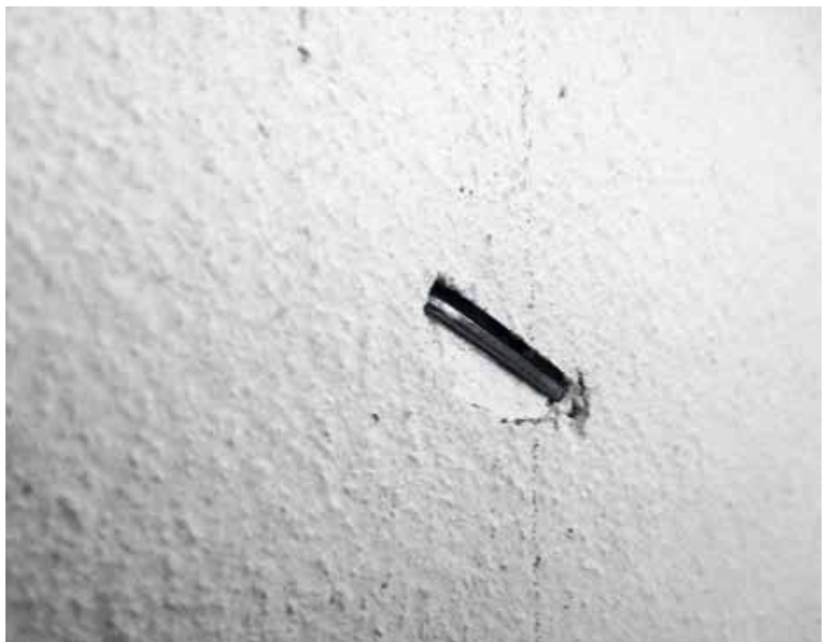
Befestigt werden die Platten durch den Putz hindurch mit Breitrückenklammern. Sie werden etwa 2 bis 3 mm vertieft in die Putzschicht eingebracht.
