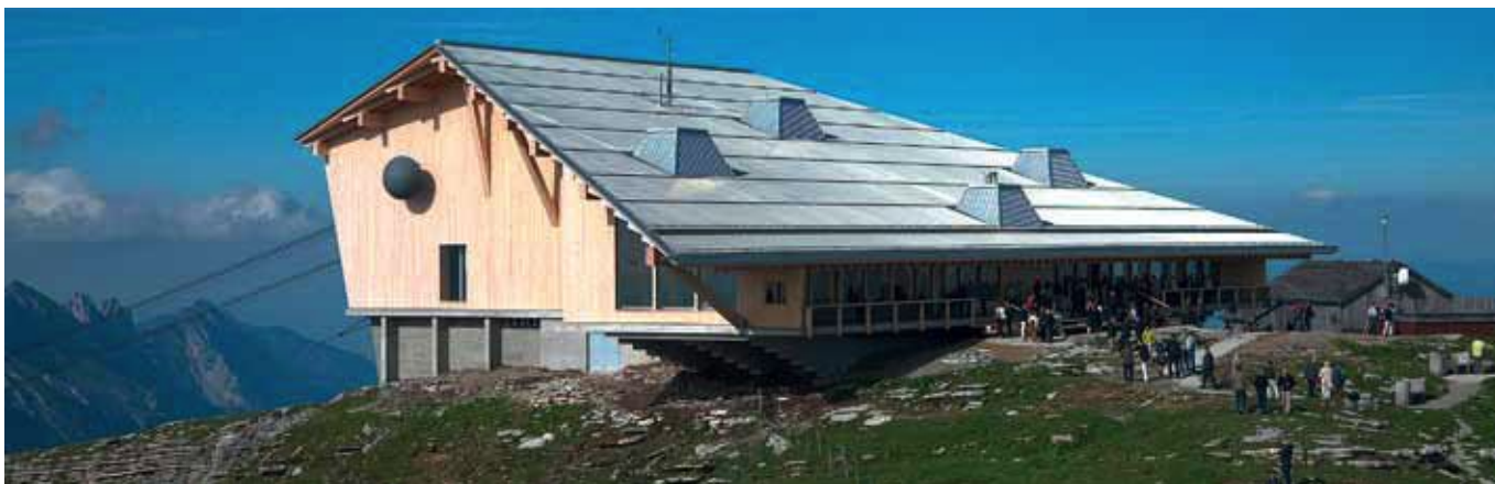
Ein asymmetrisches Satteldach mit weiten Dachüberständen spannt sich über beide Gebäudeteile des Gipfelrestaurants.
