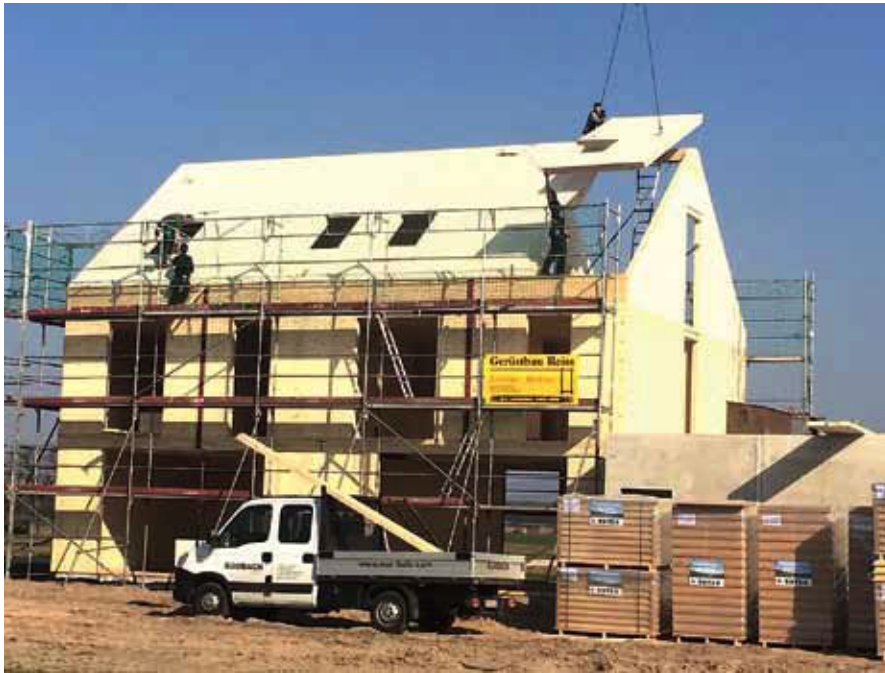
Dank der vorgefertigten, passgenauen Massivholzbauteile ist das Haus rasch aufgestellt und das Dach geschlossen.
