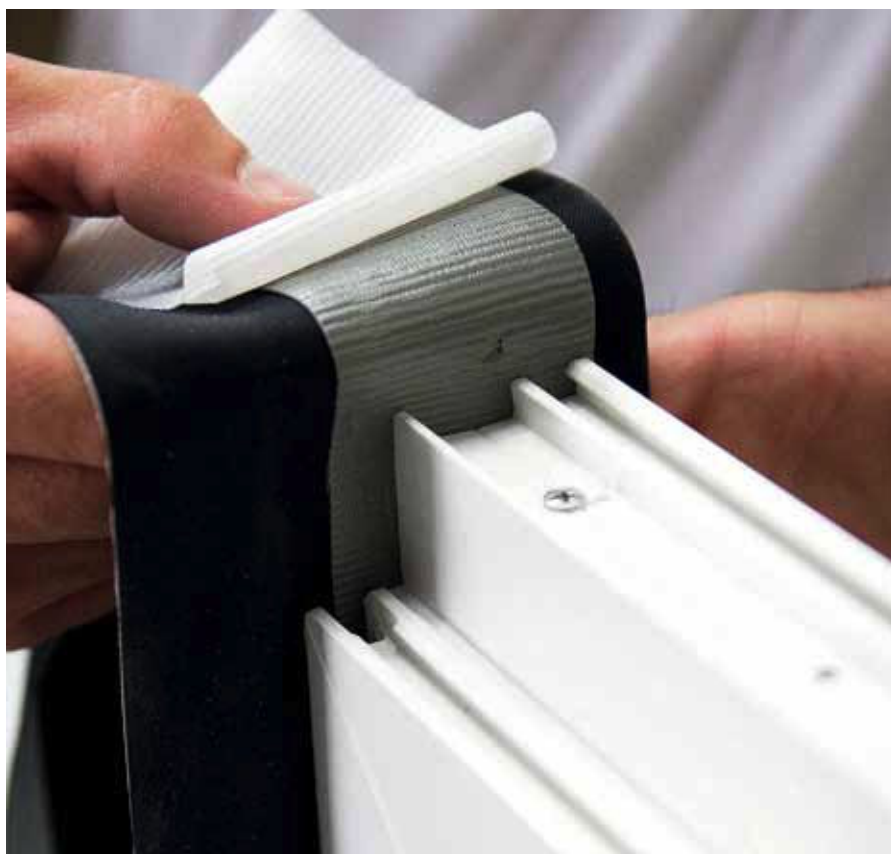
Später wird das Fenster mit einer geeigneten Fensteranschlussdichtbahn ausgestattet, die dann an die Brüstungsabdichtung angeschlossen wird.
