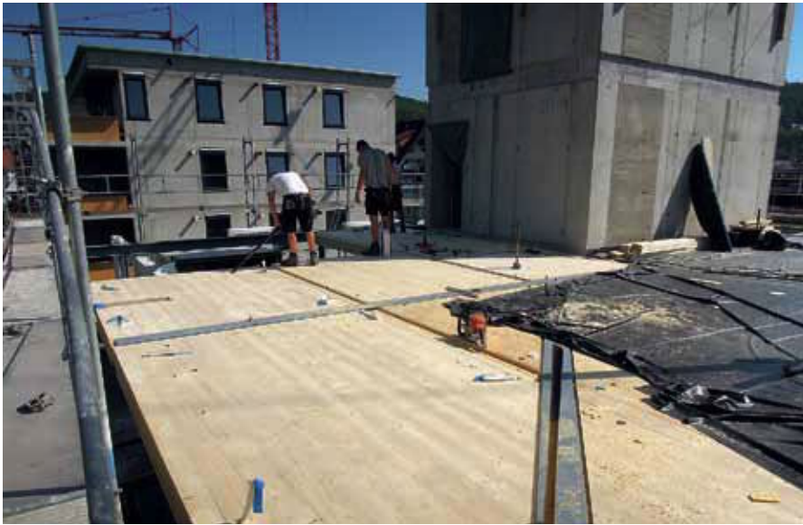
Diagonal verlegte Stahlträger nehmen die Lasten aus den über Eck auskragenden Decken auf.
