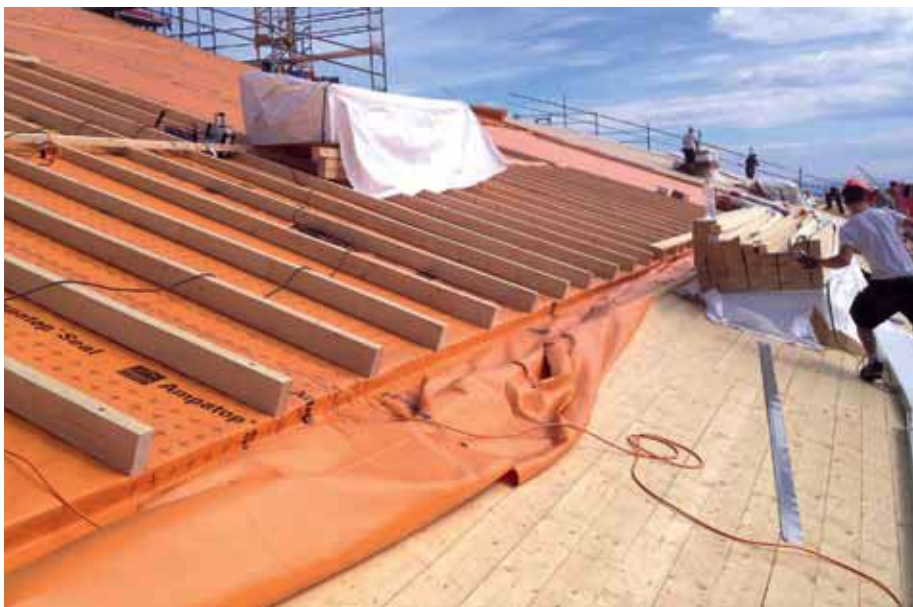
Damit das Dach den extremen Witterungsbedingungen trotzen kann, wurde die Unterdachbahn Ampatop Seal von Ampack verwendet.
