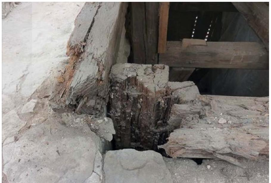
Bild 3: Schäden fanden sich an den Sparrenfüßen und an den Schwellen. Auch die Eckstiele der Glockenstube waren marode.
