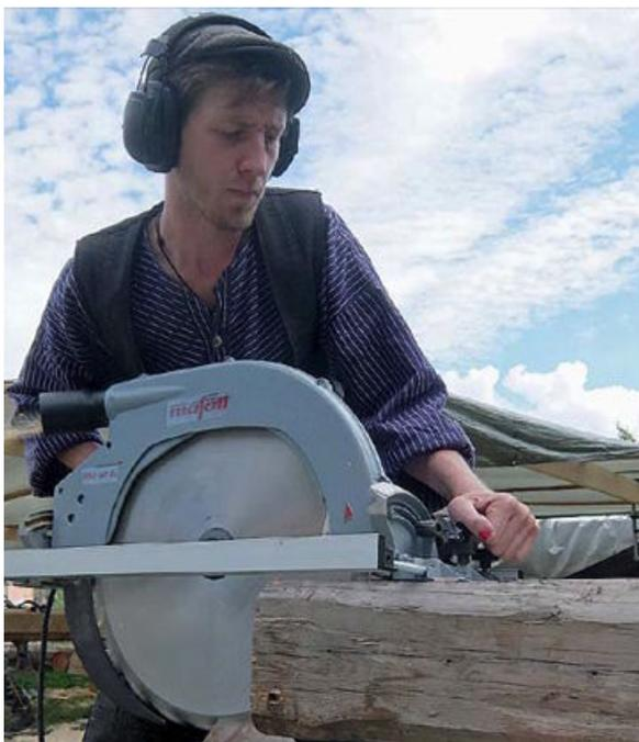
Die Zimmerei-Handkreissäge MKS 185 Ec wurde bei den mächtigen Holzquerschnitten von 18 × 18 cm zum Ablängen und Auftrennen zur Hand genommen.
