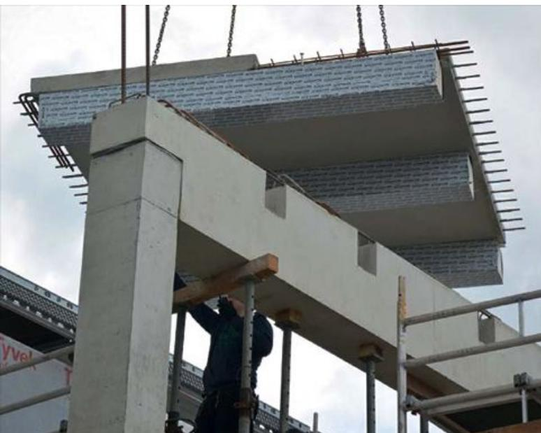
Durchgängiges Abdichtungskonzept: Unter anderem wird das Holz der Hybriddecken ab Werk mit einer Folie geschützt.
