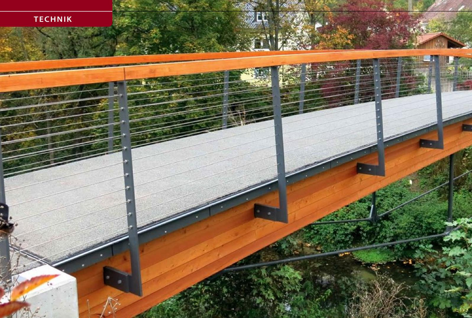
Absolut unerlässlich ist im Holzbau der konstruktive Holzschutz. Konstruktiv einwandfrei geschützte Holzbrücken haben eine vergleichbar lange Lebensdauer wie ihre Pendanten aus Stahl, Stahlbeton oder Aluminium.
