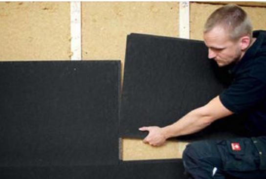
Die Wandbauplatte ist besonders für Fassadenbekleidungen mit offenen Fugen bis 20 mm geeignet.
