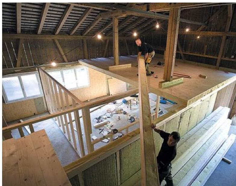
Minimale Deckenstärken der Kastenelemente ermöglichen maximale Raumhöhen.
