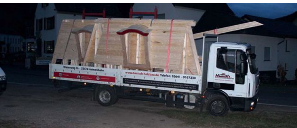
Die Mansarddachflächen kamen als vorgefertigte Elemente auf die Baustelle. Auch die kleinen Gauben waren bereits montiert und wurden zeitgleich auf die oberste Decke gehievt.
