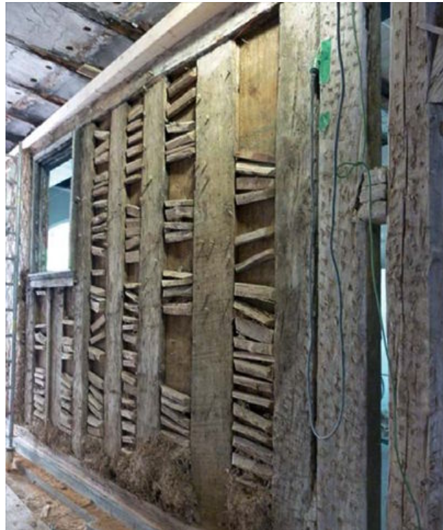
Bild 5: Mithilfe eines neuen Unterzugs wurde die historische Bohlenwand aus der Zeit um 1550 lastfrei gestellt und konnte so als sichtbares Element erhalten werden.
