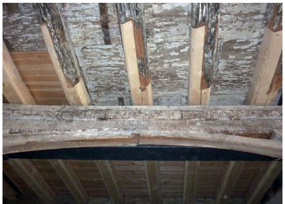
Bild 6: Die sichtbaren Deckenbalken der Erdgeschossdecke wurden traditionell zimmermannsmäßig mit langen Blättern und Stabdübeln instand gesetzt.
