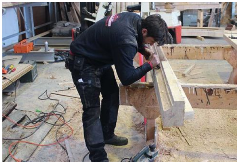
Die meisten Teile konnten die Zimmerer an den historischen Gesimsen retten. Allerdings mussten auch dort einige neue Teile angestückt werden.
