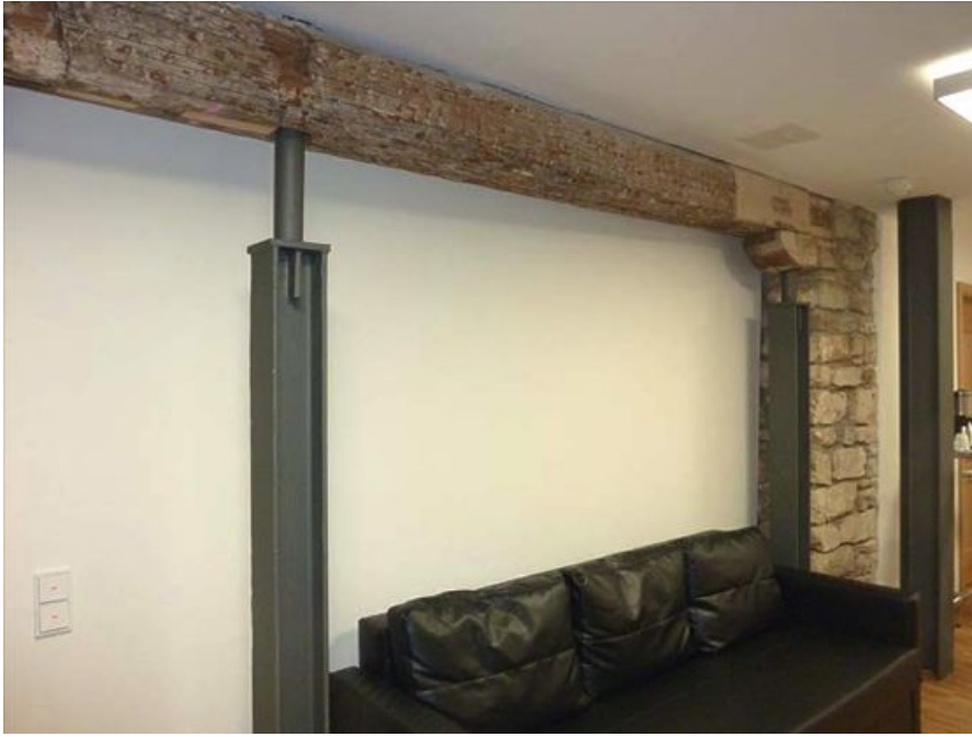
Bild 3: Ein gotischer Unterzug sollte erhalten bleiben. Die Ingenieure ordneten mehrere Stahlstützen an, die den historischen Balken durchstoßen und einen darüber neu eingebauten schlanken Stahlträger stützen.
