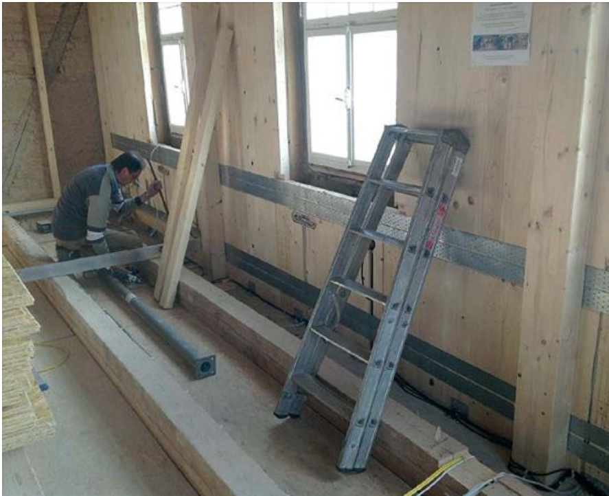
Zur Aufnahme der horizontalen Einwirkungen wurden hinter einige Außenwände Brettsperrholzscheiben eingebaut. Daran konnten die ertüchtigten Holzbalkendecken angeschlossen werden.
