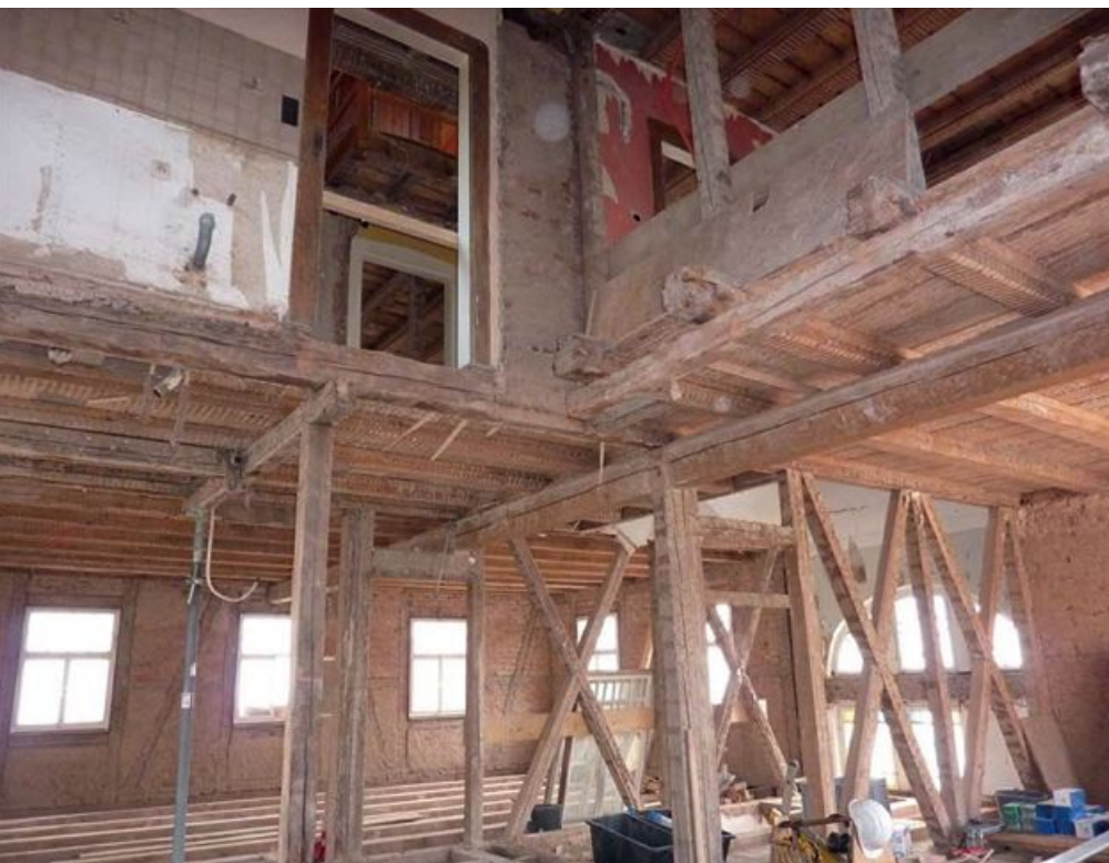
Im Altbau sollte Platz für einen großen Versammlungsraum entstehen. Dazu musste das erste Obergeschoss komplett entkernt werden. Im Hintergrund ist die Fachwerkwand zu erkennen, über die später irgendwie die horizontalen Einwirkungen abgeleitet werden mussten.
