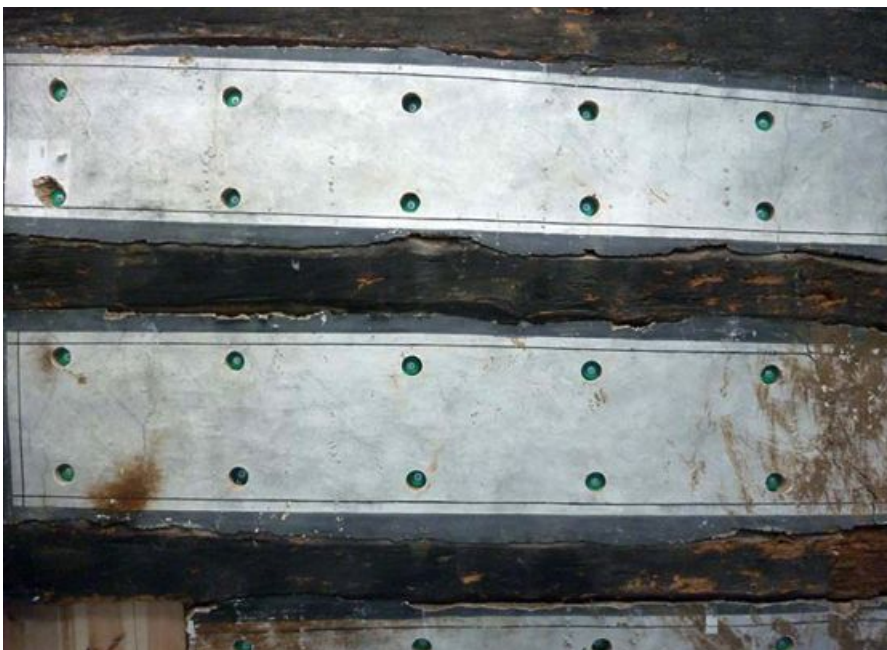
Bild 4: Auch die Füllungen wurden gesichert. Sie wurden über Gewindestangen an ein oberhalb der alten Holzbalkendecken verlegtes Rost aus Kanthölzern angehängt.
