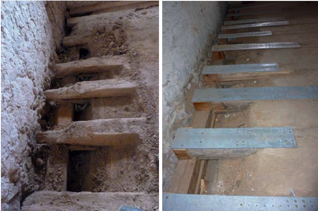
Bild 7: Zahlreiche Balkenköpfe sanierte man mit stählernen T-Trägern. Dazu wurden die maroden Balkenenden senkrecht eingeschlitz, die T-Träger von oben eingeschoben und mit Vollgewindeschrauben an den Hölzern befestigt.
