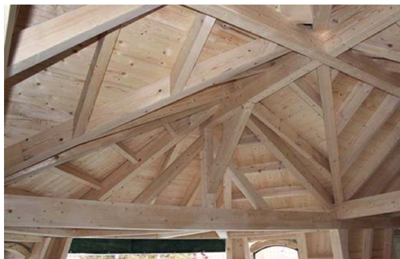
In der Sanierung historischer Gebäude wird immer wieder deutlich, welchen Stellenwert traditionelles Handwerk im modernen Bauwesen hat.
