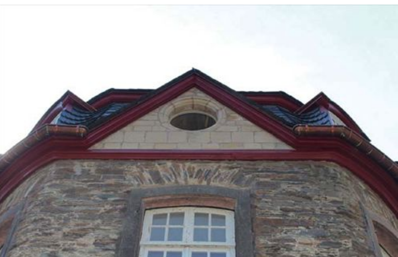
Durch die Bearbeitung mit Handwerkzeugen wie Stemmeisen, Hohleisen und Co. entstanden Reparaturteile, die sich von den Originalen kaum unterscheiden.
