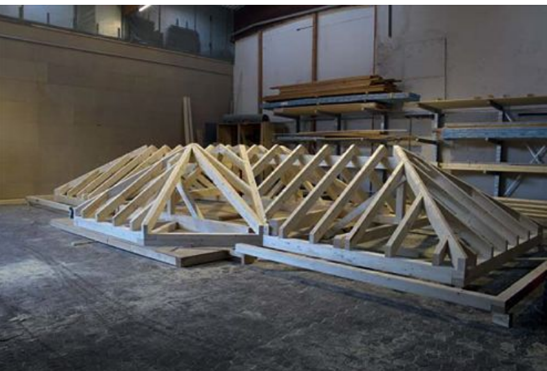
Das obere Walmdach bauten die Zimmerleute in der geschlossenen Halle vorher komplett zusammen. So konnten Sie sicher gehen, dass später alles passte und die Montagezeit auf ein paar Tage beschränkt werden konnte.
