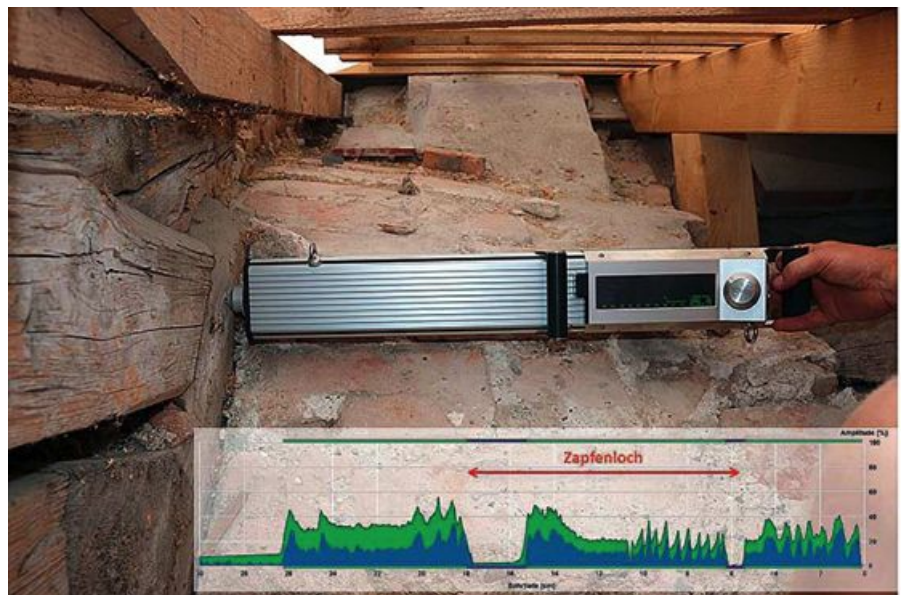
Bild 3: Überprüfung des Zustands einer Zapfenverbindung eines ins Mauerwerk eingelassenen Balkenkopfes mit dem IML-RESI PD – das Bohrprofil zeigt einen intakten Zapfen an. Die Dachkonstruktion wurde zur Erbauungszeit 1732 sehr grob verzimmert, deshalb ist das Zapfenloch so breit.
