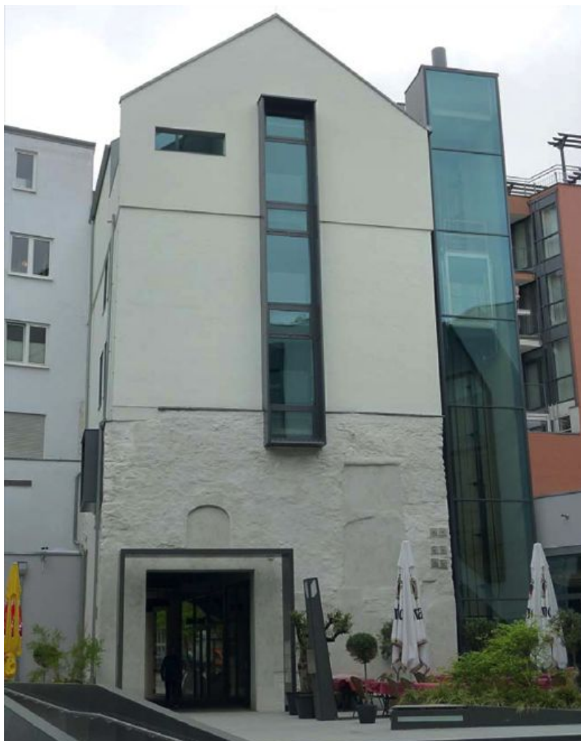
Bild 8: Auf der nach Süden weisenden Rückseite erhielt das Haus „Zur Sonne“ ein Lichtband, das die nunmehr älteste erhaltene Barocktreppe Jenas belichtet. Außerdem wurden ein Aufzug und ein neues Treppenhaus angebaut.
