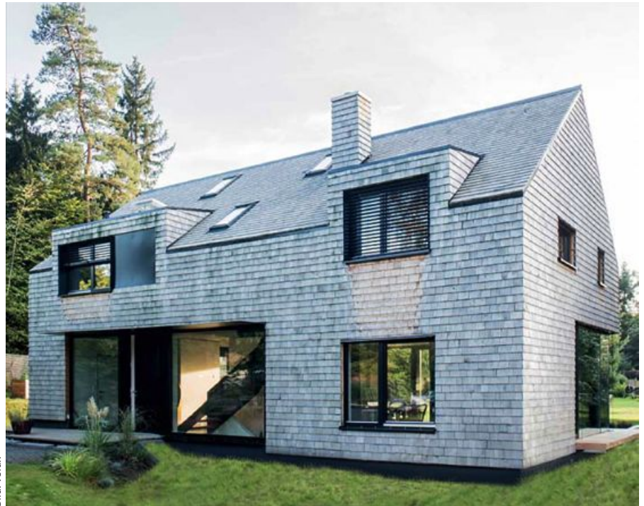
In der Vorderansicht ist der Schornstein zu sehen, der sich – ebenfalls verschindelt – in das Gesamtbild einfügt.
