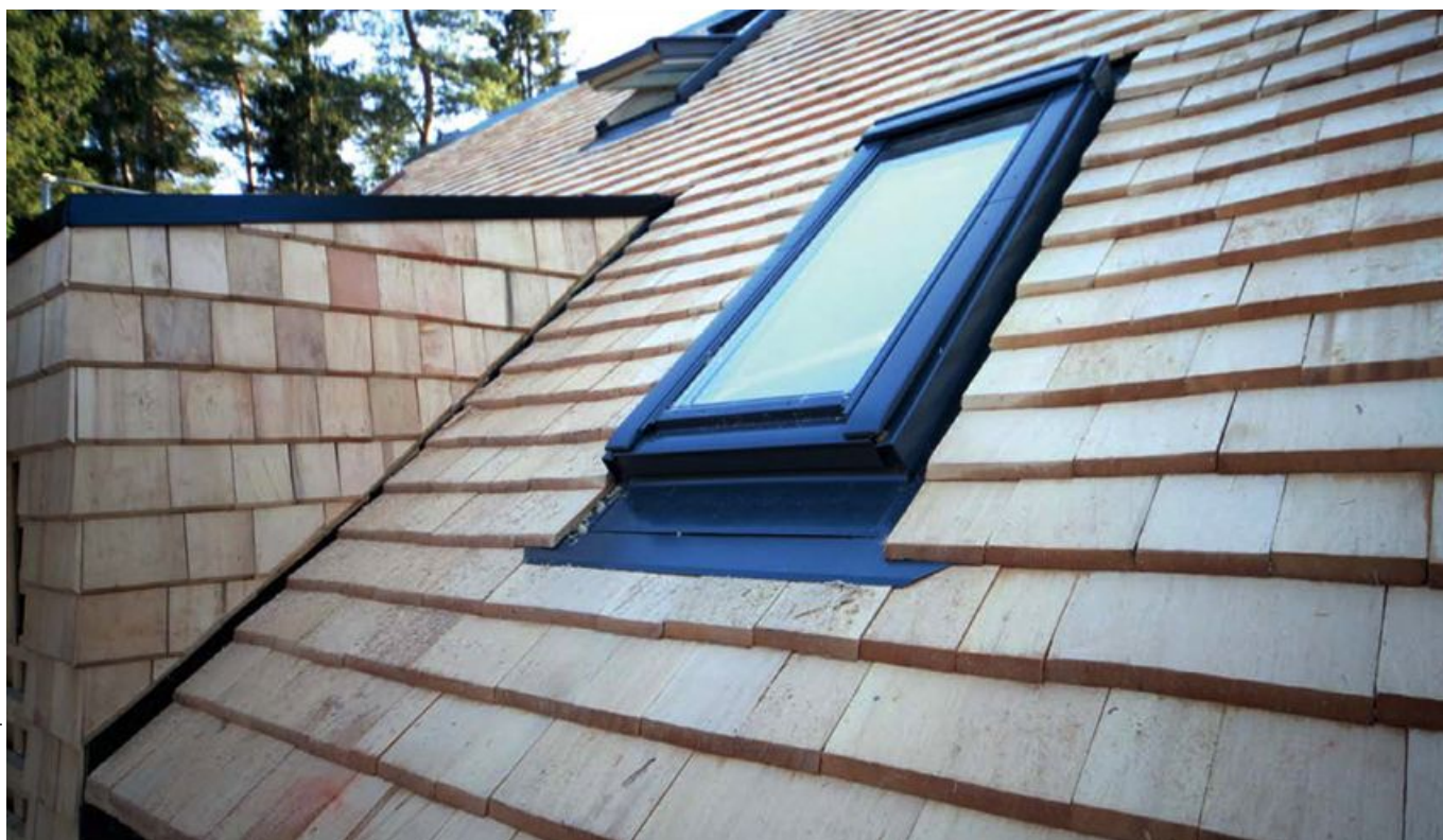
Mit den passenden Eindeckrahmen können die Holzschindeln einwandfrei an die Dachfenster herangeführt werden.
