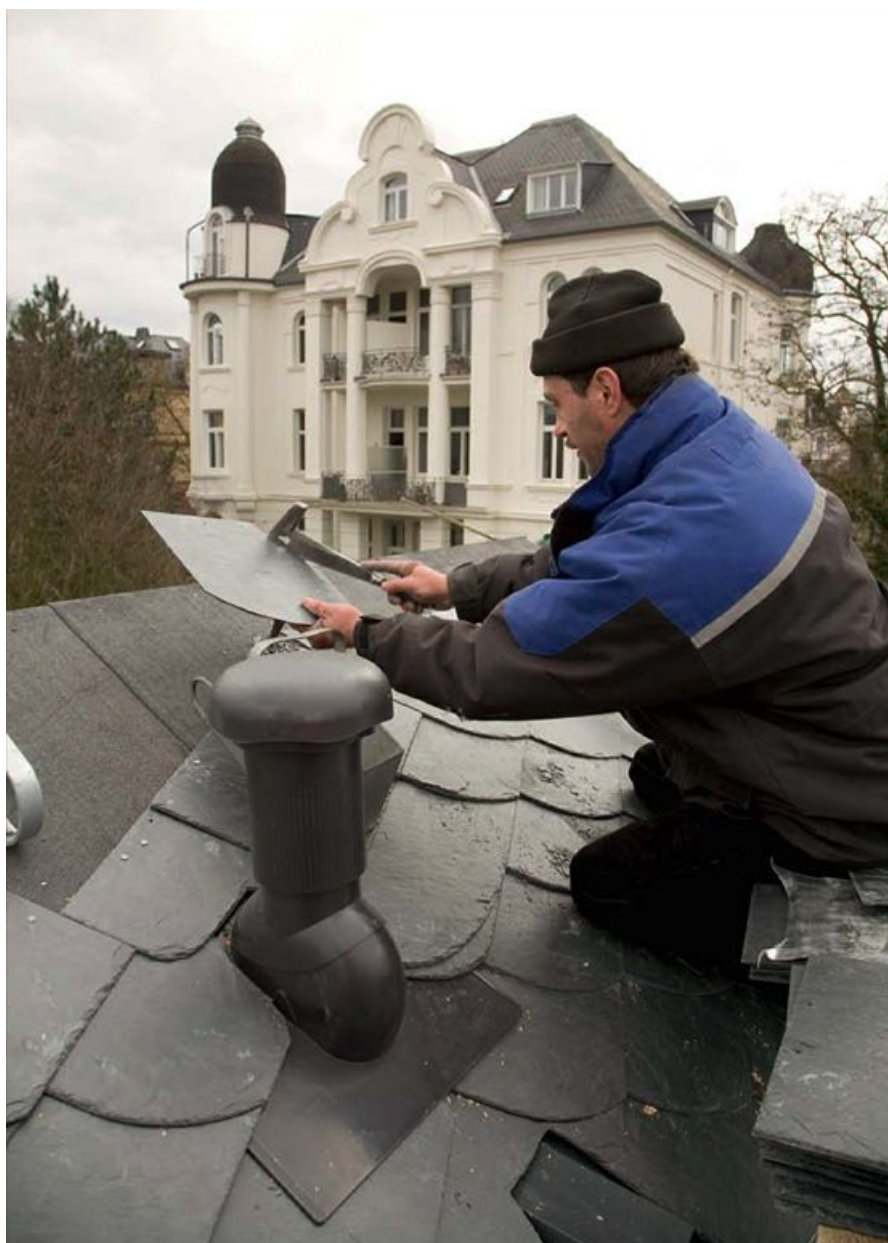
Mit den entsprechenden Unterteilen können Lüfter in jedes Dach eingebaut werden.
