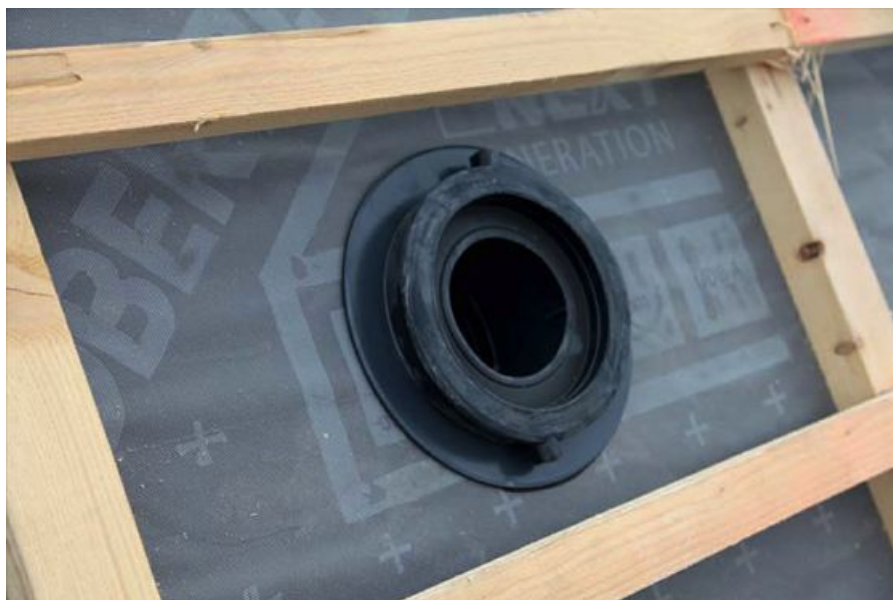
Ein Dämmstoffdurchgang für Aufdach-Dämmelemente erleichtert die Durchführung der Entlüftungsleitungen durch die Dämmung.
