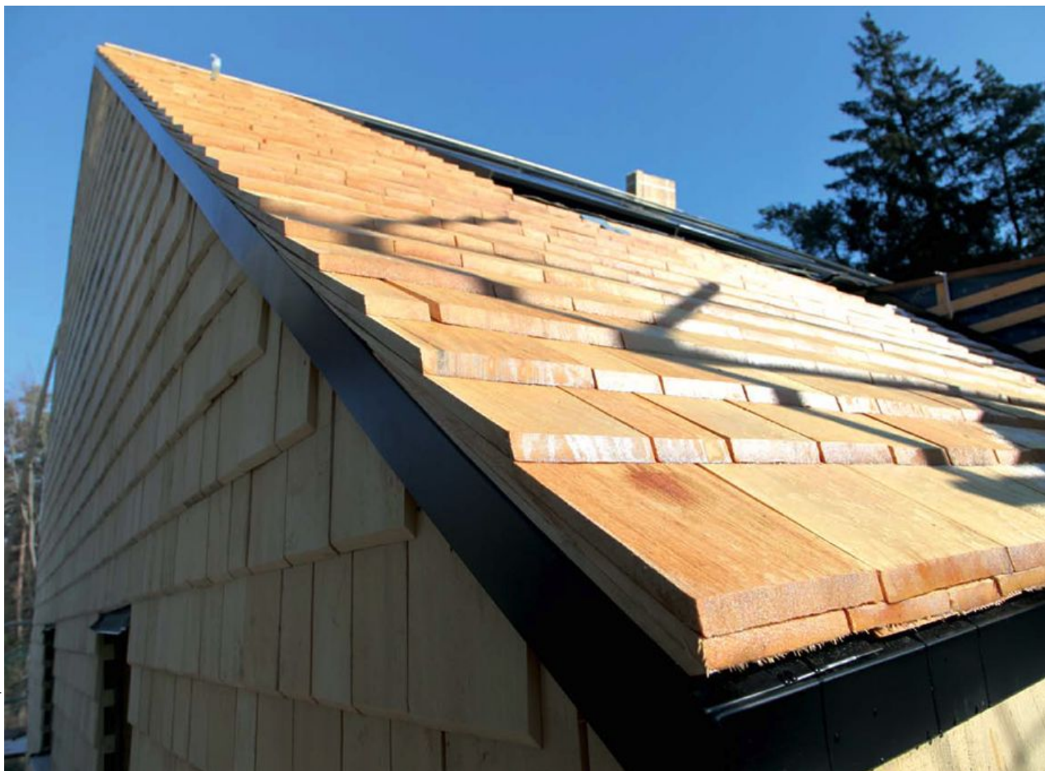
Dachrinnen gibt es nicht. Der Übergang vom Dach zur Fassade kommt unauffällig und doch sehr speziell daher.
