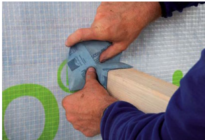
Bei quadratischen Durchdringungen sind selbstklebende 3D-Formteile die beste Wahl.
