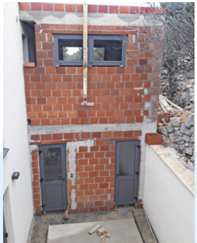
15 Die beiden Fenster vorne und hinten liegen exakt in einer Flucht, unten schließen zwei Türen ab. Über dem Decken-Betongurt dient eine letzte Ziegelreihe als Windschutz fürs folgende Metalldach.
