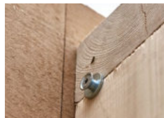
17 Zu diesem Zweck werden spezielle Verbinder eingesetzt. Über die Halteschraube (Kragenschraube)...
