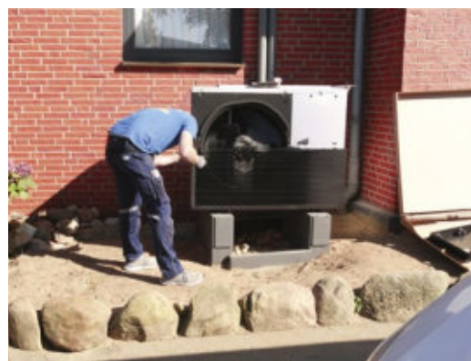
7 Der Handwerker bringt das schwarze Frontgitter am Außengerät an, das den Ventilator verdeckt.
