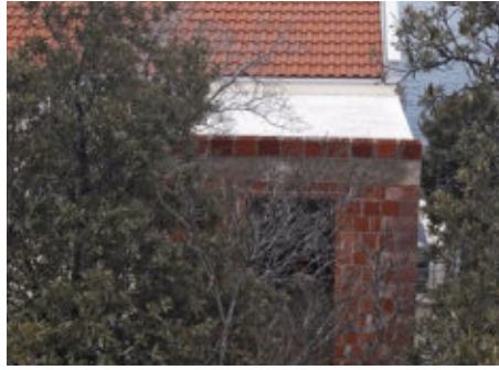
17 Blick auf die obere Decke mit Überbeton. Die vordere Ziegelreihe bildet mit der anderen Reihe (vgl. Abb. 15 ) und der Hauswand eine Art Wanne.
