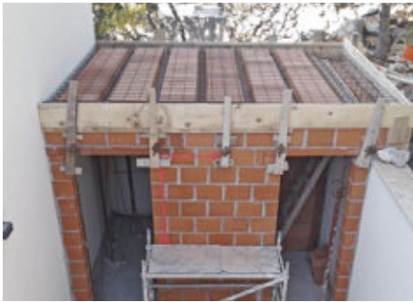
7 Nach der Randabschalung, der Verlegung von Bau-stahlmatten und Armierungsseisen sowie einer guten Abspießung von unten her kann der Beton kommen.
