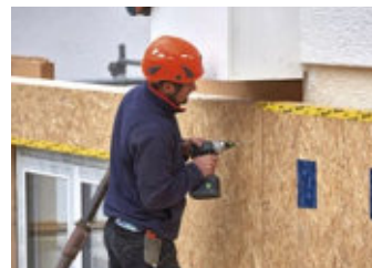
14 Die beiden nebeneinander stehenden Wandteile werden mit Holzbau-schrauben verbunden.
