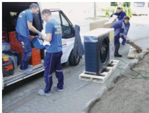
4 Die Montage der Wärmepumpe ist eine Sache für Profis. Die Fachhandwerker liefern das Gerät an.
