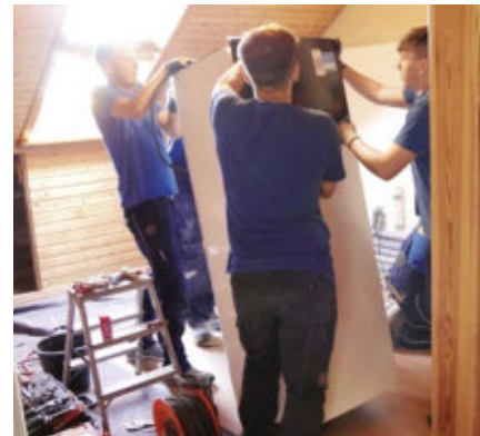
10 Das Innengerät ist eine kompakte Einheit mit einer geringen Grundfläche und Bauhöhe.
