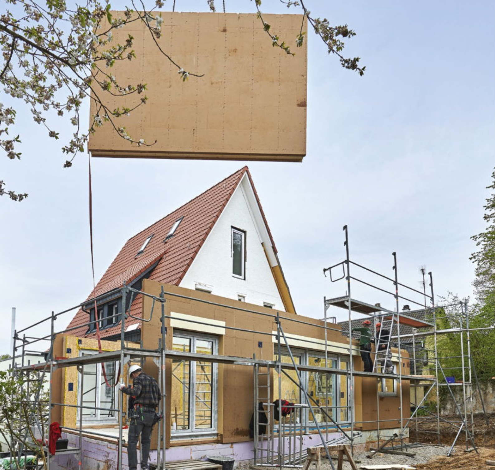
25 - 26 Die fensterlose Wand bildet den Abschluss des Anbau-Erdgeschosses. Die vermeintlich leichte Aufgabe erweist sich als durchaus anspruchsvoll, denn die Anschlüsse müssen nach zwei Seiten passen.
