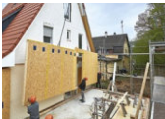
11 Die Klebebänder dienen dazu, die Luftdichtigkeit der Wand nach außen zu gewährleisten.
