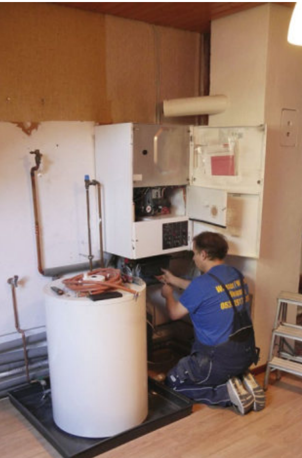
8 Der Gas-Brennwertkessel und Trinkwasserspeicher unter dem Dach werden demontiert und durch das enge ...
