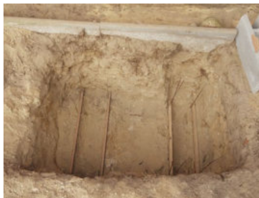
2 Das Fundament für den Sockel des Außengeräts wird vorbereitet, damit das Gerät aufgestellt werden kann.
