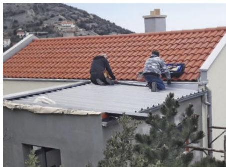
25 So liegt das Metalldach in der Wanne. Leicht schräg läuft es rechts zur Regenrinne. Ein Formblech am Haus bildet einen sicheren Wandanschluss.
