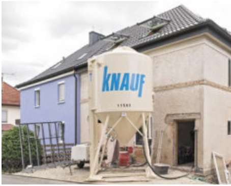
1 Die Doppelhaushälfte, Baujahr 1927, wurde kernsaniert. Innen haben die Handwerker Rotkalk-Putz aus dem Silo maschinell auf die Wände aufgebracht.
