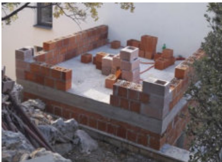
12 Die Ecksteine werden verzahnend vermörtelt, dazwischen wie gehabt Ziegelmauerwerk. Vorne erkennt man schon die Türöffnung für eine spätere Schiebetür.
