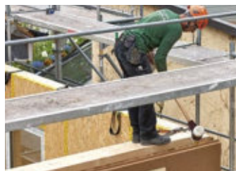
23 Hier wird mit dem Vorschlag-hammer ein bisschen nachgeholfen, um die Eckverbindung zu optimieren.
