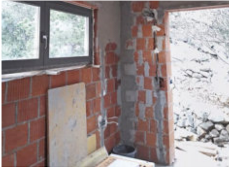
16 Erstes Raumgefühl im zukünftigen Schlafzimmer im zweiten OG. Links das Fenster über dem späteren Bett, rechts die breite Öffnung für den Ausgang in das Hanggrundstück.
