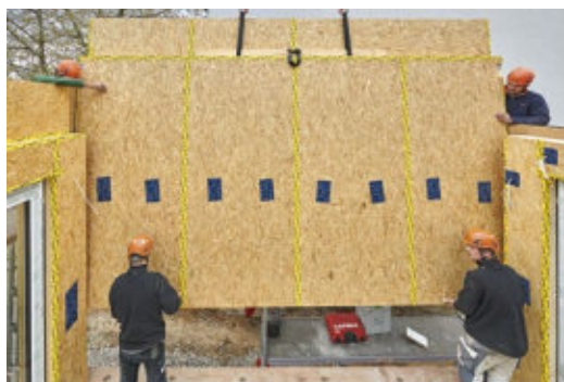
25 - 26 Die fensterlose Wand bildet den Abschluss des Anbau-Erdgeschosses. Die vermeintlich leichte Aufgabe erweist sich als durchaus anspruchsvoll, denn die Anschlüsse müssen nach zwei Seiten passen.
