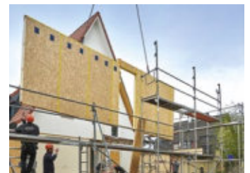
10 Das gedämmte Wandelement schließt – ohne Putzträgerplatte – an das Bestandsgebäude an.
