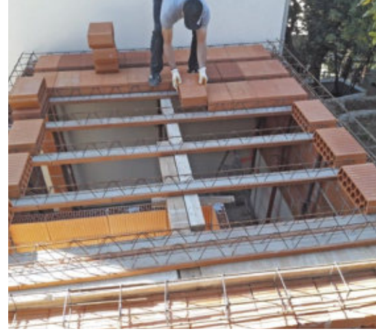
6 ... automatisch aufgeht, löste man die Endsituation (vorne im Bild) mit einem zweiten Ziegelträger. Die Decke füllt sich mit lose eingehängten Formsteinen.
