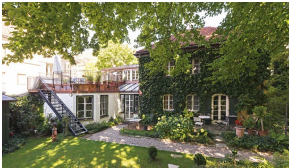
Alt und Neu in Harmonie: links das neu angebaute Gebäude, rechts das bestehende, denkmalgeschützte Eigenheim.
