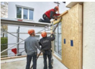
7 Das Wandelement wird ausgerichtet und vorübergehend per Stahlstütze fixiert.
