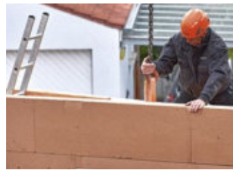
4 Nach dem Lösen der Sicherungen wird das Wandelement per Schraube mit dem Kranhaken verbunden.
