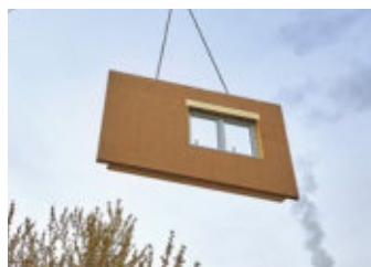
19 Diese Wand ist für das Obergeschoss des Anbaus vorgesehen und wird zwischengeparkt.
