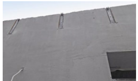
27 Mit solchen Haken werden dann die Attikableche gehalten. Später werden diese armiert und überputzt.
