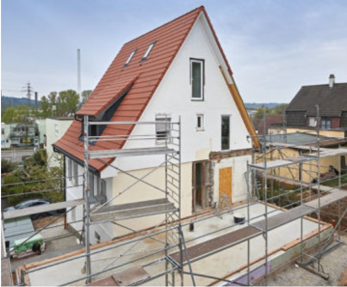
1 Der Übergang zum Haupthaus ist vorbereitet, die Bodenplatte getrocknet und gedämmt, die Gerüste aufgestellt.
