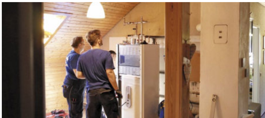
11 Das Wärmepumpeninnengerät wird aufgestellt und die Leitungen werden gelegt bzw. an das bestehende Heizsystem angeschlossen. Innen- und Außengerät werden miteinander verbunden.
