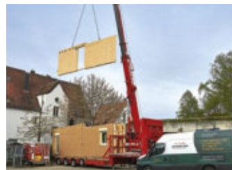
9 Hier kommt das nächste Element geflogen. Im Hintergrund ist ein Teil des Feuerwehrgebäudes zu sehen.
