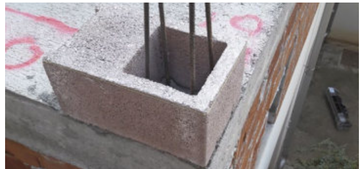
11 Nach Aushärtung der ersten Geschossdecke geht es mit dem zweiten Stock weiter. Spezielle Ecksteine und Bewehrungsstäbe machen den Anfang.
