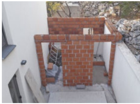
2 ... dann ebenfalls weiter mit Mauern. Vorne schon zu erkennen: die beiden Türöffnungen. Rechts läuft die erste Ziegelreihe überm Sturz bis über die Hangmauer.
