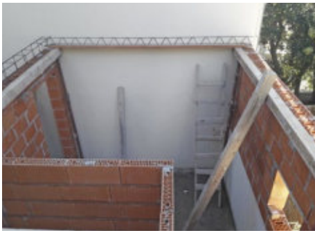
4 Die Umfassungswände haben ihre Geschosshöhe erreicht und der fassadennahe erste Ziegelträger liegt auf der Mauerkrone.
