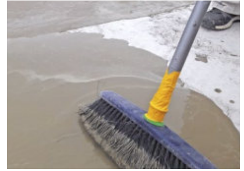
18 Zunächst wurde mit einer flüssig angemachten Trockenpulver- Dichtschlämme die gesamte Fläche zweimal abgedichtet. Darauf kamen dann zwei ...
