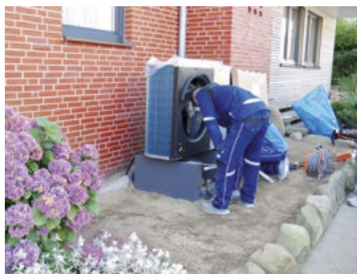
6 Aufstellung und Montage des Außengeräts auf dem Sockel. Das Modell gilt als besonders geräuscharm.
