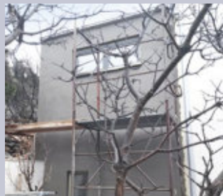
B Der neue Grundputz brauchte dann genügend Zeit zum Austrocknen.
