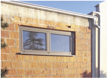
22 Die Kastenrinne hat man glücklicherweise leicht an das bestehende Fallrohr des Hauptgebäudes anschließen können.
