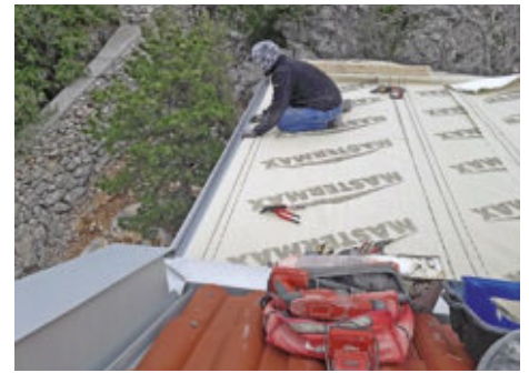
21 Perspektivenwechsel: Hier ist links die Dachrinne zu sehen, in die die Holzschalung hineintragt. Die Unterspannbahn bildet ein regensicheres Unterdach.
