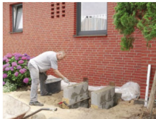
3 Selbst angepackt: Der Hausherr Volker Weinmann bereitet den Sockel für das Außengerät vor.
