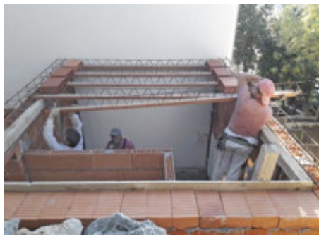
5 Nach und nach folgen die weiteren. Für richtigen Abstand und parallele Lage sorgen jeweils außen eingelegte Deckenziegel. Da das Raster nicht ...
