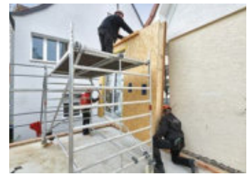
6 Das Element wird nicht direkt auf die Bodenplatte gesetzt, sondern auf die vormontierte Richtschwelle.
