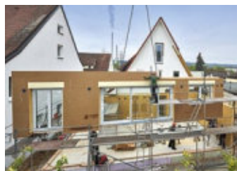
22 Die Kabelauslässe sind zwecks Winddichtigkeit mit Spezial-Klebe-manschetten abgedichtet.
