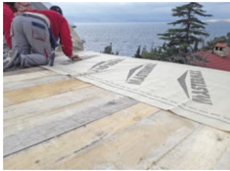
20 ... für das Metalldach. Die Dielen werden noch mit einer Unterspannbahn abgedeckt. Die Bretterenden (rechts) führen in die Entwässerungsrinne.
