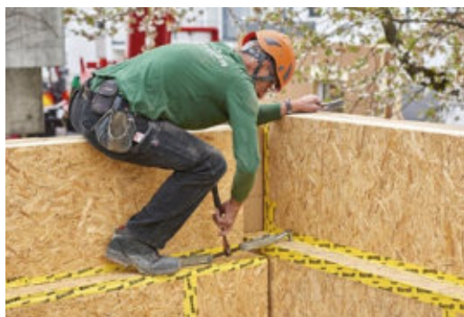
27 Mit Hilfe des Balkenzugs werden die Wandelemente fest zusammengefügt.
