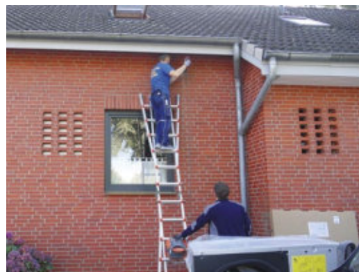
5 Bohrung durch die Hauswand für die Leitungen, die das Außengerät mit dem Innengerät verbinden.
