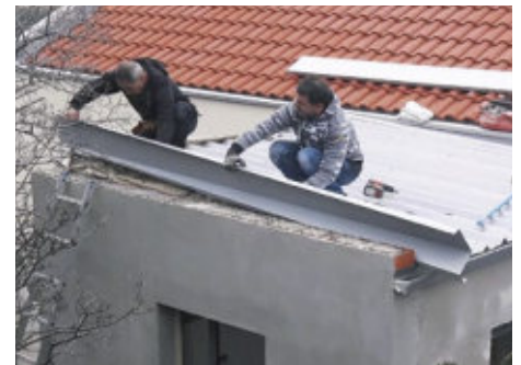
26 Über die Randerhöhungen werden U-förmige Zinkbleche verlegt, was für eine Anbindung ans Metalldach sorgt und einen Attika-Abschluss ergibt.
