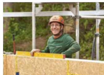
24 Der Richtmeister scheint zufrieden und hat zwischendurch ein Lächeln für die Kamera übrig.
