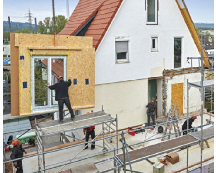
2 Hier schwebt das erste Wandelement seinem Bestimmungsort entgegen. Fenster und Türen sind ebenfalls vormontiert.
