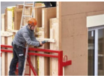
3 Die Transportsicherungen sorgen dafür, dass die Wandelemente unbeschädigt bleiben.
