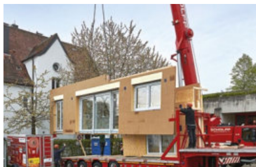
16 Wichtig für die Stabilität und die Energieeffizienz sind exakte und dichte Übereckverbindungen.
