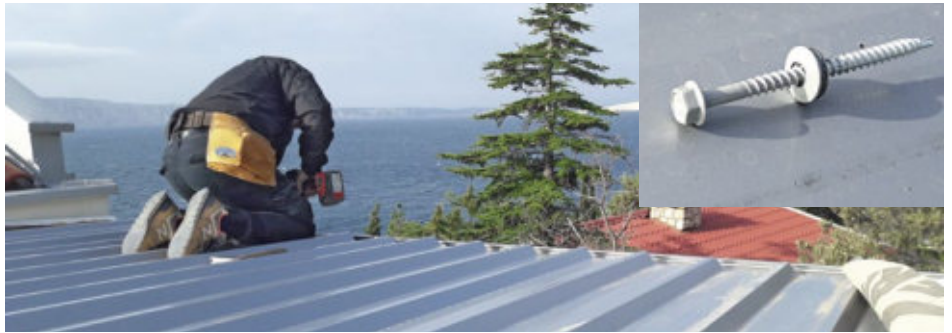
23 Die Trapezblechtafeln werden übereinander verlegt und bilden so eine geschlossene, wasserdichte Ebene mit Neigung in Richtung Regenrinne. Befestigt werden sie mit speziellen Sechskantschrauben mit Dichtring (siehe eingeklinktes Foto). Sie halten hier besonders gut in der Holzunterkonstruktion. Je nach Länge ...
