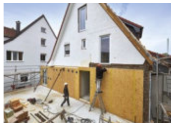
13 Auf den etwas höheren Bereich (rechts) wird später ein weiteres Geschoss montiert.
