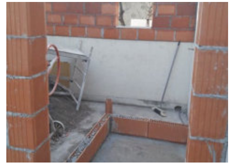
3 Blick nach innen, wo die Grundreihe die Abtrennung für den Vorratsraum markiert. Hinten ein Fenster für das spätere Gästezimmer.
