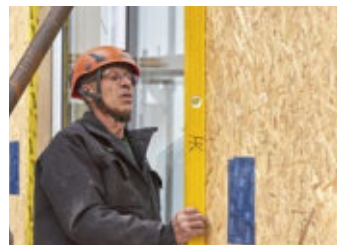
8 Der Richtmeister überzeugt sich davon, dass alles im Lot bzw. „im Wasser“ ist.
