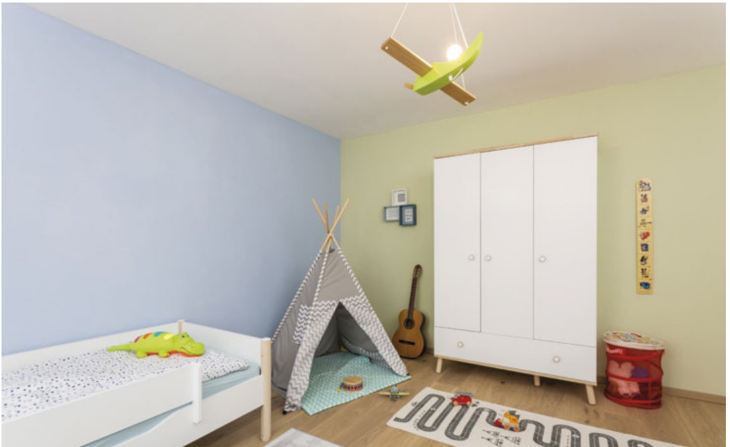
Besonders im Kinderzimmer wünschte sich die Bauherrin verputzte Wandflächen für ein gesundes Wohnumfeld. Die Wände wurden mit Rotkalk verputzt und mit abgetönter Rotkalkfarbe beschichtet.
