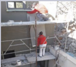
A Auf einer Polystyrol-dämmschicht wurde zunächst einmal Gewebe eingespachtelt.
