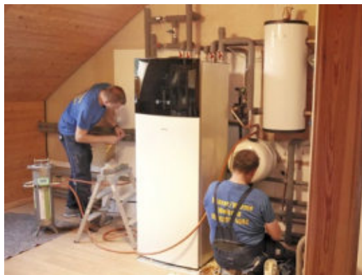
12 Die Arbeiten sind fast abgeschlossen. Kurz vor der Inbetriebnahme wird das Heizsystem neu befüllt.
