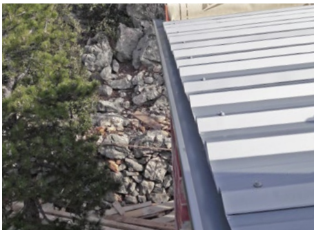
24 ... der Tafeln und Windlast verschraubt man alle 40 cm und zwar stets auf der Erhöhung der Trapezform. Hier die Blechenden.
