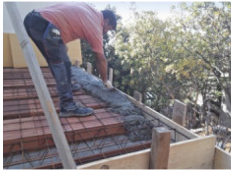
8 Da hier keine Betonpumpe im Einsatz möglich war, arbeitete man händisch. Begonnen wurde an den Rändern, wo gegenüber den ...
