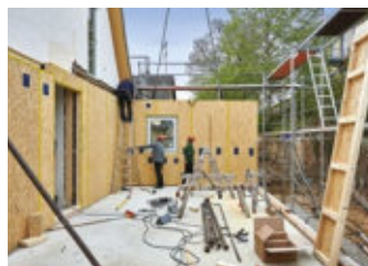
16 Wichtig für die Stabilität und die Energieeffizienz sind exakte und dichte Übereckverbindungen.
