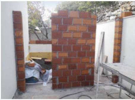
1 Im hinteren Bereich der großen Außenfläche hat man so abgemauert, dass ein 10 m 2 großer Raum entsteht. Auf der hinteren Brüstungswand ging es ...
