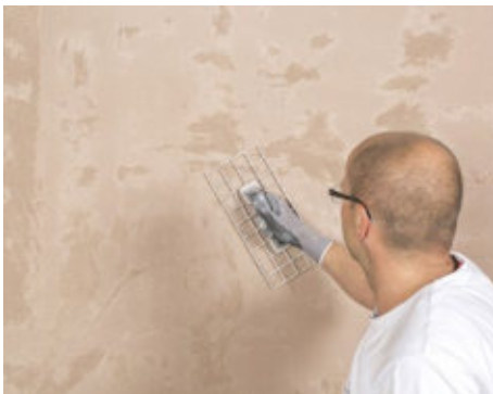
4 Feinere Unterschiede und Materialüberschuss des Unterputzes können mit einem Gitterrobot ausgeglichen und der Putz leicht angeraut werden.
