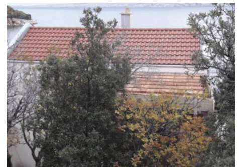
14 Dann folgt wieder eine Ziegel-Filigran-Decke. Die Gesamthöhe war so bemessen, dass der Anbau deutlich unterhalb der Dachkante des Haupthauses bleibt.
