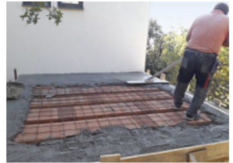
9 ... Einhängziegeln mehr Tiefe vorhanden ist und der Beton erst auf Höhe gebracht werden muss, bis er über die Ziegelfläche verteilt und glattgezogen wird.
