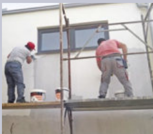
C Die Endbeschichtung stellt ein feinkörniger, abgeriebener Silikonharzputz dar.
