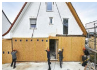
12 Das exakte Setzen der Wandelemente erfordert Erfahrung und ein eingespieltes Zimmerer-Team.
