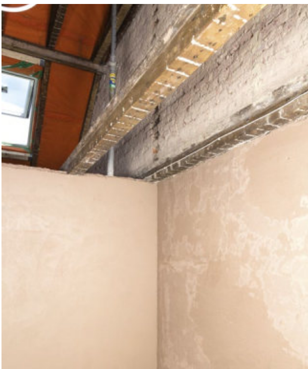
6 Der rötlich-braune Farbton des Putzes ähnelt dem des historischen Ziegelmauerwerks, das hier noch über der neu verputzten Wand im Dachstuhl deutlich zu sehen ist.
