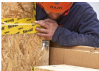
18 ... wird der Aufnahmetrichter gestülpt, sodass die Wandteile fest aneinandergespresst werden.
