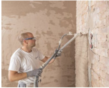
2 Auf den vorbereiteten Putzgrund wurde Rotkalk Grund in bis zu 3 cm Stärke aufgetragen. So konnten Unebenheiten im Mauerwerk ausgeglichen werden.
