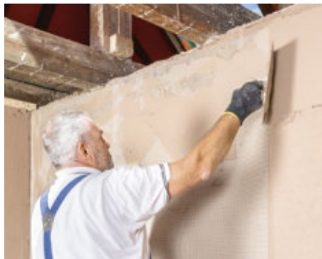
5 Zwischen die erste und zweite Putzlage wurde ein Innenputzgewebe in den Putz eingebettet, um Rissbildungen zu vermeiden.
