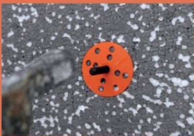
8. Die Tellerdübel werden dann so tief versenkt, dass sie bündig mit der Oberfläche abschließen.
