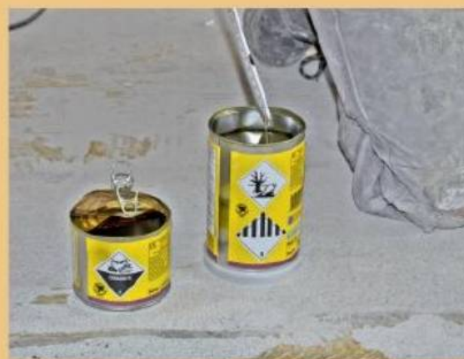
8. Zusätzlich wird ein Zwei-Komponenten-Harz angerührt, mit dem die Risse verfüllt werden.
