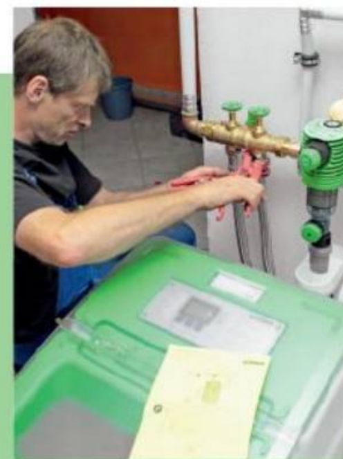
11. ... mit der neuen Wasserleitung. Sobald die Wassermenge in einer der Kammern enthärtet wurde, ...
