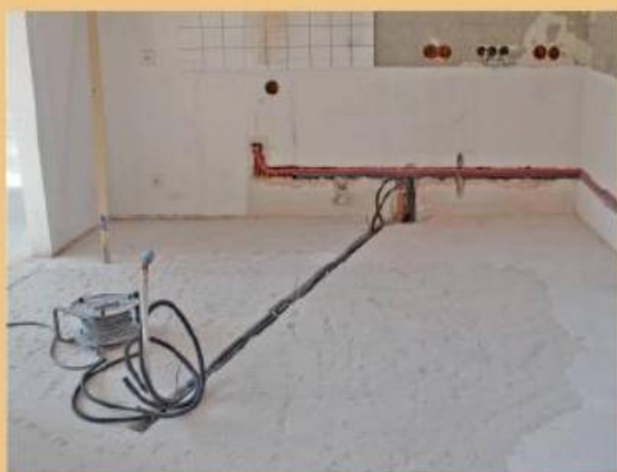
4. Von der Wand her führte man dann in einer Ausfräsung Strom- und Gasleitung in den Raum.
