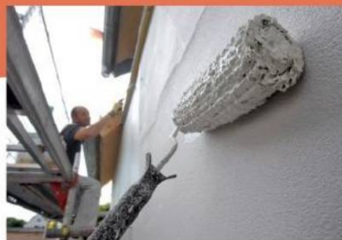
14. Letzte Komponente eines Dämmsystems ist die Farbe, die auf das System abgestimmt ist.
