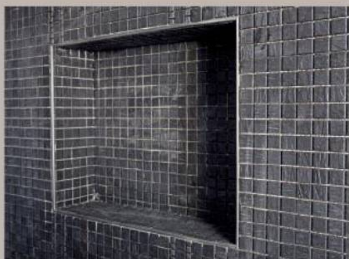
20. Ästhetisch gelöst: Bei perfekter Verlegung laufen die Fugen ohne Versatz in einem durch.
