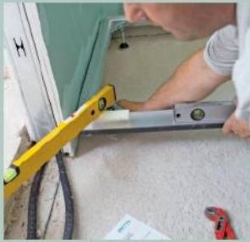
2. ... waagerechten Einbau des Tragrahmens bei Unebenheiten.
