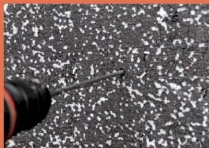
7. ... zweiten Arbeitsdurchgang zusätzlich fürs Verdübeln bis tief ins Mauerwerk durchbohrt.
