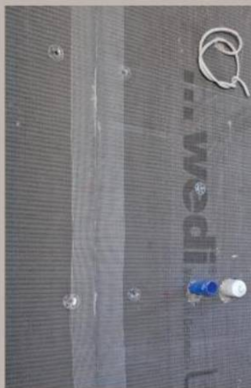
11. Die Plattenstöße werden mit einem Armierungsgewebe überdeckt und dann überspachtelt.
