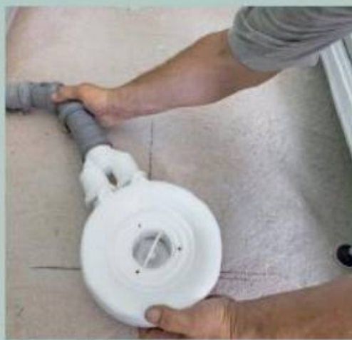
5. Ein Abfluelelement sorgt für den sicheren Abtransport des Wassers.
