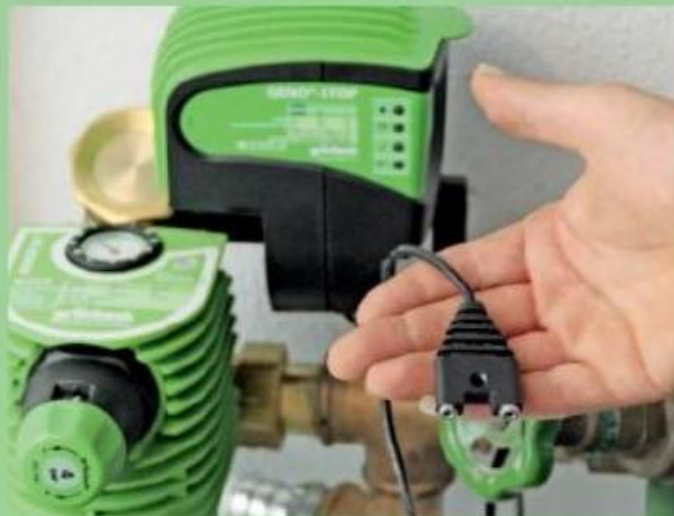
5. Ein Bodensensor sperrt bei unkontrolliertem Wasseraustritt im Raum sofort die Wasserzufuhr.
