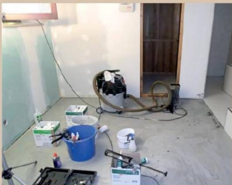
Die Rohbausituation: An der Kelleraußenwand wurde gedämmt und mit Gipskartonplatten beplankt, die Sauna bekam eine Verkleidung und der Estrich für den Holzboden wurde vorbereitet.
