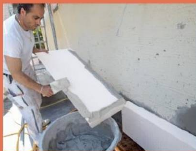
1. Im Sockelbereich werden Perimeter-Dämmplatten verklebt. Mit einer Randverklebung ...
