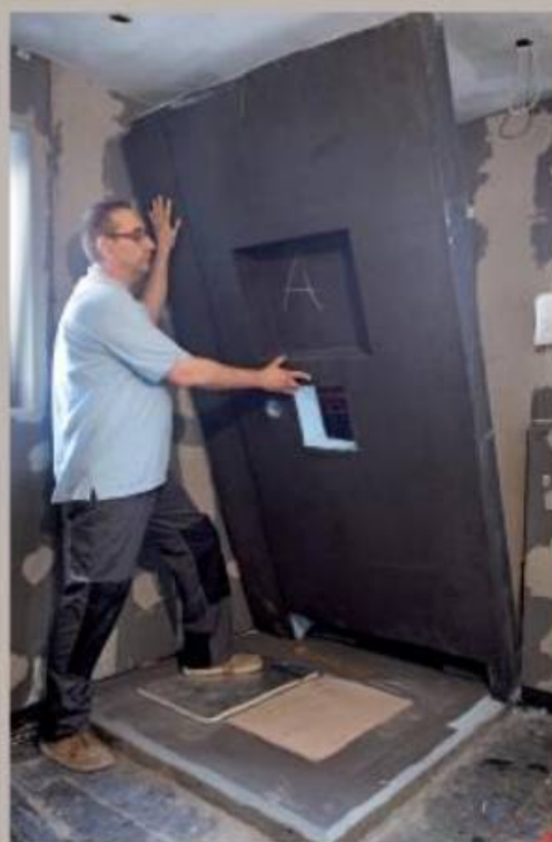
6. Das Duschelement beinhaltet die Nische sowie die Aussparungen für die Armatur und den Wandablauf.
