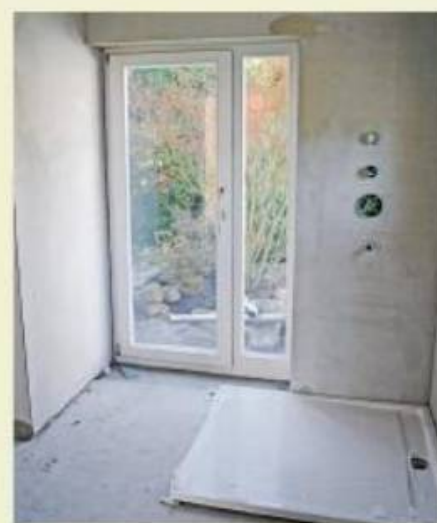
Der Duschboden ragt bis in den Türraum und sorgt wie die Wände für ruhige Flächen.
