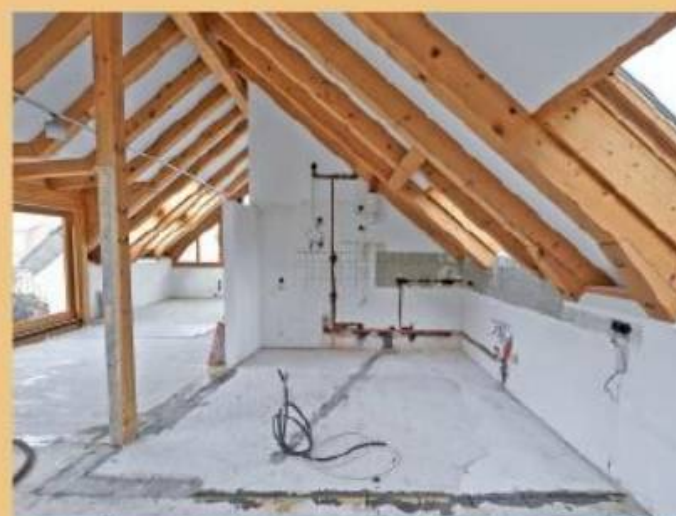
11. Der so ausgebesserte Rohboden ist damit vorbereitet für die folgenden Belagsarbeiten.
