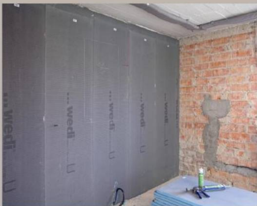
4. Die Bauplatten werden raumhoch und dicht gestoßen verlegt. An dieser Wand dienen sie z. B. als Trägermaterial für die Fliesen, als Haftgrund für den Putz und als Feuchteschutz.
