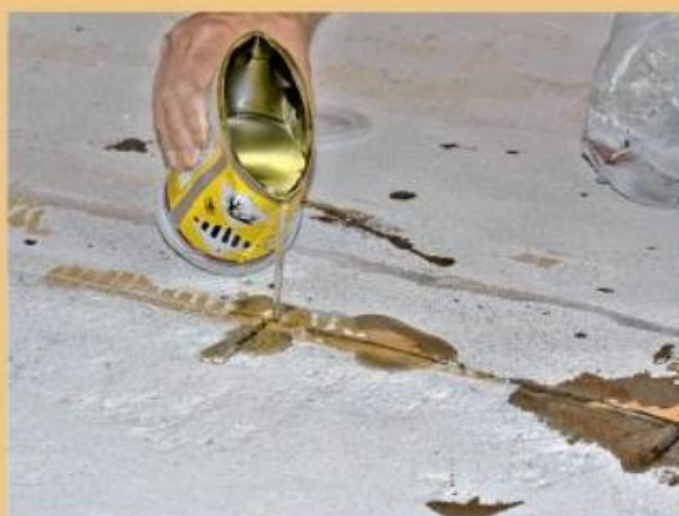
9. Das flüssige Material wird gezielt in die Risse und Fräsungen gegossen. Zusammen mit ...
