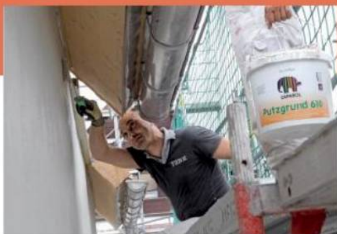
12. Ist die Armierungsschicht trocken, folgt die flächige Putzgrundierung mit einer Farbbrolle.
