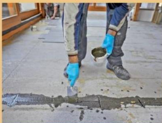
10. ... einer Spachtelmasse werden die Fugen so dauerhaft und oberflächenbündig geschlossen.
