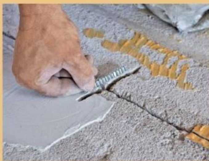
7. Zur Rissarmierung und Vermeidung von weiterer Rissbildung dienen Metallklammern.
