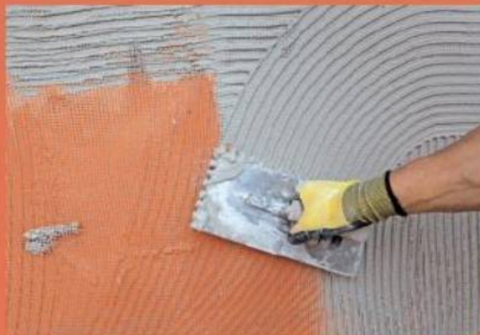
10. ... eingelegt und mit einer Zahnkelle noch einmal mit derselben Spachtelung überzogen.
