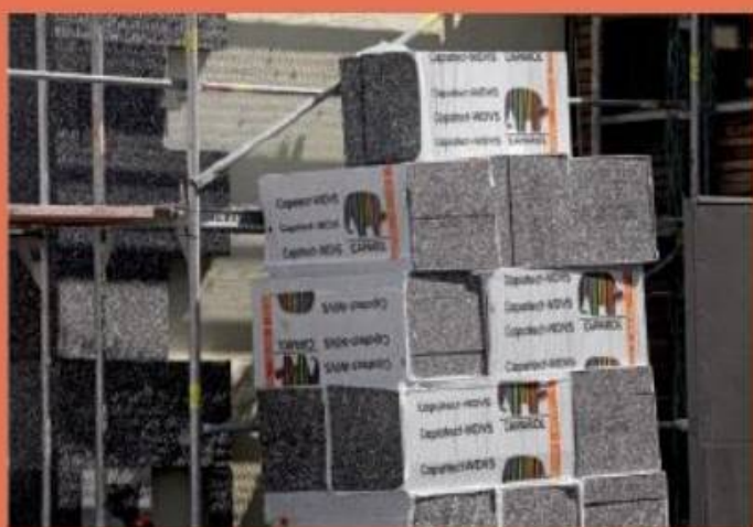
5. Nach der Sockeldämmung schließt die eigentliche Fassadendämmung als WDVS an.
