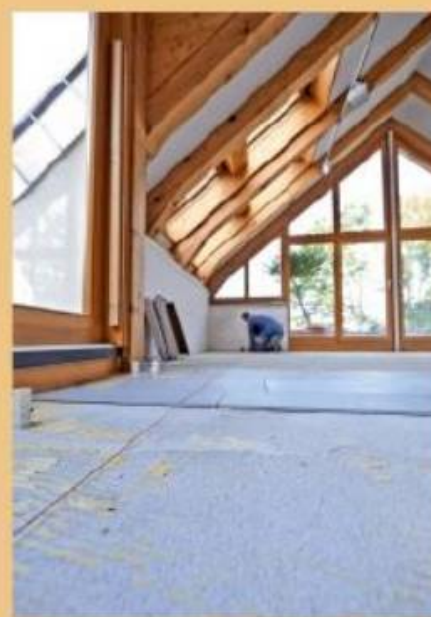
13. Mit einem Schnurschlag stellte er die Parallelität der Querfugen zur Wand fest und richtete die Fliesen entsprechend aus.
