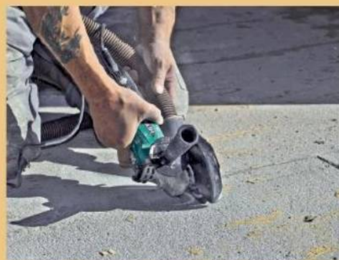
5. Zur Rissanierung hat man quer zu den Rissen 15 bis 20 cm lange Schlitzte in den Estrich gefräst.
