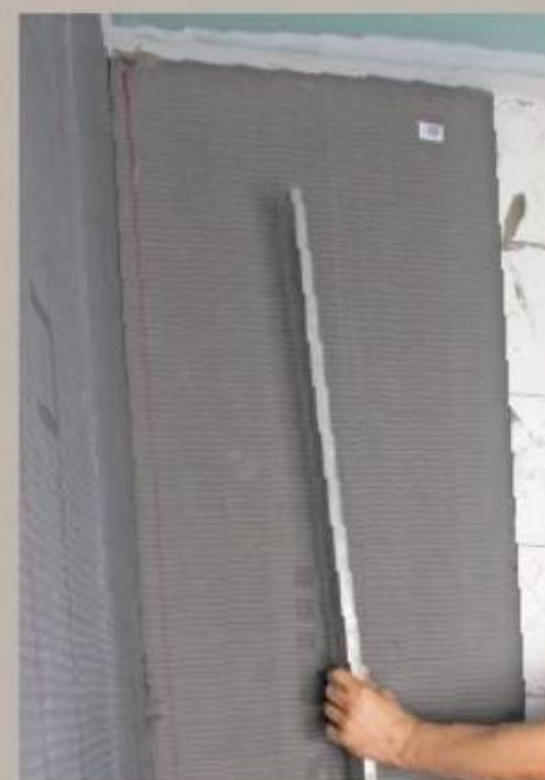
3. Nun vollflächig die Platten ansetzen, mit einem Richtscheit festdrücken und senkrecht ausrichten.
