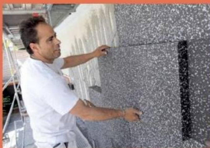
6. Die weiß gefleckten Polystyrol-Platten werden zunächst verklebt und dann in einem ...
