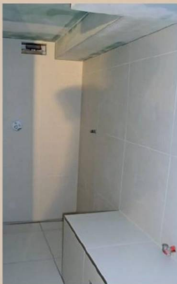
Die neue Dusche bekam eine dezente Linienentwässerung, großformatige Relieffliesen, eine Kopf-Schwallbrause sowie einen Anschluss für einen Sauna-Abkühlschlauch.
