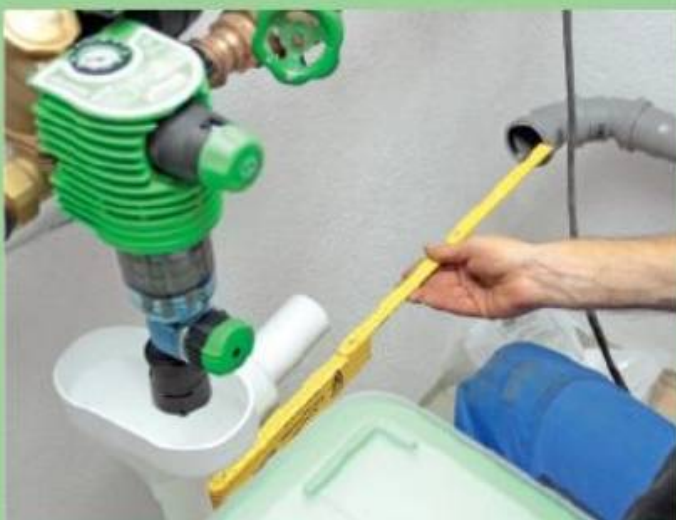
7. ... bis zum Filter verlegt, von wo aus das Spülwasser über den Trichter abgeleitet wird.
