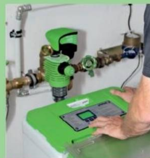
15. Das selbstlaufende Inbetriebnahmeprogramm erfordert dann nur wenige Eingaben.
