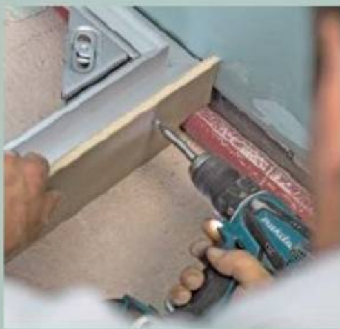
4. Dieser wird mit dem Aluminiumprofil verschraubt.
