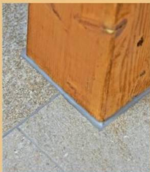
18. Dauerelastisch verfugen sollte man auch bewegliche Teile – wie hier den Dachstuhlholzständer.
