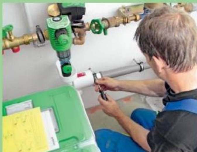
8. Das im Gefälle liegende Rohrstück wird nun dicht mit dem Anschlussflansch verbunden.
