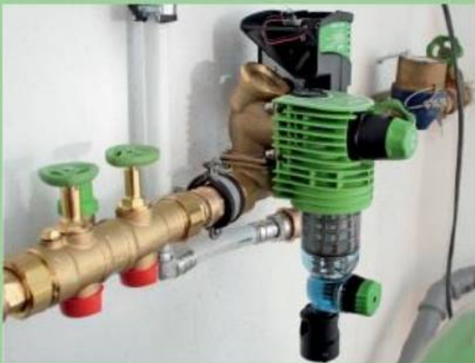
4. Die neu installierte Filtereinheit, rechts die Wasseruhr, oben schwarz das Aquastop-Element.
