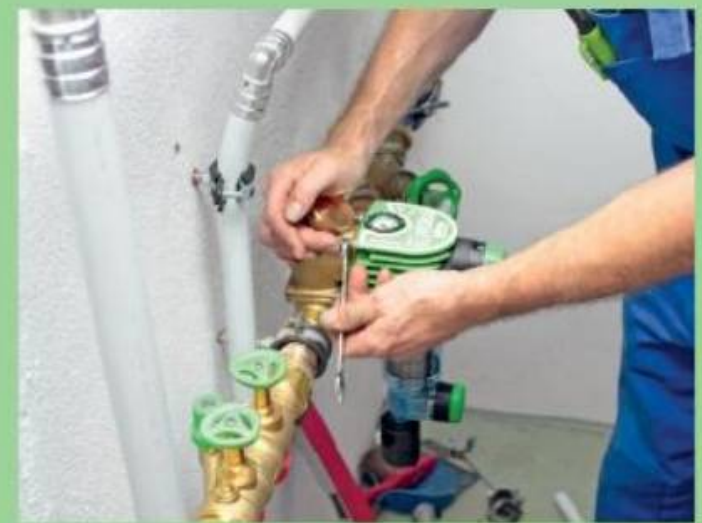
3. ... ein Filter mit unterbrechungsfreier Rückspülfunktion, Druckminderer und Manometer.
