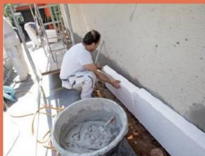
3. Dämmplatten horizontal ausrichten und dann versatzfrei und dicht stoßend verkleben.
