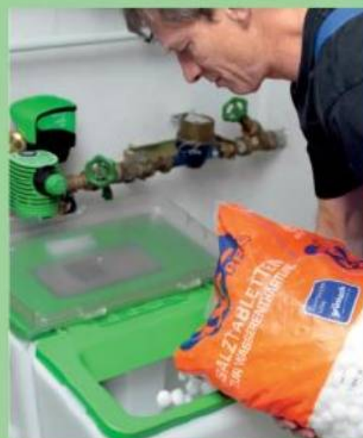
14. Jetzt kann die Inbetriebnahme erfolgen. Dazu wird die Anlage zuerst mit Salztabletten befüllt.
