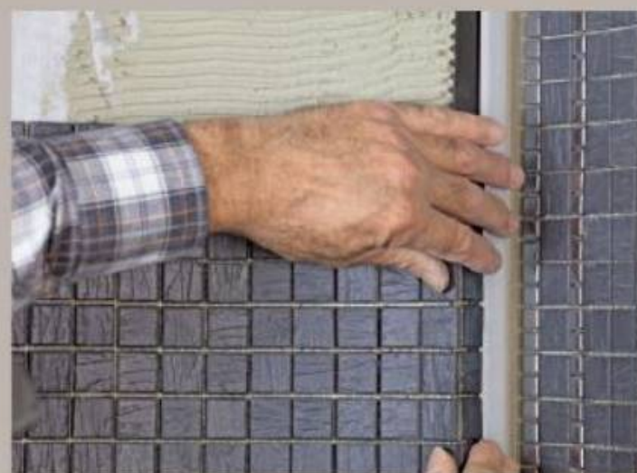
17. Sie können auch gut über Eck verlegt werden, wie hier an der Kante zur versenkten LED-Schiene.
