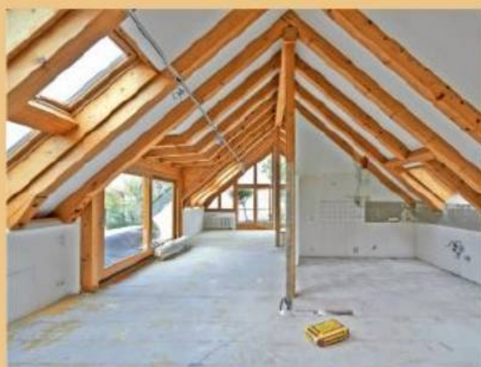
1. Entkernt und entfernt: Das Dachgeschoss zeigt sich in seiner ganzen, beeindruckenden Größe.
