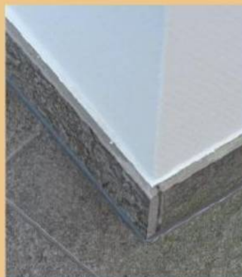
19. Auch die aus den Bodenfliesen geschnittenen Sockelriemchen dichtete man mit Silikon ab.
