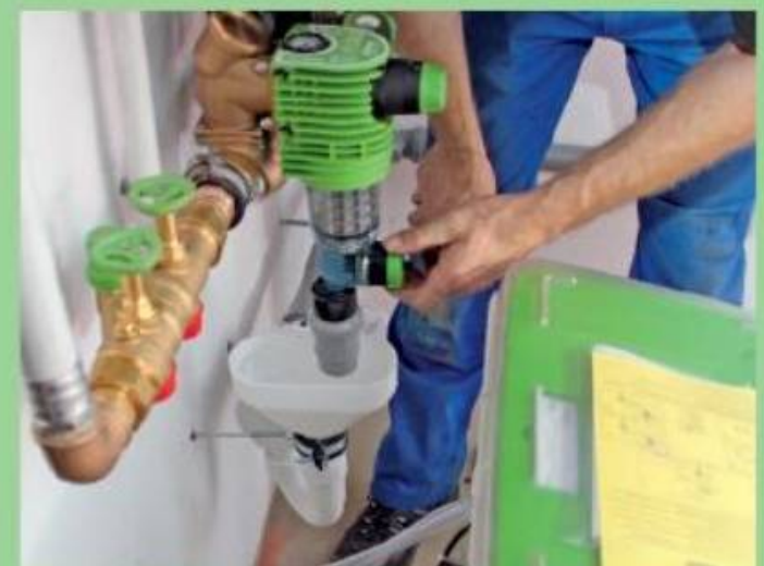
9. Beim Öffnen setzt der Rückspülbetrieb ein und leitet das Wasser in die Kanalisationsleitung ab.
