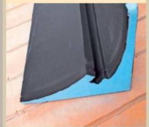
12. Auf diese Weise entstand die Eckdusche samt „Schamwand“ zum WC. Der gesamte Raum wurde mit Bauplatte ausgekleidet und bekam so ebene Wände, die erforderlichen Installationswände und eine Wärmedämmung.
