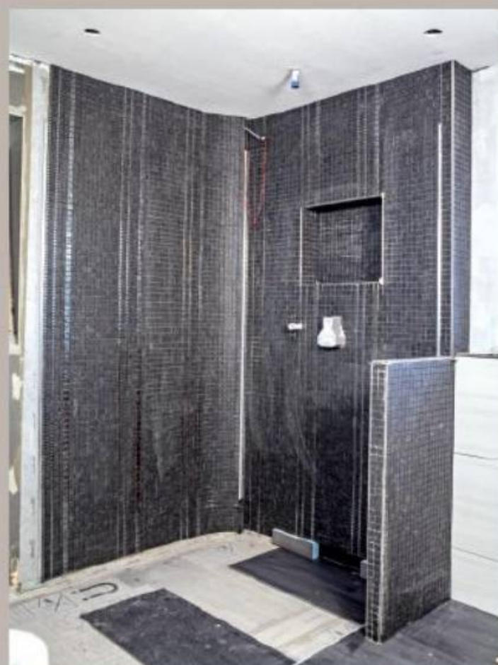
21. Auf dem Boden wurden großformatige Fliesen aus derselben Keramikserie verlegt. Dank des gleichmäßigen Gefälles hin zum Wandablauf konnte man unschöne Fliesenschnitte vermeiden.
