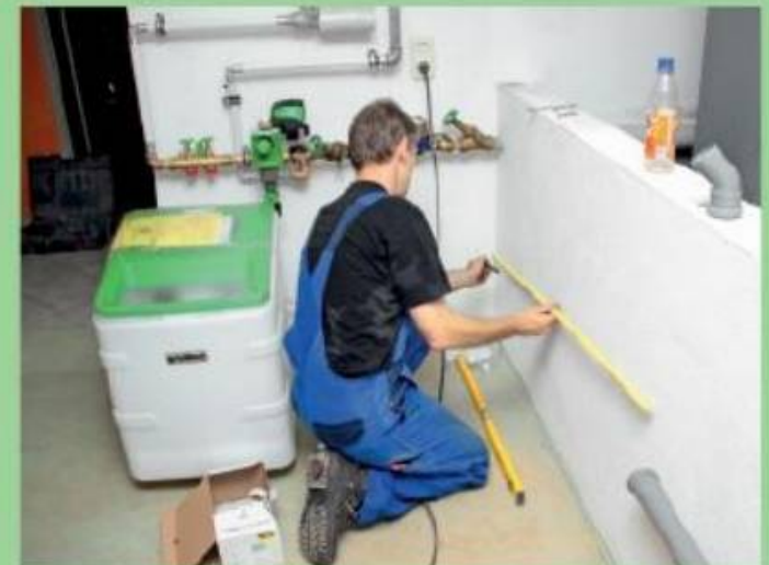
6. Zum Rückspülen des Filtereinsatzes wird vom Kanalanschluss aus eine Gefällerohrleitung ...
