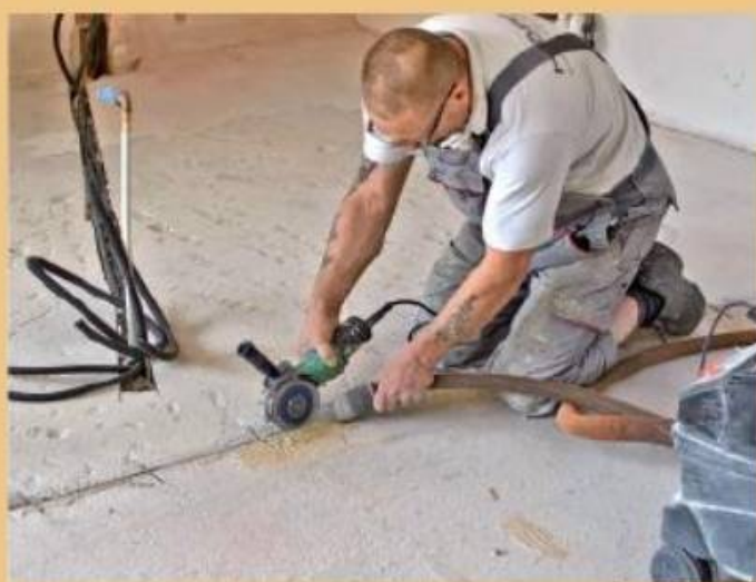
6. Ebenso wurden die Risse in Längsrichtung tiefer ausgefräst und sorgfältig entstaubt.
