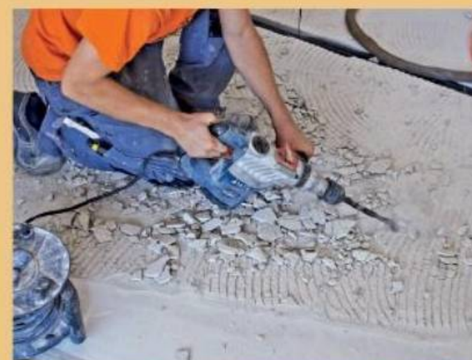
3. Mit einem Meißelhammer ging es dann an das Kleberbett des bisherigen Küchenfliesenbodens.
