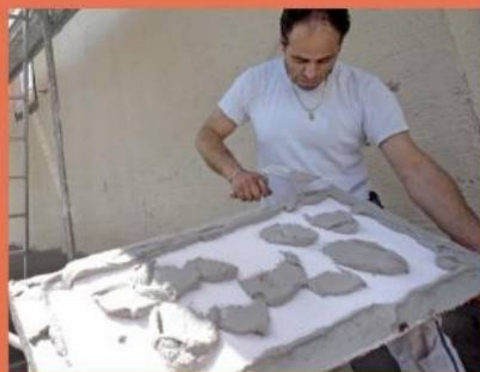
2. ... sowie weiteren Kleberbatzen haften die Sockelplatten ausreichend an der Altfassade.
