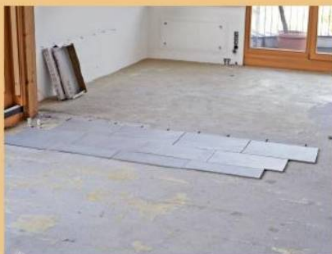
12. Unser Fliesenleger legte zunächst einmal probeweise die ersten drei Fliesenreihen aus.
