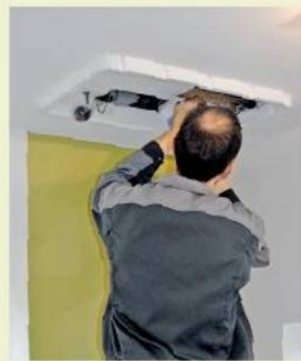
Das Kopfbrause-Element sitzt später als Regenhimmel bündig in der Gipskartondecke.
