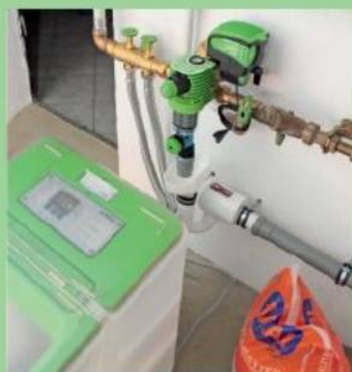
12. ... setzt hier der Regenerationsprozess ein und der zweite Ionen-Austauscher geht in Betrieb.
