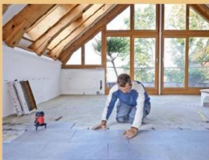
14. Dann konnten die ersten Fliesen mitten im Raum auch schon fest verklebt werden.
