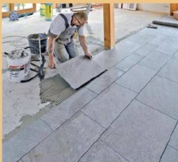
17. Weiter ging es dann in die andere Raumrichtung. Hier sieht man gut die drei unterschiedlichen Formate.
