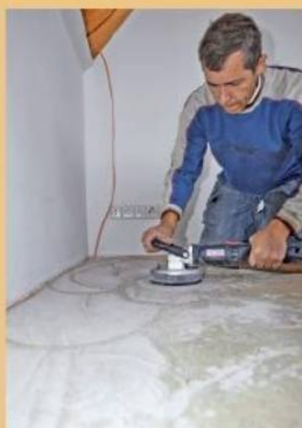
2. Alte Kleber- und Schaumreste von Teppich- und Parkettboden wurden sorgfältig abgeschliffen.
