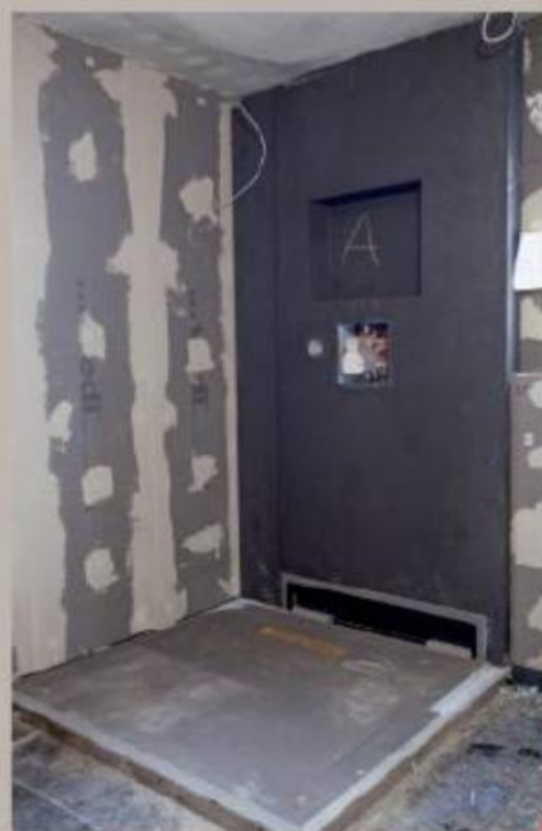
7. Es wird auf das Duschboden-Gefälleelement gesetzt und in gleicher Weise wie die Platten verklebt.
