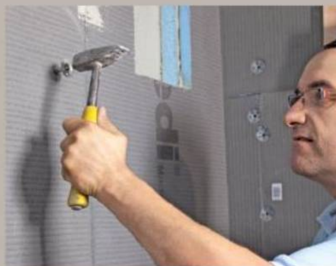
5. Da die Wand nur teilweise tragfähig war, kamen spezielle Metaldübel zur Fixierung zum Einsatz. Fünf Dübel pro Quadratmeter.
