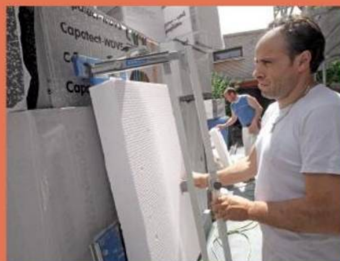
4. Je genauer zugeschnitten wird, desto lückenloser wird die Dämnhülle auch ausgebildet.
