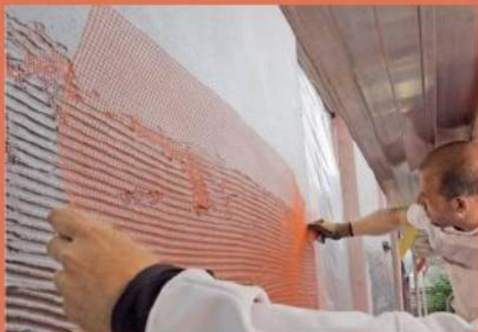
9. In die Spachtelmasse mit widerstandsfähigen Nano-Quarz-Partikeln wird nun ein Gewebe ...
