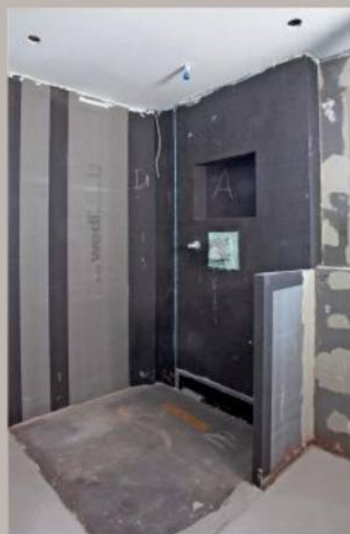
10. Die Eckdusche im Plattenroh-zustand, die Duschbodenfläche sitzt nun bündig mit dem Estrich.
