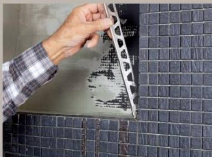
18. Für einen dekorativen Abschluss an der Nische hat man rundum Edelstahlblechprofile eingesetzt.
