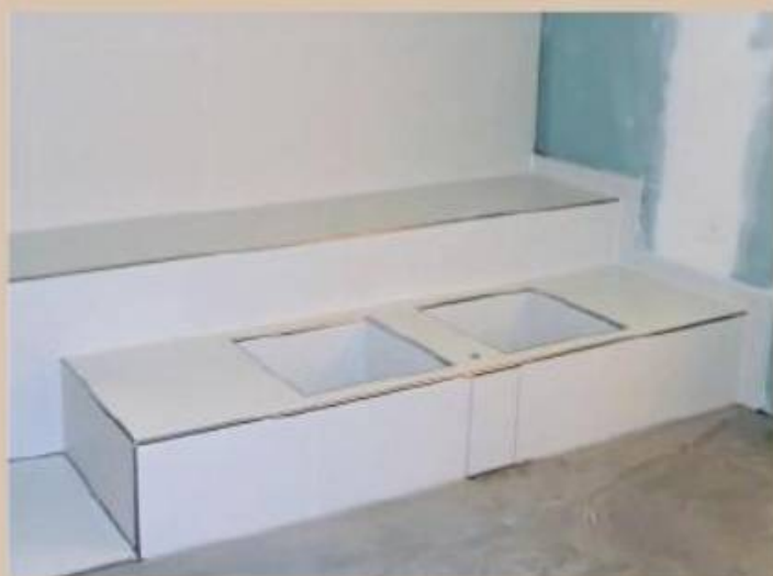
Eine gemauerte Sitzbank sowie zwei gemauerte Fußbecken ergänzen das Thema Kellersauna. Die klare Linienführung mit Edelstahlprofilen bringt Modernität herein.
