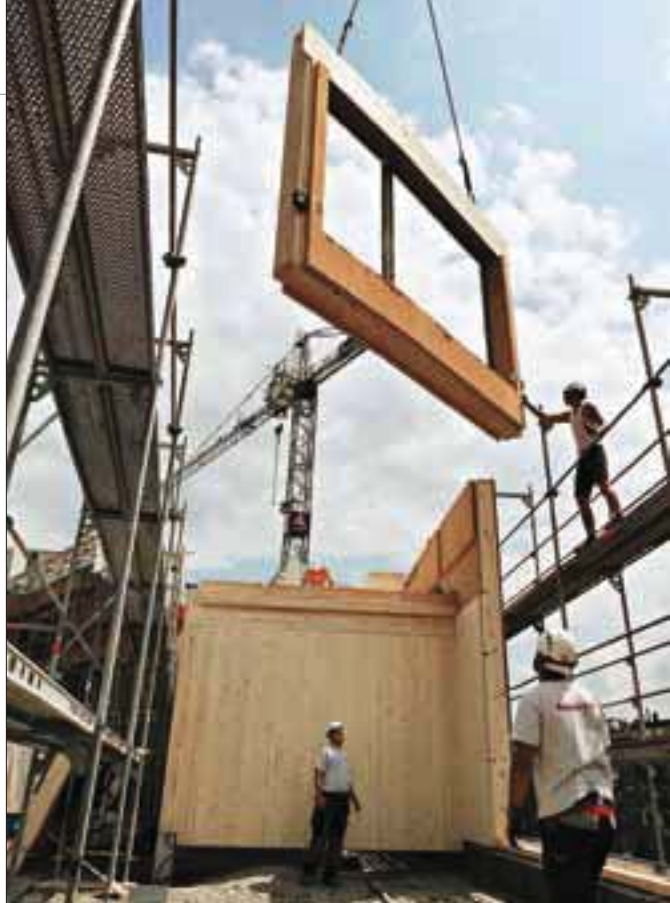
Im Werk mit Holzweichfaserdämmung vorbereitete Außenwände werden auf der Baustelle zusammengefügt.
