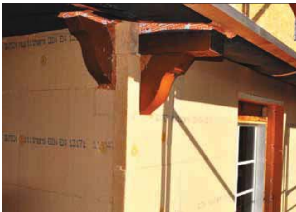
Feste Holzweichfaserplatte als Außendämmung einer hinterlüfteten Fassade
