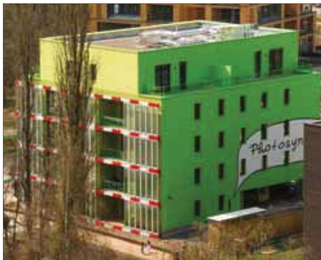
Nach Süden experimentelle Algenfassaden, nach Norden knallgrüne Putzfassaden: Dieses Haus mit Bioreaktor gehört sicherlich zu den spektakulärsten Gebäuden der IBA.
