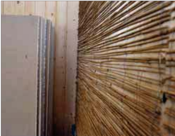
Auf die Holzwände wurden Schilfrohmatten als Lehmputzträger getackert.
