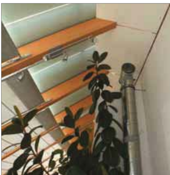
Im niedrigen Glasvorbau im Süden wird unter der Traufe die Warmluft angesaugt.
