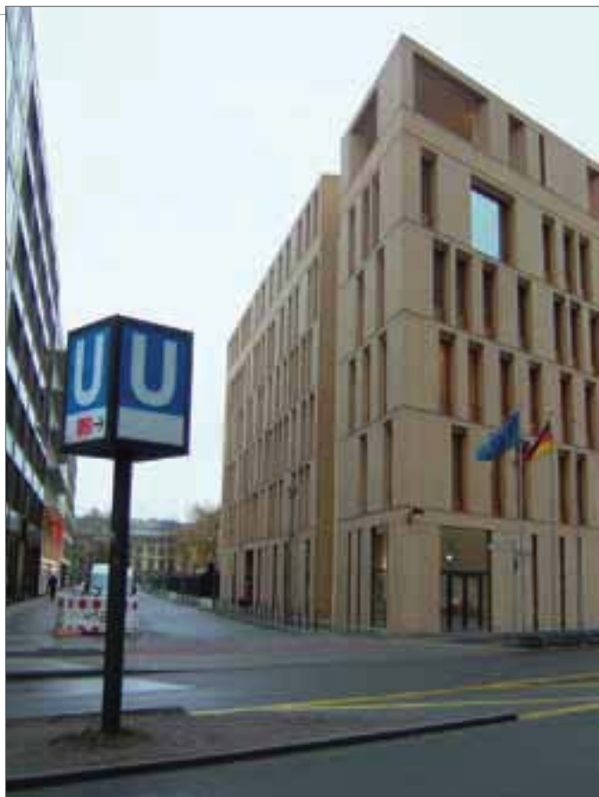
Blick vom Potsdamer Platz auf den Neubau des Umweltministeriums. Auf der Freifläche hinter dem Gebäude findet die Regenwasserfilterung statt.
