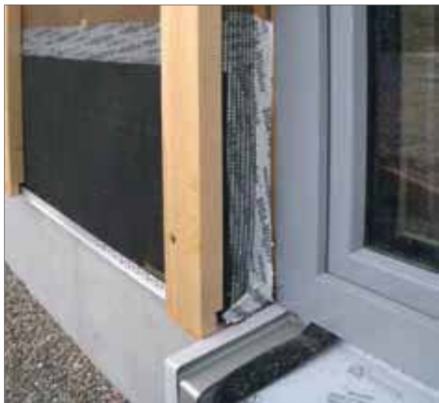
Das zur Abschirmung in der Kita verwendete Carbonfasergewebe wird aus Gründen des Personen- und Sachschutzes geerdet.
