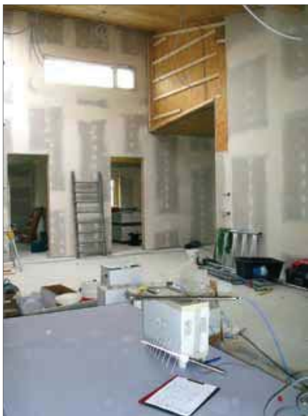
Hochfrequenz-Spektralanalysator zur Kontrollmessung der Abschirmung im Kita-Rohbau
