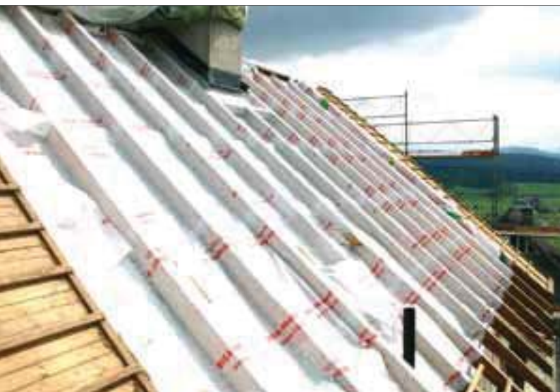
Verklebte Dampfbremsbahnen für die Einbringung der Zwischensparren-Dämmung
