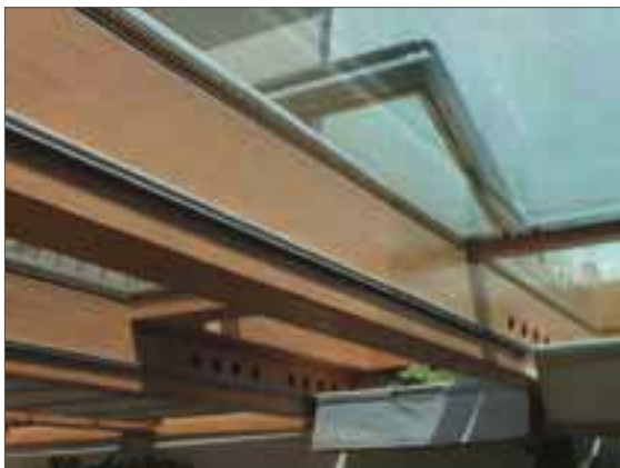
Löcher am Firstpunkt der Dachsparren: Aus allen Glasfeldern kann gestaute Warmluft zum Entlüftungsflügel strömen.
