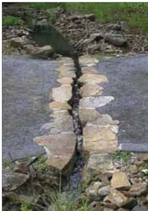
Durch diese Verbindung zwischen zwei Versickerungsmulden wird Wasser erlebbar.
