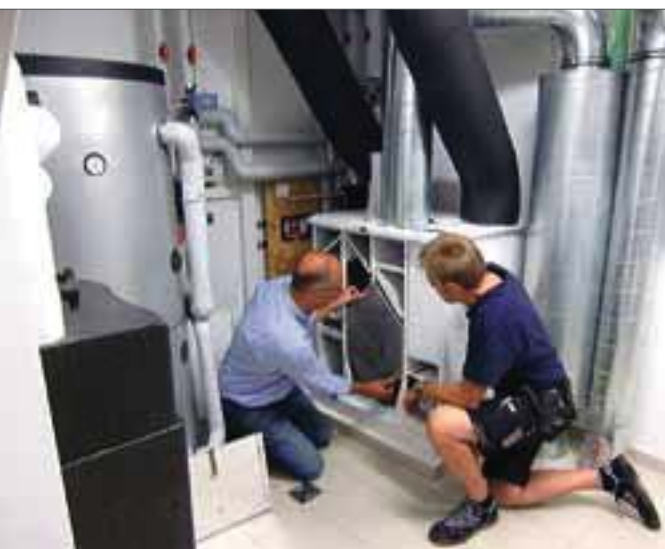
Montage der Zentraleinheit einer Lüftungsanlage mit dem Wärmetauscher zur Wärmerückgewinnung.
