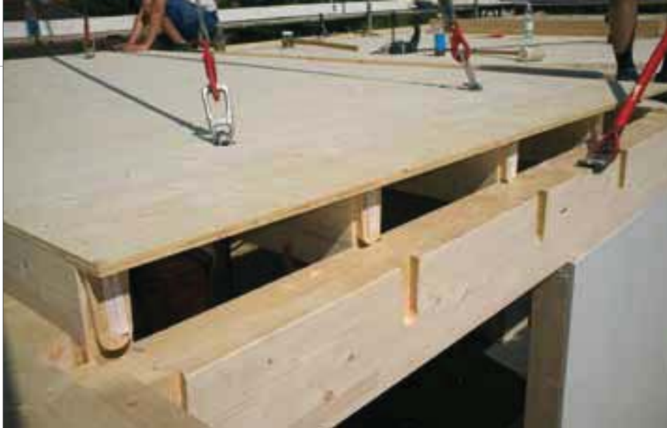
Altbewährtes mit modernster Technik gefertigt: Schwalbenschwanzverbindung
