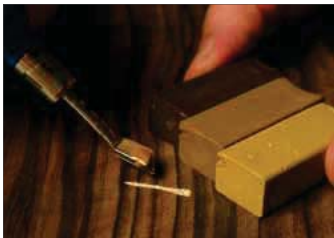
Kratzer und Dellen lassen sich mit Hilfe von geschmolzenem Wachs ausbessern und anschließend wieder ölen oder versiegeln.
