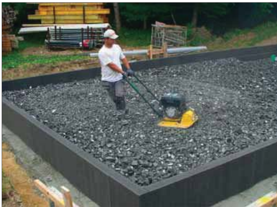
Glasschaumschotter wird verdichtet als Träger der Bodenplatte für einen Kindergarten.
