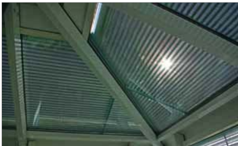
Für Glasdächer robust und effektiv, dabei flexibel und dezent lichtdurchlässig: Schräg-Rollläden mit einzelnen gelochten Profilen
