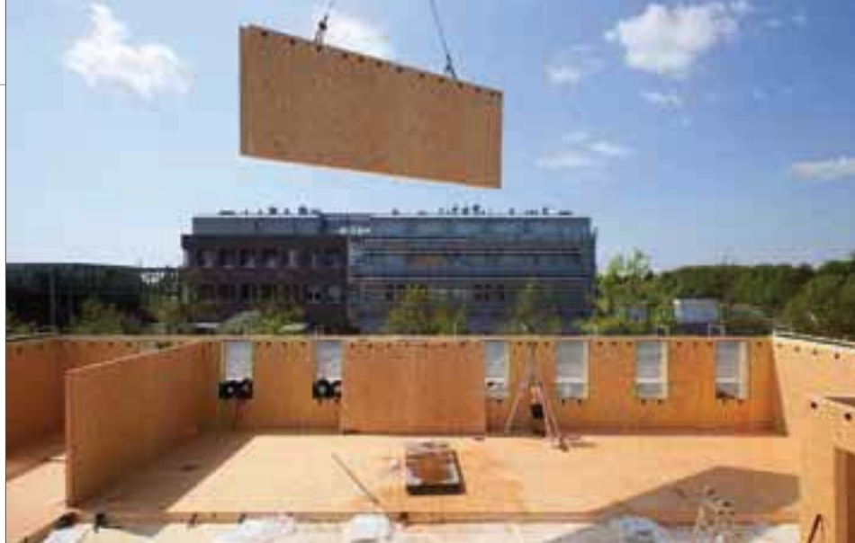
Erstellung des UBA-Gebäudes in Berlin-Marienfelde in Holztafelbauweise
