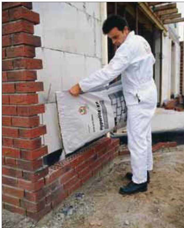
Perlite als mineralischer, Wasser abweisender Schüttdämmstoff wird hinter die Fassade eingefüllt.
