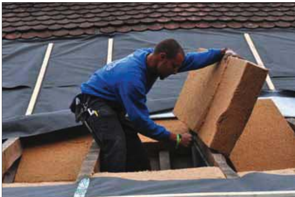
Holzweichfaserplatten werden für die Zwischensparrendämmung passend geschnitten.
