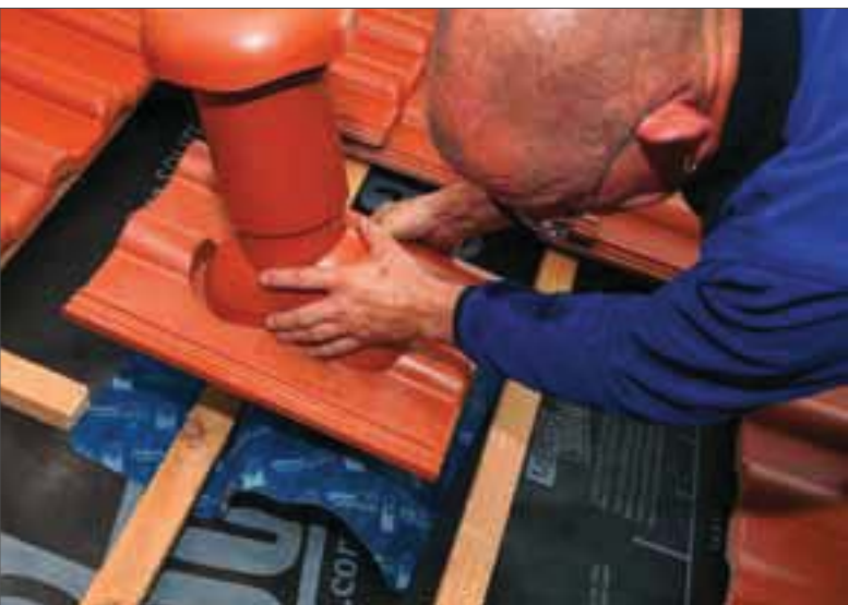
Regensichere, winddichte Manschette zur Abdichtung eines Dunstrohrs
