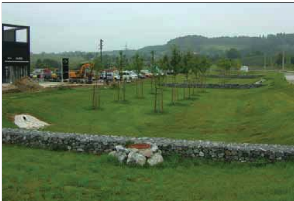
Erfolgt die Versickerung des Regenabflusses von stark verschmutzten Innenstadt- oder Gewerbeflächen durch bewachsenen Oberboden, sind zur Rückhaltung von Schadstoffen große Flächen mit ausreichend Rückstauvolumen erforderlich.
