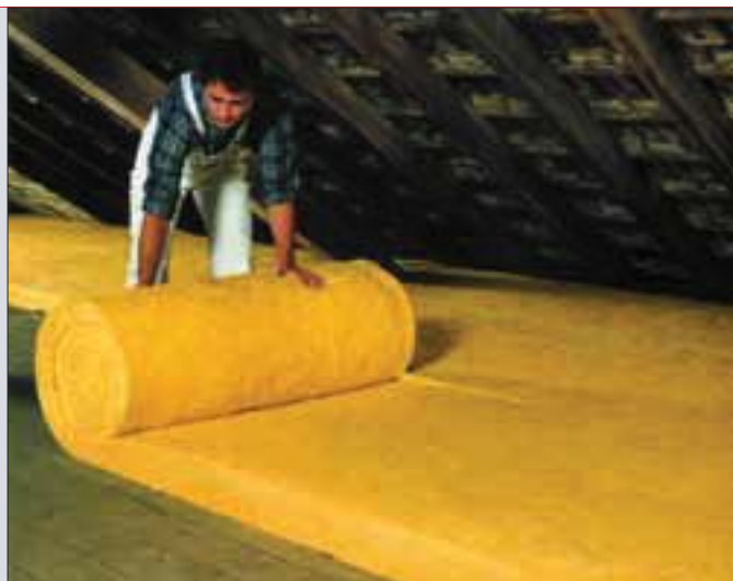
Dämmung der obersten Geschossdecke mit Glaswolle-Matten
