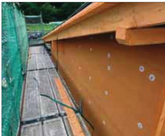
Holzfaserdämmplatten werden überwiegend an Fassaden und Dächern eingesetzt.
