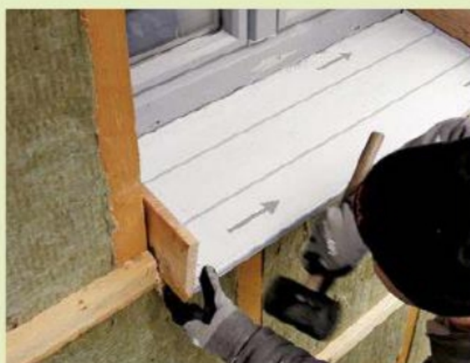
13. ... Abstand, damit hier noch Hilfsbretter für die Holzschalung eingebracht werden können.
