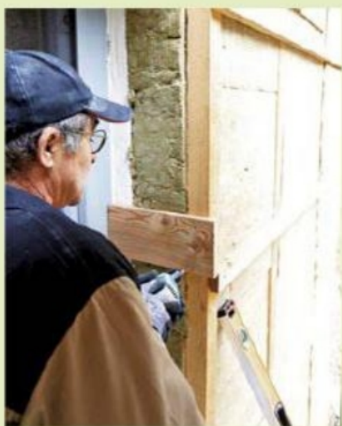
15. Weitere kurze Brettabschnitte bilden noch die Unterkonstruktion für die Fassadenprofile.
