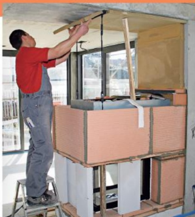
19. Zum Hitzeschutz werden Decke sowie angrenzende Aufstellwand vollständig mit Dämmplatten beklebt.
