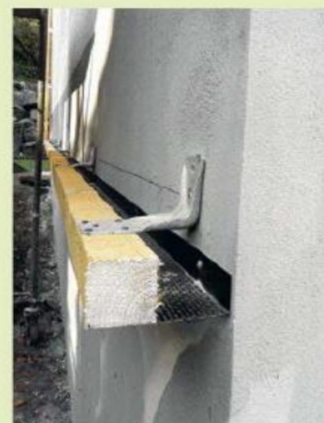
3. Der Balken hält drei Zentimeter Abstand von der Fassade und gewährleistet so die spätere Hinterlüftung.
