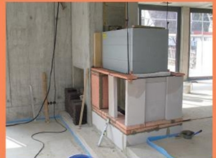
17. Später hängt hier die gesamte obere Kaminverkleidung aus Schamotte-Putzträgerplatten.
