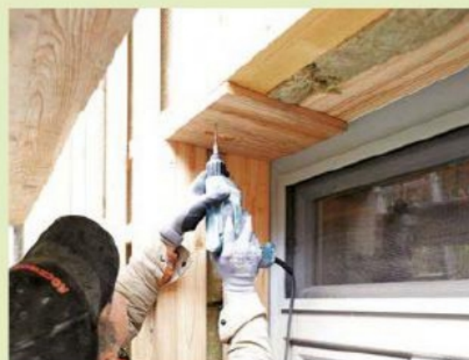
19. Im Sturzbereich der Fenster werden nebeneinander Brettabschnitte als Sichtsturz montiert.
