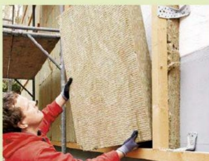
7. Die Gefache werden mit 8 bzw. 14 cm (Westfassade) dicken Steinwolleplatten gefüllt.
