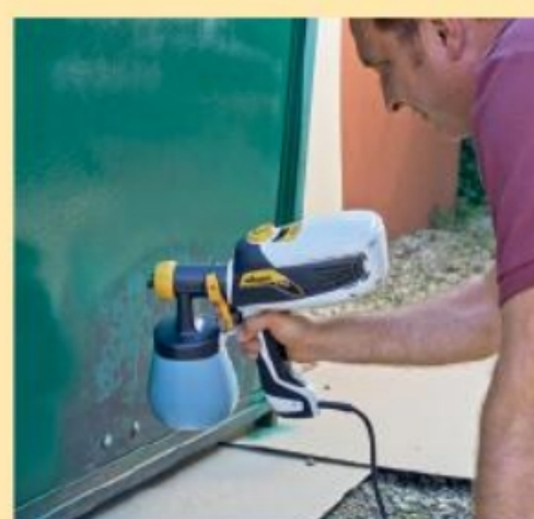
9. Sowohl die Lackfehlstellen als auch der angeschliffene Altlack wurden gleichmäßig überdeckt.
