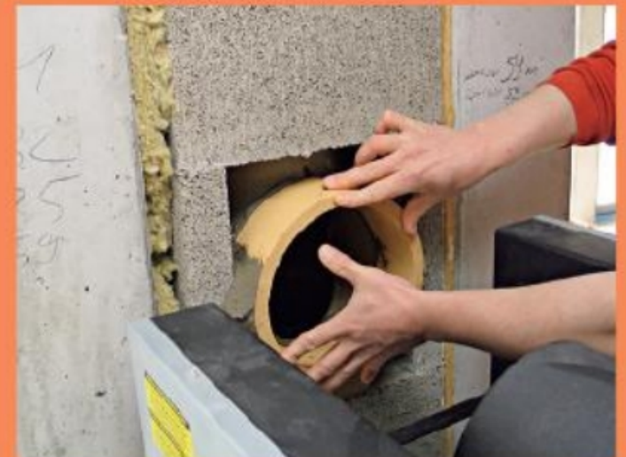
12. Der keramische Stutzen wird mit hitzebeständigem Mörtel am Schornstein angeschlossen.
