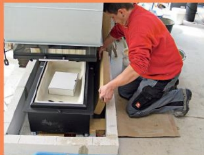
9. Auf gleiche Weise wird der Heizkammerboden (hier die Rohbetondecke zum Keller) gedämmt.
