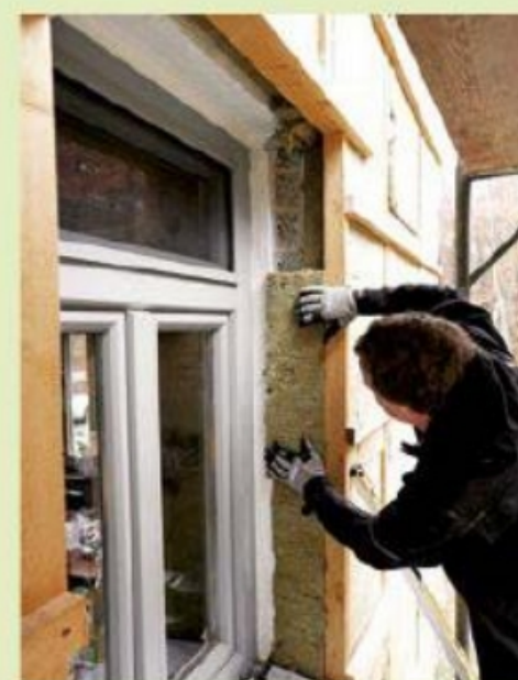
14. Und ebenfalls wurde im Laibungsbereich noch passgenau Dämmwolle eingefügt.
