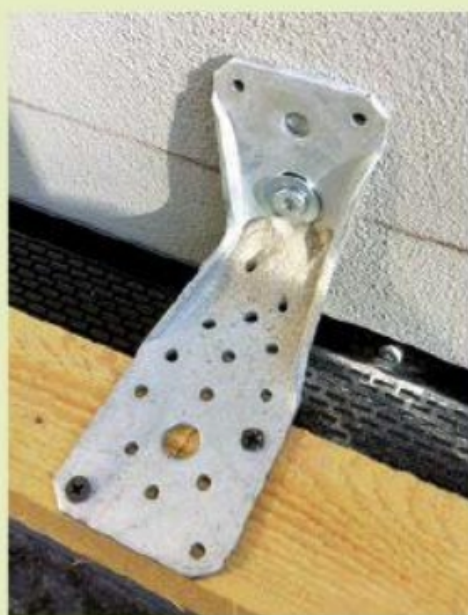
2. Darüber verläuft der Basisbalken, gehalten von starken, verzinkten Wandwinkeln.
