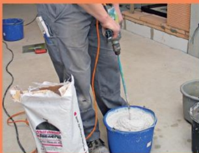
22. Dann wird der weiße, temperaturunempfindliche Feinputz (1 mm Körnung) angerührt.
