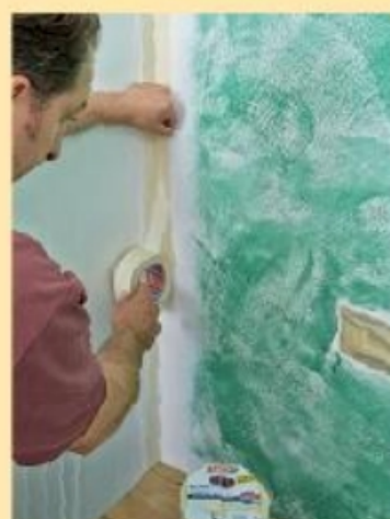
10. Nach Trocknung nun auf dem weißen Rand noch einmal abkleben, und zwar so, dass der ...
