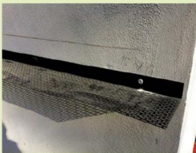
1. Als unterer Abschluss und Schutz vor Insekten und Kleinnagern dienen breite Lochblechwinkel.
