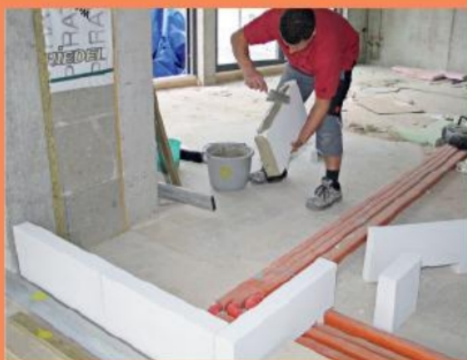
1. Vor dem Nassestrich-Einbau wird zur Abgrenzung ein Sockel aus Porenbeton angelegt.
