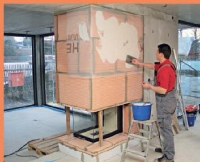
23. Zur Vermeidung von Putzrissen wird damit ein hitzeresistentes Gewebe einspachtelt.
