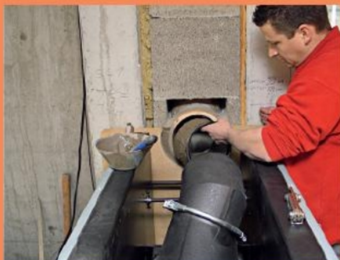
13. Danach verklebt der Ofensetzer das Stahl-Doppelwandfutter mit dem Keramikstützen.
