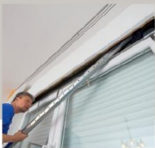
Die vorhandenen Rollladenwellen wurden kurzfristig ausgebaut, ...
