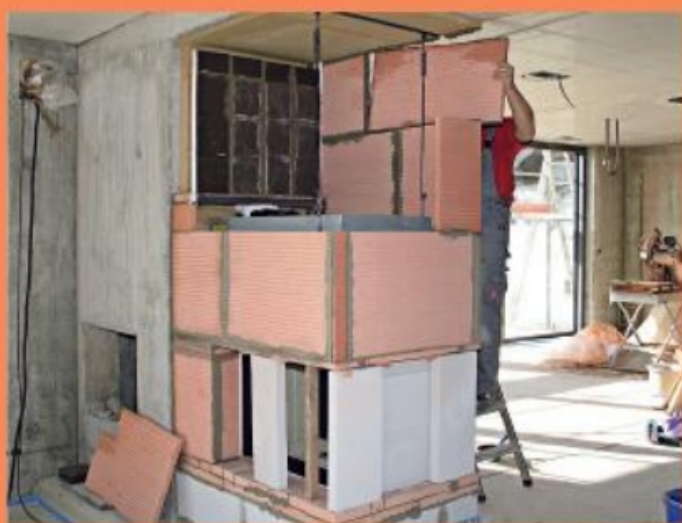
21. Die Ofenhülle aus Schwerschamotte-putzträgerplatten wird bis zur Decke hochgezogen.
