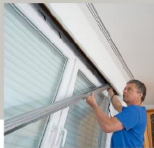
Der erforderliche Stromanschluss wurde ebenfalls nachgerüstet.
