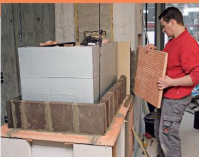
18. Als innere Verkleidung werden kleinere hochspeicherfähige Magnesit-Formsteine verbaut, die Außenhülle besteht aus großformatigen Schwerschamotte-Putzträgerplatten.
