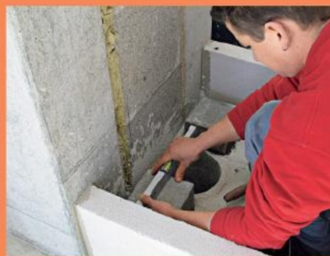
3. An vordefinierten Stellen werden Betonsteine platziert, auf denen die Brennzelle stehen wird.
