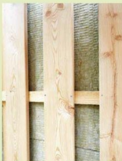
16. Diese wurden dann in einem zuvor errechneten Abstandsrastrer verschraubt.
