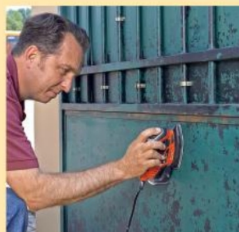
4. Empfohlen wird das Anschleifen der Flächen sowie das partielle ...
