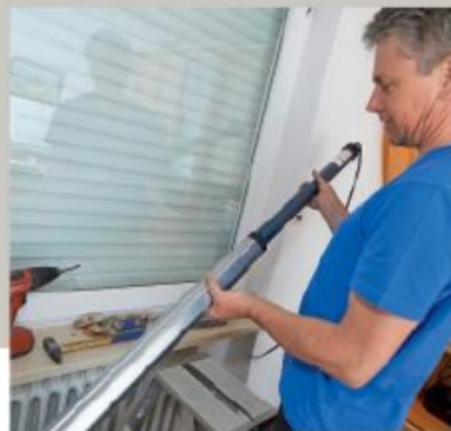
... um jeweils die passenden Rohrmotoren einzubauen.
