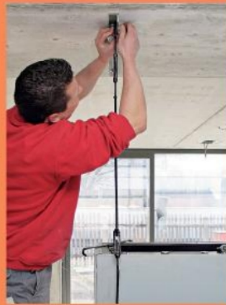
16. ... Spannvorrichtung des systemeigenen Tragrahmens der Brennzelle eingehängt.
