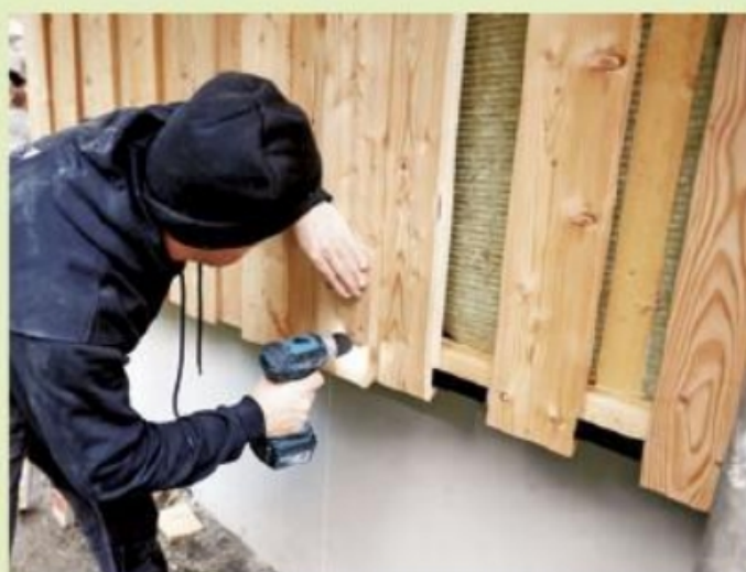
18. ... und den Deckelprofilen, die mittig über den Freiräumen aufgeschraubt werden.
