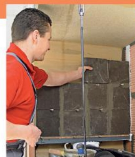
19. Zum Hitzeschutz werden Decke sowie angrenzende Aufstellwand vollständig mit Dämmplatten beklebt.
