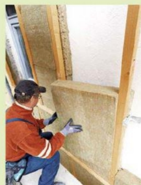
8. Von unten nach oben baut sich dann die Dämnhülle auf – lückenlos anschließend an die Traghölzer.
