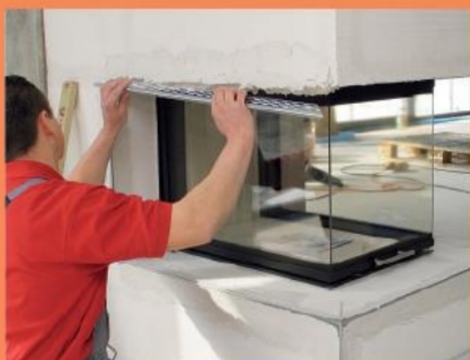
25. Um saubere, stoßfeste Kanten zu erhalten, kommen verzinkte Putzschienen zum Einsatz.
