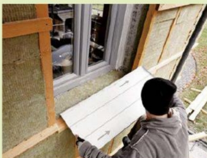
12. Zuvor wurden noch die Aluminium-Fenstersimse eingepasst. Sie benötigen seitlichen ...
