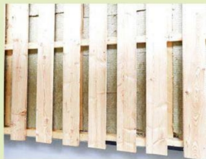
17. Die sogenannte Boden-Deckel-Schalung besteht aus den Bodenprofilen (erste Lage) ...
