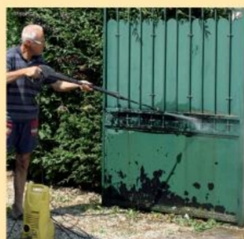
1. Lose Farbe, Moospolster und Verunreinigungen ließen sich mit dem Hochdruckreiniger gut entfernen.
