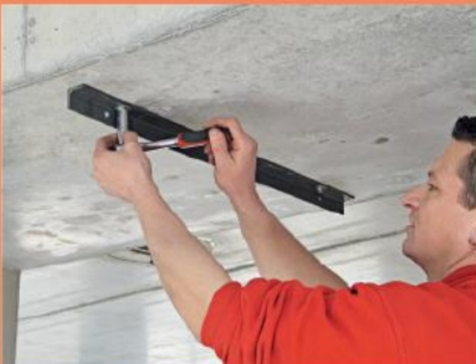
15. An einem sicher mit der Betondecke verankerten Winkeleisen aus Stahl wird die ...
