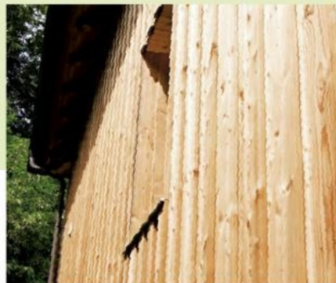
21. Jedes Fenster ist perfekt in die Schalung eingebunden, der Sims steht ausreichend über.
