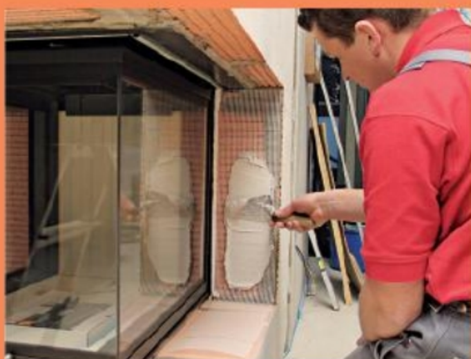
24. Das Gewebe wird auch auf den Laibungsflächen des Glasbereichs eingearbeitet.
