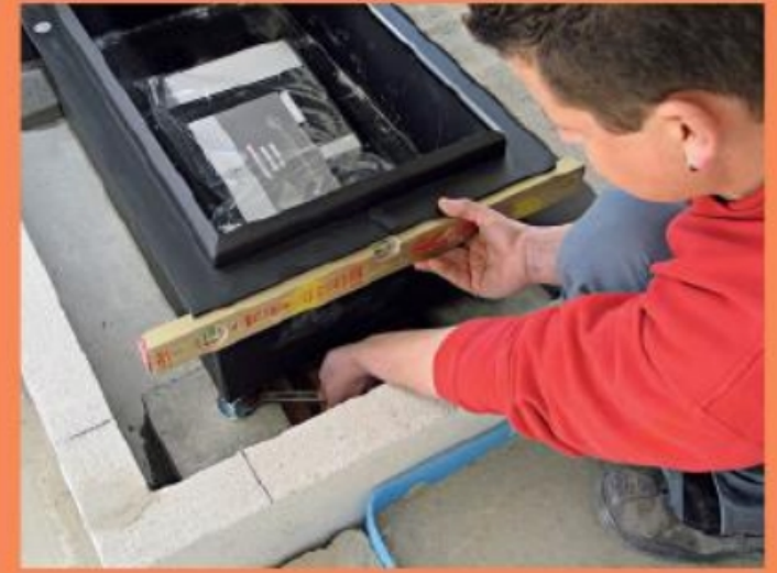
6. Die Feinjustierung der Stellfüße erfolgt mit einer Wasserwaage und einem Gabelschlüssel.
