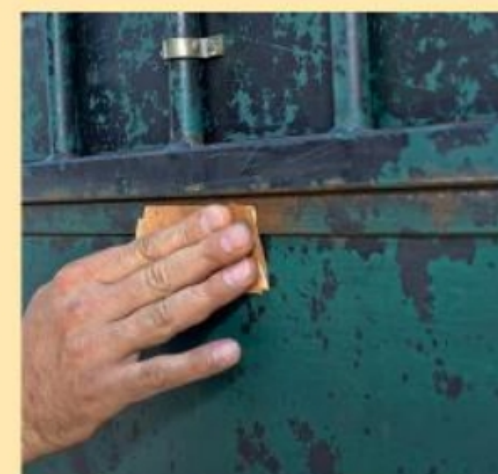
5. ... Bearbeiten hartnäckiger Roststellen, hier am besten manuell.
