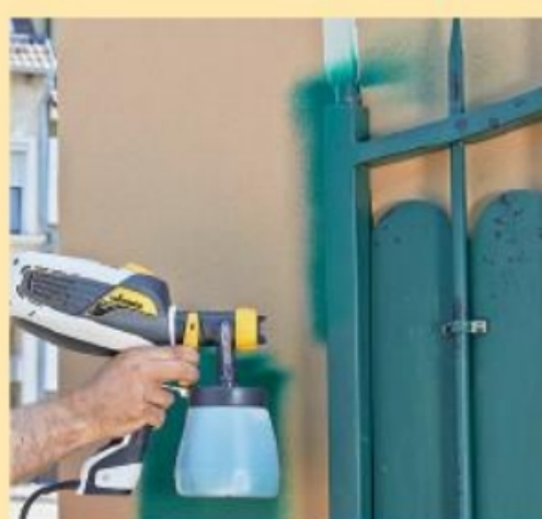
7. Zunächst wurden die schmalen Profile mit der auf Punktstrahl eingestellten Düse lackiert, dann ...
