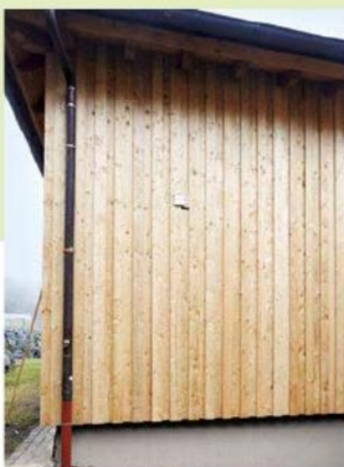
20. Nach Fertigstellung der Lärchenholz-Wetterschutzfassade können auch wieder die Fallrohre befestigt werden.
